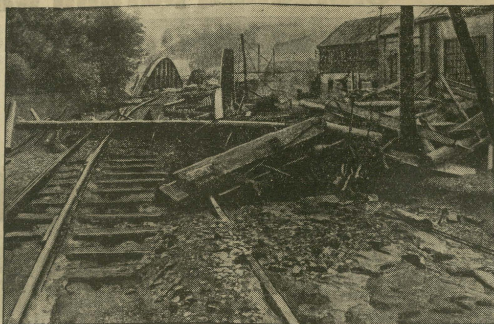
Niebywała burza, połączona z oberwaniem chmury, jaka ostatnio nawiedziła część Saksonji, spowodowała tam katastrofalne zniszczenie. Wiele linii kolejowych zostało zupełnie zdevastowanych, tak, że ruch kol. został wstrzymany. Rycina przedstawia zrujnowaną doszczętnie stację kolejową Erla pod Schwarzenberg.
