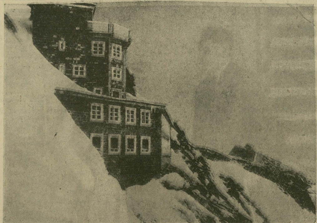
W Interlaken, w Szwajcarii, odbyło się otwarcie międzynarodowej alpejskiej stacji badawczej na przełęczy Jungfrau. Prace techniczne na tej wysokości były bardzo utrudnione ze względu na liczne przeszkody. Ilustracja nasza przedstawia nowe obserwatorium w Interlaken.
