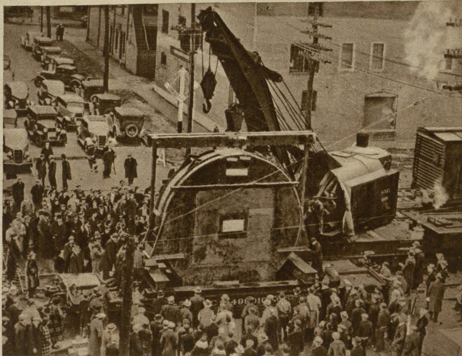
BUDOWA OLBRZYMIEGO OBSERWATORJUM W KALIFORNII. Nasze zdjęcie przedstawia transport największej na świecie soczewki, sporządzonej w zakładach w Corning, a przeznaczonej do teleskopu Obserwatorium na Mount Palomar w Kalifornii. Dla ochrony przed uszkodzeniem kosztowna soczewka otulona jest warstwą kauczuku, fileu i kortu.
