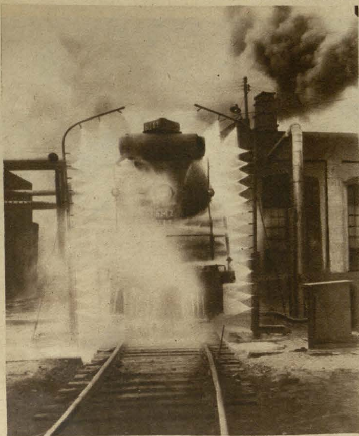
LOKOMOTYWA POD TUSZEM. Lokomotywy także muszą regularnie przechodzić różne zabiegi, pozwalające na ich dokładne czyszczenie. Jednym z takich zabiegów jest specjalny tusz, uwidoczniiony na naszej fotografii. Silne prądy wody, wydobywające się z kilkudziesięciu otworów czyszczą w krótkim czasie bardzo gruntownie cały parowóz. Fotografia powyższa została zrobiona w jednej z parowozowni kanadyjskich.
