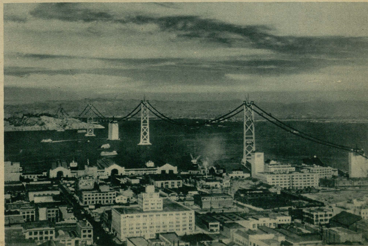
MOST W SAN FRANCISCO JUŻ JEST NA UKOŃCZENIU. Słyszało się już o jego budowie, widziało się zdjęcia poszczególnych faz dokonywania tego wielkiego przedsięwzięcia. Obecnie dobiegło ono do końca — ten najdłuższy na świecie most wiszący jest już na ukończeniu.
