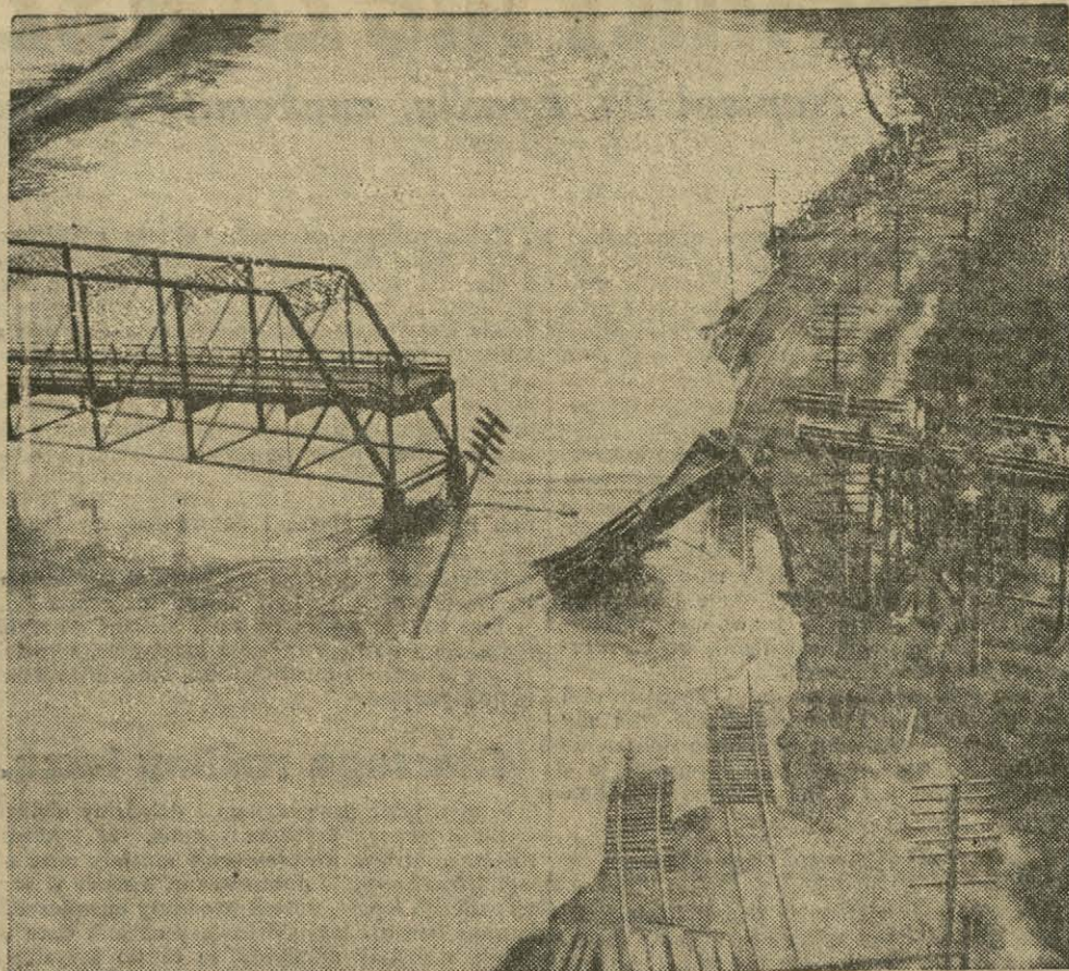
W zachodniej części stanu Waszyngton katastrofalna powódź zniszczyła wiele mostów i torów kolejowych. Na zdjęciu zniszczony most i tor kolejowy pod Tacoma.
