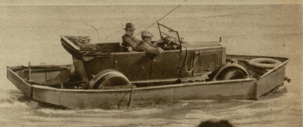
LÓDZ „MOTOROWA” PORUSZANA MOTOREM SAMOCHODU. Pewien Anglik, któremu sprzykrzyły się jazdy samochodem na lądzie, a który nie chciał wydawać pieniędzy na łódź motorową, poradził sobie w ten sposób, że umieścił swe auto na starej łodzi tak, że motor samochodu wpadł w ruch śrubę łodzi.
