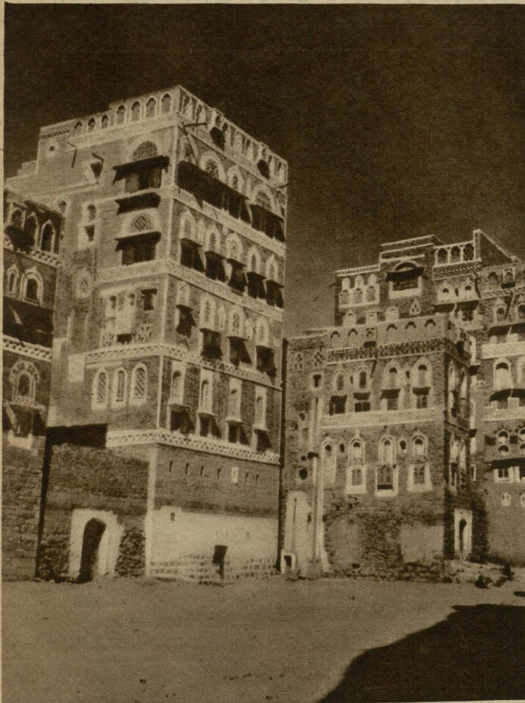
ORYGINALNA ARCHITEKTURA WSCHODU. W mieście Sana, stolicy prowincji arabskiej Yemen, poważna część domów zbudowana jest z cegiel z prasowanego błota i rumowiska. Ściany zewnętrzne takich domów są niejednokrotnie ozdobione bardzo artystycznym deseniem.
