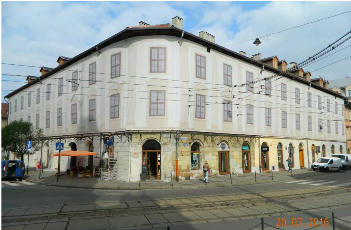
Fot. nr 52. Kamienica z naroża ulic: Krakowskiej 29 i Węglowej, która od dekad czeka na odnowę. Założenie plachty nie jest na to sposobem.
