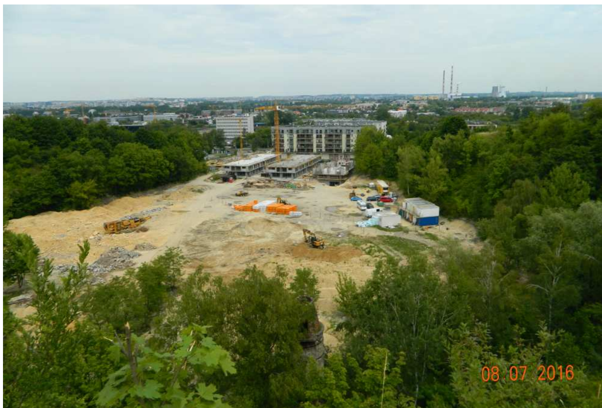
Fot. nr 140. Trwa zabudowa niecki dawnego kamieniołomu miejskiego przy ulicy Jerozolimskiej, gdzie w czasie II wojny światowej katorżniczo pracowali więźniowie z pobliskiego KL Płaszów. Dla deweloperów nie ma jednak świętości.
