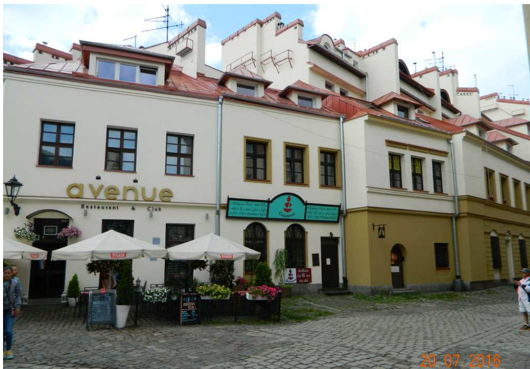
Fot. nr 35. Wybudowany od nowa już w III RP fragment zabudowy na styku ulic: Józefa i Bartosza, który nawiązuje do dawnej zabudowy tego fragmentu.
