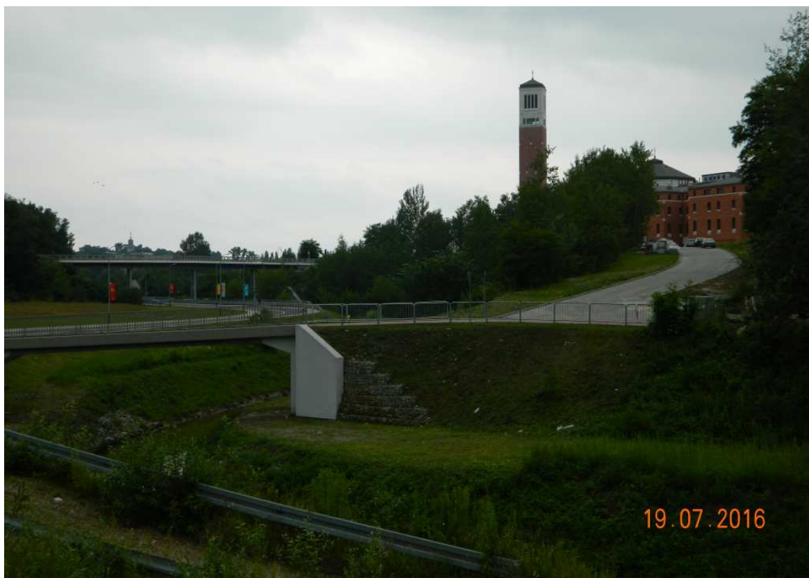
Fot. nr 266 (266-267). Moloch Centrum Jana Pawła II. Tu widok z nowego ronda na styku rozbudowujących się ulic: Totus Tuus i św. Brata Alberta.
