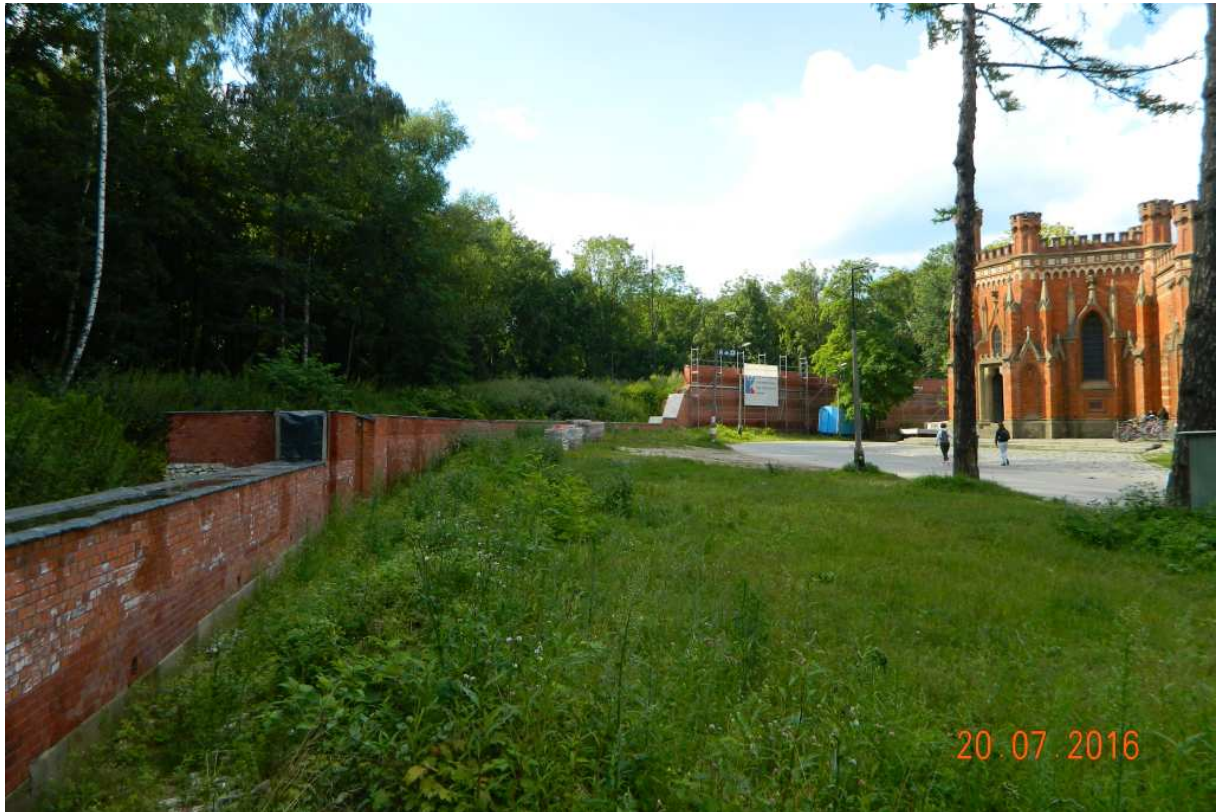
Fot. nr 96 (96-99). Trwa rekonstrukcja narysu i niektórych elementów kurtyny I-II fortu.
