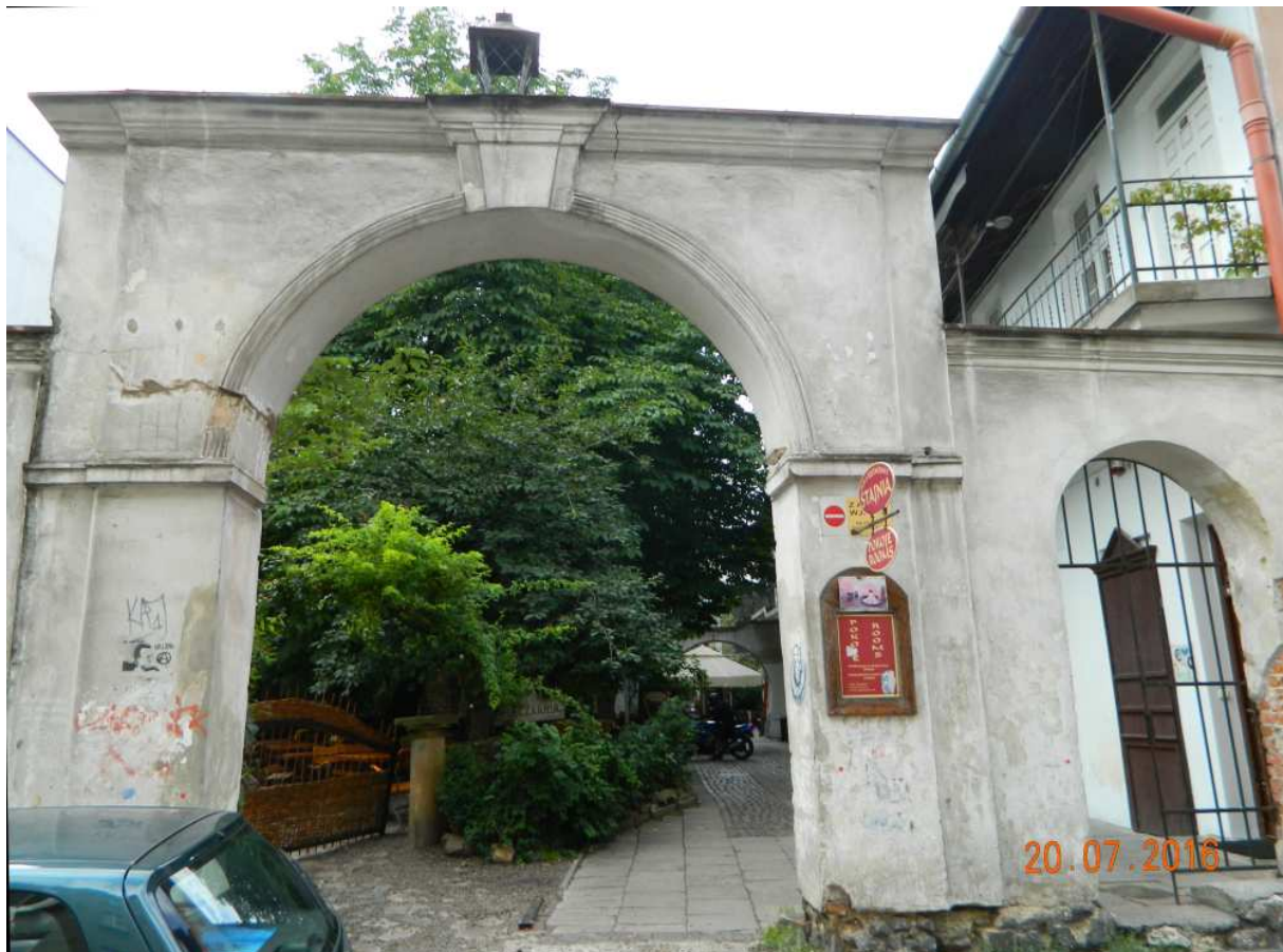
Fot. nr 69 (69-70). Przejściowe podwórko pomiędzy ulicami: Meiselsa i Józefa 12 na tyłach zabudowy ulicy Bożego Ciała – widoki z ulicy Meiselsa.
