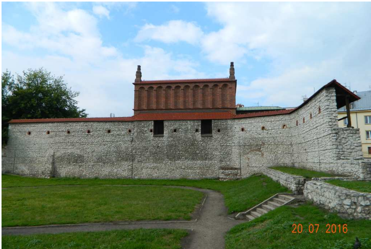
Fot. nr 32. Fragment muru obronnego Kazimierza w sąsiedztwie Starej Bożnicy – widok z ulicy Dajwór.
