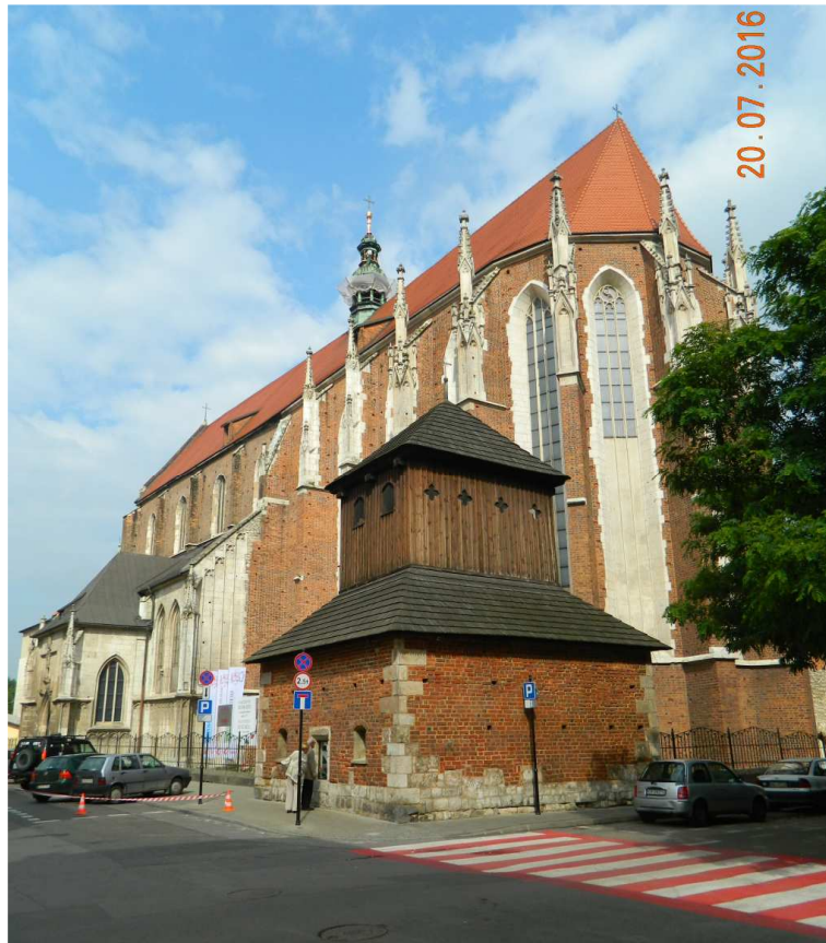
Fot. nr 57 (57-60). Ujęcia zespołu klasztoru Augustianów i Kościoła Św. Katarzyny.
