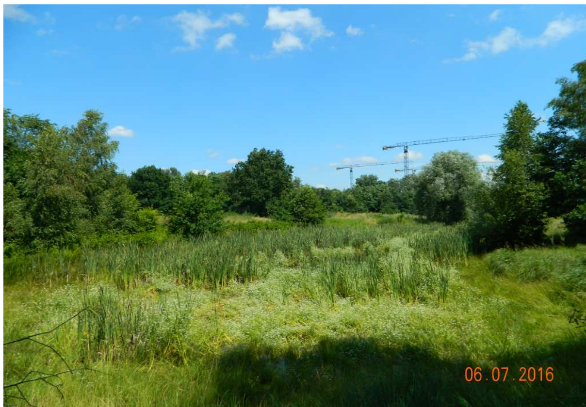
Fot. nr 218 (218-219). Widoki znad większego ze stawów w kierunku placu budowy nowego kompleksu szpitalnego AM, który powstaje wzdłuż ulicy Jakubowskiego.
