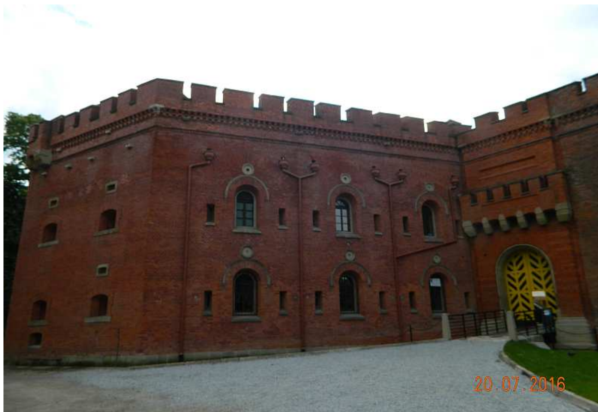
Fot. nr 128. Bastion nr V i brama wjazdowa na jego dziedziniec. Sam bastion pełni dziś funkcję muzealną.
