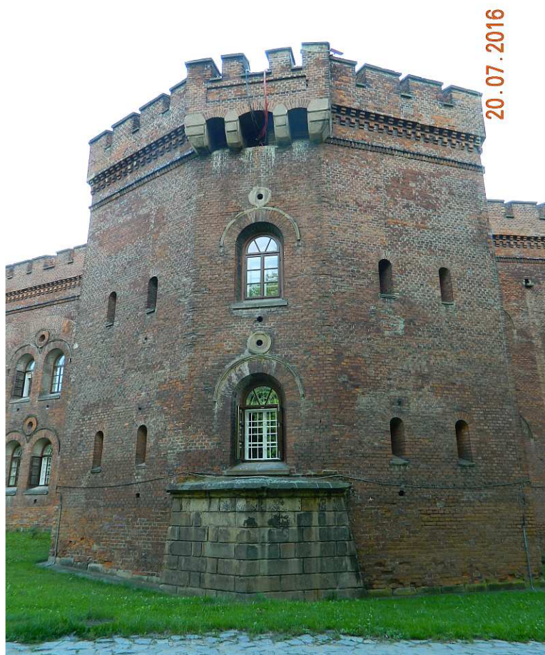
Fot. nr 125. Basteja pomiędzy bastionami nr: IV i V.
