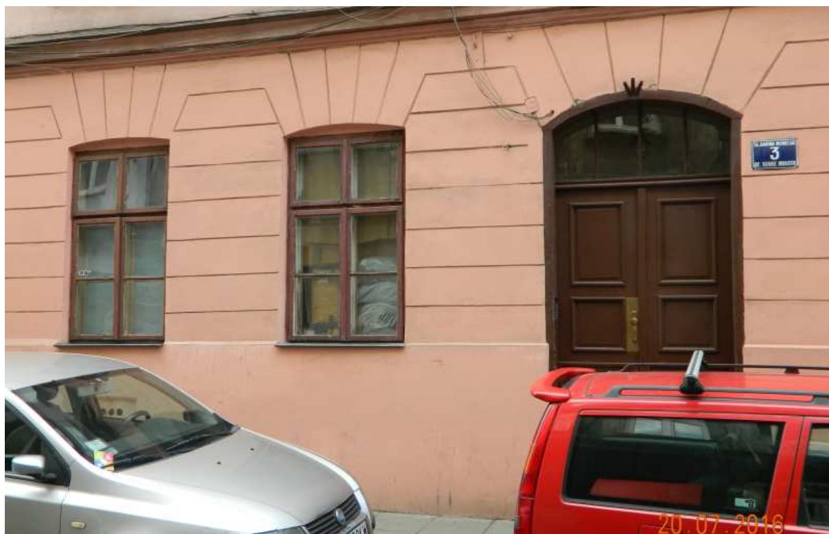
Fot. nr 62. Oryginalne okna kamienicy z ulicy Meiselsa 3, jeszcze z cienkimi szprosami.
