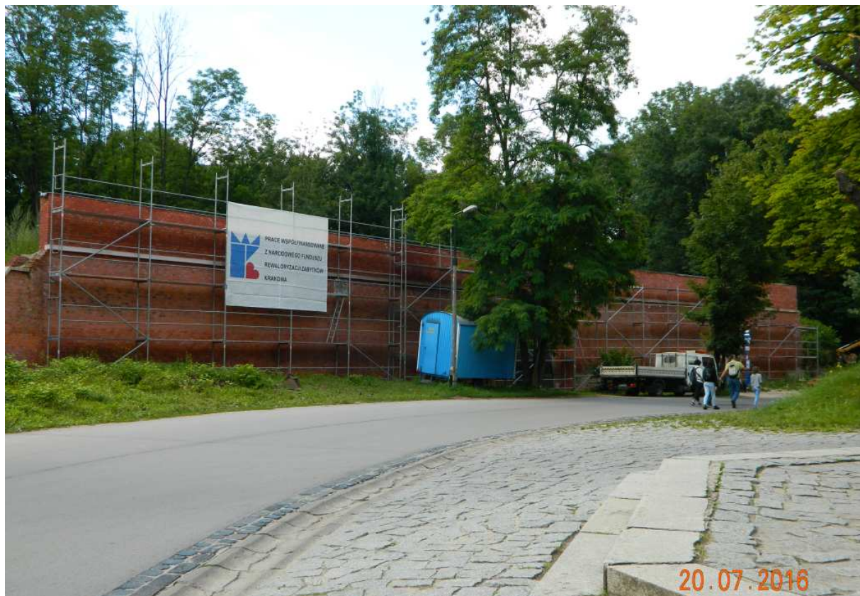
Fot. nr 98 (98-99). Próba otworzenia ściany wewnętrznej bastionu nr II.
