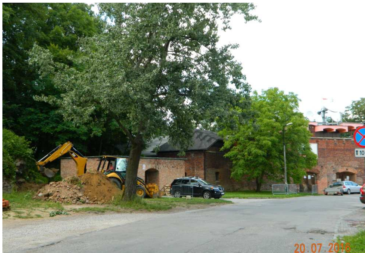
Fot. nr 102. Prace rekonstrukcyjne w sąsiedztwie bastionu nr III.
