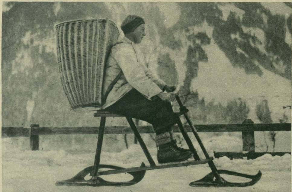
ROZWÓZ PIECZYWA W ZIMOWYM SEZONIE. Praktyczny sposób szybkiego rozwozu świeżego pieczywa dla hoteli i schronisk zastosowała pewna wielka piekarnia szwajcarska. Dzięki temu wynalazkowi, łączącemu narty z mechanizmem rowerowym, gońcy mogą szybko przebiegać po śniegu dalekie przestrzenie.
