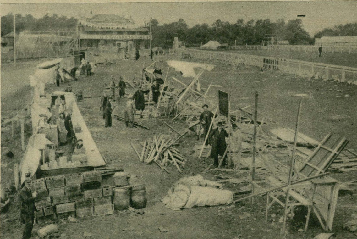
KATASTROFALNA BURZA , jaka przeszła nad południową Anglią, wyrządziła m. in. znaczne szkody na słynnym torze wyścigów konnych w Epsom. Oto widok zniszczonych trybun.
