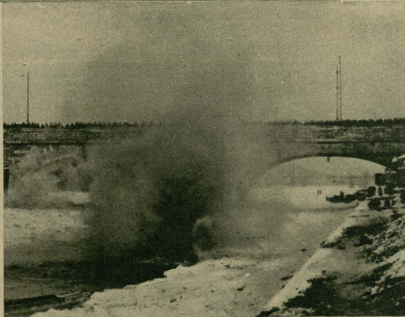
Rozsadzanie dynamitem zatorów lodowych na rzece Loarze pod miastem Tours.
