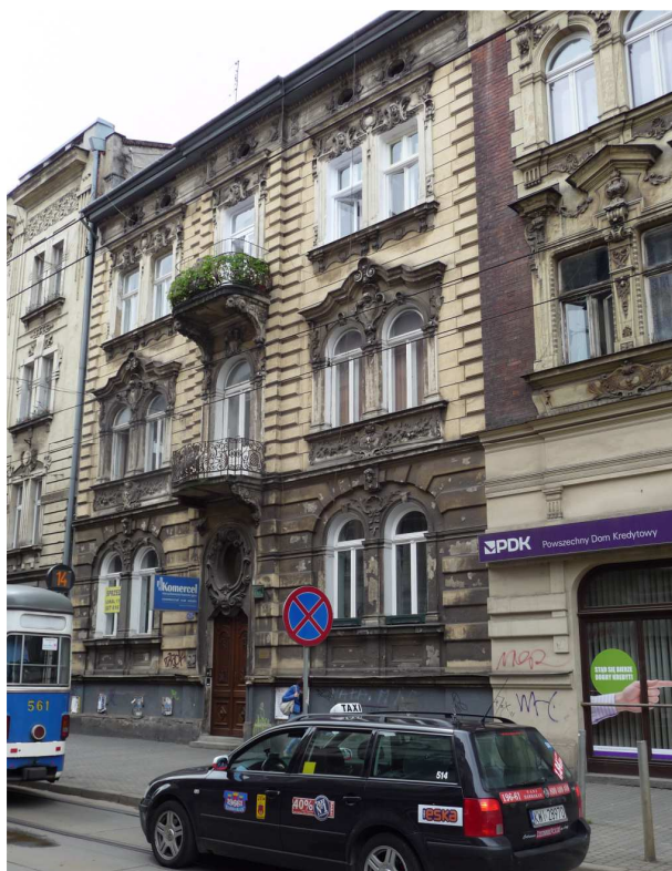
Fot. nr 119. Kamienica z ulicy Karmelickiej 48, która została wybudowana w roku 1906 wg projektu Beniamina Torbe. (04.06.2012)
