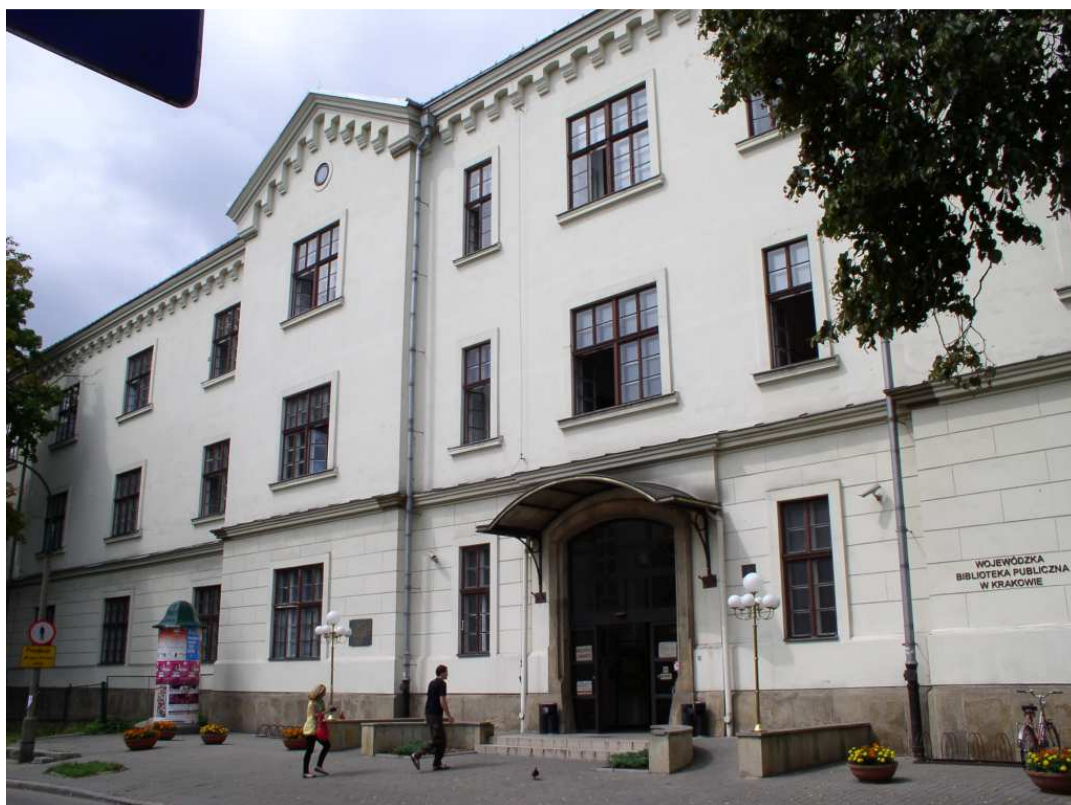
Fot. nr 77. Wejście do gmachu WBP, która przejęła dawne pomieszczenia wojskowe po jednostce OTK WP. (06.08.2009)
