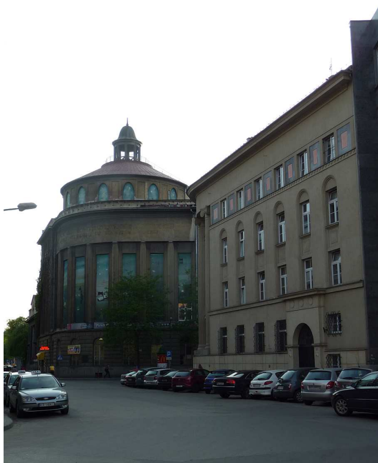
Fot. nr 296. Z prawej dawny gmach Izby Skarbowej pod nr 27, który powstał w latach 1921-26 wg projektu Wacława Krzyżanowskiego. (15.05.2013)
