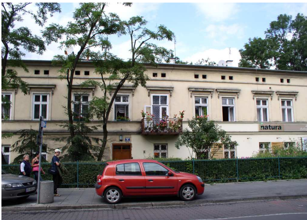
Fot. nr 278 (278-279). Dom z ulicy Krupniczej 21/Dolnych Młynów 1, który powstał w roku 1871. (06.08.2009)
