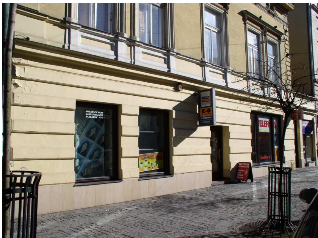
Fot. nr 209. Dom pod nr 15, który został wybudowany w roku 1820. (12.02.2011)
