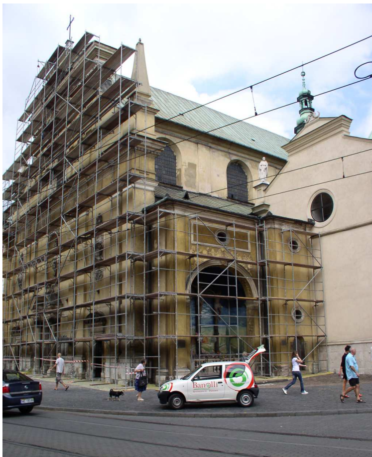
Fot. nr 184. Narożnik kościoła na styku z ulicą Garbarską. (06.08.2009)
