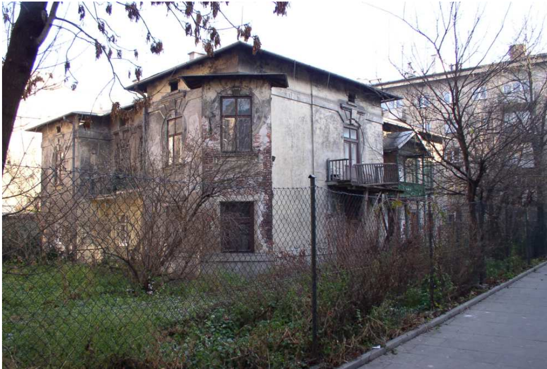
Fot. nr 104 (104-106). Narożny wykusz, a w nim zachowane oryginalne okna. (26.11.2010)
