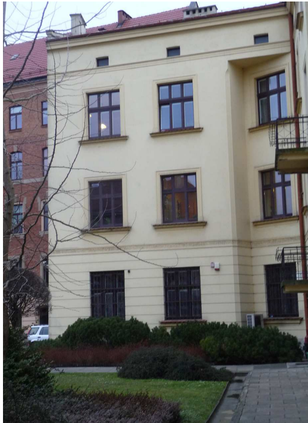
Fot. nr 56. Dwa okna na parterze oficyny w latach 1970-76 należały do naszego mieszkania. Kiedyś w miejscu trawnika rósł sobie niewielki sad. (11.02,2014)
