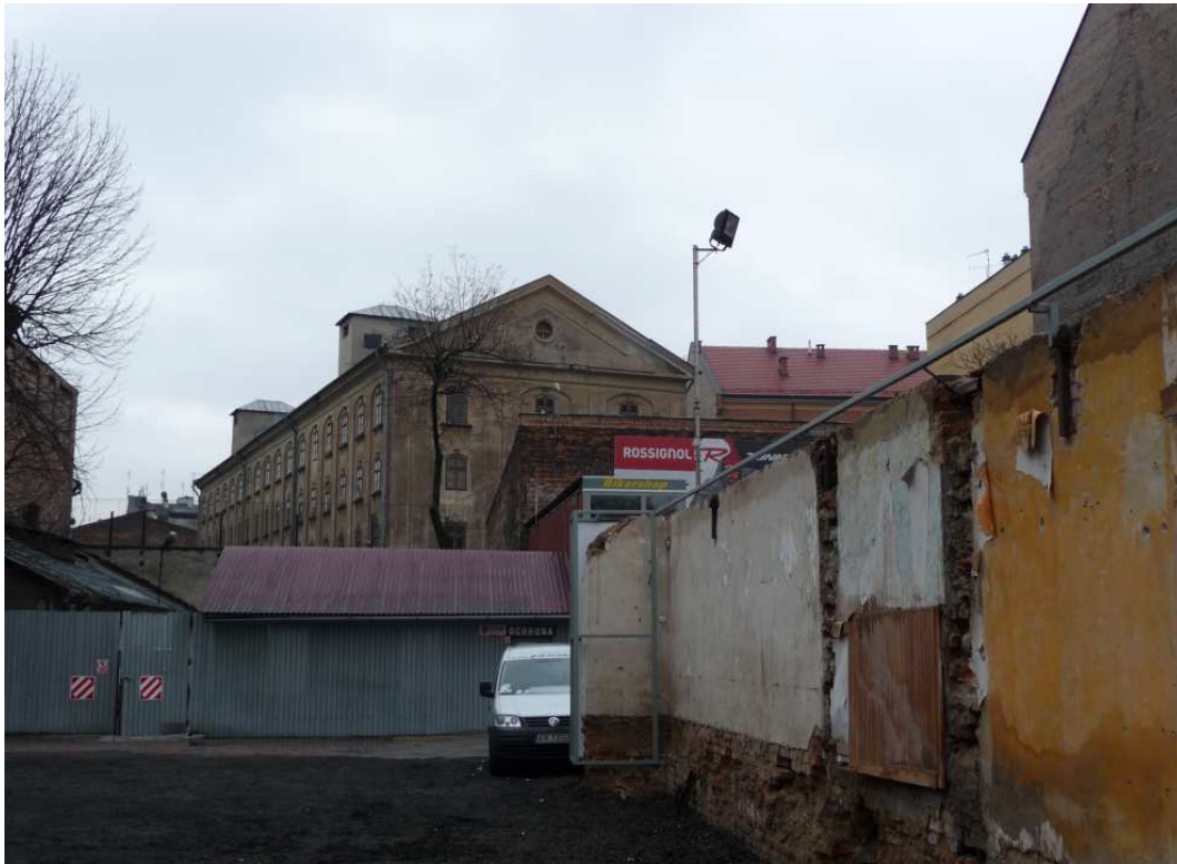
Fot. nr 90. Pusta przestrzeń po kamieniczce spod nr 4. (10.01.2012)
