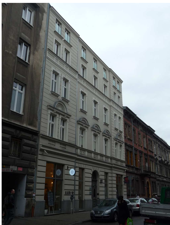
Fot. nr 27. Widok fasady po zakończeniu remontu. (11.02.2014)
