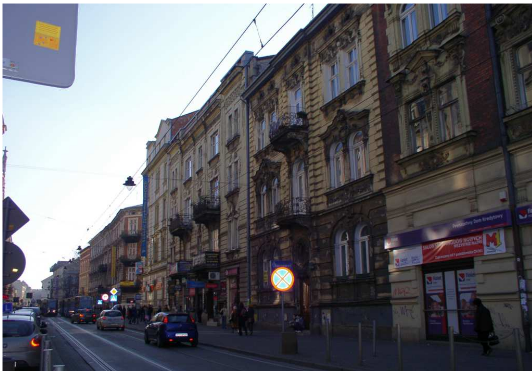
Fot. nr 118 (118-119). Fragment ulicy Karmelickiej o numerach: 44-50, której zabudowa, typowa dla okresu przejściowego pomiędzy eklektyzmem, a modernizmem, powstawała w latach 1895-1911. Czyszówka pod nr 46 (trzecia od prawej), została wybudowana latach 1910-1911 wg projektu Aleksandra Biborskiego. (26.11.2010)
