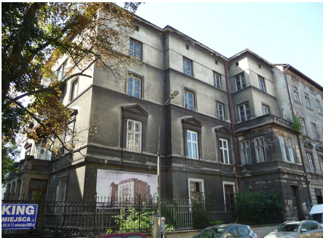
Fot. nr 250. Jak ta rozległa kamienica będzie wyglądała po remoncie? (20.08.2012)
