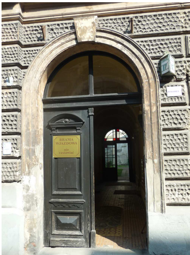
Fot. nr 41 (41-42). Detale sieni czynszówki spod nr 17. (07.04.2014)
