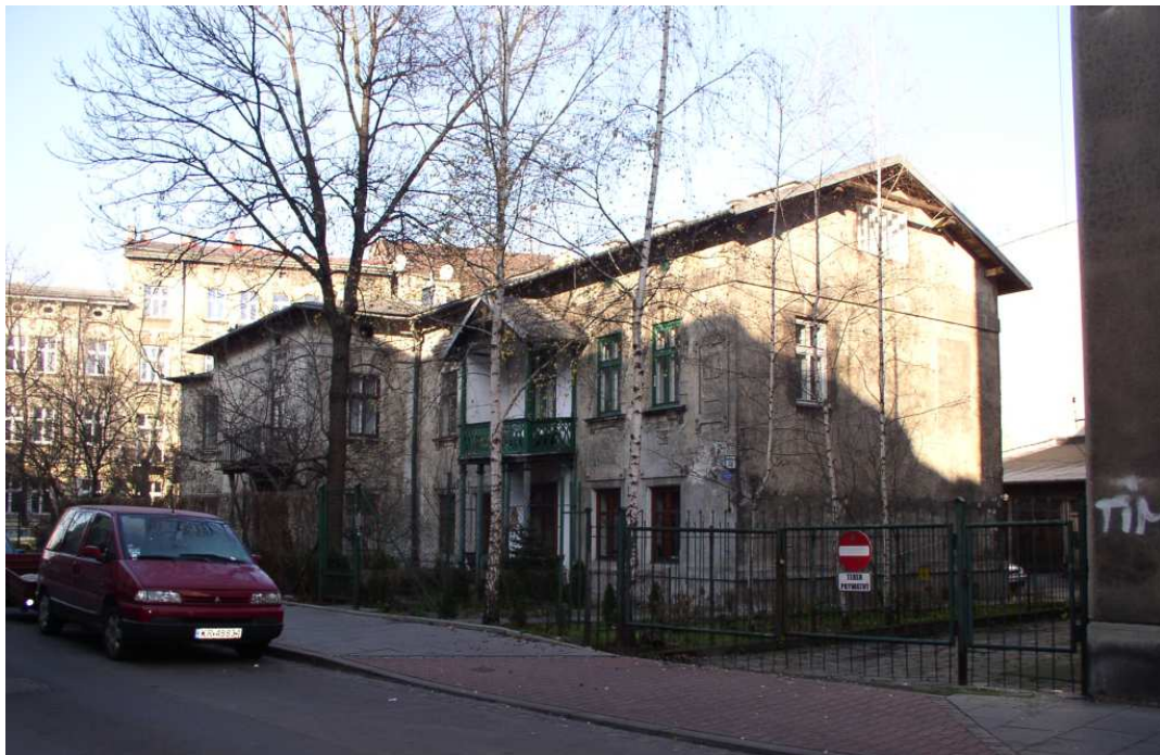
Fot. nr 101 (101-107). Mocno zaniedbana willa z początku XX wieku z ulicy Kochanowskiego 15/Grabowskiego 12 i jej zachowane do dziś detale. (26.11.2010)
