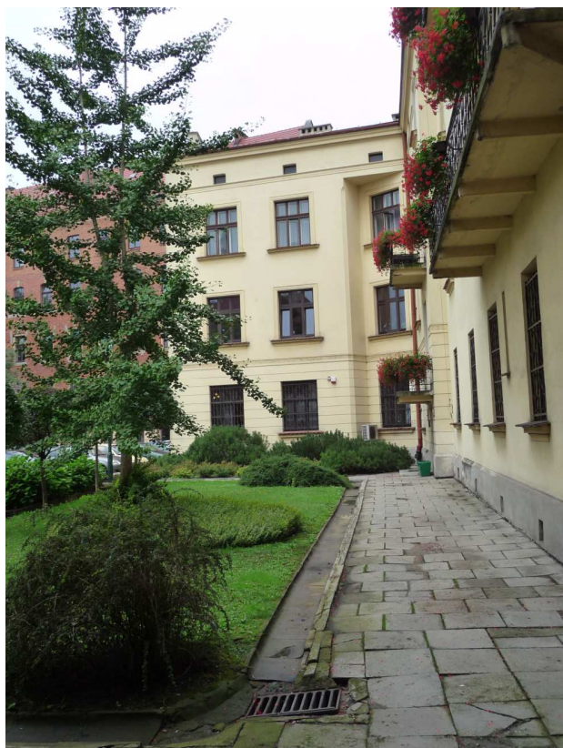
Fot. nr 55 (55-56). Podwórko i oficyna kamienicy. (26.07.2011)
