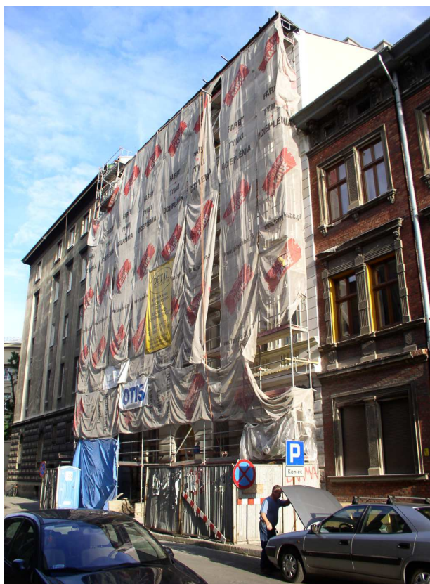
Fot. nr 17 (17-28). Kolejne fazy przemian remontowanej fasady i wnętrza. (18.08.2010)
