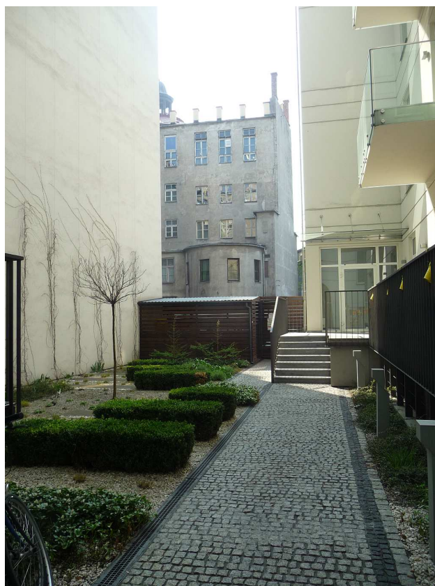
Fot. nr 29 (29-31). Częściowo zabudowane podwórk „mojej kamienicy”, kiedyś stanowiące jej zielone płuca, które po dodatkowym podwyższeniu fasady przypomina teraz pełny cienia więzienny spacerniak. (07.04.2014)
