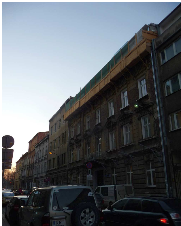
Fot. nr 35 (35-36). Kamienica z ulicy Czystej 11. Właśnie trwa jej nadbudowa pod pretekstem wzmocnienia stropu. (12.03.2014)
