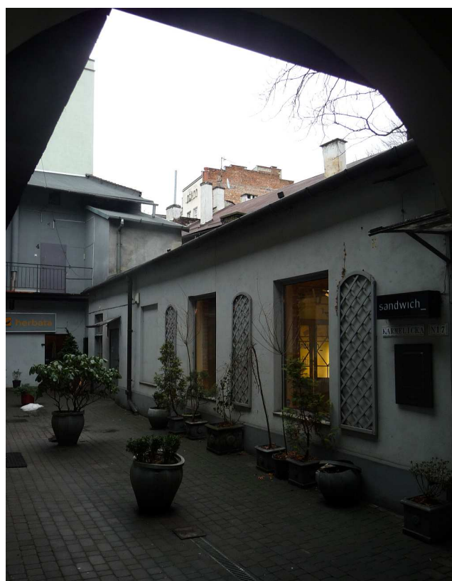
Fot. nr 197. Odnowiony dziedziniec domu pod nr 17. (11.02.2014)
