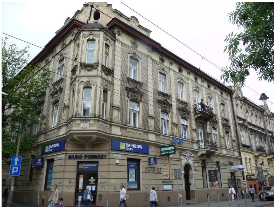
Fot. nr 114. Kamienica z ulicy Karmelickiej 52/Grabowskiego 1, która powstała w roku 1906 wg projektu Beniamina Torbe. Jej styl jest zbliżony do sąsiadki spod nr 54. (04.06.2012)
