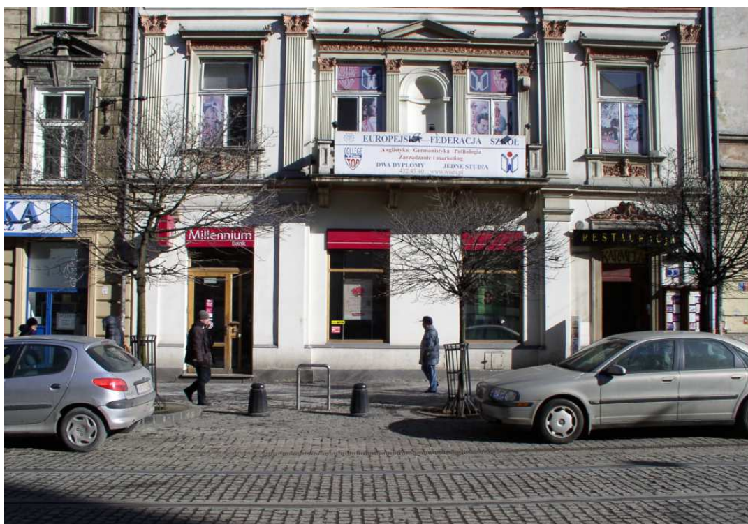
Fot. nr 217. W parterze tej kamienicy w czasach PRL funkcjonowała popularna w Krakowie restauracja Ermitage, gdzie w przyjemnym wnętrzu można było wypić piwo Zagłobę ze śledzikiem w śmietanie na „zagrychę”. (12.02.2011)
