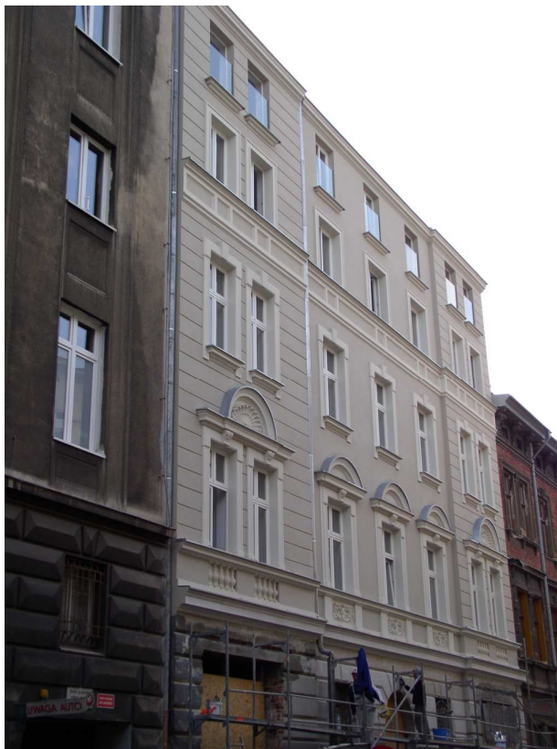
Fot. nr 18. Tu widoczne już jest jej zeszpecenie przez dobudówkę dwóch pięter i obdarcie z wielu dawnych detali, m.in. profilowanych okien. (13.09.2010)
