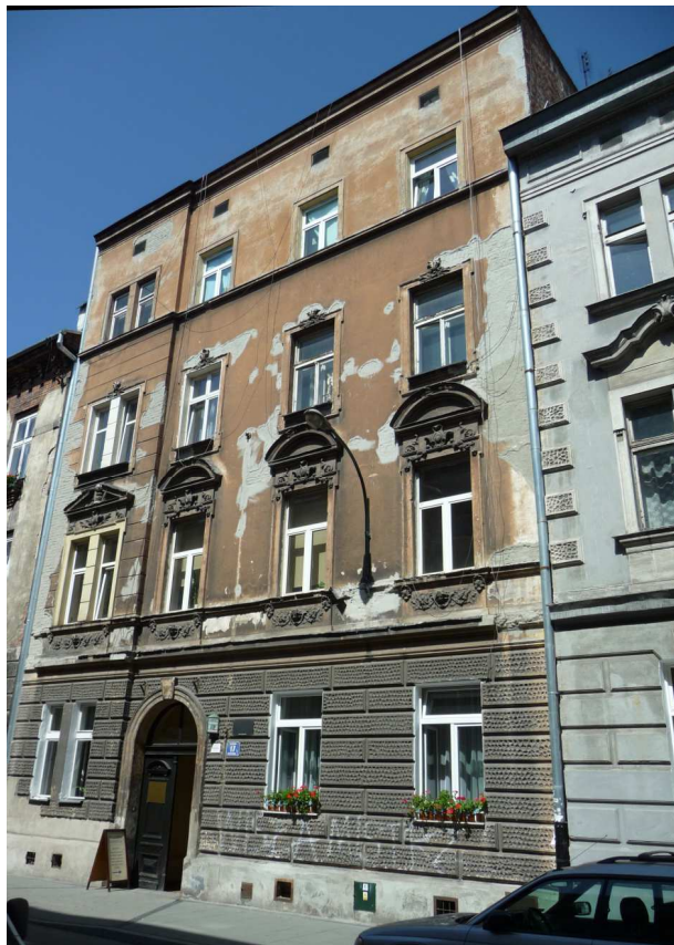
Fot. nr 40 (40-42). Kamienica pod nr 17, która powstała w roku 1902 wg projektu Leopolda Tlachny, głównego architekta tej ulicy. (20.08.2012)
