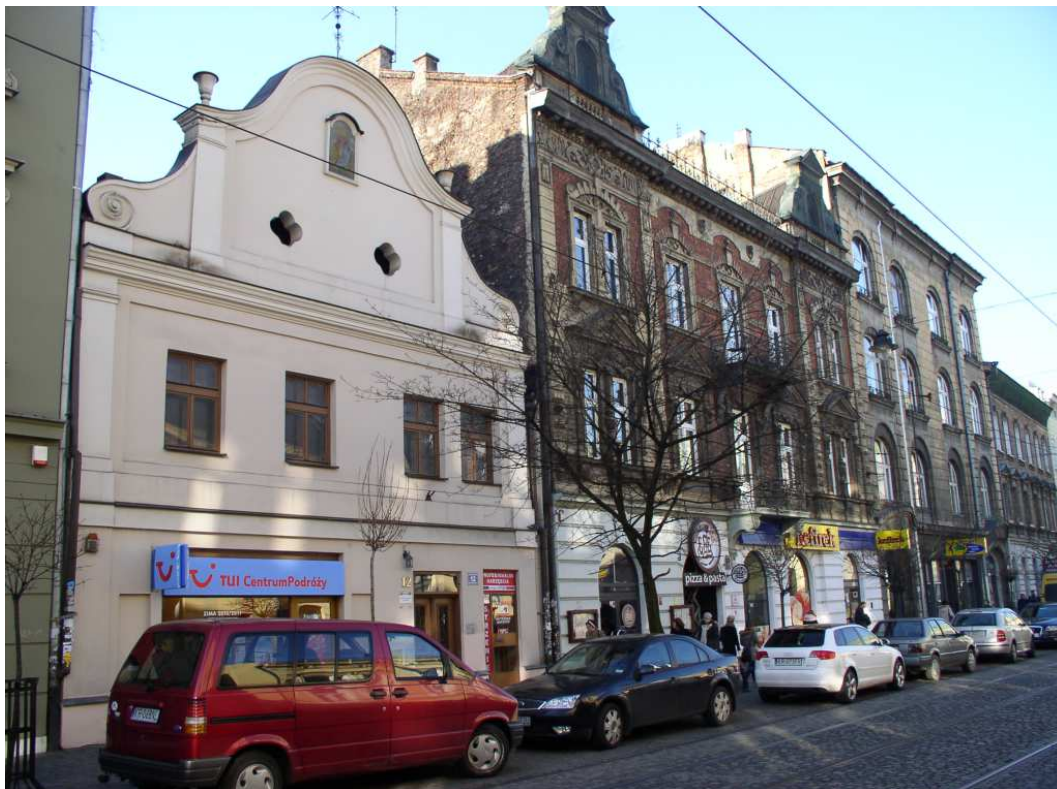
Fot. nr 204. Kamienica pod nr 14 (z prawej) powstała w roku 1899 wg projektu Aleksandra Biborskiego. (26.11.2010)
