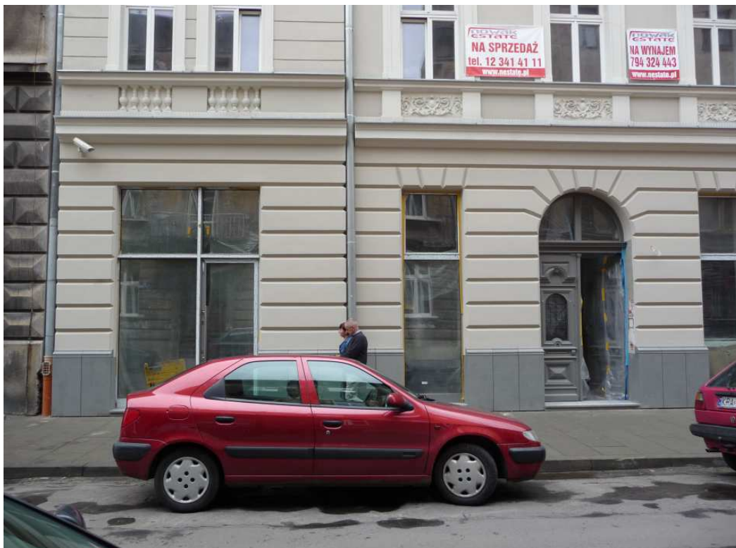
Fot. nr 24. Parter przerobiony na pomieszczenia usługowe. (26.07.2011)
