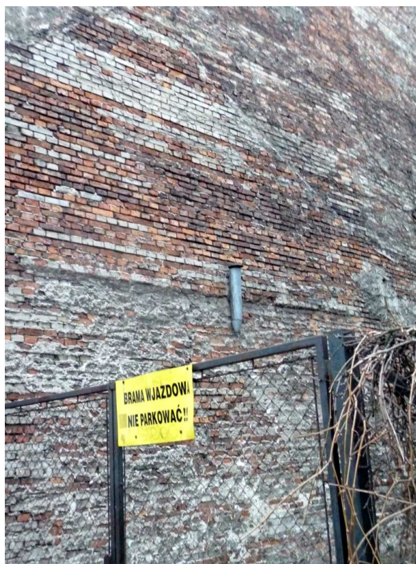
Fot. nr 283. Narys dach dawnego domku. (11.02.2014)
