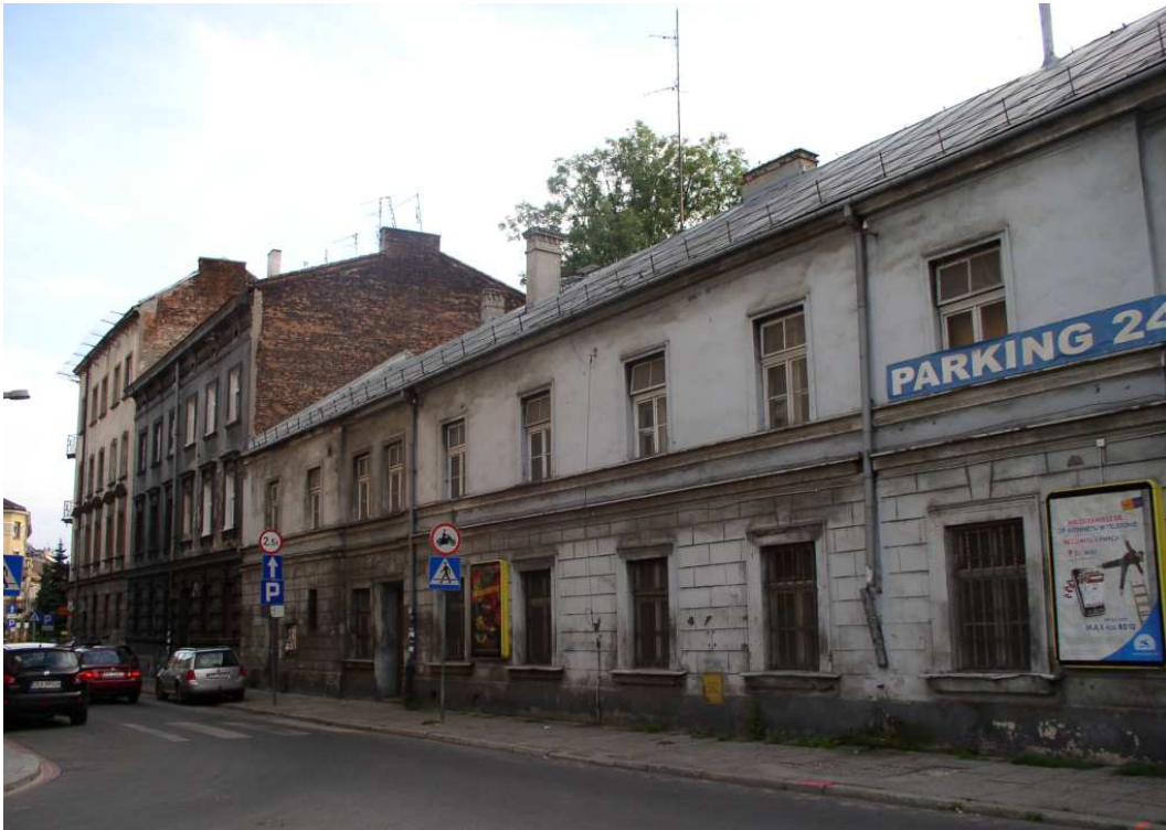
Fot. nr 62 (62-64). Zabudowania socjalne dawnych Krakowskich Zakładów Tytoniowych, pierwotnie Rządowej Fabryki Tytoniu i Cygar, usytuowane wzdłuż ulicy Dolnych Młynów 8-10. Fabryka powstała w roku 1872. (18.08.2010)
