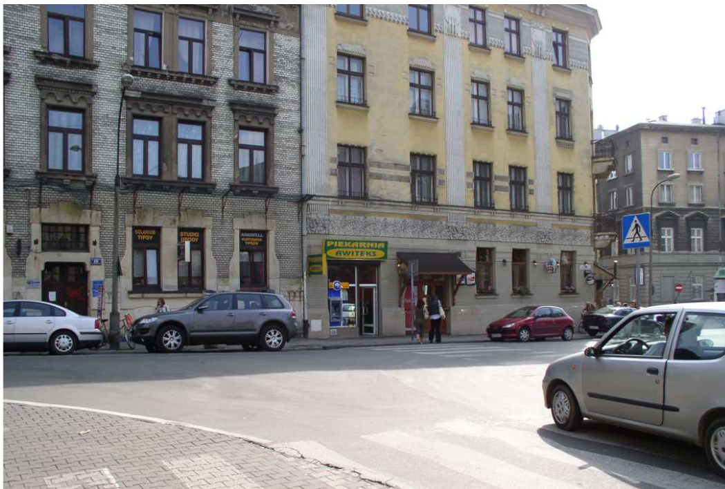
Fot. nr 286. Kamienice z ulicy Krupniczej 28 i 30, które zostały wybudowane na początku XX wieku. Tam, gdzie widoczny sklep Awiteksu w czasach PRL mieściła się tzw. „spółdzielnia”, czyli sklep ogólnospożywczy PSS Społem. (13.09.2010)
