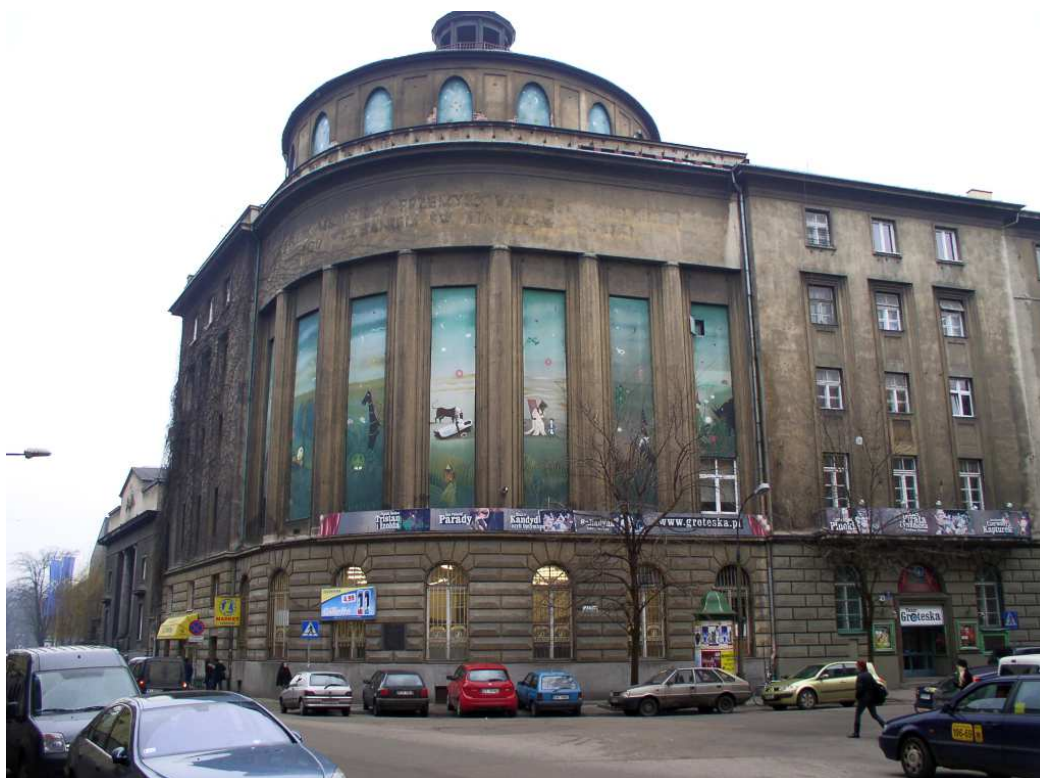
Fot. nr 293 (293-297). Dawna Bursa księdza Mieczysława Kuznowicza w narożu ulic: Skarbowej 4 i Krupniczej 29. W jej parterze, z wejściem od strony ulicy Skarbowej, gdzieś do końca lat 60. znajdował się Teatr Rapsodyczny, a po jego rozwiązaniu przeniósł się tutaj Teatr Groteska, poprzednio funkcjonujący przy ulicy św. Jana 6. (18.01.2011)
