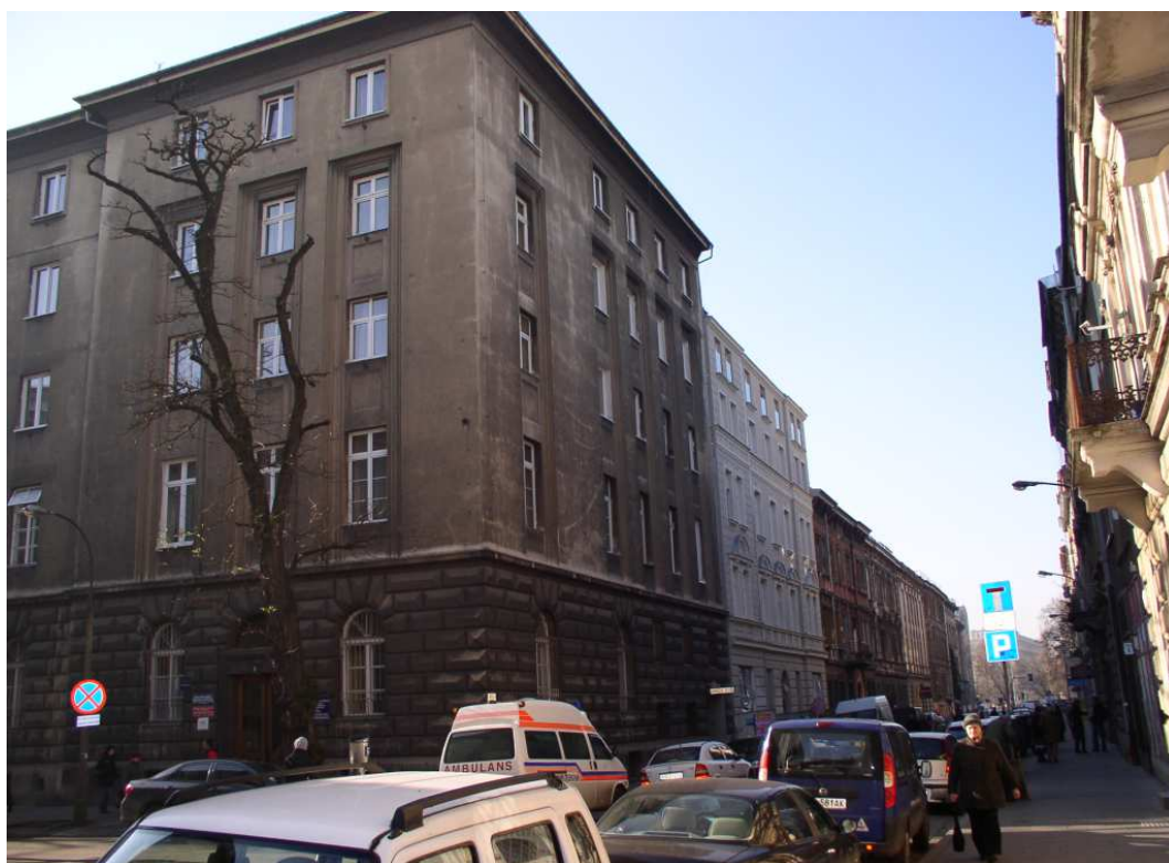
Fot. nr 19. Nadbudowa dwóch pięter dodatkowo zaburzyła całą pierzeję tej ulicy o parzystych numerach. (26.11.2010)
