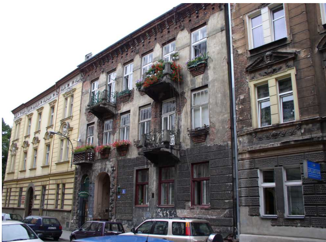
Fot. nr 49. Również potwornie zniszczona kamienica z ulicy Czystej 19, która została wybudowana w latach 1896-1897 wg projektu Aleksego Kowalskiego i zawiera już elementy secesji. (04.08.2010)
