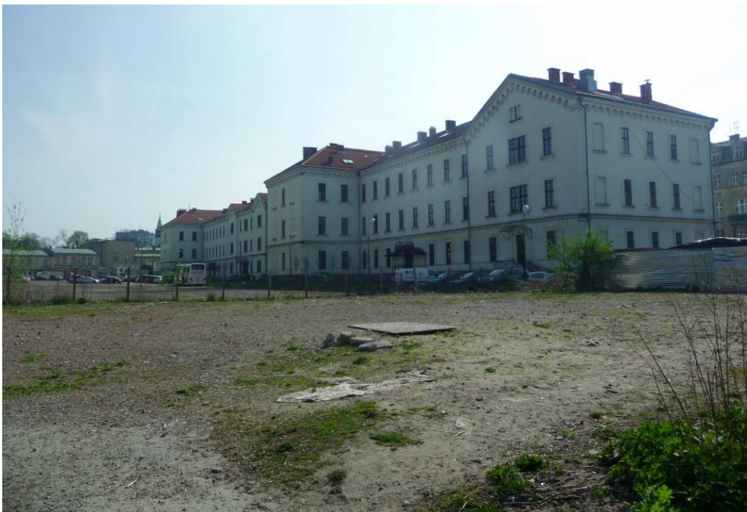
Fot. nr 83. Dziedziniec dawnych C.K. koszar (widok od strony ulicy Dolnych Młynów), o którego dalsze wykorzystanie trwa bój. Czy powstanie tu jakaś oaza zieleni, o co od lat toczy boje strona społeczna, czy będzie to kolejny przykład "betonowania" i "dogęszczania" centrum Krakowa i powstaną tu np. gmachy IPN? (07.04.2014)
