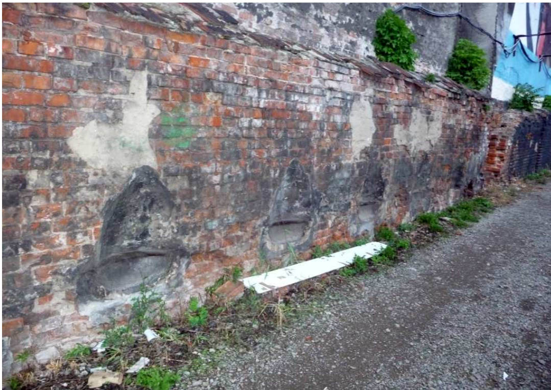
Fot. nr 144 (144-148). Pozostałości po poidłach dla koni na murze granicznym kamienicy pod nr 28, który przylega do dziedzińca dawnych C.K. koszar przy ulicy Rajskiej 1-3. (26.09.2013)
