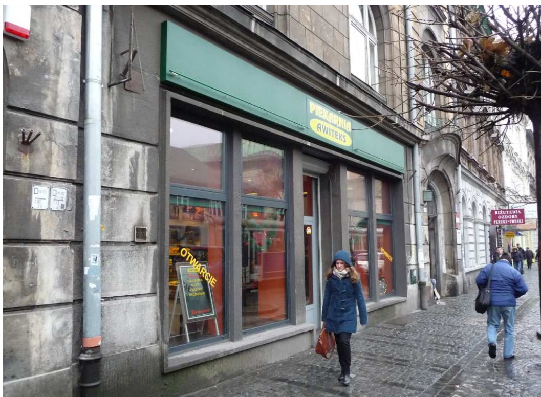
Fot. nr 202. Parter kamienicy pod nr 16, gdzie do początku XXI wieku przez dekady funkcjonował popularny w Krakowie sklep rybny. Kamienica powstała w latach 1910-1911 wg projektu Wawrzyńca Karselera. (10.01.2012)
