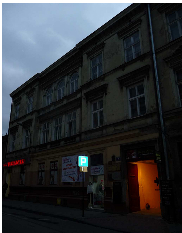
Fot. nr 237 (237-239). Kamienica z ulicy Krupniczej 8 i detale jej sieni. Powstała ona w latach 1873-74, a jej projektantami byli: Teofil Żebrawski, Tomasz Pryliński Tomasz i Juliusz Niedziałkowski. (26.09.2013)
