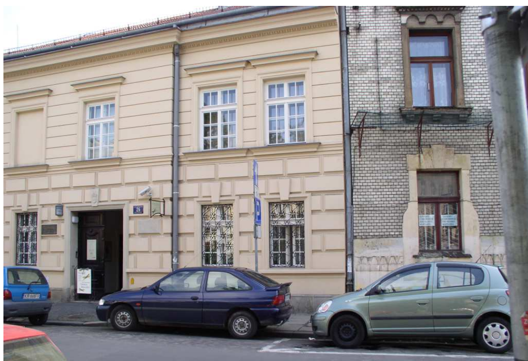
Fot. nr 285. Na prawo od drzwi wejściowych do domu Mehoferów spod nr 26 w czasach PRL znajdował się sklepik spożywczy Pani "Gieni" Mazgajewskiej i jej syna "Edka" (pierwsze z dwóch okien były wtedy drzwiami), kolejnych „prywaciarzy”. (13.09.2010)
