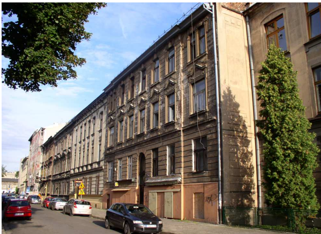
Fot. nr 43 (43-48). Bogato zdobiona, ale potwornie zniszczona kamienica z ulicy Czystej 16, która powstała w roku 1906 wg projektu Beniamina Torbe.
