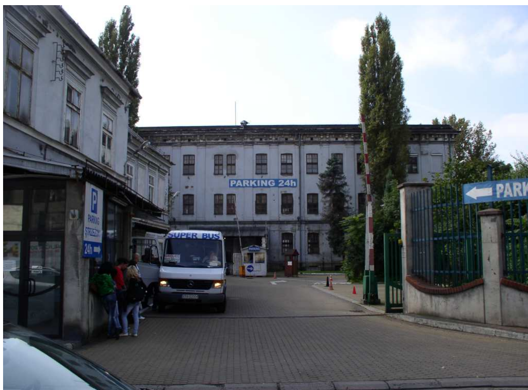
Fot. nr 79. Budynki fabryczne, które już od dawna stały puste. I dziś raczej nieciekawie rysuje się perspektywa kompleksowego ich wykorzystania, choć ostatnio w sposób chaotyczny powstało tam kilka obiektów gastronomicznych. (13.09.2010)
