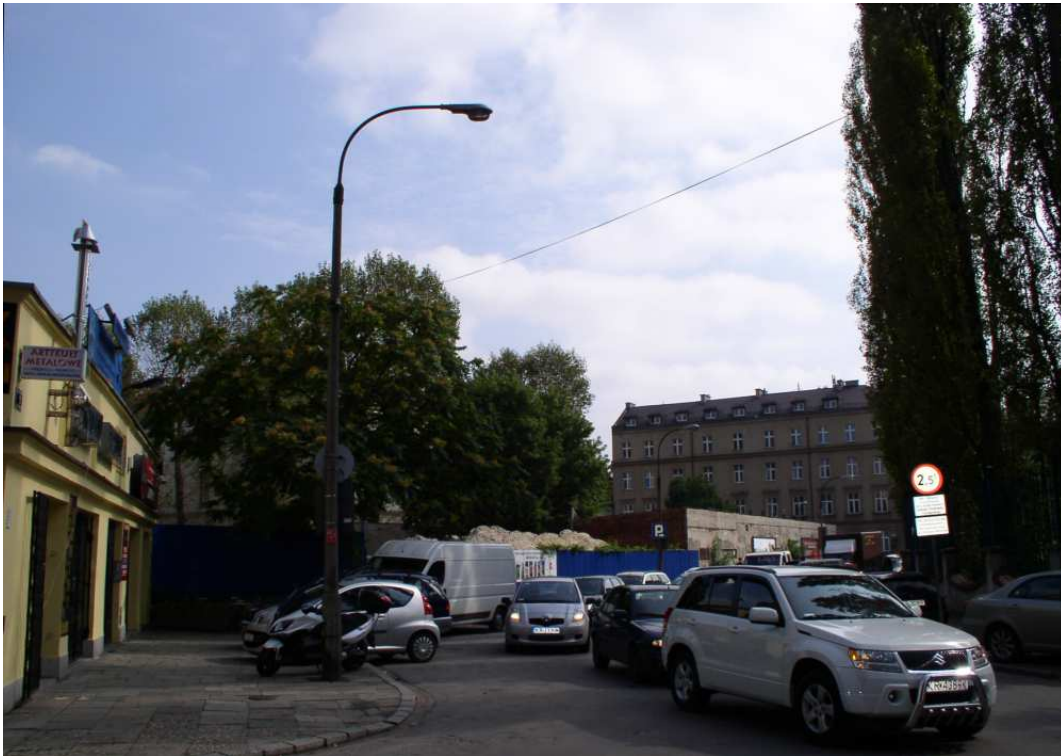
Fot. nr 82. W wyglądzie tego fragmentu ulicy Dolnych Młynów w zasadzie niewiele się zmieniło, gdyż wyburzony został jedynie dwupiętrowy budynek dawnego lazaretu spod nr 11 (widok pustego po nim placu na wprost) przylegający do dawnych koszar wojskowych. (13.09.2010)
