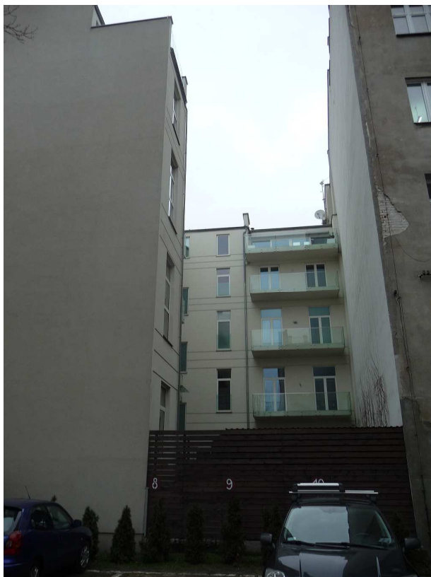
Fot. nr 30 (30-31). Widoki od strony podwórka dawnego gmachu WRZZ z ulicy Skarbowej 2. Gdzie podziła się dawna wolna przestrzeń? (11.02.2014)
