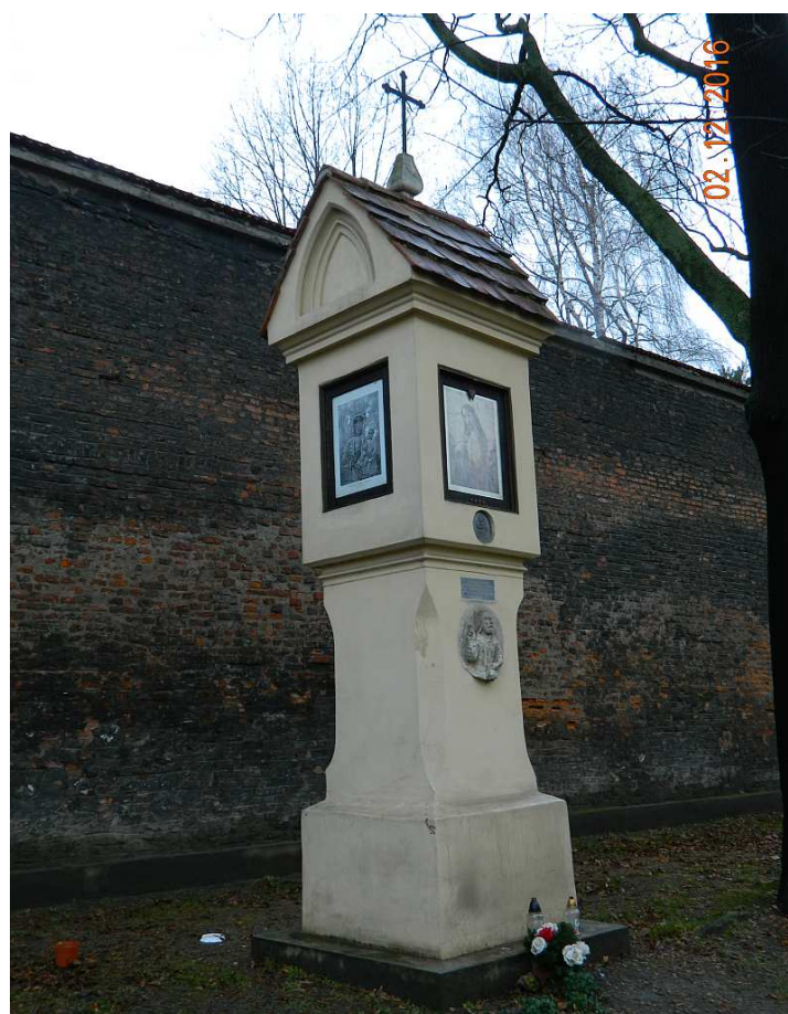
Fot. nr 29 (29-31). Dawna latarnia przy murze klasztoru Karmelitanek i jej detale.
