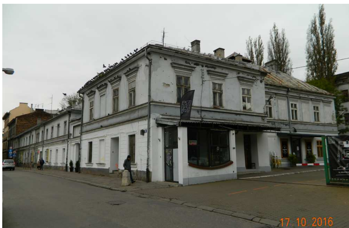
Fot. nr 69 (69-95). Fotografie kompleksu budynków dawnej rządowej „cygar fabryki” z ulicy Dolnych Młynów 10-12. Tu Zabudowania socjalne i brama wjazdowa do dawnych Krakowskich Zakładów Tytoniowych.
