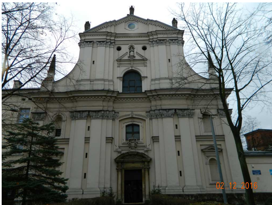
Fot. nr 25. Fasada kościoła.
