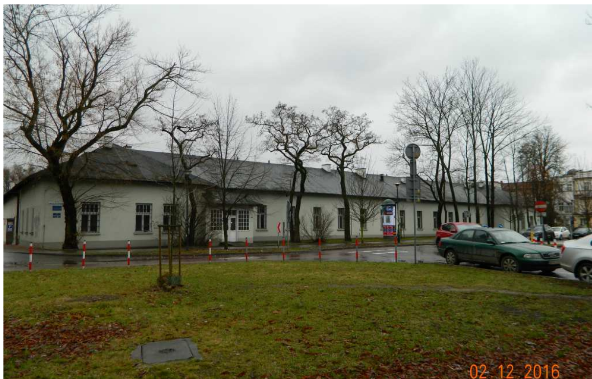
Fot. nr 35. Dawnie stajnie wojskowe w miejscu folwarku Klarysek na posesji przy ulicy Kopernika 31. Dziś obiekt należy do UJ.
