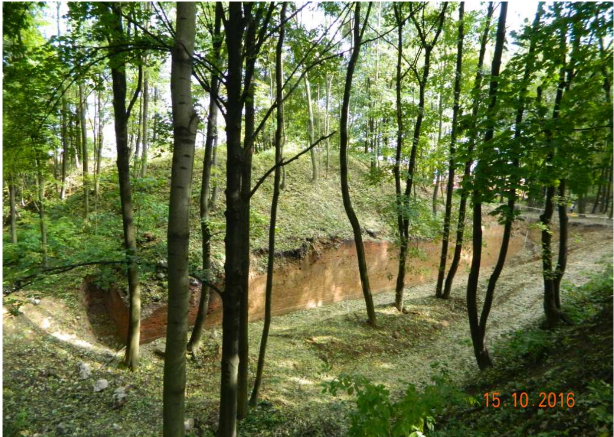
Fot. nr 132 (132-134). Odsłonięty fragment ściany zewnętrznej bastionu nr II.
