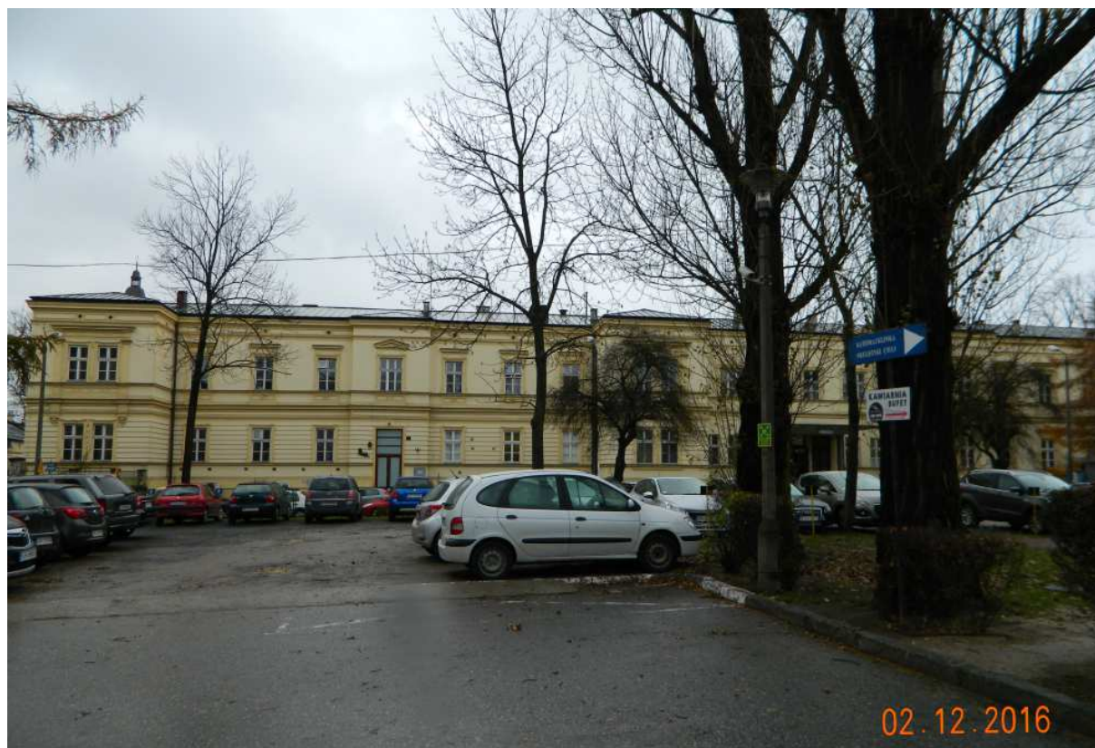
Fot. nr 22. Fasada szpitala dziecięcego, który został wzniesiony w roku 1874.
