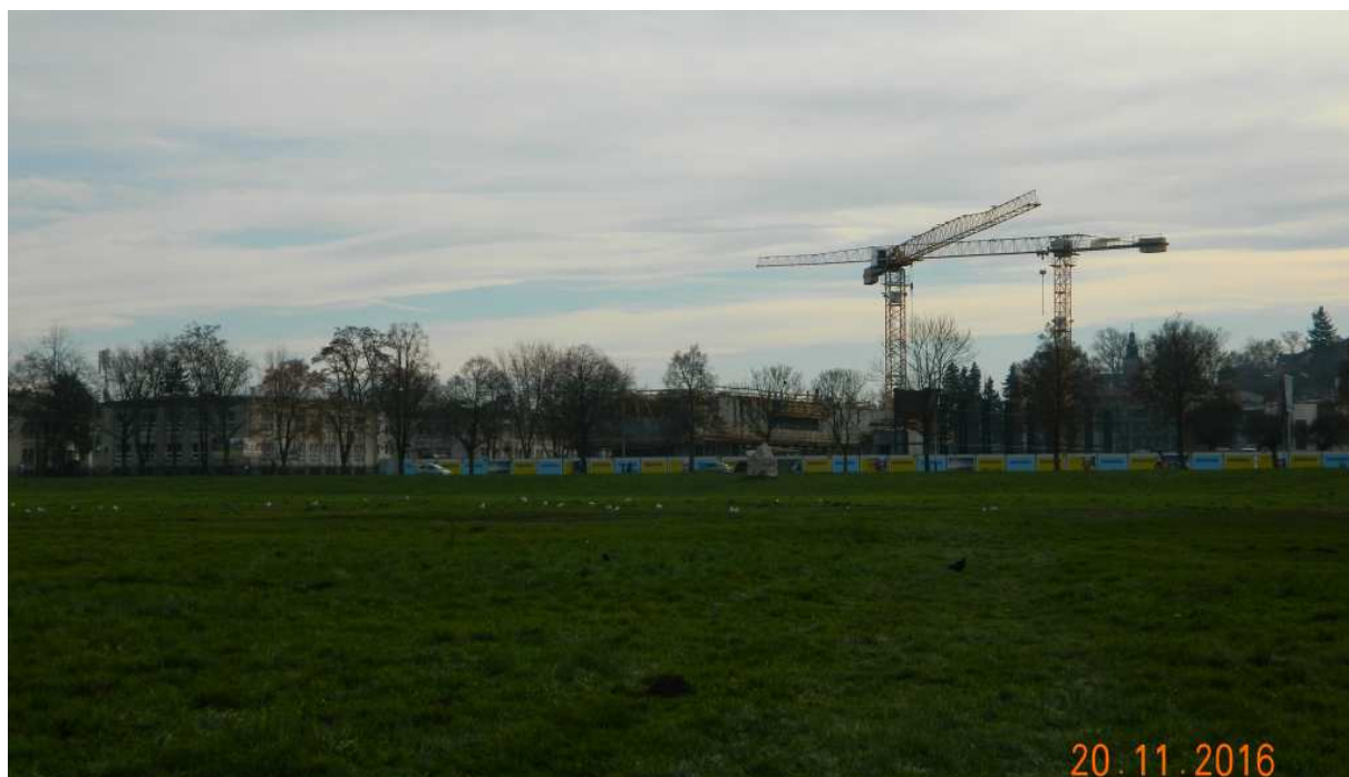
Fot. nr 118. Ponad Błoniami w stronę Salvatora. Na pierwszym planie trwa już budowa hali (Comarch) Cracovii.
