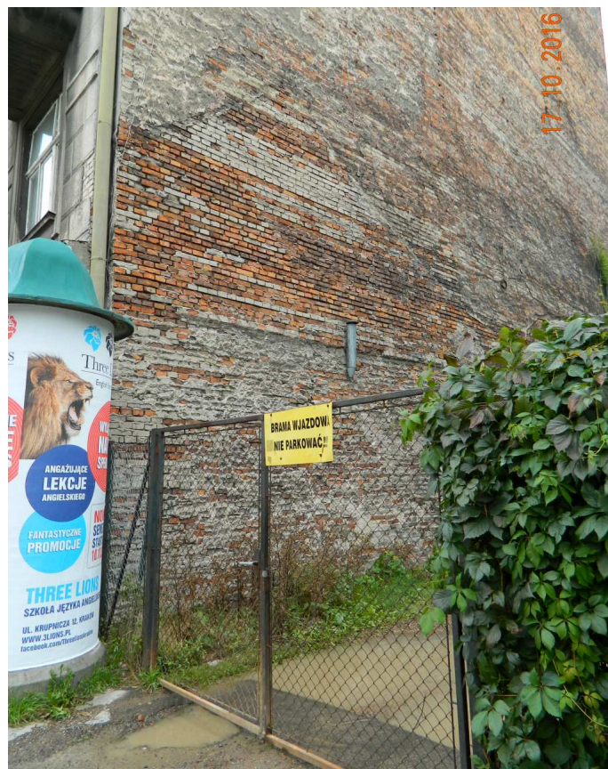
Fot. nr 101. Widoczny na ścianie bocznej Domu Literatów narys dachu parterowego domu malarza Witolda Rzegocińskiego z ulicy Krupniczej 24, który znikł ponad 30 lat temu.
