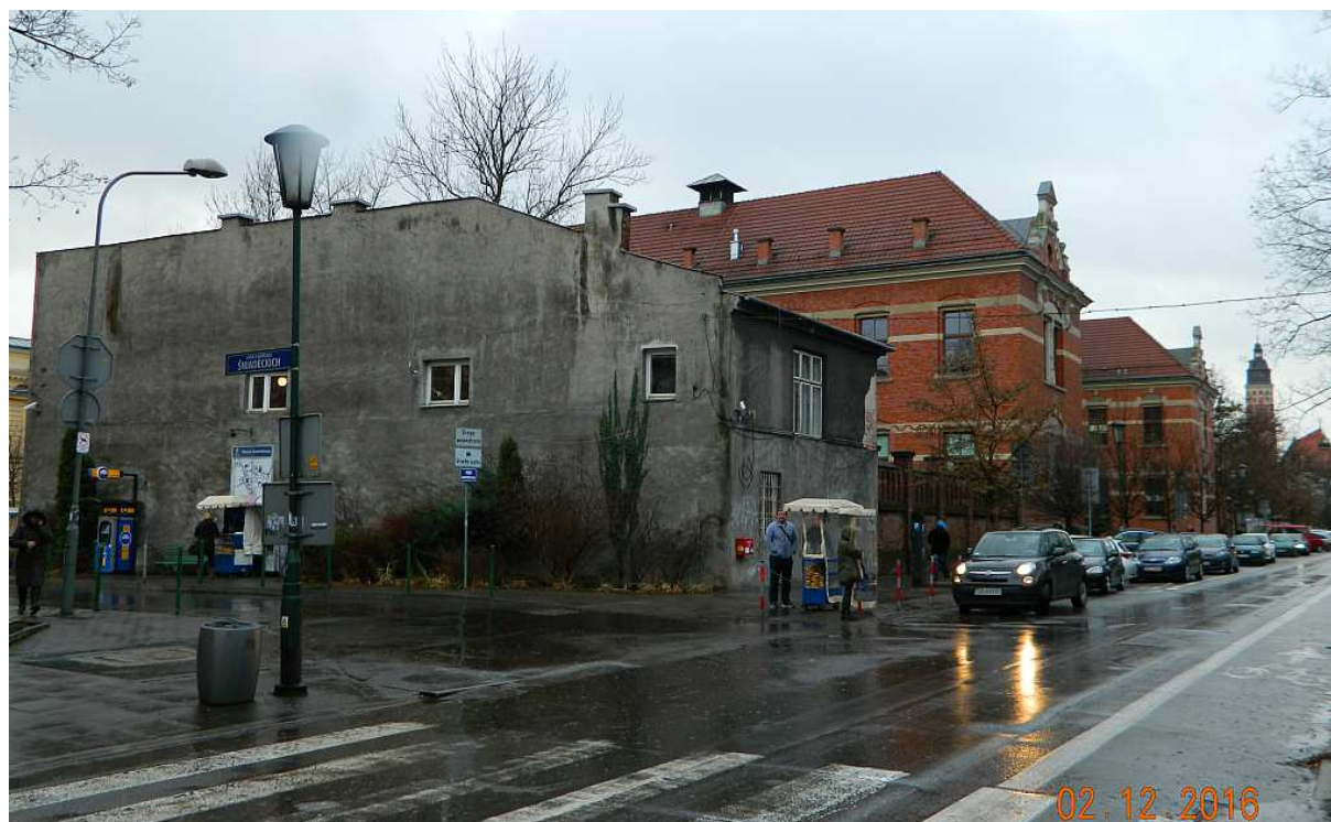
Fot. nr 26. Widok na budynek Czerwonej Chirurgii przy ulicy Kopernika 21. Powstał w roku 1891 wg projektu Karola Zaremby.
