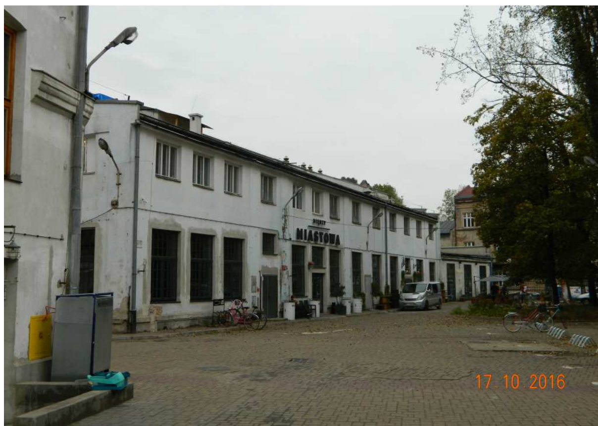
Fot. nr 81 (81-83). Dawne garaże we fragmencie od strony ulicy Czarnowiejskiej.
