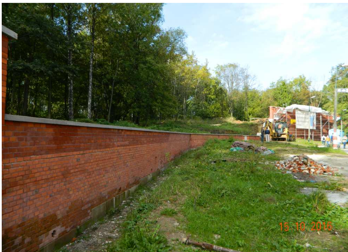
Fot. nr 129 (129-131). Trwa właśnie rekonstrukcja ściany wewnętrznej bastionu nr II.
