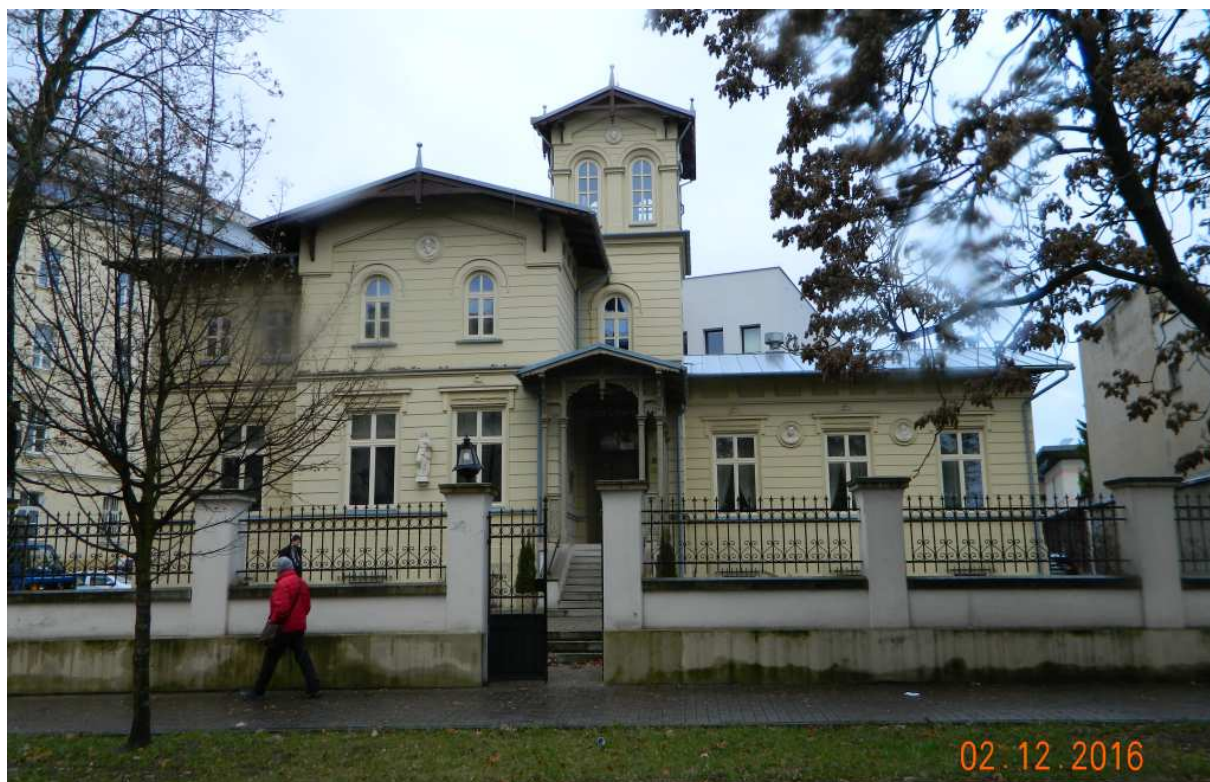
Fot. nr 17 (17-18). Willa Zofiówka spod nr 30, przykład zabudowy kurortowej w stylu szwajcarskim. Powstała w roku 1872 wg projektu Antoniego Łuszczkiewicza.
