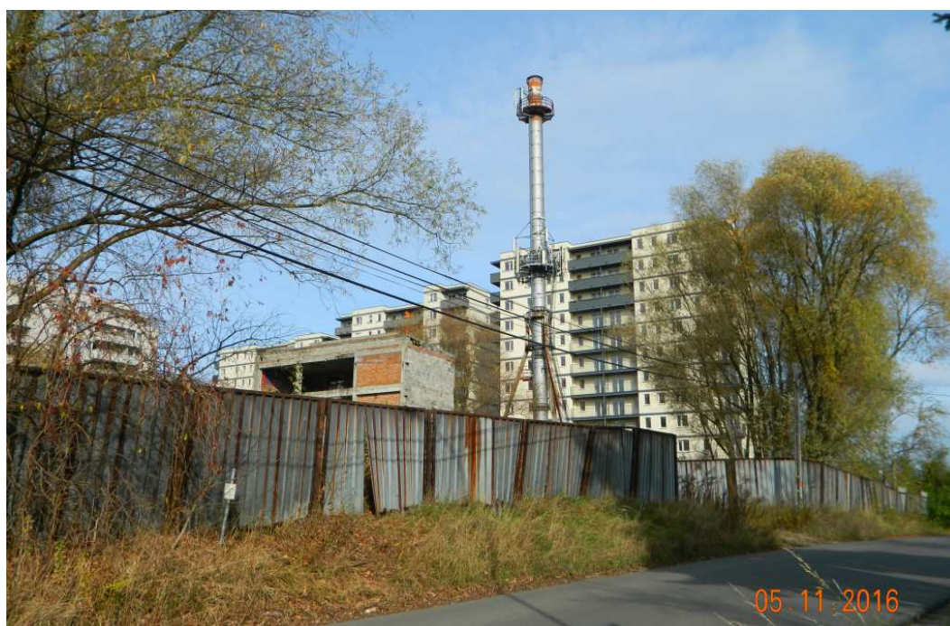
Fot. nr 321. Po zaniechany, dawnym szpitalu podgórskim pozostała już tylko ruina spalarni odpadów. Dziś w tym miejscu rozbudowuje się blokowisko przy ulicy Bochenka.
