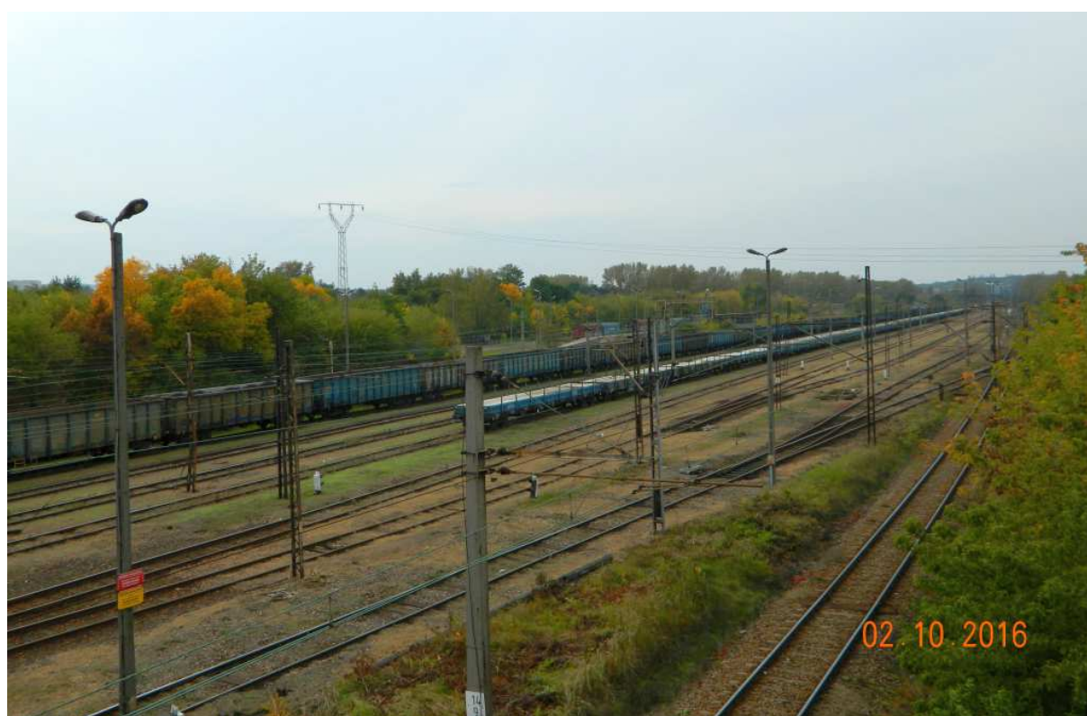
Fot. nr 311. Widok z kładki nad torami w stronę Płaszowa.
