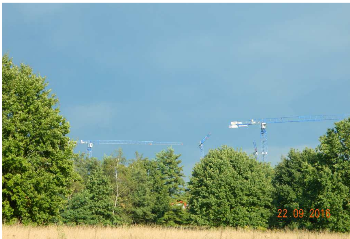
Fot. nr 346. Zielone jeszcze klimaty z placem budowy centrum medycznego AM w tle.
