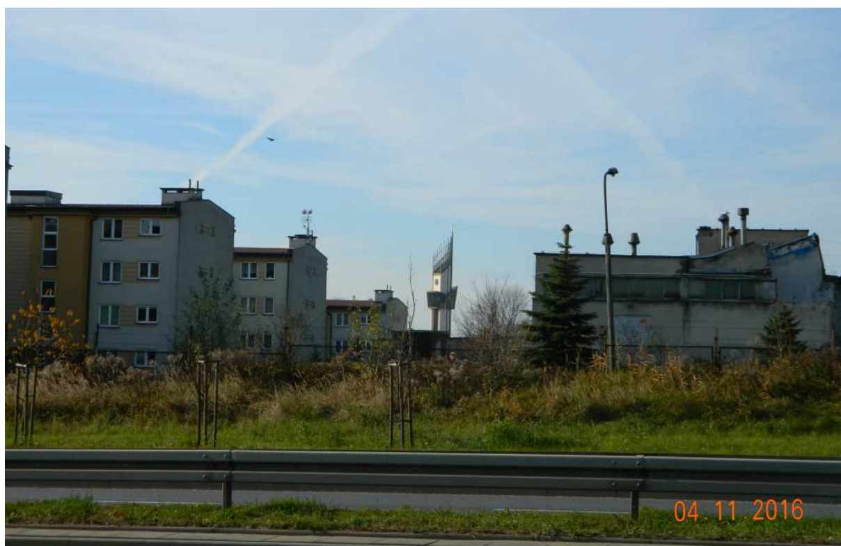
Fot. nr 197. Wieża Sanktuarium BM w Łągielnikach ponad ulicą Turowicza. Z prawej zabudowania fabryczne cegielni Bonarka.
