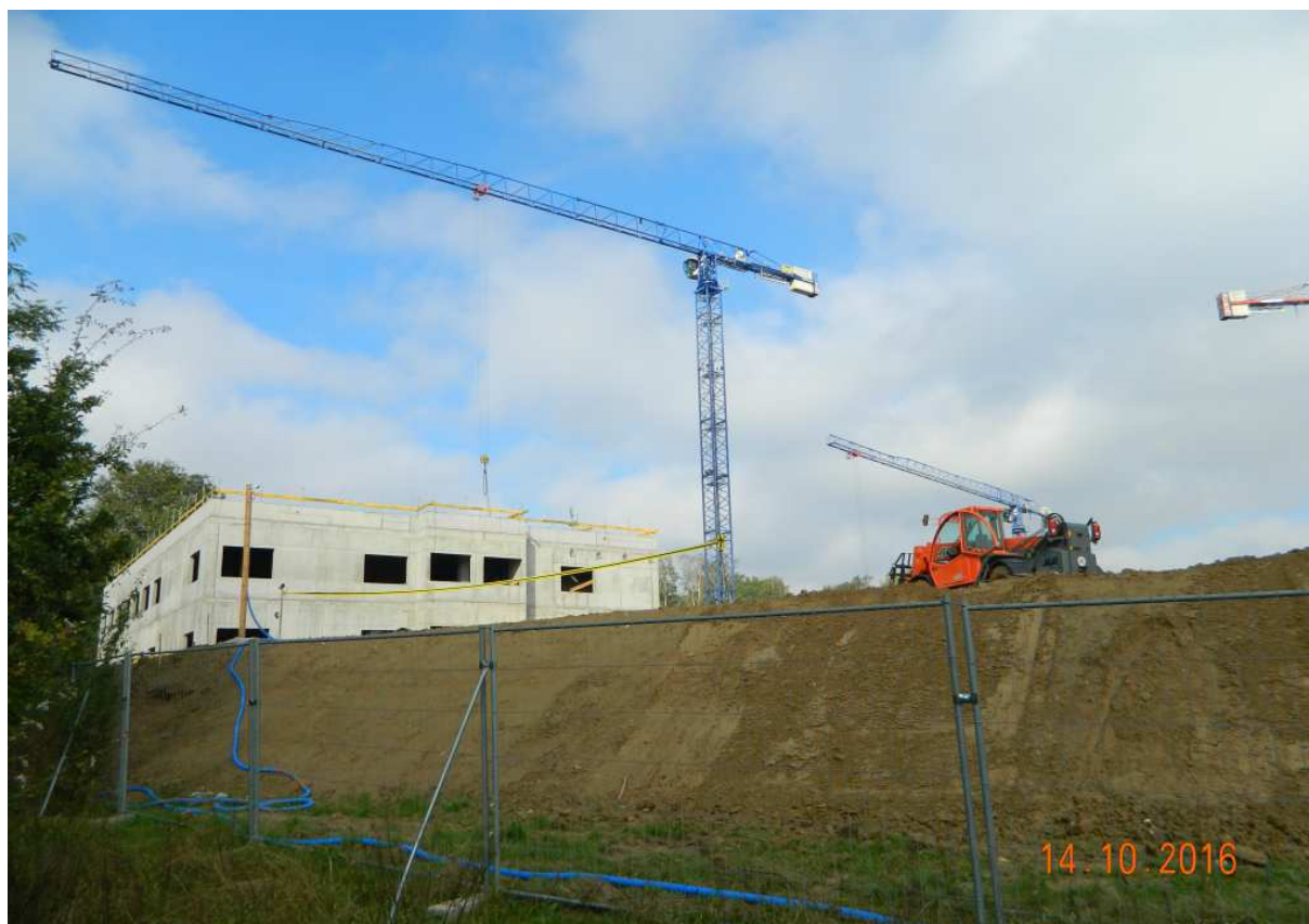
Fot. nr 362 (362-366). Kilka migawek placu budowy nowego centrum medycznego AM w ujęciach od strony ulicy Słona Woda.
