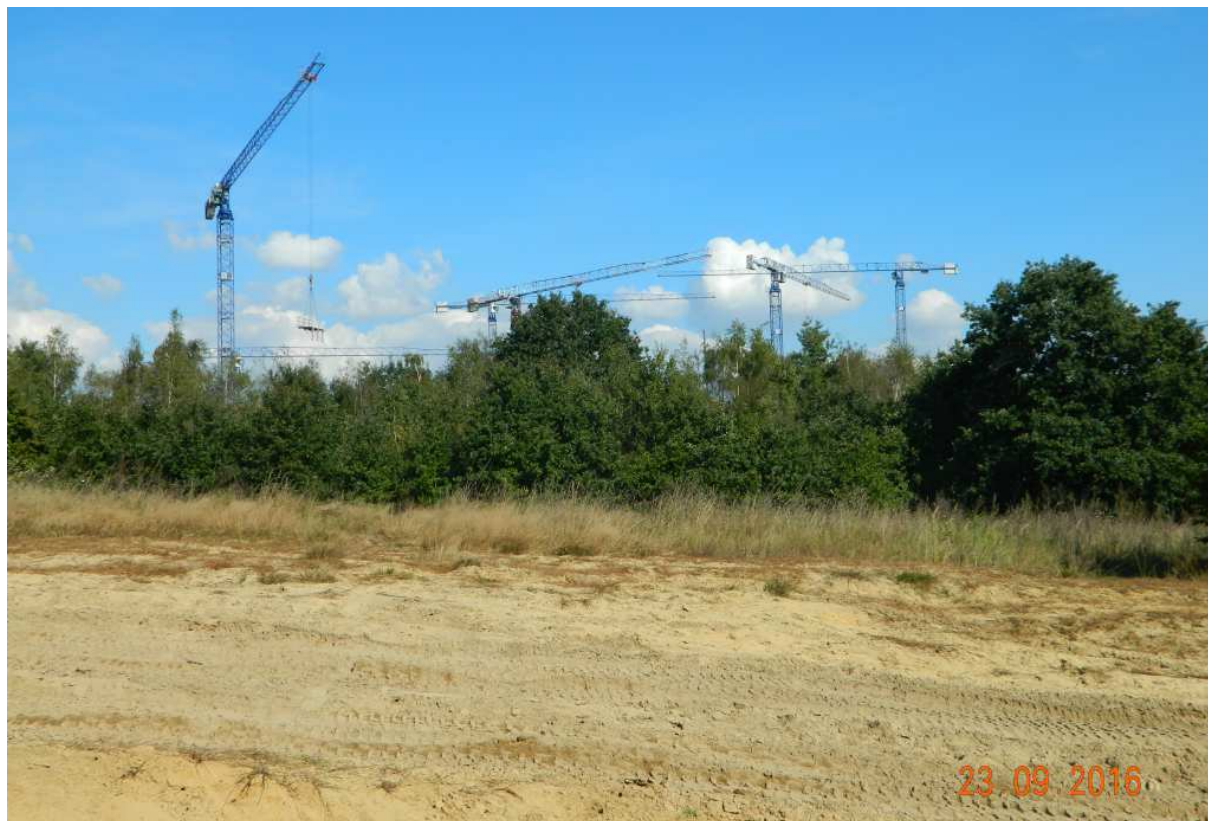
Fot. nr 358 (358-359). Rozjeżdżony przez motocykle i quady fragment dawnych pól uprawnych w sąsiedztwie ulicy Słona Woda. W tle trwa budowa centrum medycznego AM.
