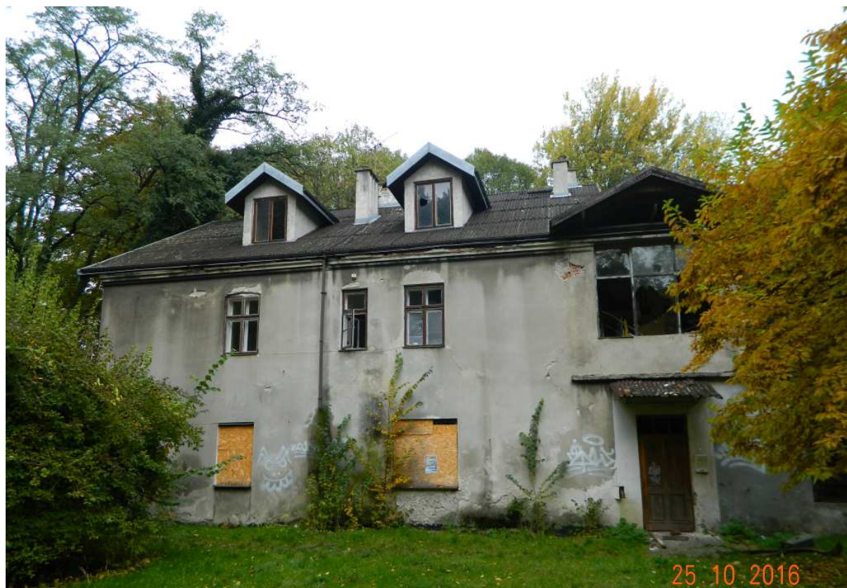
Fot. nr 204 (204-206). Fasada dworu.
