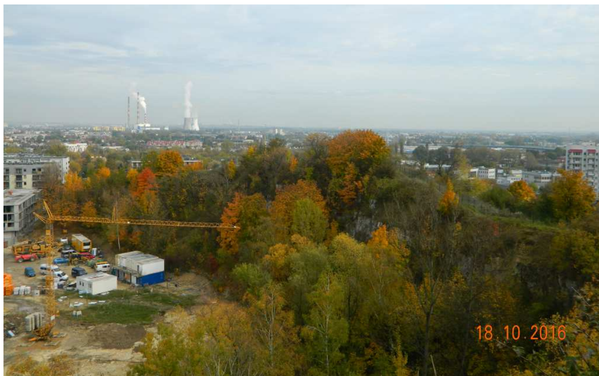
Fot. nr 124 (124-127). Widoki na wschodnie rubieże Krakowa znad dawnego kamieniołomu miejskiego przy ulicy Jerozolimskiej, którego niecka jest obecnie szybko zabudowywana.
