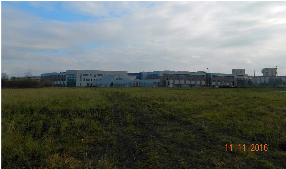
Fot. nr 54 (54-55). Zabudowania kampusu UJ wzdłuż ulicy Łojasiewicza i ich przedpole w ujęciu z ulicy Gronostajowej.
