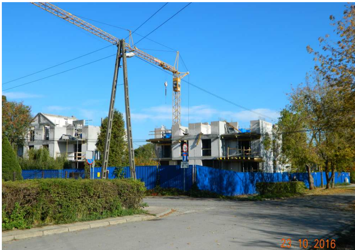
Fot. nr 12. Trwa zabudowa końcowego odcinka ulicy Twardowskiego w miejscu zburzonego niedawno budynku dawnego kamieniołomu pod nr 117.
