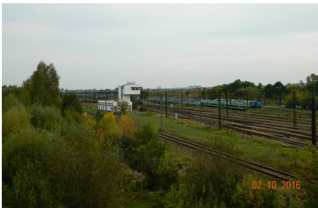
Fot. nr 309 (309-311). Stacja rozrządowa w Prokocimiu, która niebawem ma zniknąć. Fot. nr: 309-310 - widoki w stronę Bieżanowa.
