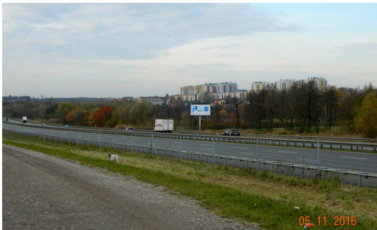
Fot. nr 399. Ponad autostradą w stronę Borku Fałęckiego (z lewej) i osiedla Nowy Kurdwanów.
