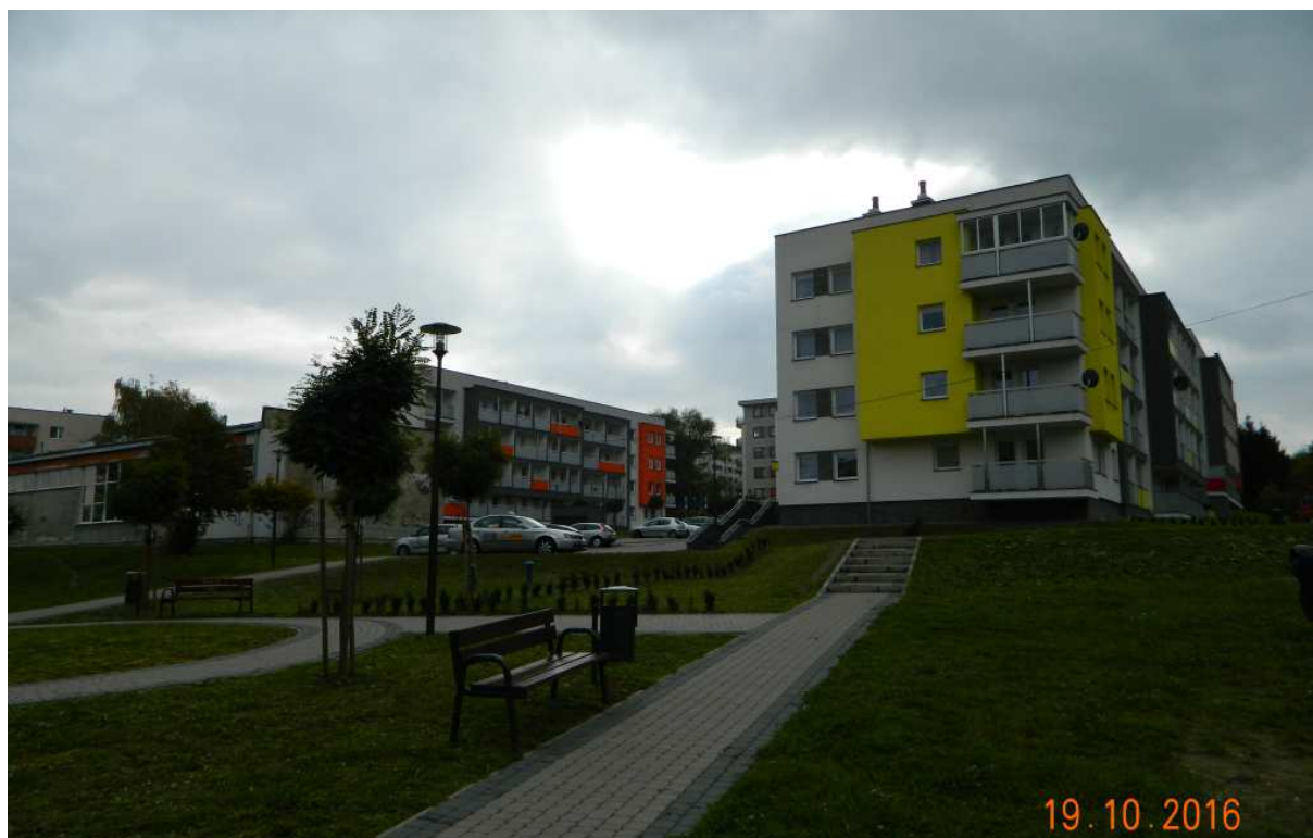
Fot. nr 223 (223-224). Współczesna zabudowa początkowego odcinka ulicy Wolności.
