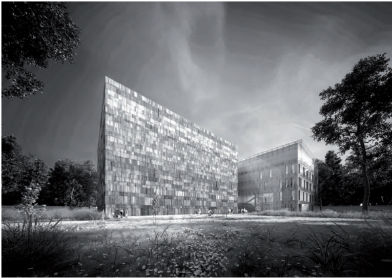
28. Projekt nowego budynku Archiwum Narodowego w Krakowie. Widok od strony południowo-wschodniej – wizualizacja. Po lewej segment magazynowy, po prawej – niższy segment biurowy z przezroczystą fasadą zewnętrzną (wyk. Pracownie Konserwacji Zabytków „Arkona” Sp. z o.o.)
