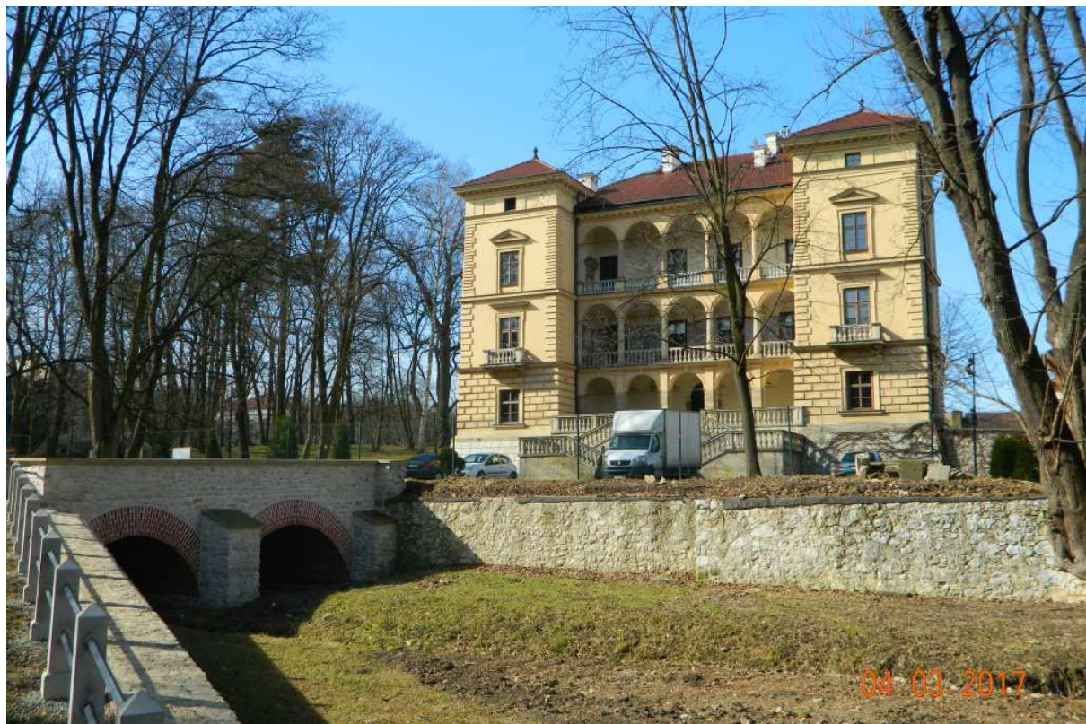
Fot. nr 26. W latach 60-tych w willi tej znajdował się szpital dla chorych na gruźlice, a sam obiekt był bardzo zaniedbany.
