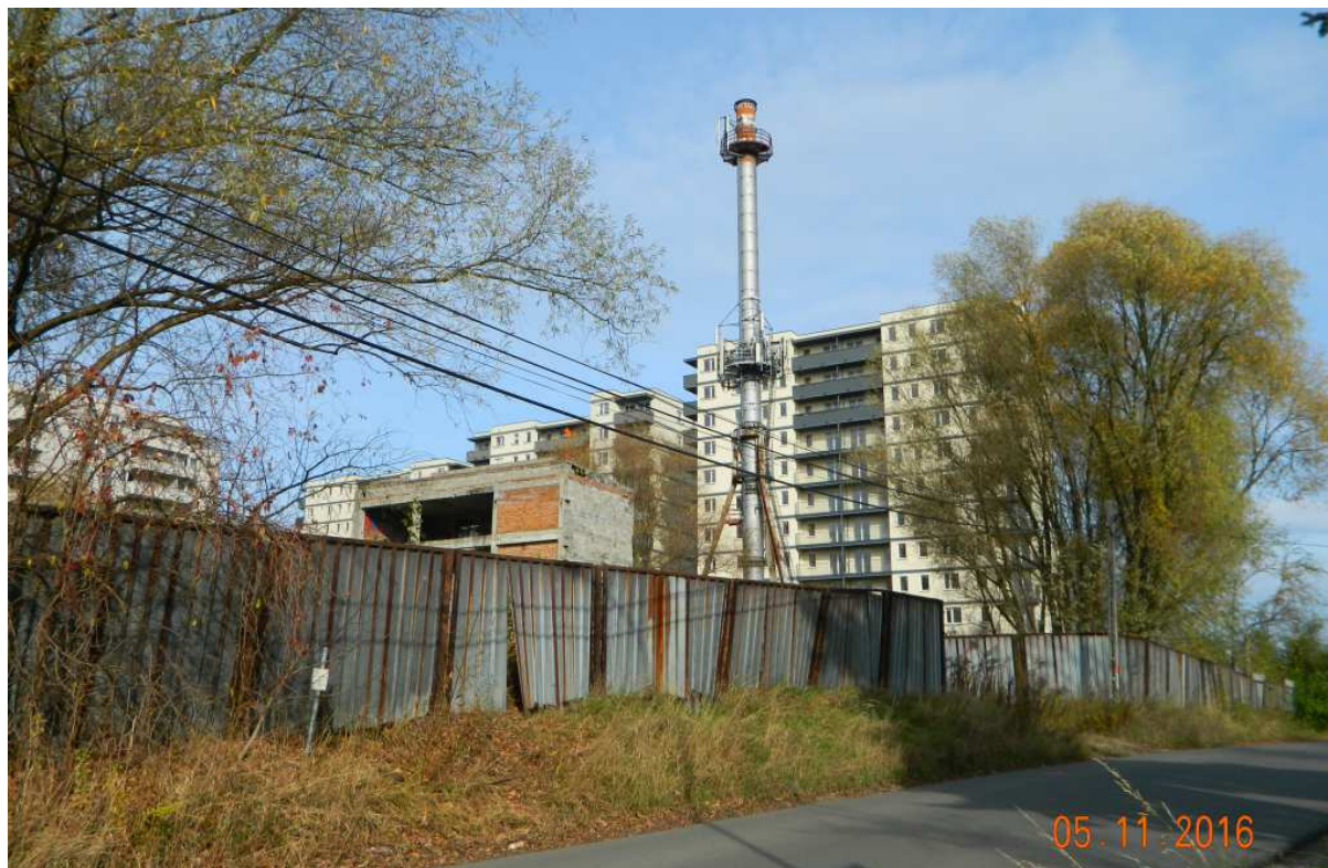
Fot. nr 140. Po zaniechanym, dawnym szpitalu podgórskim pozostała już tylko ruina spalarni odpadów. Dziś w tym miejscu rozbudowuje się blokowisko przy ulicy Bochenka.
