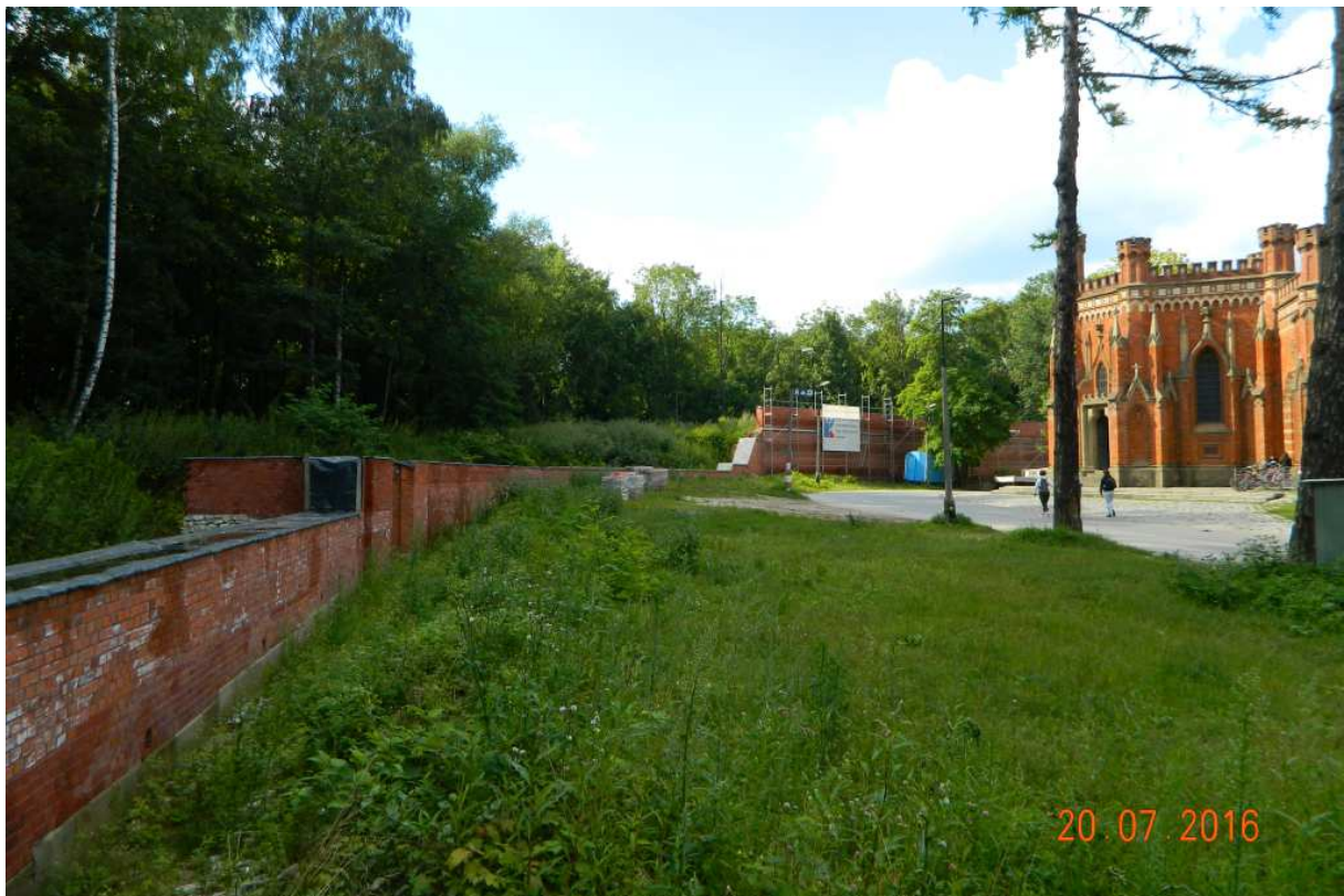
Fot. nr 13 (13-16). Trwa rekonstrukcja narysu i niektórych elementów kurtyny I-II fortu.
