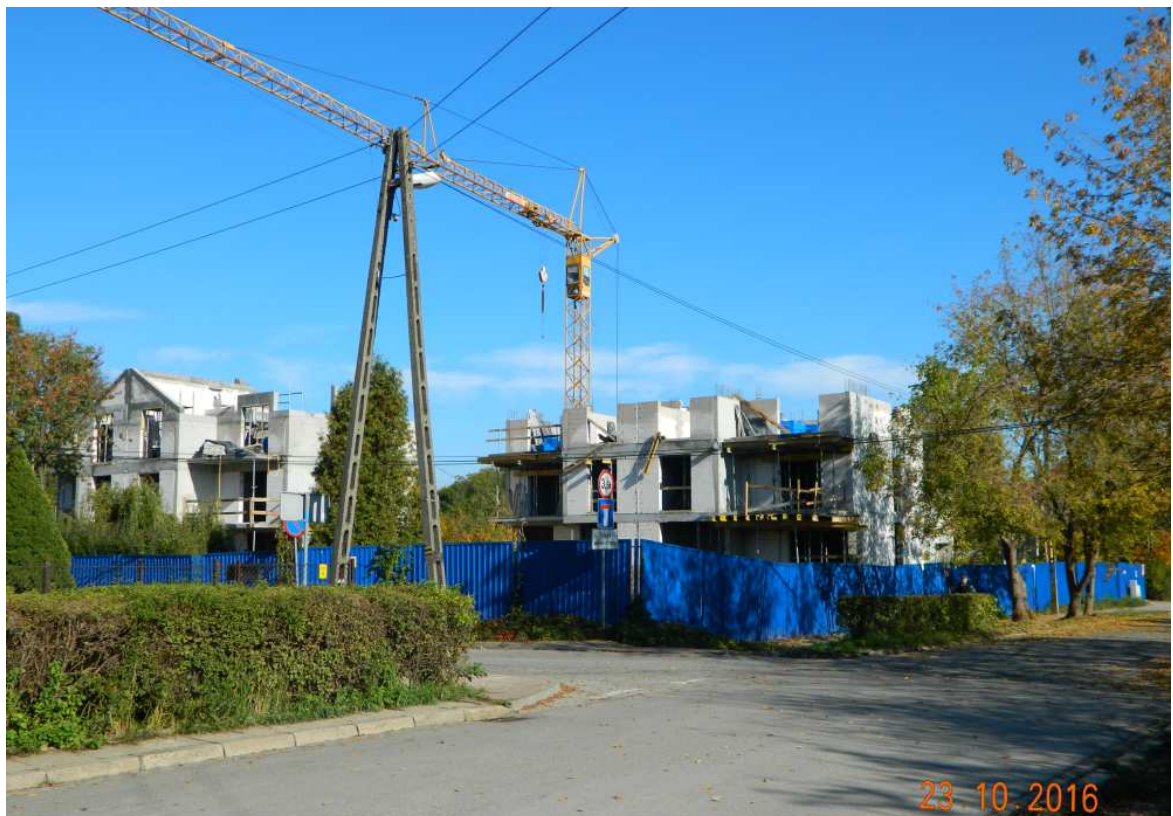
Fot. nr 53. Trwa zabudowa końcowego odcinka ulicy Twardowskiego w miejscu zburzonego niedawno budynku socjalnego dawnego kamieniołomu spod nr 117.
