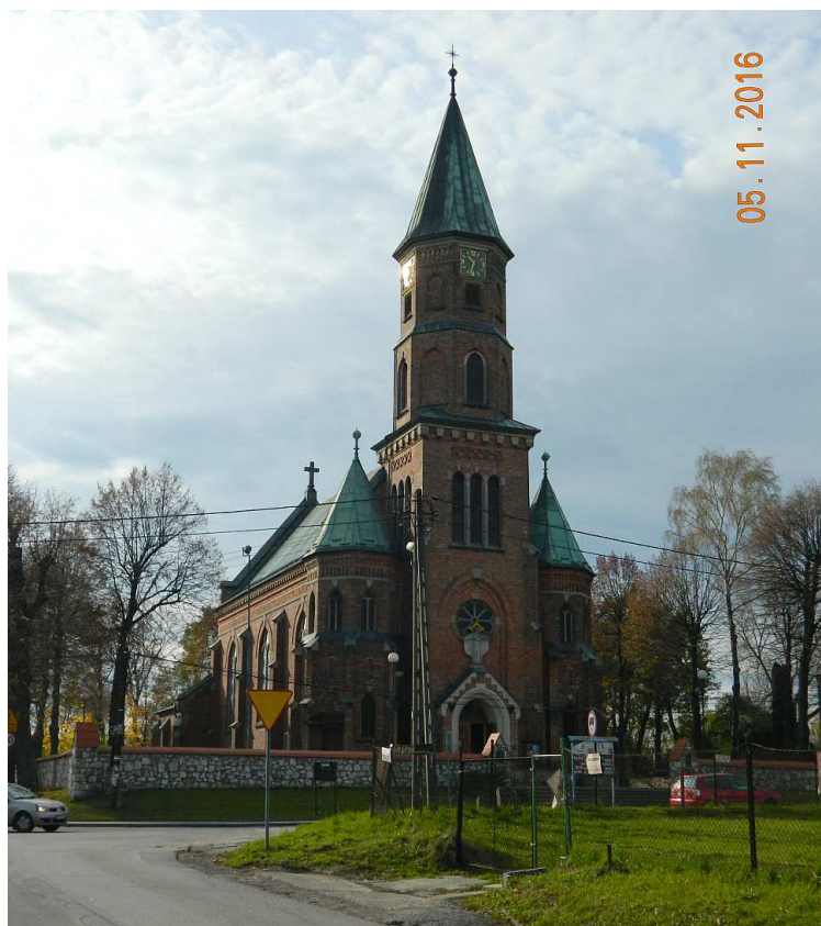
Fot. nr 146. Kościół parafialny dla Piasków Wielkich z naroża ulic: Cechowej i Niebieskiej, zapóźniony przykład eklektyzmu z początku lat 20-tych XX wieku.
