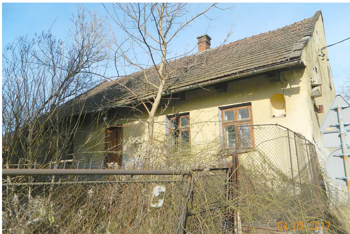
Fot. nr 41. Domek pod nr 5, który jeszcze trwa, ale wokół już tylko współczesna zabudowa, która powstaje w ekspresowym wręcz tempie.
