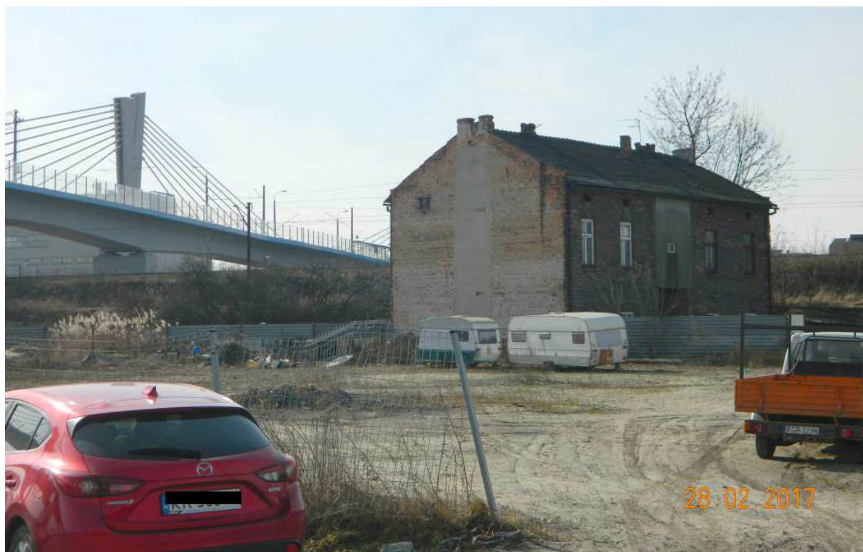
Fot. nr 109. Dawny budynek kolejowy z ulicy Żołnierskiej 62.
