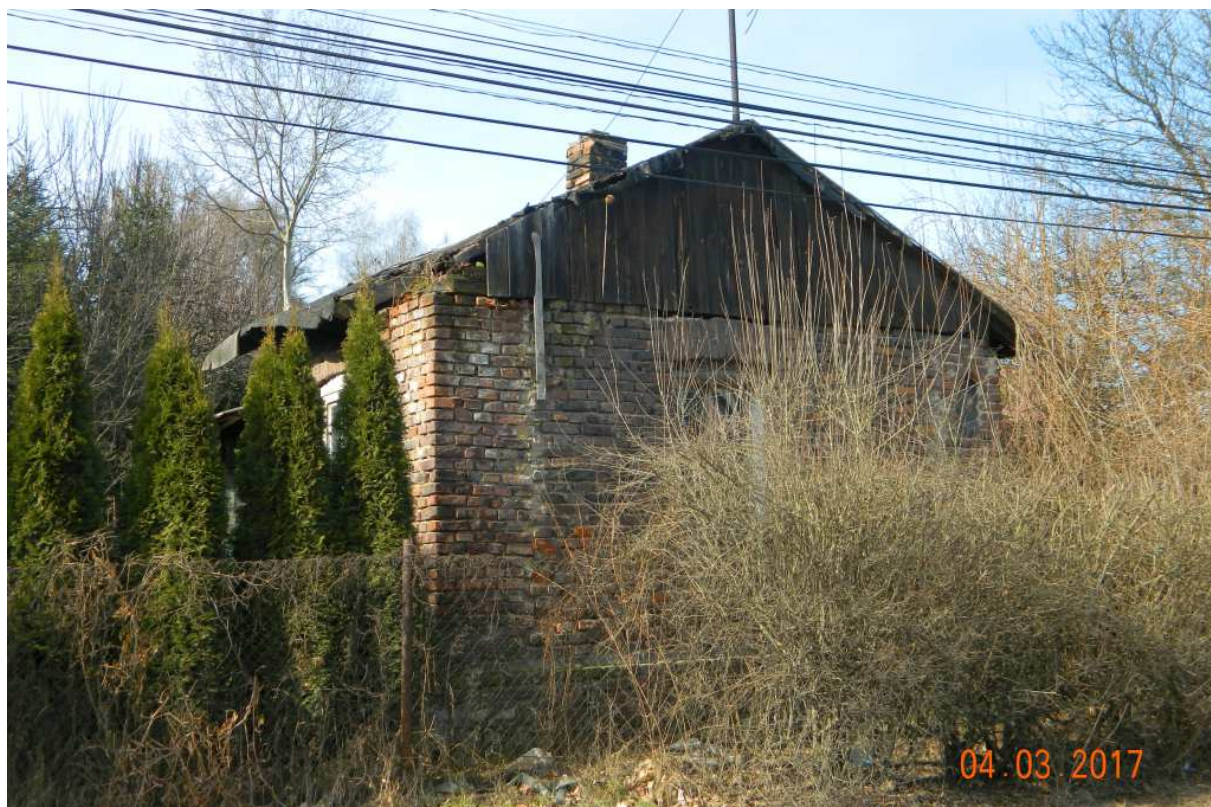
Fot. nr 40 (40-41). Dawna zabudowa ulicy Starowolskiej. Tu pozostałości po dawno opuszczonym budynku spod nr 11.
