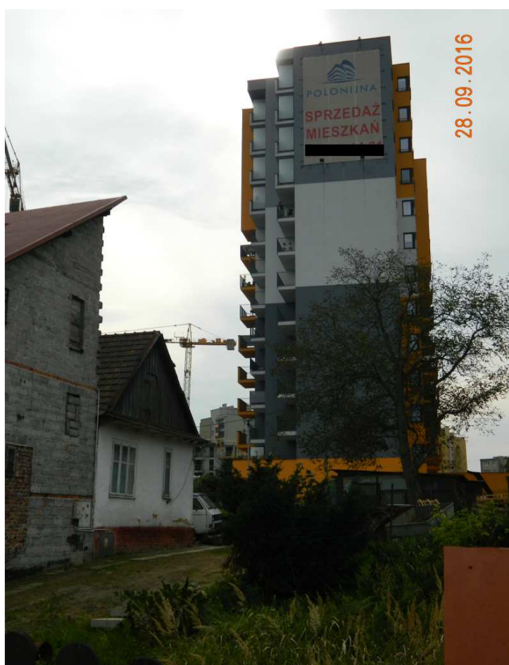
Fot. nr 115 (115-116). Podmiejski domek spod nr 251 ukryty za współczesną zabudową.
