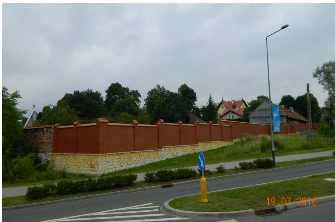
Fot. nr 179. Mur dawnego folwarku kościelnego rozciągający się wzdłuż współczesnej ulicy Do Sanktuarium BM.
