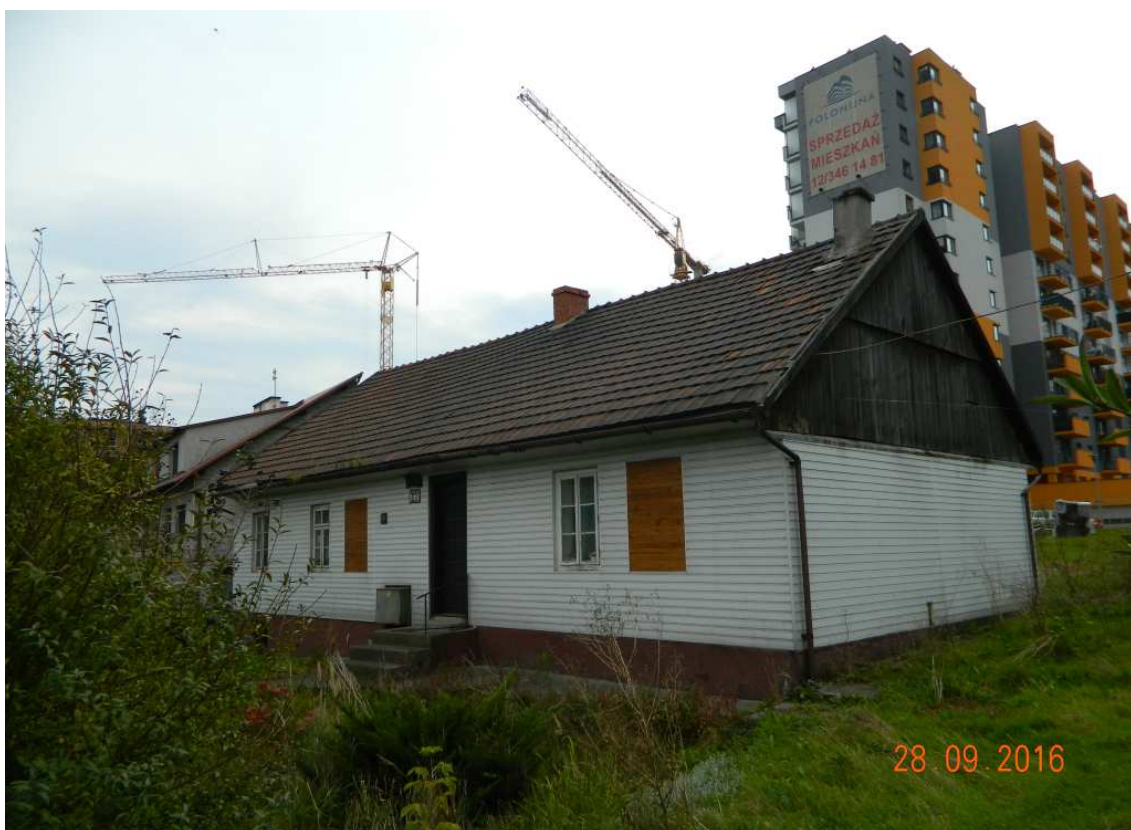
Fot. nr 112(112-114). Ostatnie chyba chwile podmiejskiego domku z ulicy Wielickiej 249.
