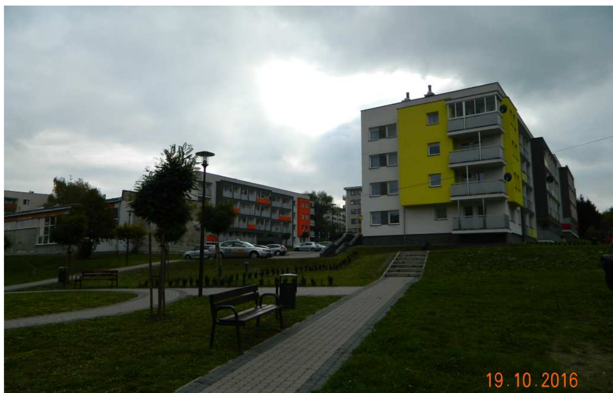
Fot. nr 95 (95-96). Współczesna zabudowa początkowego odcinka ulicy Wolności.
