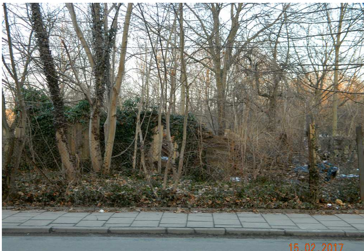
Fot. nr 202. Pokryta bluszczem ruina drewnianego domu na styku ulic: Ułanów i Fiołkowej.
