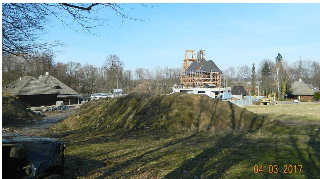
Fot. nr 37. Smutny widok od strony ulicy Cisowej.
