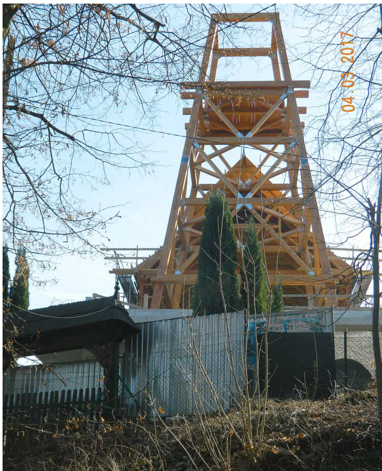
Fot. nr 34. Wieża nowego, murowanego kościoła od strony ulicy Panieńskie Skały.
