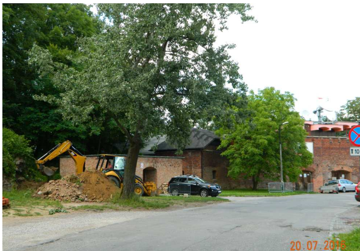
Fot. nr 17. Prace rekonstrukcyjne w sąsiedztwie bastionu nr III.
