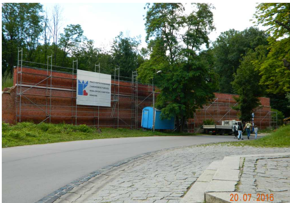
Fot. nr 15 (15-16). Próba rekonstrukcji ściany wewnętrznej bastionu nr II.
