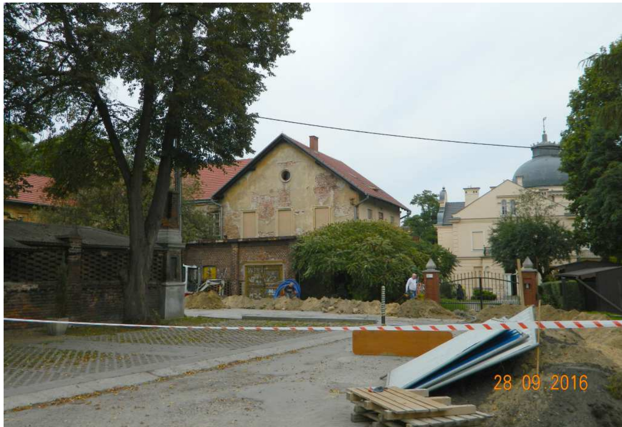
Fot. nr 127. Widok od strony kaplicy księży Augustianów.
