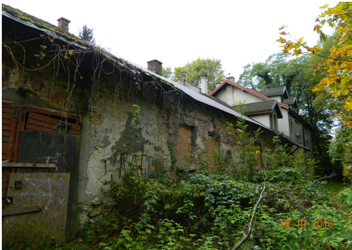
Fot. nr 90 (90-91). Część gospodarcza dawnego dworu Bemów, kiedyś zapewne wozownia, w ujęciach od strony ulicy Albańskiej.
