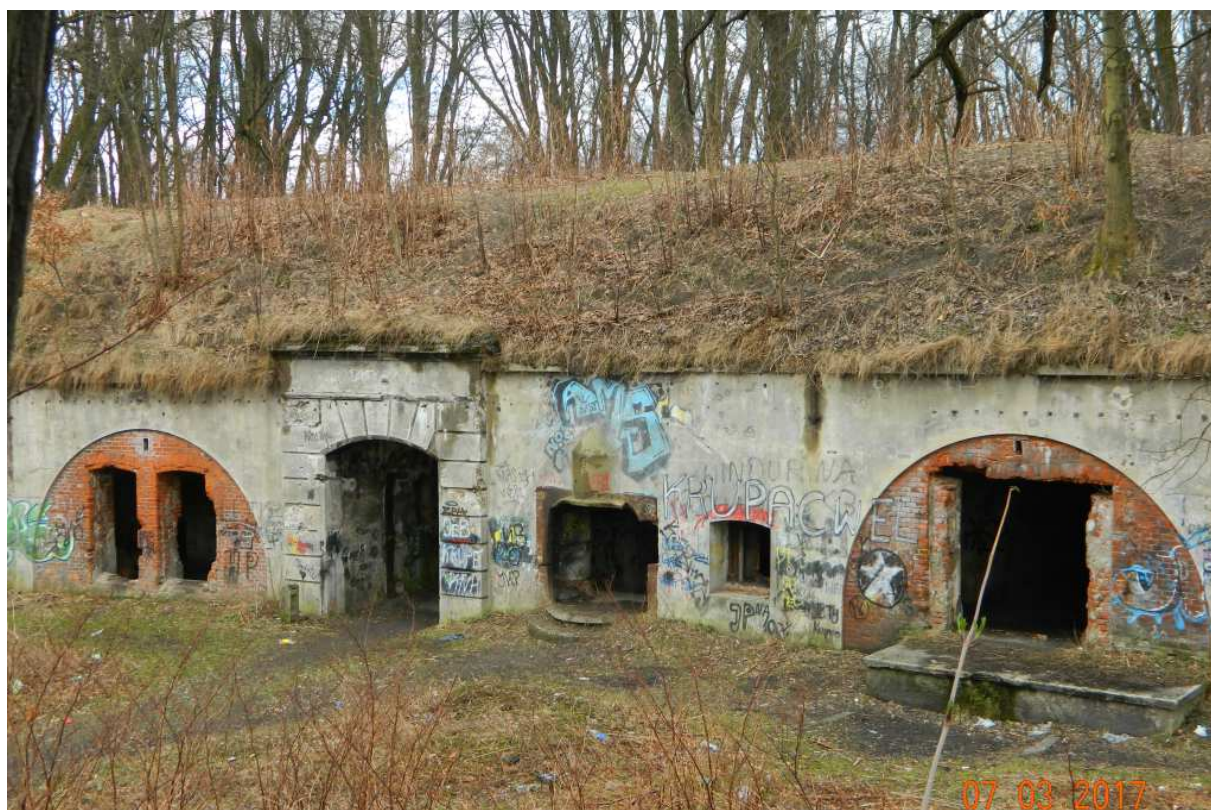
Fot. nr 135. Brama wjazdowa i dawne stanowisko ckm, z którego dawno już wypruto metalową osłonę.
