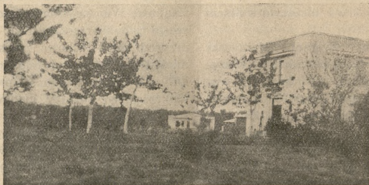
Ogólny widok Obserwatorium Magnetycznego w Świdrze; w głębi drewniany budynek do pomiarów bezwzględnych i murowany dla przyrządów samopiszących.
