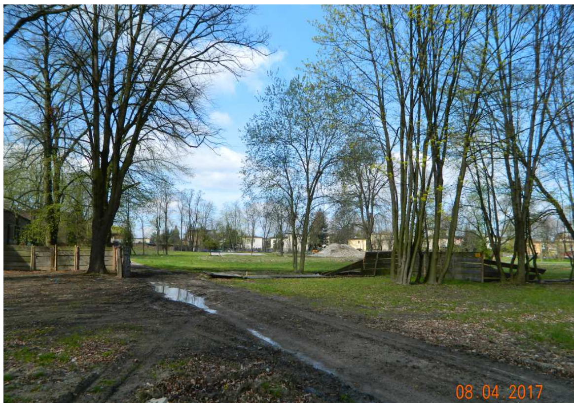
Fot. nr 56. Widok na splantowany już teren po basenach: średnim i głębokim.
