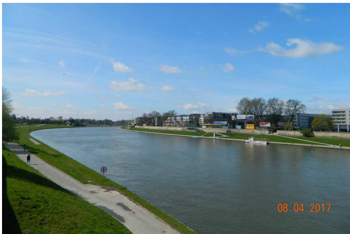
Fot. nr 57. Widok na nową zabudowę nadbrzeże Półwsia w ujęciu z Mostu Dębnickiego.
