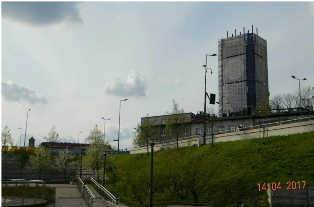
Fot. nr 129 (129-130). „Szkieletor” na etapie demontażu ścian. Tu ujęcie spod ruin fortu mogilskiego.
