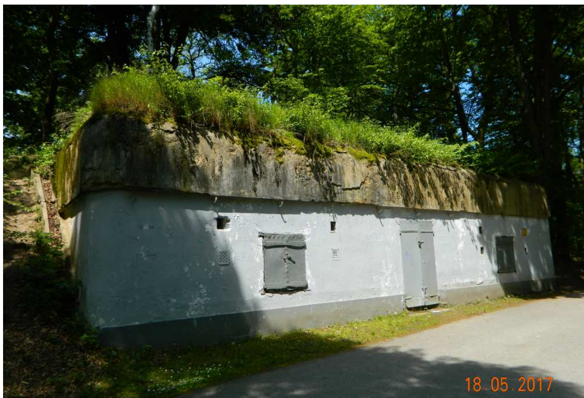
Fot. nr 108. Schron amunicyjny z czasów Twierdzy Kraków na szczycie Ostrej Góry. Kiedyś wchodził w skład baterii nr 36 („Ostra Góra”).
