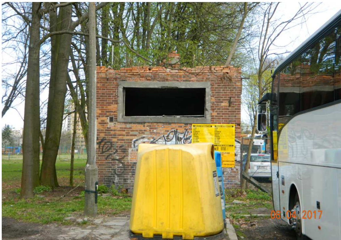
Fot. nr 53. Dawna budka kasowa przy wejściu na stadion lekkoatletyczny, która zapewne niebawem zniknie.
