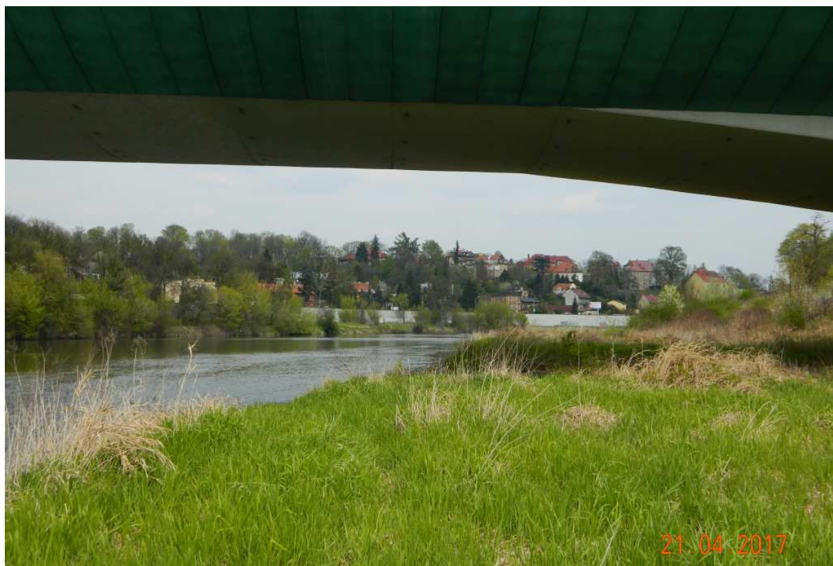
Fot. nr 83 (83-84). Widoki zabudowy początkowego odcinka ulicy Księcia Józefa i osiedla Salwator w ujęciach spod Mostu Zwierzynieckiego
