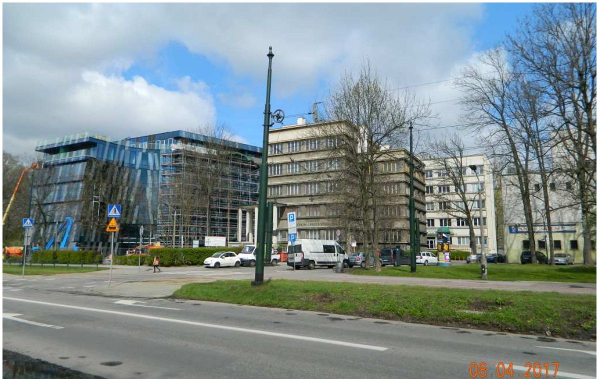
Fot. nr 35 (35-36). Końcowy etap budowy „krzywego domu” w miejscu gmachu Petroinformu, który przetrwał w tym miejscu ledwo pół wieku – tu widok z Błonia.
