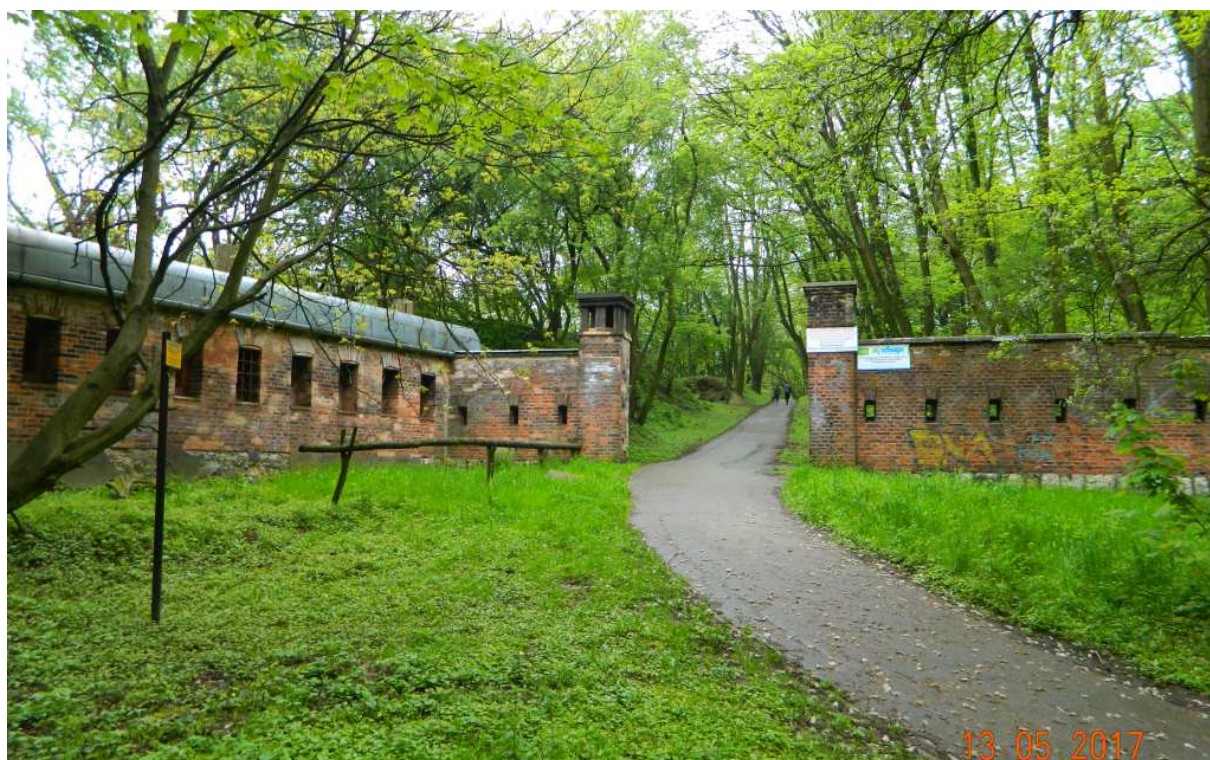
Fot. nr 90. Ostale fragmenty zespołu bramnego 3a fortu Kościuszko u wylotu ul. Hofmana.
