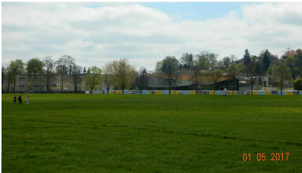
Fot. nr 63. Budowa hali sportowej Comarch-Cracovii w końcowym odcinku alei Focha.
