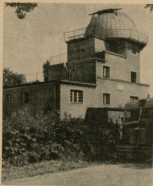
Główny budynek Obserwatorium Astronomicznego we Wrocławiu
