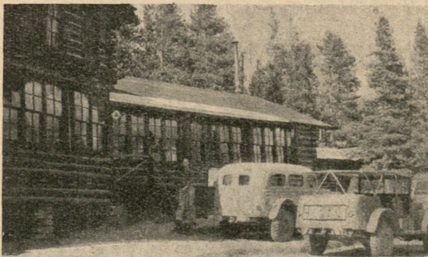
Ryc. 1. Budynek stacji wysokogórskiej — Fot. Cz. Jura
