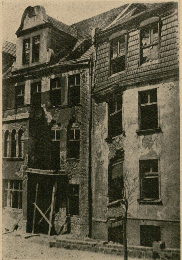
Ryc. 2. Widok gdańskich kamienic przedwojennych, posadowionych w gruncie aluwialnym, przewarstwowym torfem. Fot. A. Piórek
