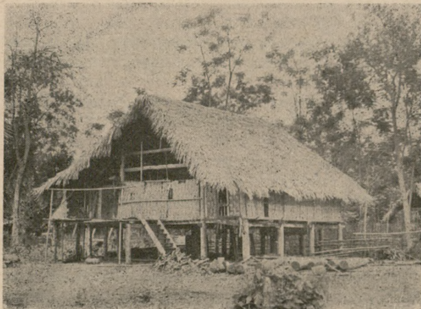
Ryc. 4. Dom na palach w wiosce narodowości Tho. Bardzo podobną konstrukcję ma budynek Stacji Biologicznej w Cuc Phuong. — Fot. L. Sawicki
