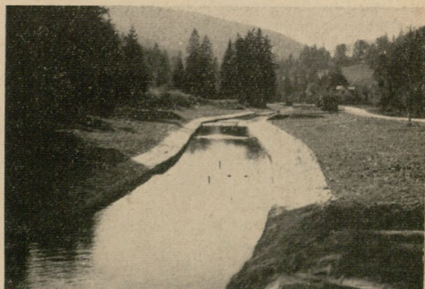
Ryc. 4. Potok Kocierz regulacja techniczna i biologiczna widziana w dół potoku. — Fot. J. Pieniążek
