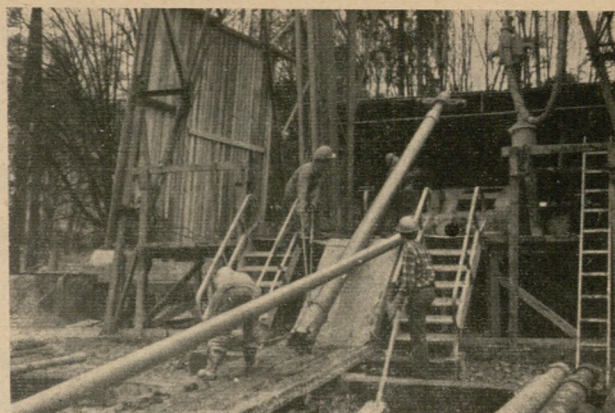
Ryc. 4. Wyciąganie koronki z rurą rdzeniową z głębokiego otworu badawczego w Szczawnicy. — Fot. K. Birkenmajer
