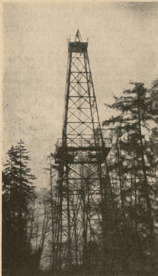
Ryc. 2. Wieża wiertnicza głębokiego otworu badawczego w Szczawnicy. — Fot. K. Birkenmajer
