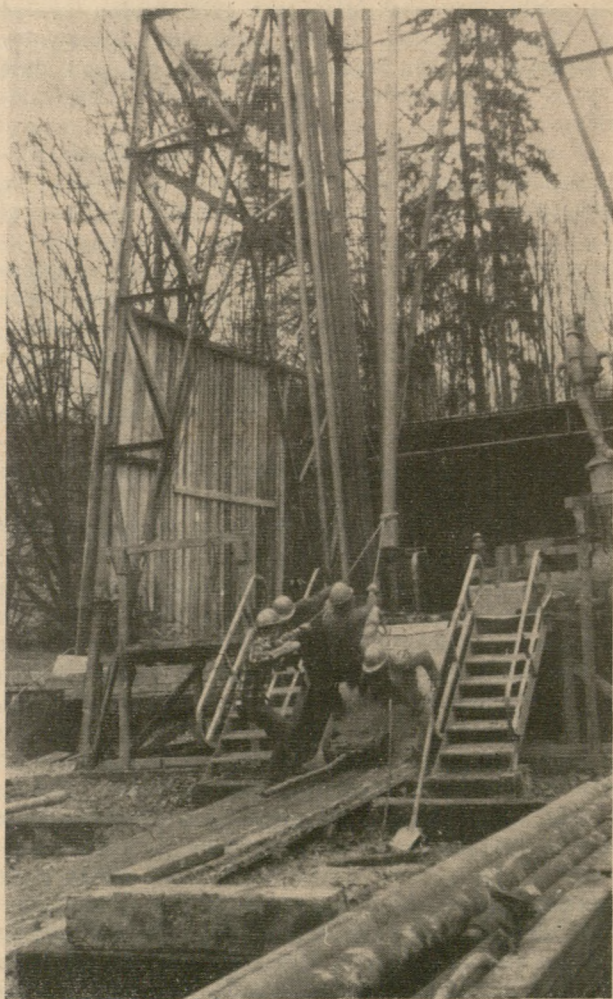
Ryc. 3. Wyciąganie żerdzi wiertniczych z głębokiego otworu badawczego w Szczawnicy. — Fot. K. Birkenmajer
