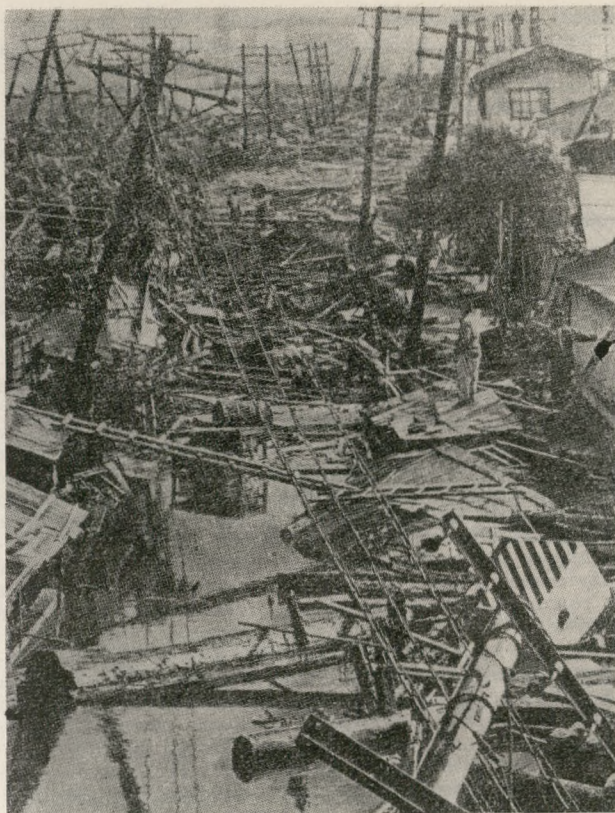
Ryc. 2. Zniszczenia w jednym z portów japońskich w czasie trzęsienia ziemi w 1964 r.
