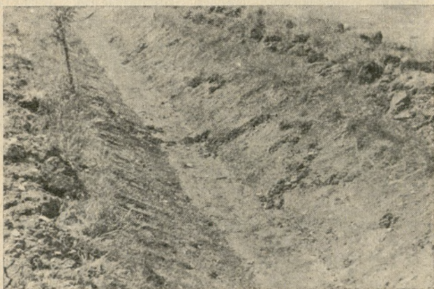
Ryc. 4. Zbocza świeżo wykopanego rowu przydrożnego niszczone przez gryzonie
