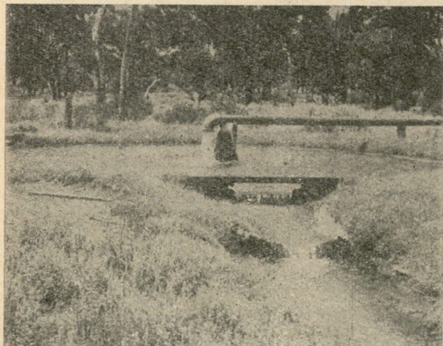
Ryc. 7. Studnia artezyjska i zbiornik na wodę łączą się siecią odkrytych rowów rozprowadzających wodę na pastwiska. Zachodni Queensland
