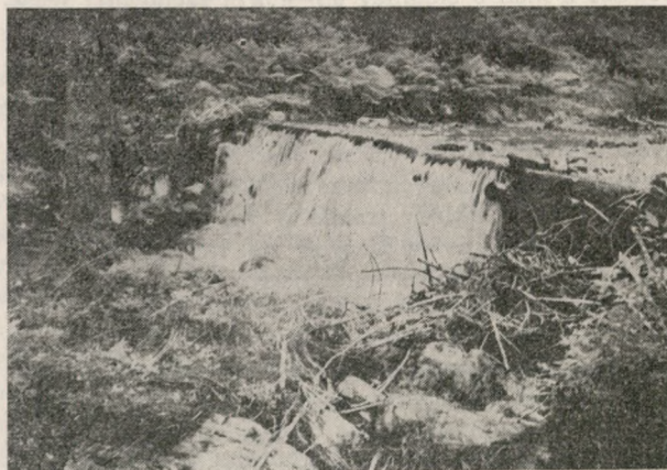
Ryc. 2. Zapora przeciwszutrowa w dnie Potoku Jarząbczego, 35 \text{ m} powyżej tamy. Fot. J. Dudziak
