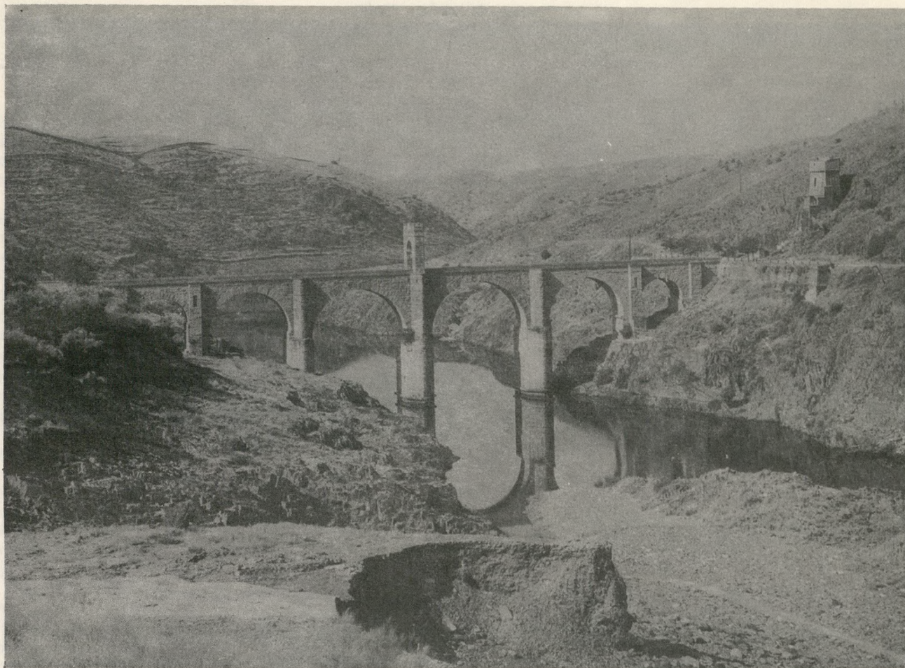
Ryc. 6. Rzymski most z czasów cesarza Trajana (96–106 r. po Chr.) w miejscowości Alcántara (Hiszpania). Długość mostu 146 m, rozpiętość przęseł środkowych 36 m.
