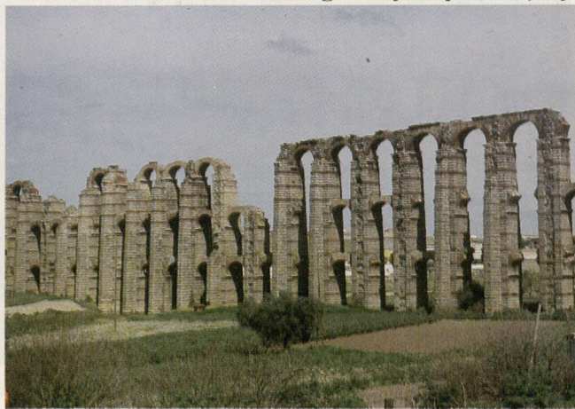
Ryc. 5. Resztki wielkiego akweduktu.
