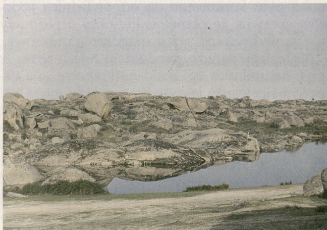
Ryc. 19. Jeden ze zbiorników dawnej oczyszczalni węgny.
