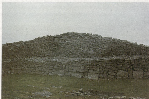
Ryc. 4. Wewnętrzny mur fortu Dún Aongusa zbudowany z dopasowanych bloków wapienia, które ułożono na wysokość 5,4 m. Fot. M.W. Lorenc
