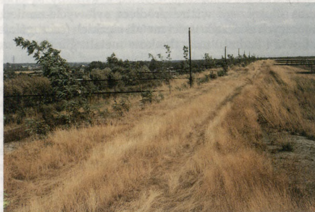
Ryc. 5. Korona zwałowiska w Orzeszu (elektrownia Łaziska) – powierzchnię luźnego popiołu utrwalono uprawą żywicy trwałej i wielokwiatowej
