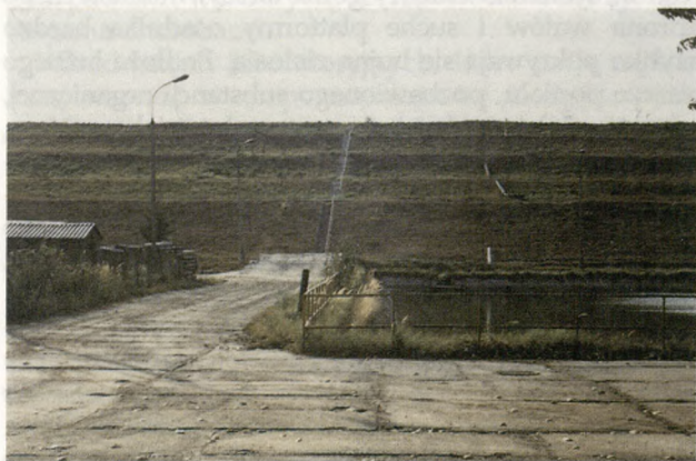
Ryc. 2. Tarasowa struktura składowiska popiołów elektrowni Łaziska
