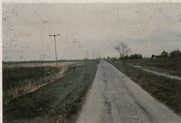
Ryc. 4. Pochylone słupy telefoniczne koło Peterborough jako efekt nierównomiernego osiadania gruntu
