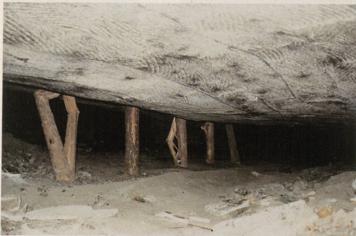
CIŚNIENIE STROPU. Dawne wyrobisko w kopalni soli w Wieliczce
