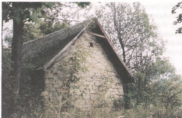
Ryc. 5. Bartne. Przykład zastosowania kamienia w budownictwie. Stary spichlerz plebański przy cerkwi grekokatolickiej
