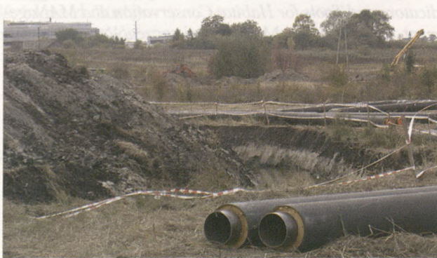
Ryc. 4. Głównym zagrożeniem łąk w Krakowie jest budownictwo. Fot. M. Woyciechowski
