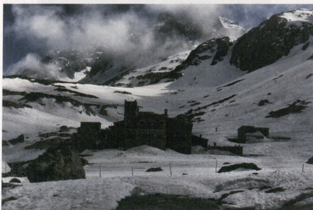
Ryc. 7. Widok na schronisko Refuge Neltner. Fot. J. Hiksiz
