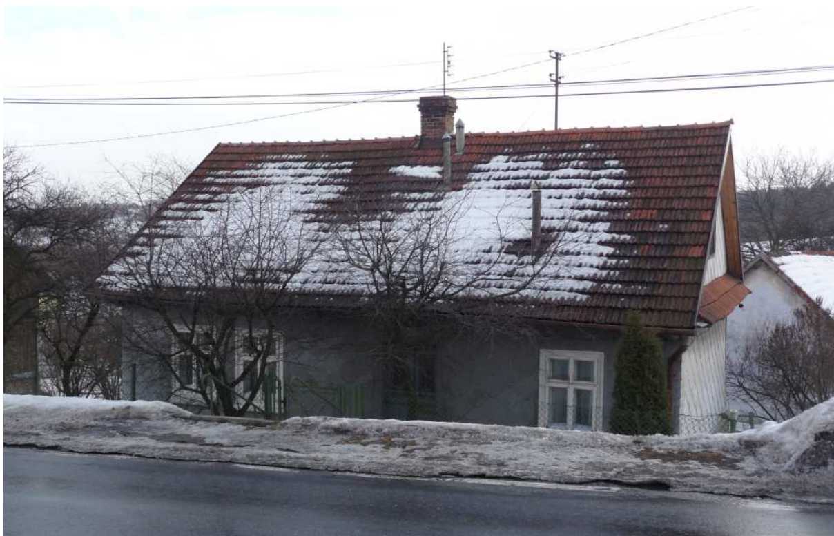
Fot. nr 75. Fasada z oryginalnymi oknami. (20.02.2012)
