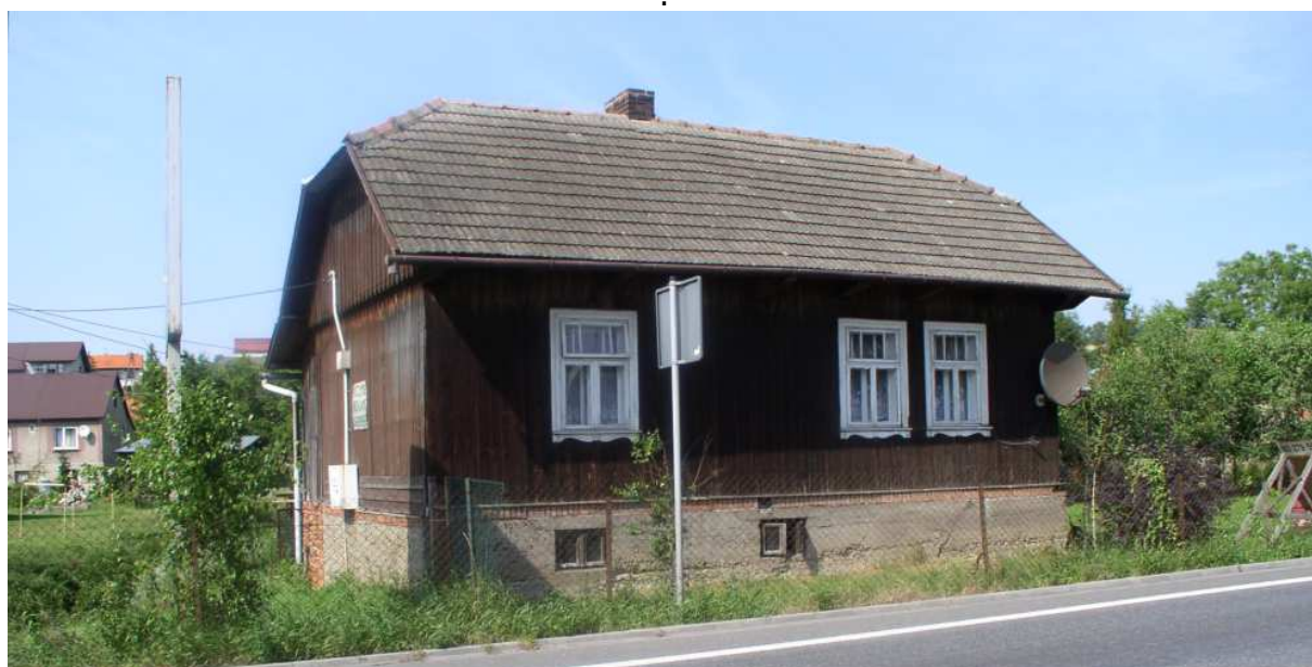
Fot. nr 89 (89-90). Drewniany dom pod nr 175, wybudowany zapewne w latach 20. zeszłego wieku, który na tej fotografii posiada jeszcze charakterystyczne dla tego okresu okna. (18.07.2009)
