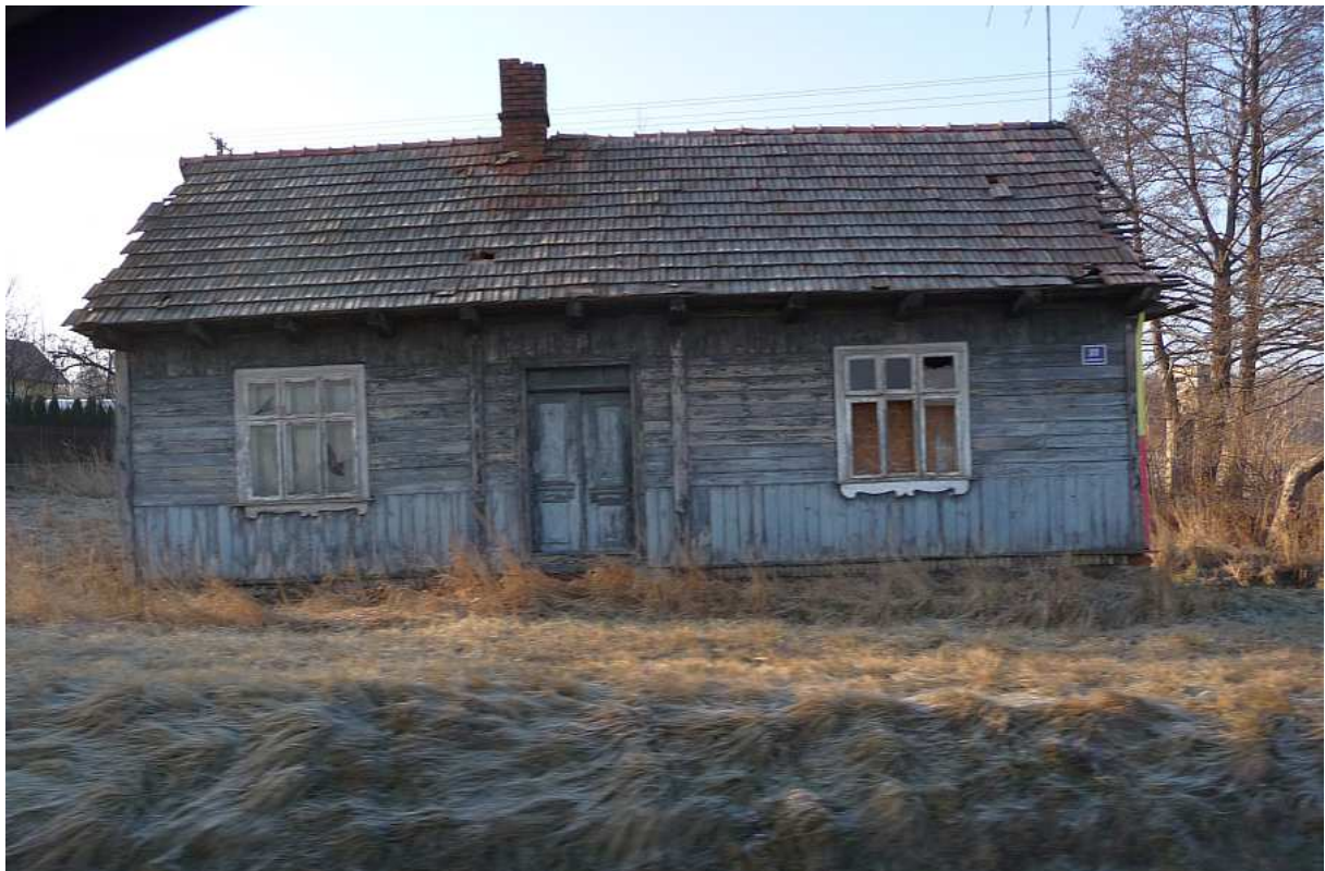
Fot. nr 159. Ruina oryginalnego domu drewnianego spod nr 31, który mógł powstać na przełomie I i II ćwierci XX wieku. (07.03.2012)
