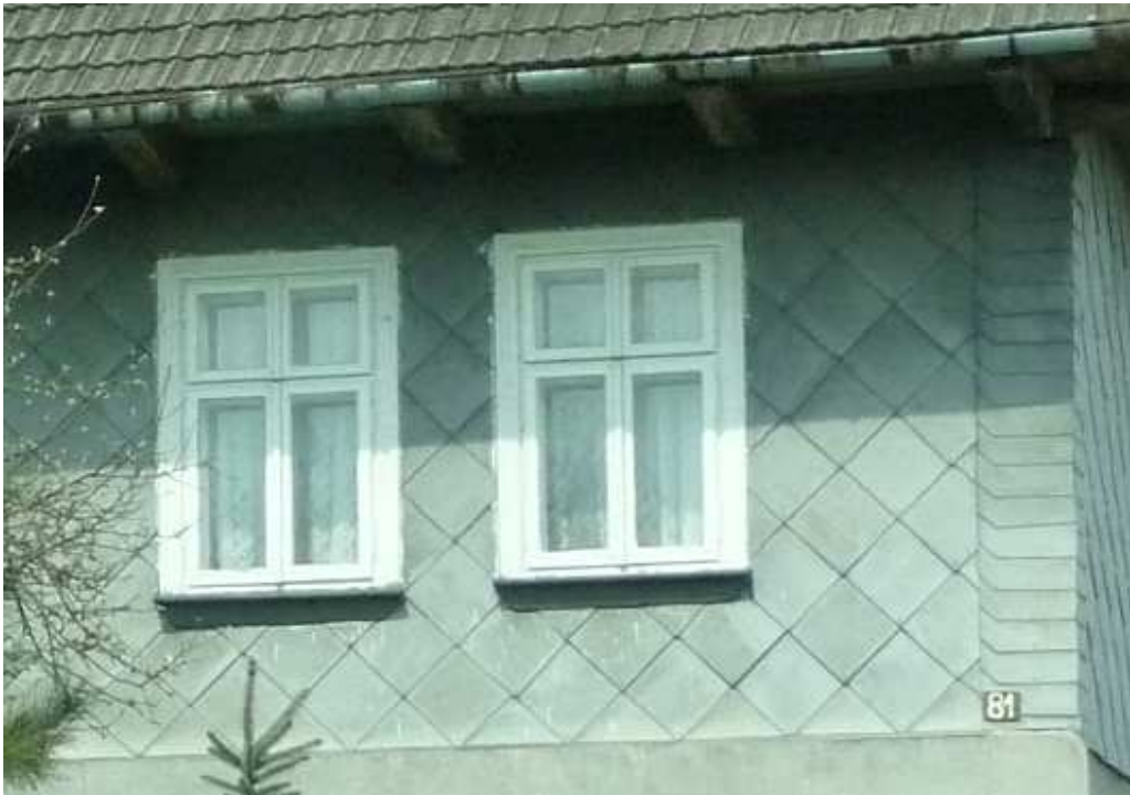
Fot. nr 110. Oryginalne detale fasady. (19.04.2012)
