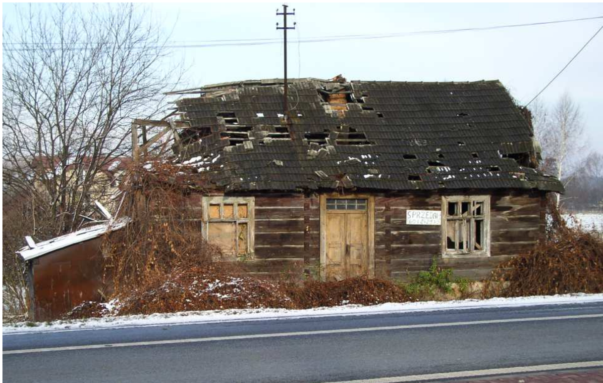
Fot. nr 151 (151-155). Kilka ujęć fasady ruiny oryginalnego domu spod nr 140, który można datować na przełom I i II ćwierci zeszłego wieku – ujęcia z drogi krajowej nr 75. (28.11.2010)
