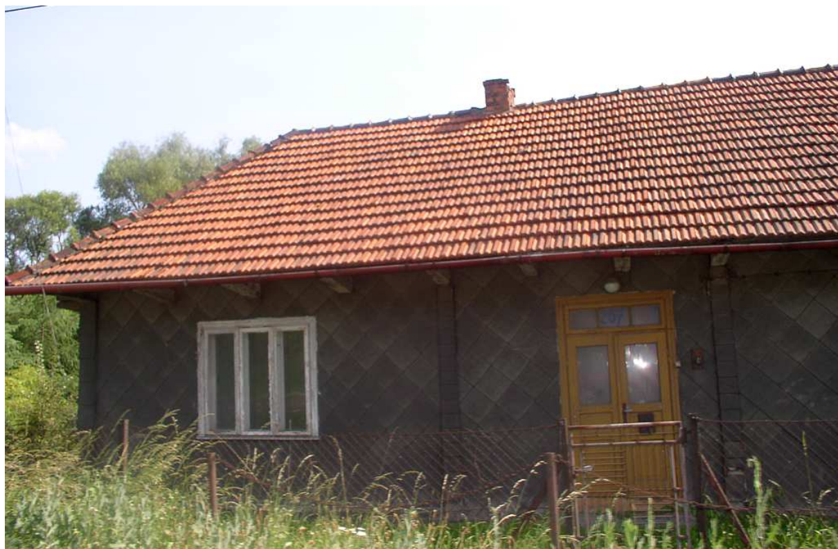
Fot. nr 103 (103-105). Zapewne przedwojenny jeszcze dom spod nr 207 i jego łuskowa boazeria. (18.07.2009)
