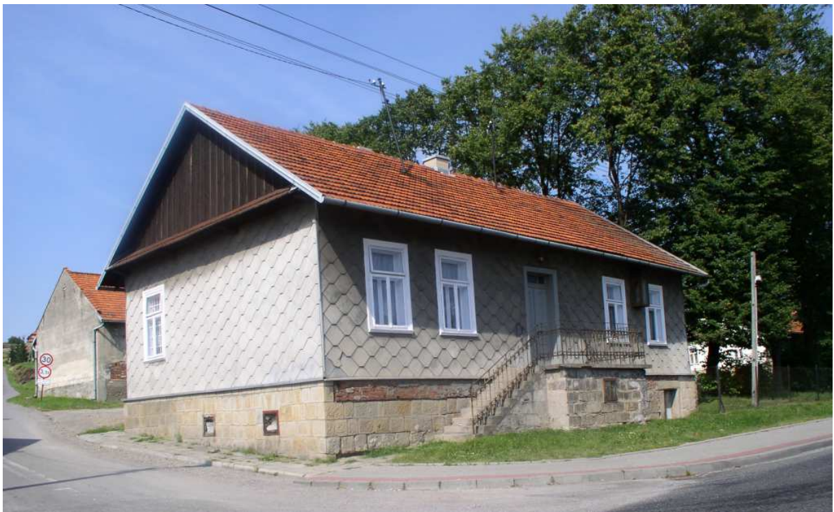
Fot. nr 95. Dom pod nr 75, czyli ciekawy przykład oryginalnej zabudowy zapewne z lat 20/30 XX wieku. Fasada z boazerią łuskową i oryginalnymi oknami. (18.07.2009)
