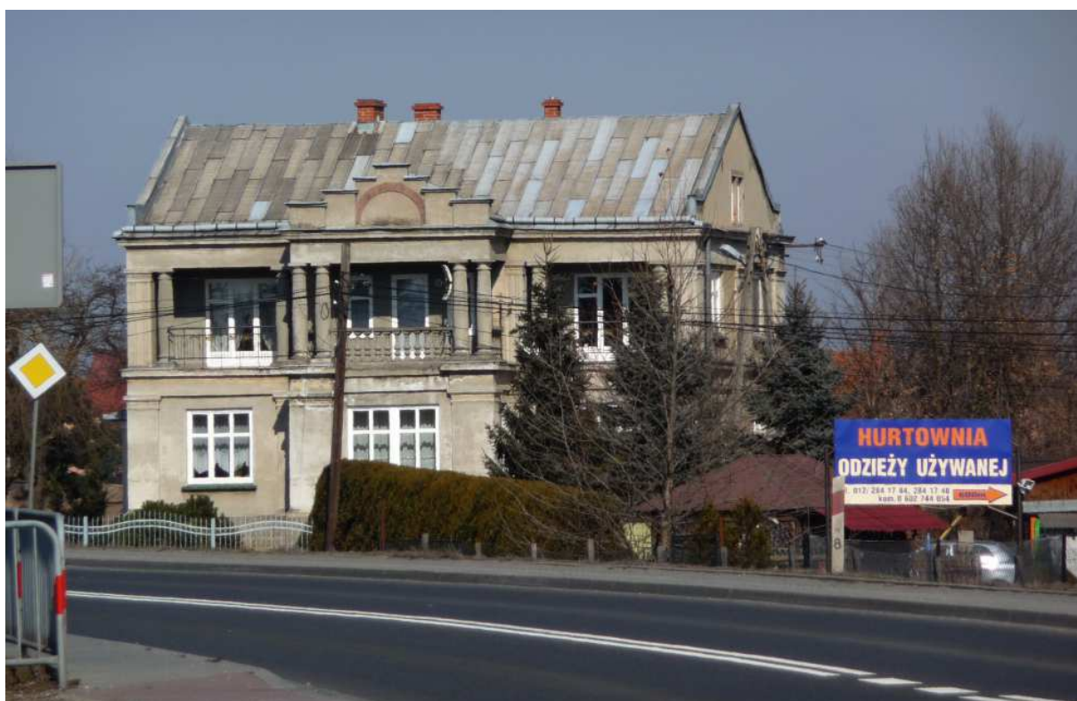
Fot. nr 125. Detale jej fasady. (07.03.2012)
