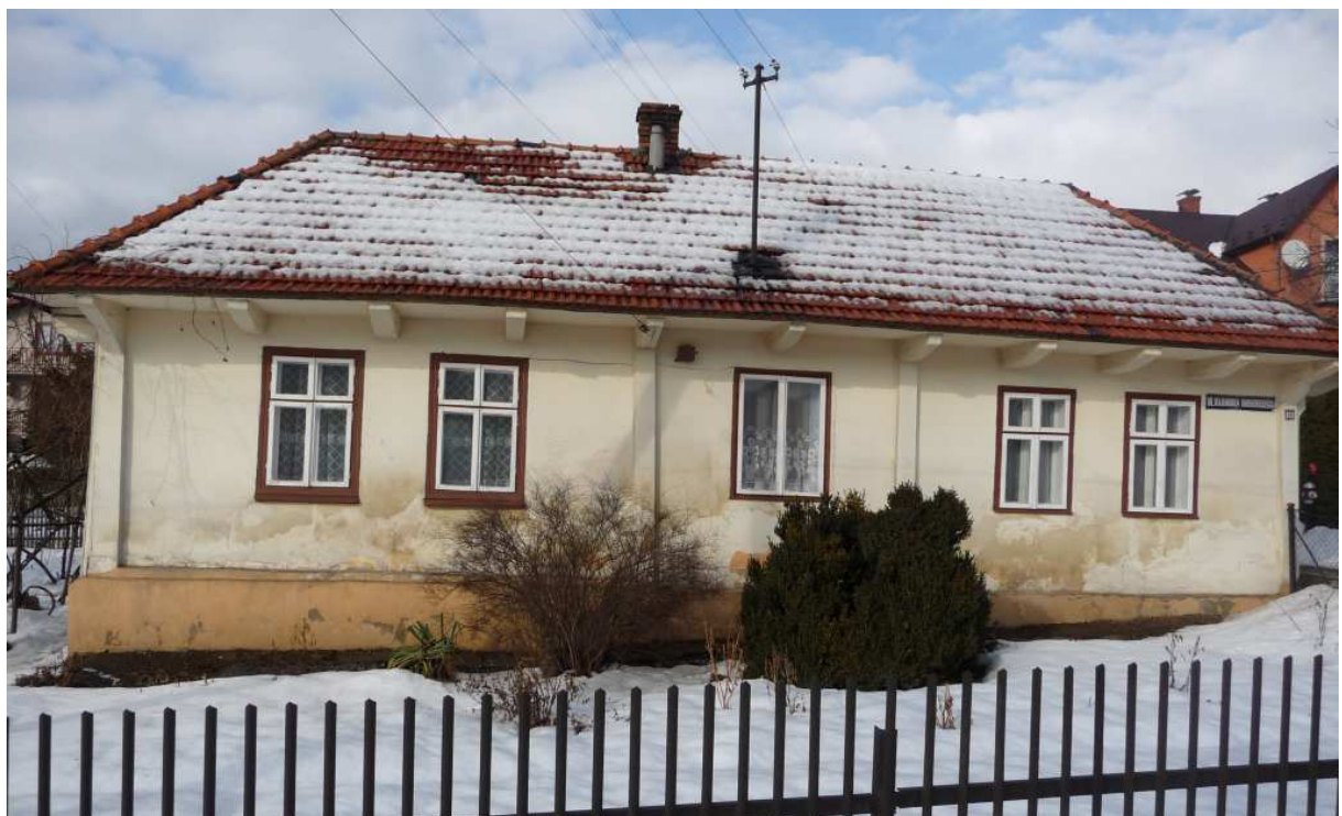
Fot. nr 83. Fasada z oryginalnymi oknami w bocznych skrzydłach domu. W miejscu zlikwidowanego ganku późniejsze stylowo okno. (20.02.2012)
