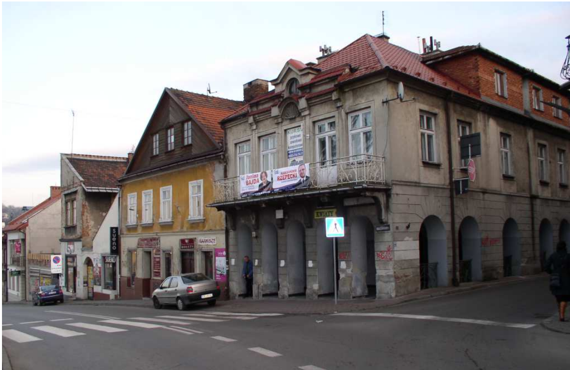
Fot. nr 34. Początkowy fragment galicyjskiej duchem zabudowy ulicy Kraszewskiego o nieparzystych numerach. Widok z wylotu ulicy Szewskiej. (20.11.2010)
