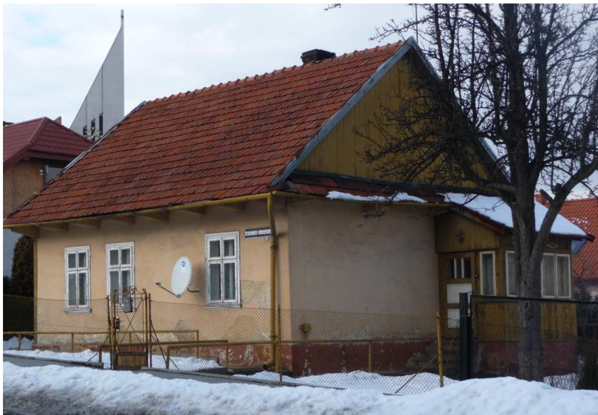
Fot. nr 54. Fasada z oryginalnymi oknami o cienkich szprosach. (20.02.2012)
