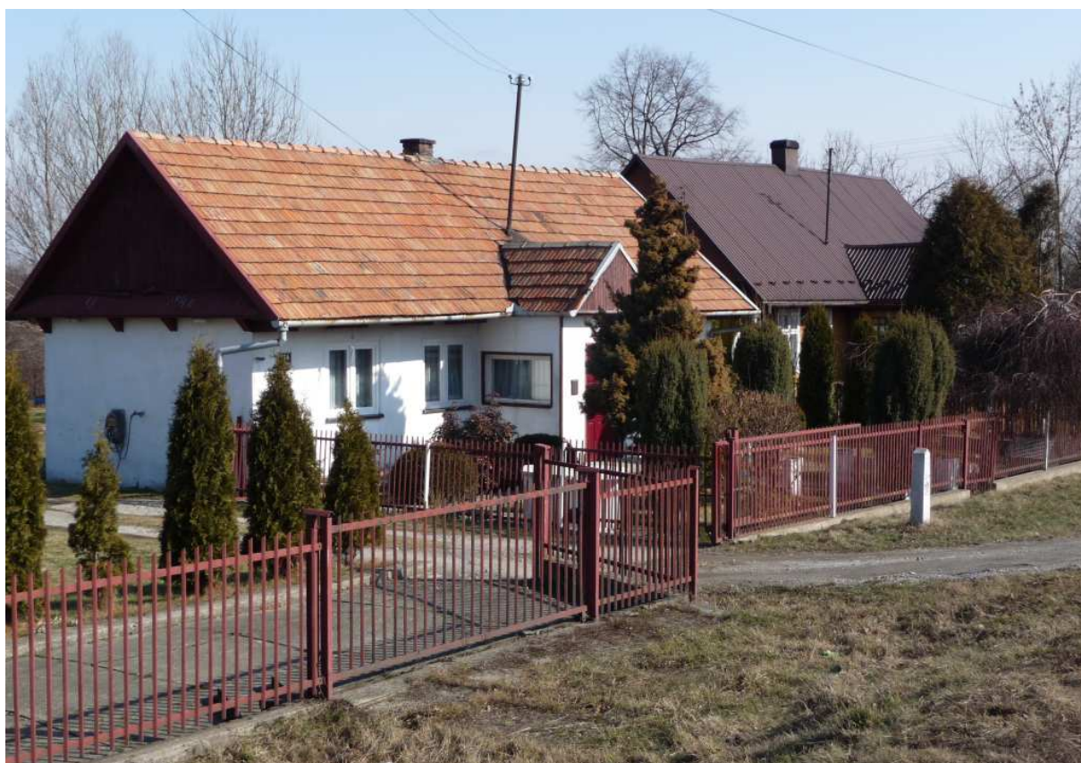
Fot. nr 135. Okryty już sidingiem drewniany dom spod nr 174. (07.03.2012)
