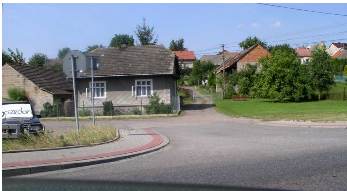
Fot. nr 93 (93-94). Może powojenny już dom pod nr 146, który jest pokryty łuskową boazerią i posiada oryginalne dwukwaterowe okna. (18.07.2009)
