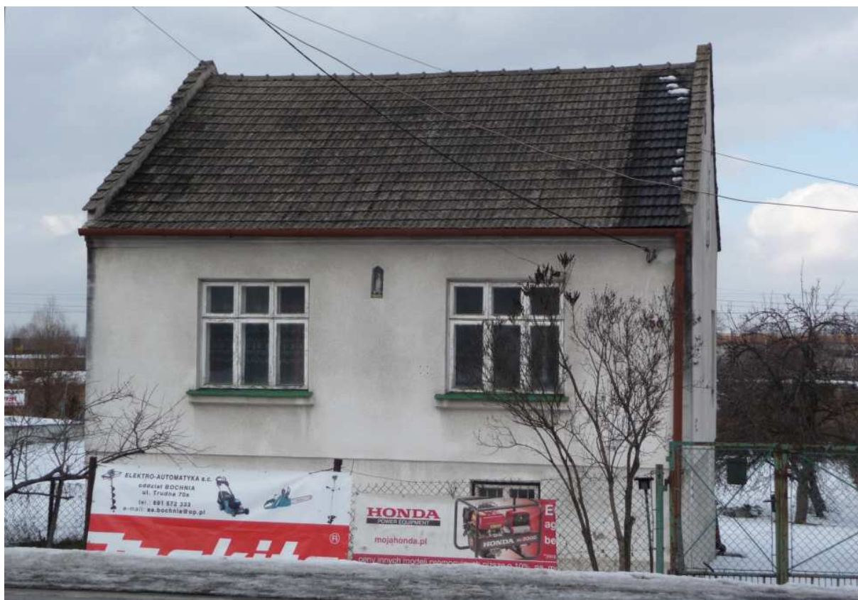
Fot. nr 9. Murowany dom z ulicy Brzeskiej 50, który mógł powstać w okresie po II wojnie światowej. (20.02.2012)
