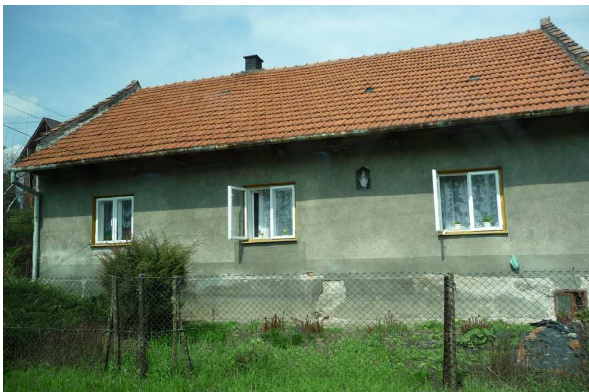
Fot. nr 101 (101-102). Typowo powojenny dom murowany spod nr 280, który na fasadzie posiada skromną kapliczkę. (19.04.2012)
