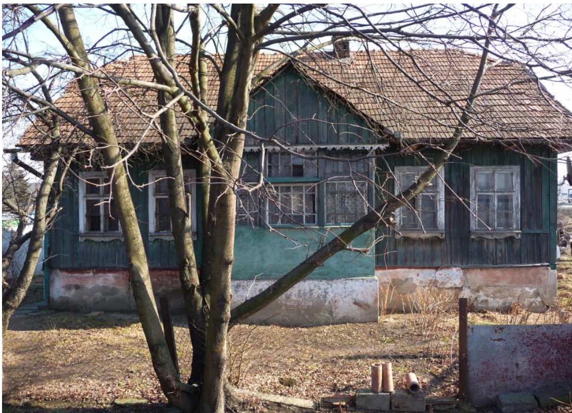
Fot. nr 118 (118-120). Fasada opuszczonego oryginału, który mógł powstać na przełomie I i II dekady XX wieku (07.03.2012)
