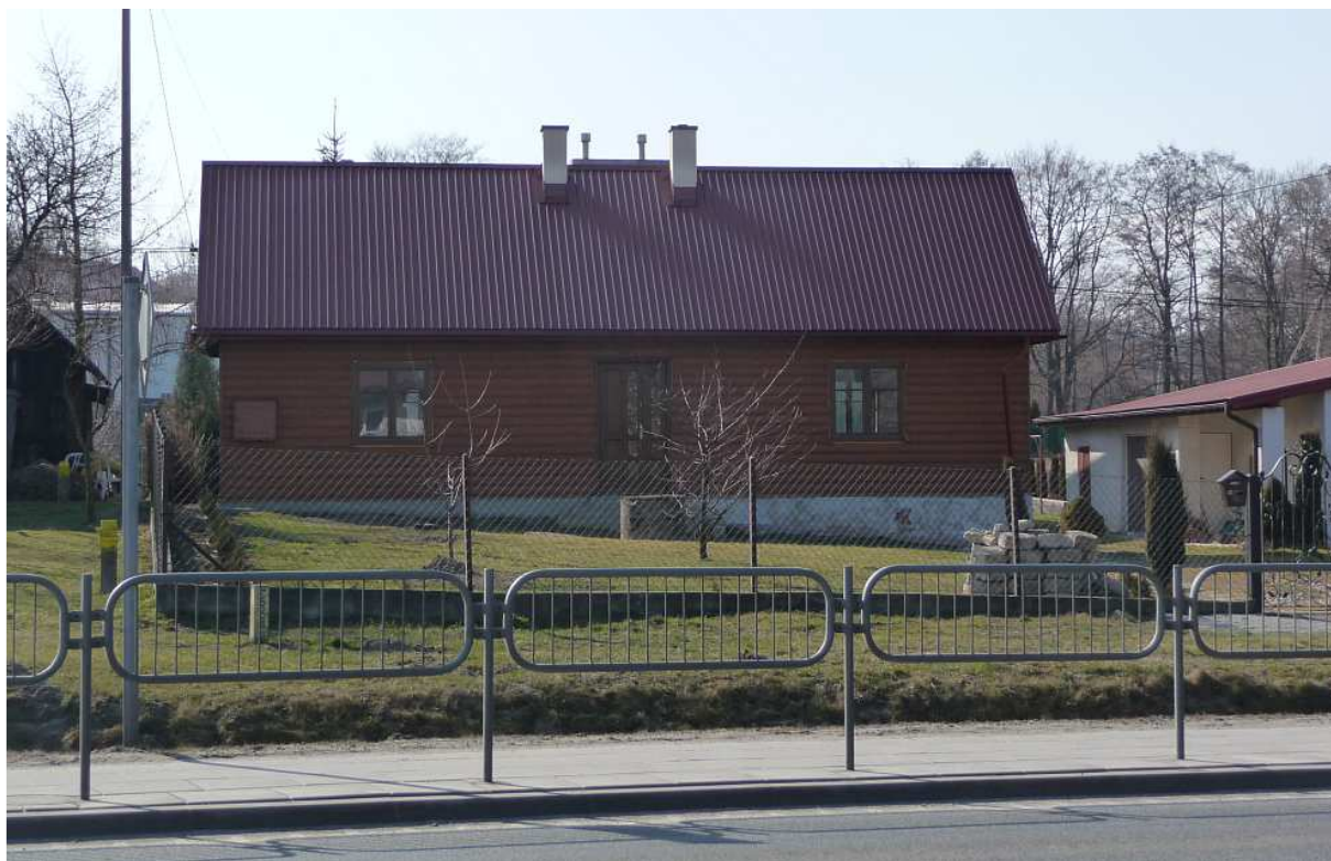
Fot. nr 157. Stan po niedawnej przebudowie. (03.07.2012)
