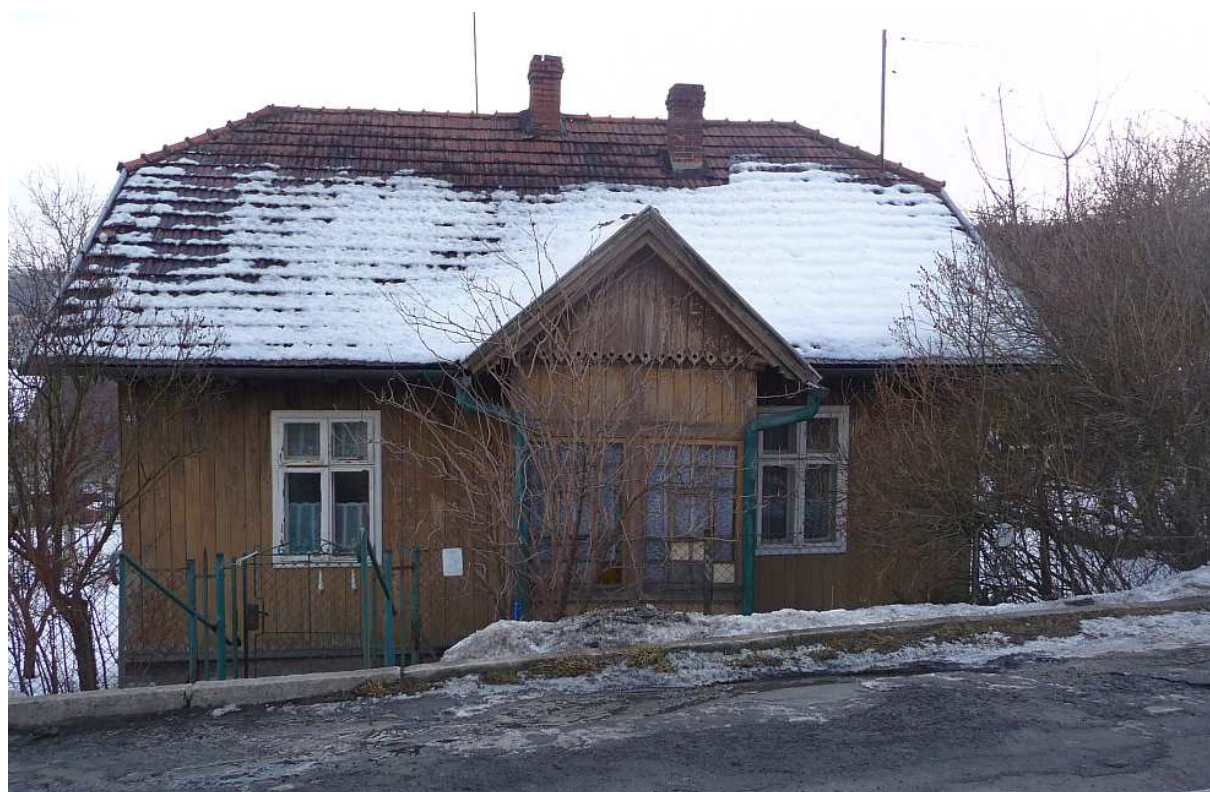
Fot. nr 79 (79-80). Detale fasady: drewniane, dwukwaterowe okna i rzeźbiony w drewnie ganek. (20.02.2012)
