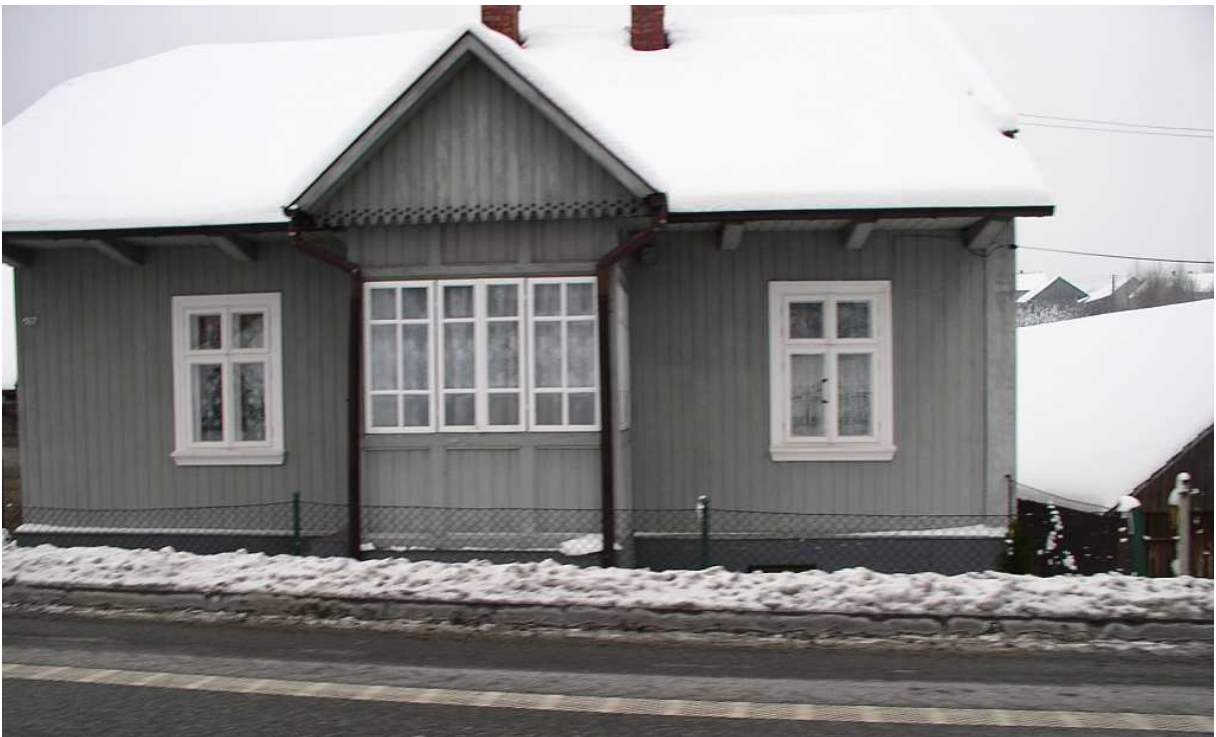
Fot. nr 97 (97-98). Dom z gankiem spod nr 167, zapewne pochodzący II ćwierci XX wieku, może już powojenny. (01.12.2010)
