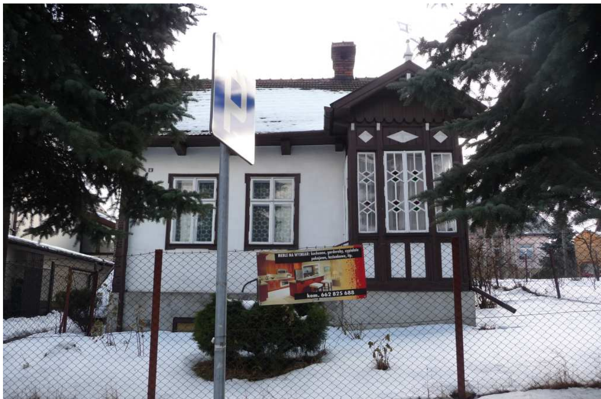
Fot. nr 56 (56-59). Dom z efektownym gankiem z ulicy Brodzińskiego 8, który mógł powstać w I dekadzie XX wieku. (20.02.2012)
