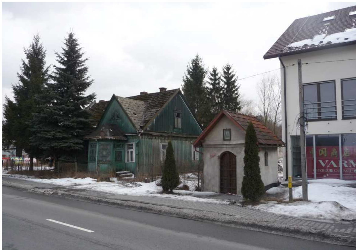
Fot. nr 2 (2-6). Fragment zabudowy ulicy Brzeskiej: dom pod nr 71 i kapliczka typu domkowego. Można przypuszczać, że dom powstał w I ćwierci XX wieku. (20.02.2012)
