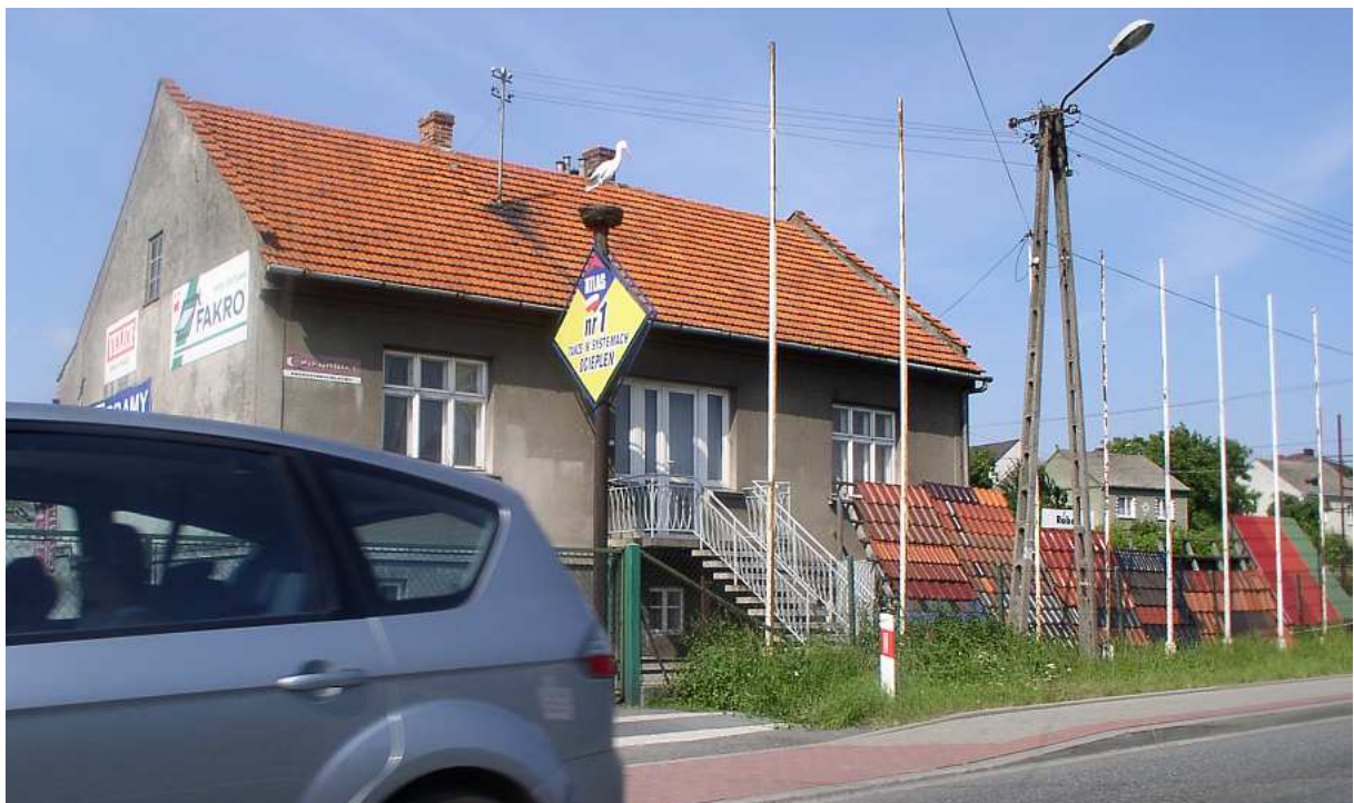
Fot. nr 111. Powojenny dom murowany spod nr 82, które zapewne został wybudowany w okolicy roku 1960; w obu skrzydłach zachowały się oryginalne okna o cienkich szprosach. (18.07.2009)
