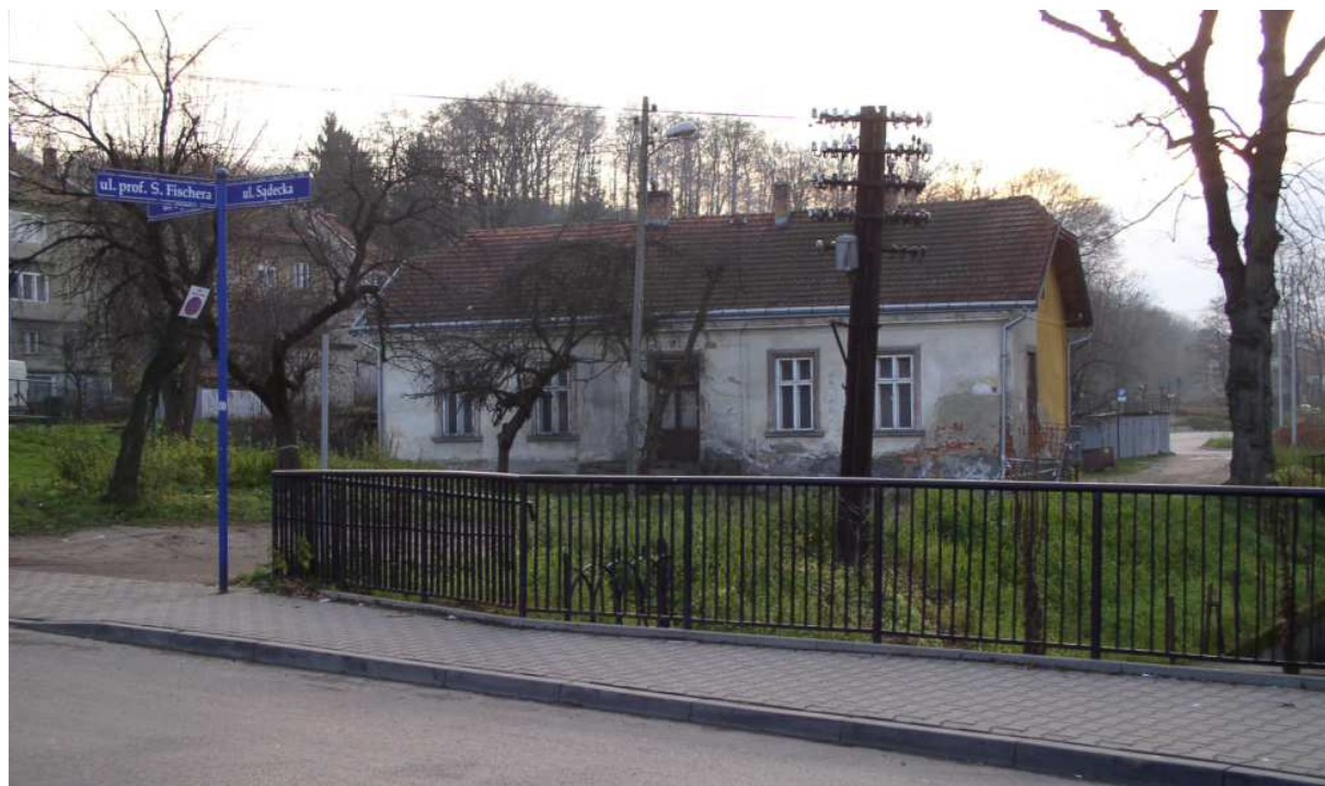
Fot. nr 24 (24-25). Wielorodzinny dom z ulicy Sądeckiej 7, który powstać w I ćwierci XX wieku. (20.11.2010)
