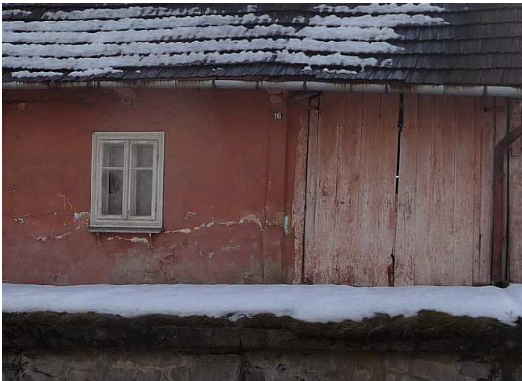
Fot. nr 66. Część gospodarcza w zespole z częścią mieszkalną. (20.02.2012)
