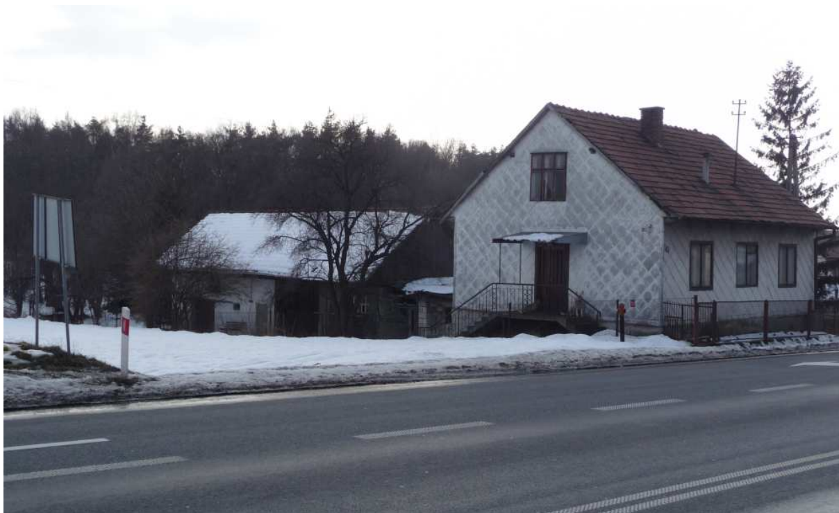
Fot. nr 81. Zagroda z ulicy Brodzińskiego 92. Dom o nieoryginalnych oknach, pokryty łuskową boazerią, powstał zapewne przed II wojną światową. (20.02.2012)
