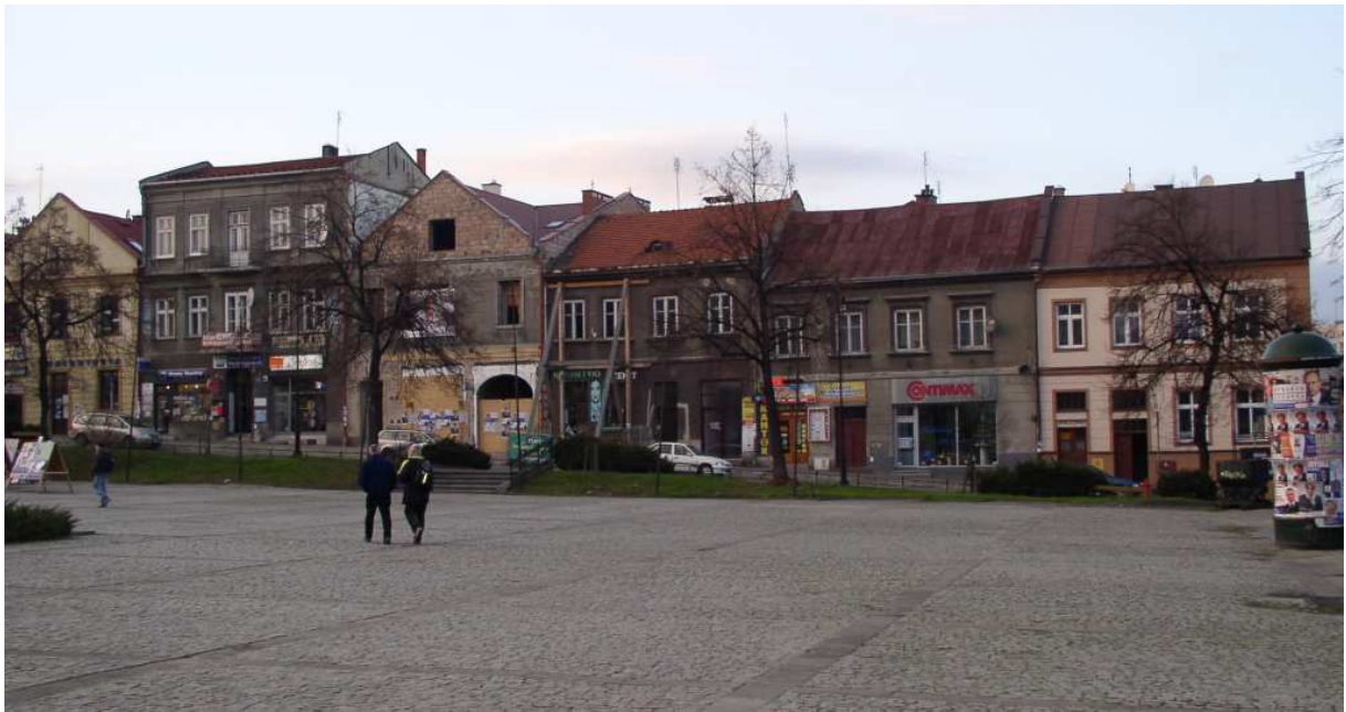
Fot. nr 31 (31-32). Fragment zabudowy północnej pierzei Rynku w pobliżu wlotu ulicy Szewskiej o numerach: 10 do 15, której obecna zabudowa powstała od końca XVIII wieku po początek wieku XX. (20.11.2010)
