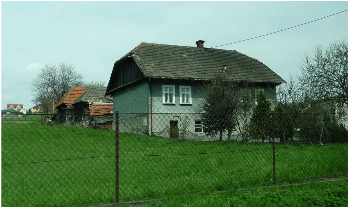
Fot. nr 108 (108-110). Zapewne międzywojenny jeszcze dom spod nr 81. I w nim zachowały się oryginalne okna i boazeria łuskowa. (19.04.2012)
