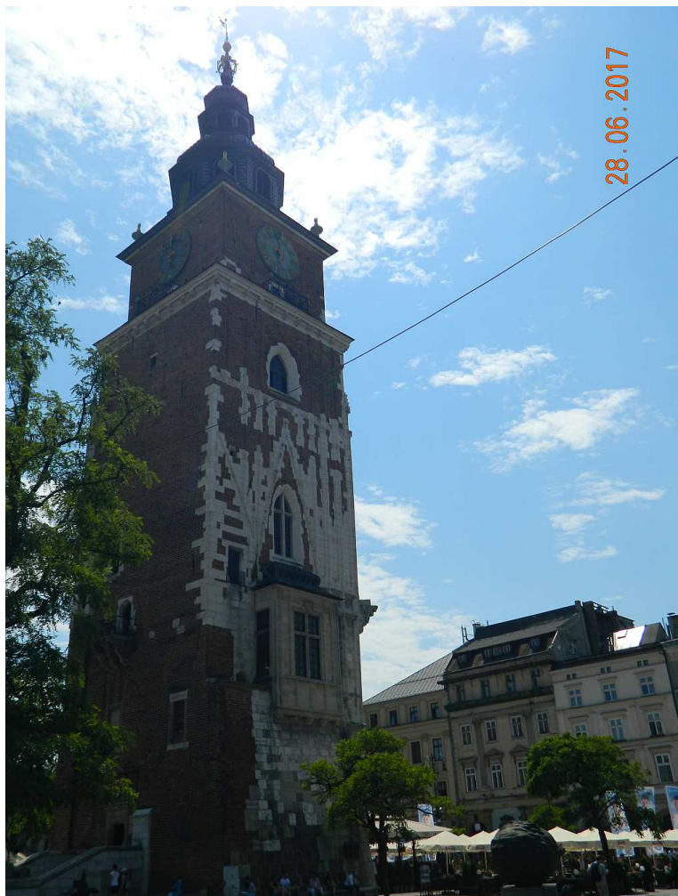
Fot. nr 42. Wieża ratuszowa w ujęciu od strony ulicy Szewskiej.
