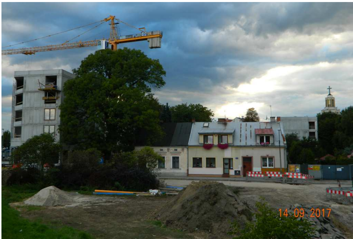
Fot. nr 207. Na pierwszym planie rozpoczynają się właśnie prace budowlane przy kolejnym betonowym blokowisku na styku z Rondem Grunwaldzkim.
