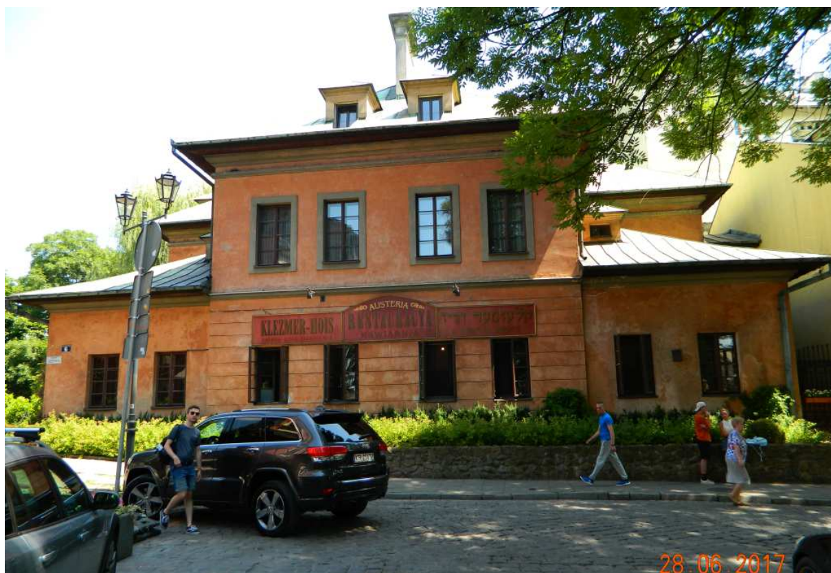
Fot. nr 199. Widok z ulicy Dajwór.
