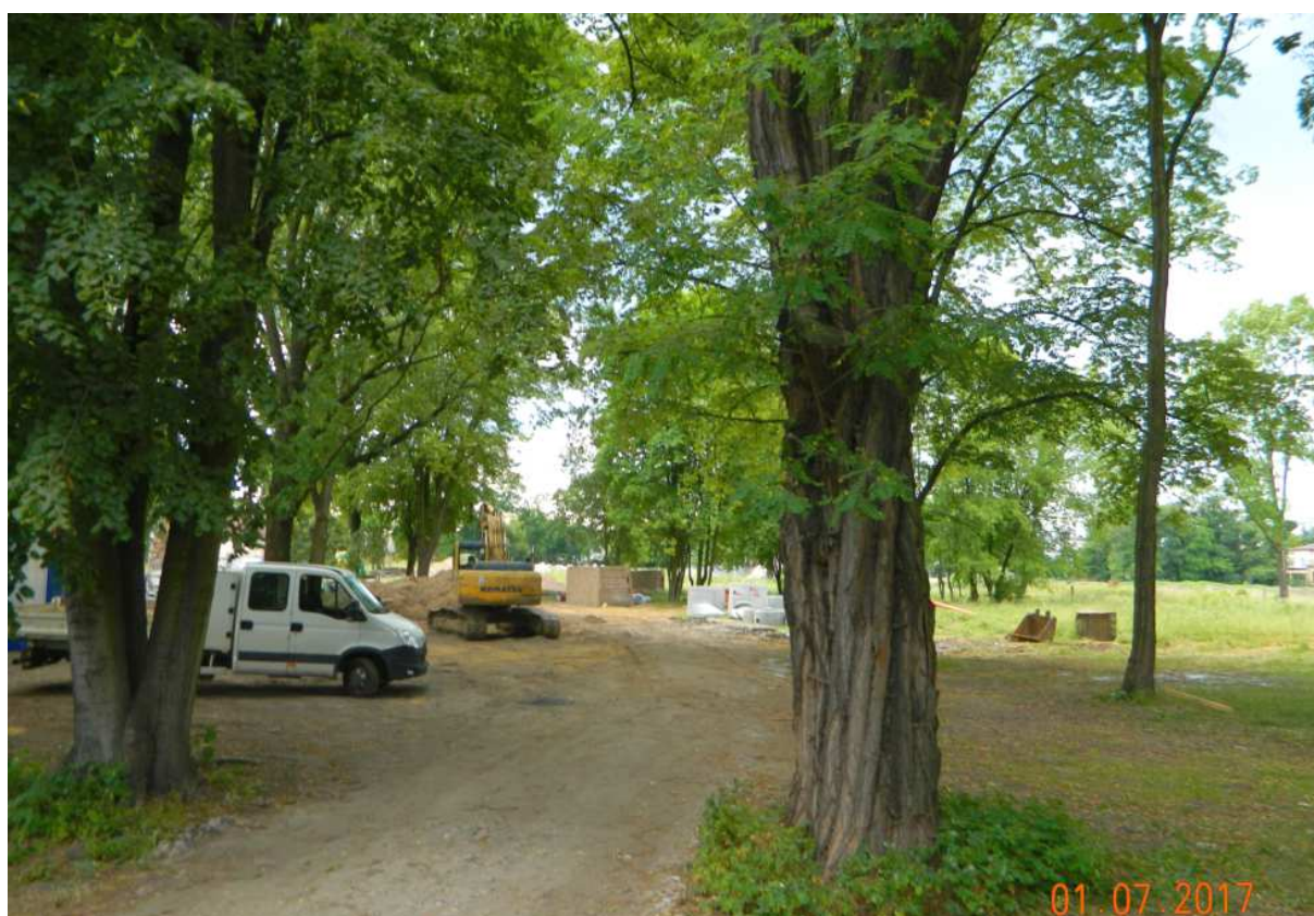
Fot. nr 157 (157-162). Plac budowy kompleksu rekreacyjnego Comarchu, który powstaje w miejscu kompleksu trzech basenów Cracovii. Czy i tu (przy okazji) nie powstanie jakieś blokowisko mieszkalne?
