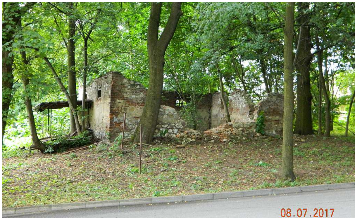
Fot. nr 260. Ruina budynku gospodarczego dawnego dworu Bemów przy ulicy Estońskiej.
