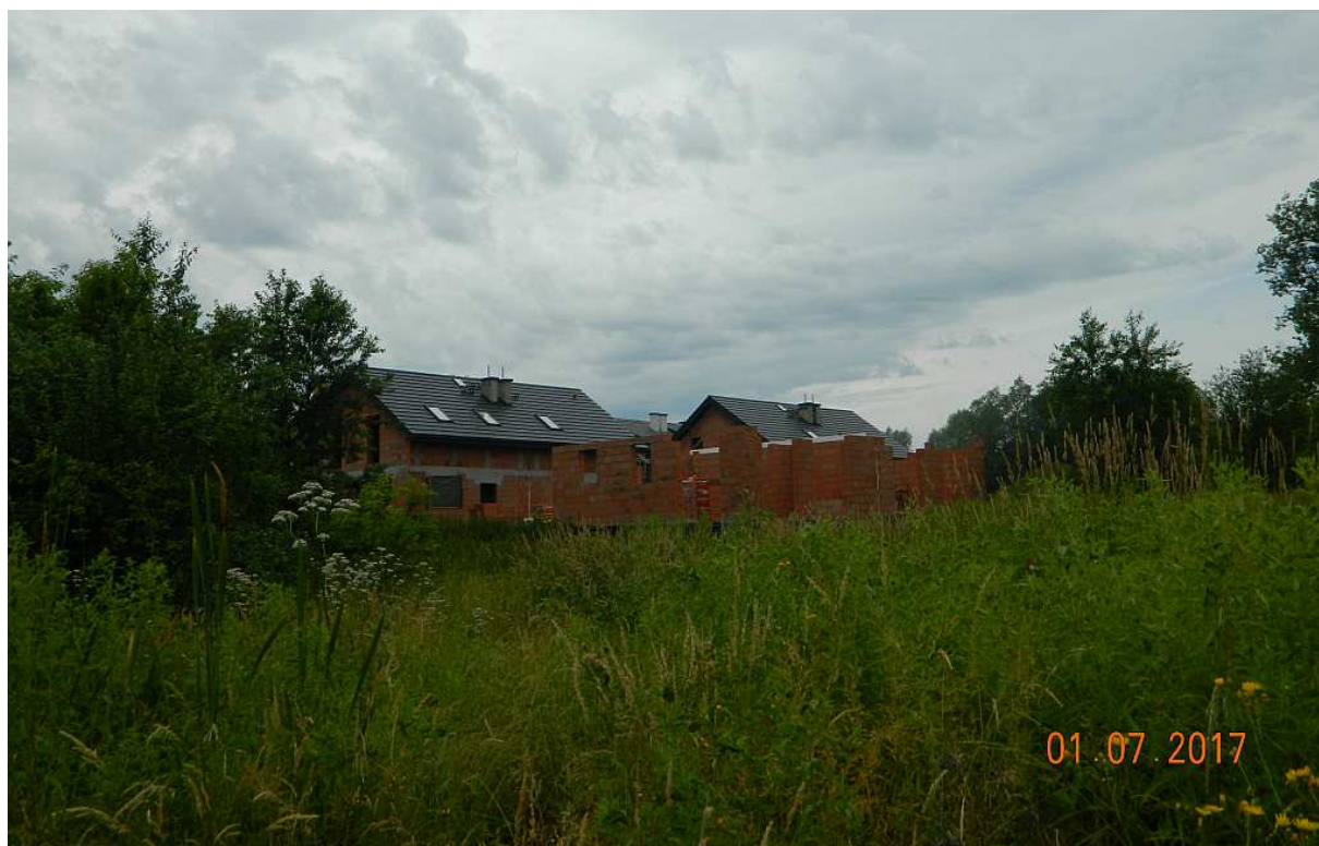
Fot. nr 341 (341-342). Nowo powstające osiedle na przedpolu styku ulic: Kosocickiej i Rżackiej.
