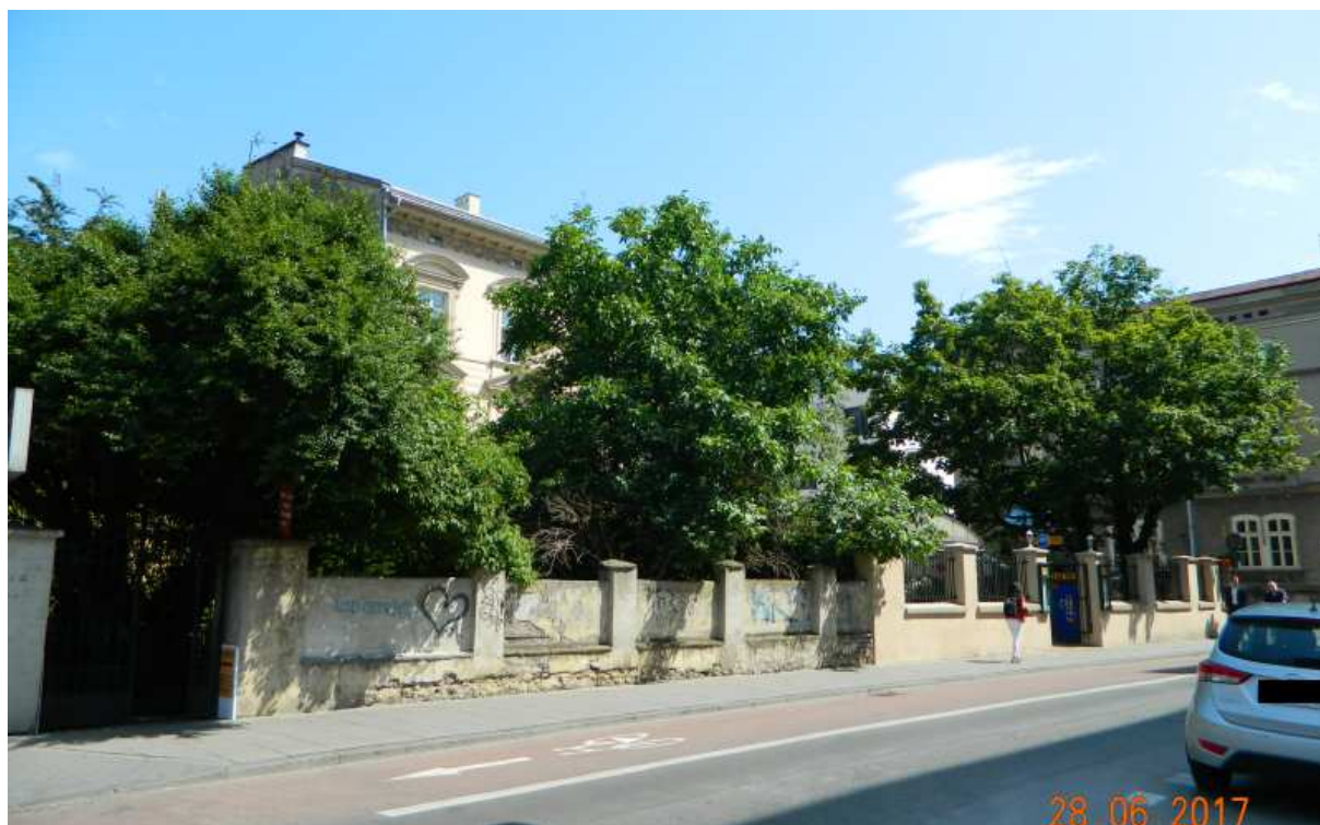
Fot. nr 109. Zielone, ogrodowe kiedyś przedpole budynków spod nr: 17 i 19.
