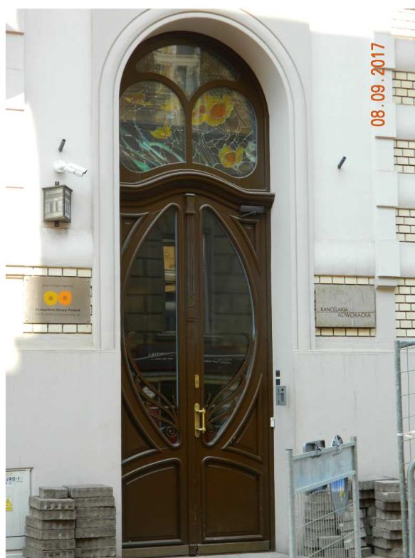
Fot. nr 75 (75-76). Próba odtworzenia dawnych drzwi i ich zwieńczenia w postaci witrażu.
