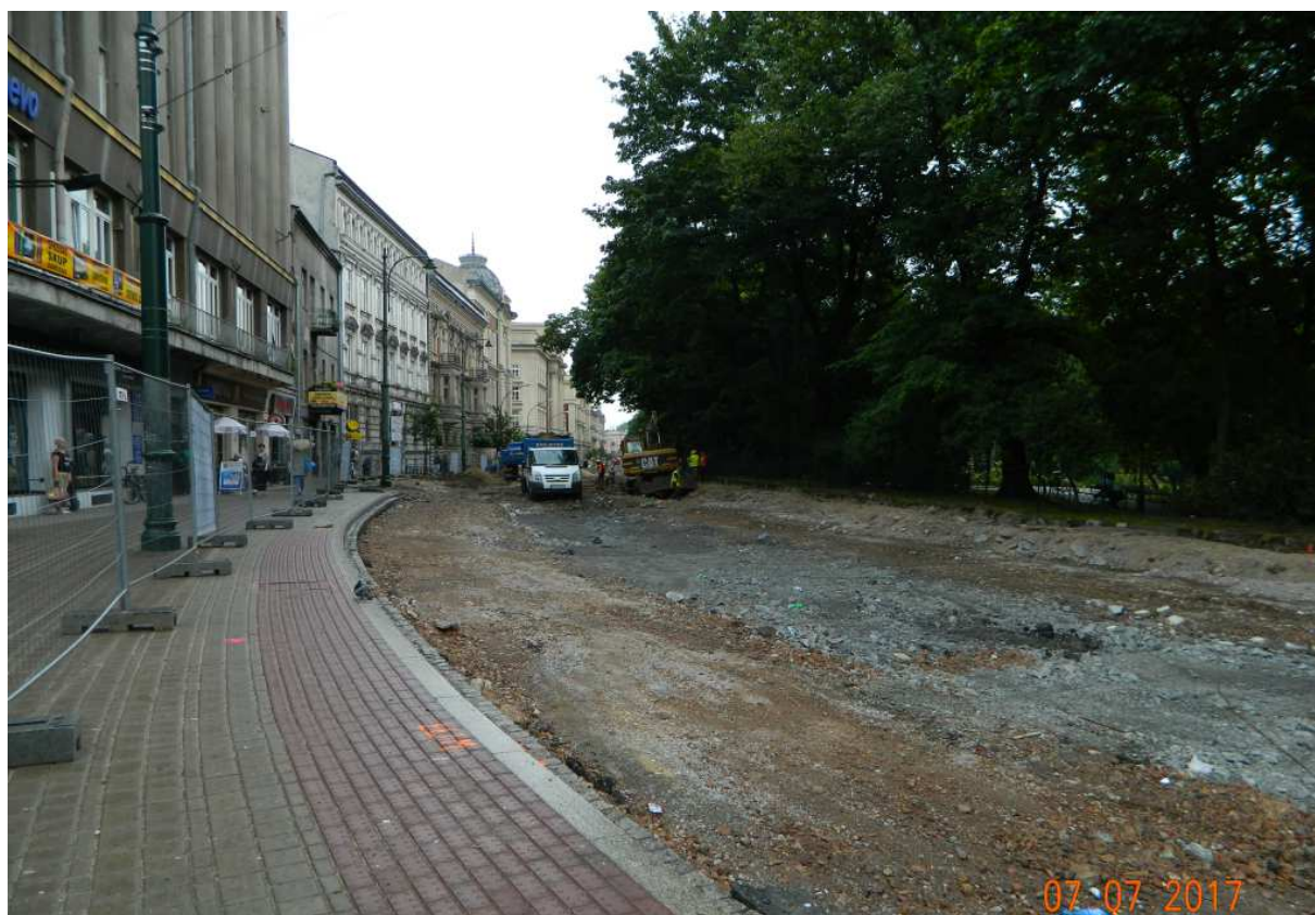
Fot. nr 35. Remont ulicy Basztowej, który miał trwać do grudnia tego roku. Tu odcinek od Rynku Kleparskiego.
