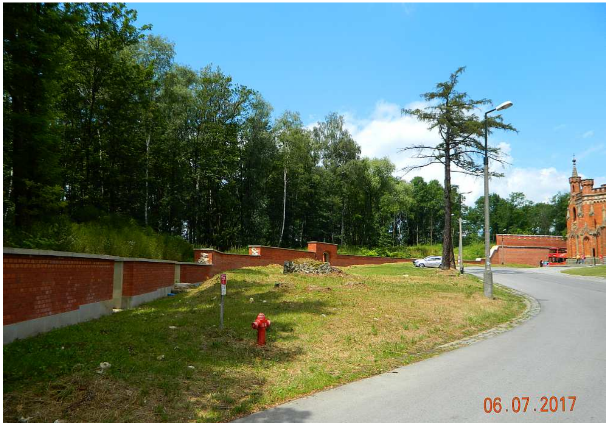
Fot. nr 168 (168-169). Widoki na zrekonstruowany narys kurtyny I-II fortu Kościuszko.
