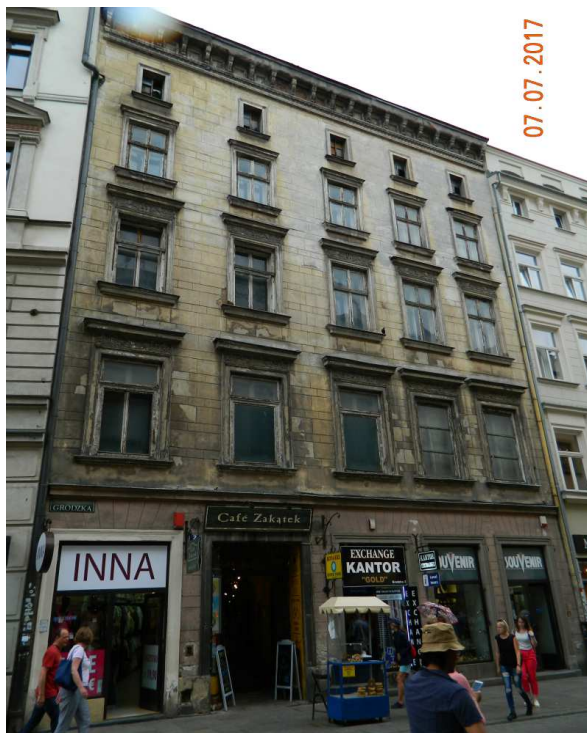
Fot. nr 47. Remontowana kamienica z ulicy Grodzkiej 2, której fasada nie poraża.
