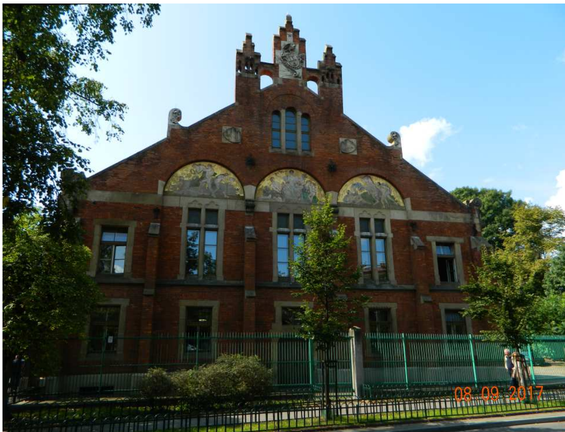
Fot. nr 62 (62-63). Szczytowa ściana TG Sokół w kształcie po przebudowie dokonanej przez Teodora Talowskiego w roku 1894, z malowidłami autorstwa Fryderyka Lachnera.
