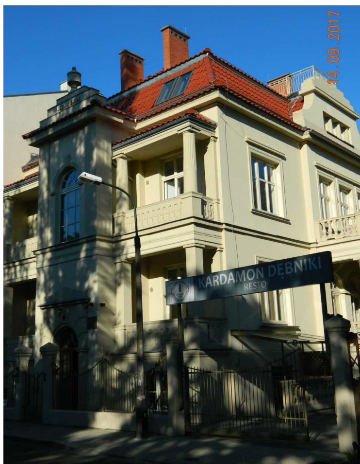
Fot. nr 213. Willa z ulicy Zduńskiej 18, wybudowana w roku 1921 wg projektu Jana Zarzyckiego przez Stefana Marko, dyrektora Polskich Zakładów Garbarskich.
