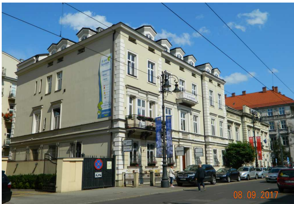
Fot. nr 71 (71-72). Fragment zabudowy o numerach 17 i 15. Kamienica pod nr 15 powstała w roku 1875 wg projektu Jacka Matusińskiego.
