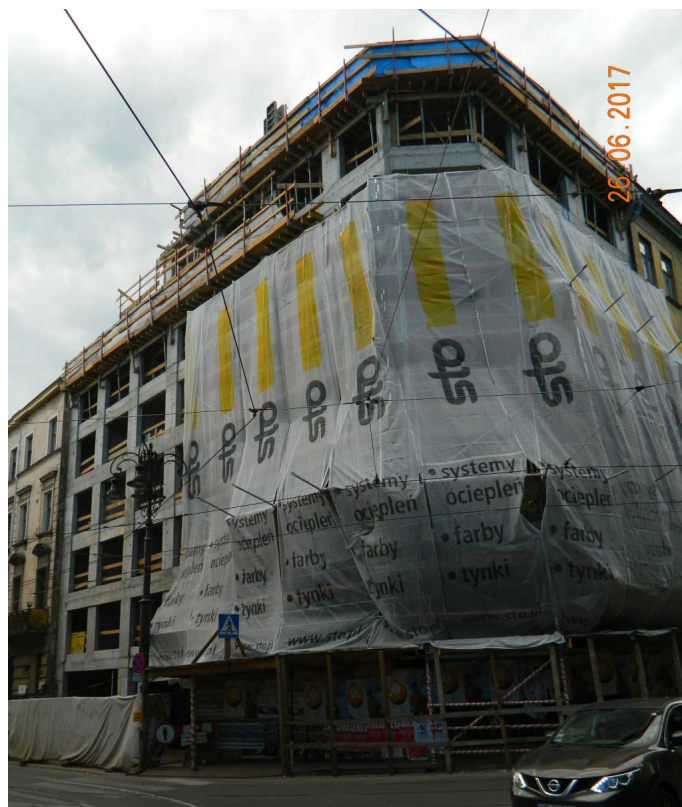
Fot. nr 80 (80-82). Betonowy szkielet przewymiarowanej kamienicy z naroża ulic: Piłsudskiego 1 i Straszewskiego 24, która powstaje w miejscu piętrowego budynku dawnej „Barcelony”. W okresie międzywojennym funkcjonował tam szynk Goldmana.
