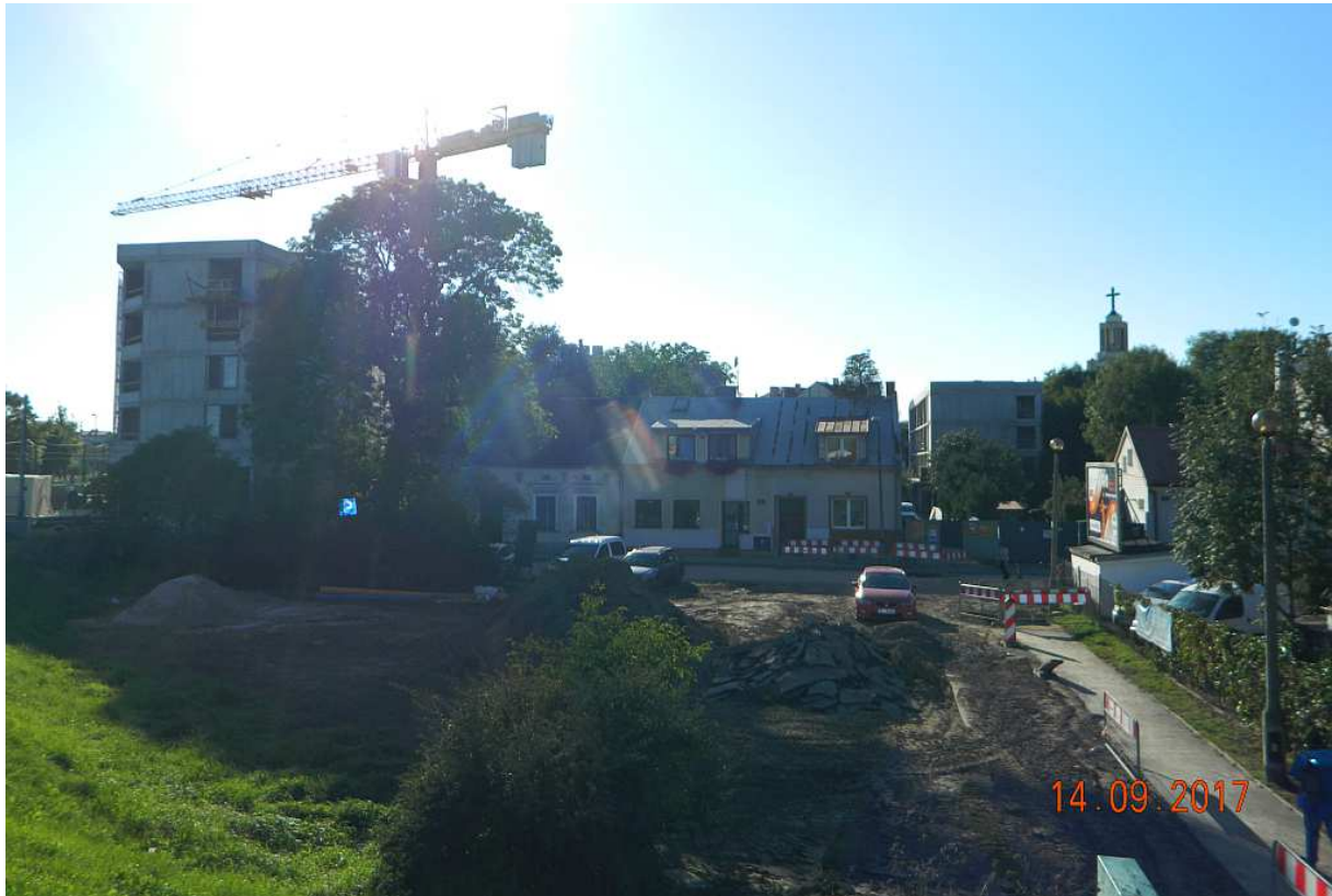
Fot. nr 206 (206-207). Zaciska się betonowy pieścień nad końcowym odcinkiem ulicy Kilińskiego, która swą niską zabudową dobrze oddaje podmiejski klimat.
