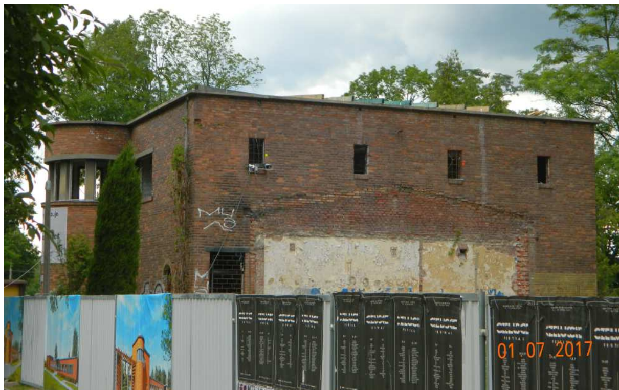
Fot. nr 160 (160-161). Remontowany budynek mieszkalny przy zespole dawnych basenów.
