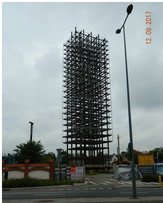
Fot. nr 354. Stalowa konstrukcja „szkieletora” w ujęcie z ulicy Lubomirskiego.
