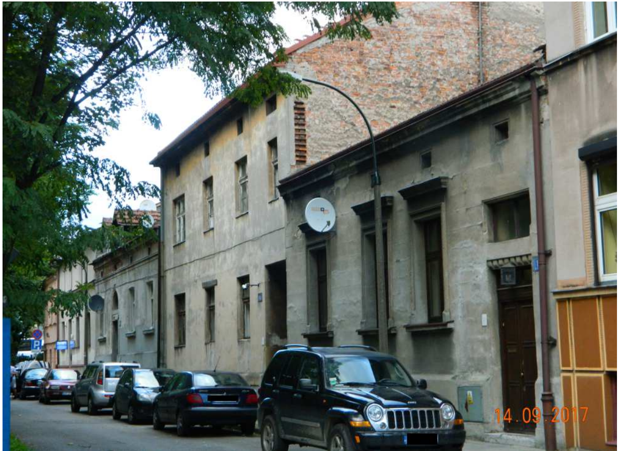
Fot. nr 214. Zabudowa ulicy Zduńskiej o nr: 6-14, która powstała na przełomie XIX i XX wieku.
