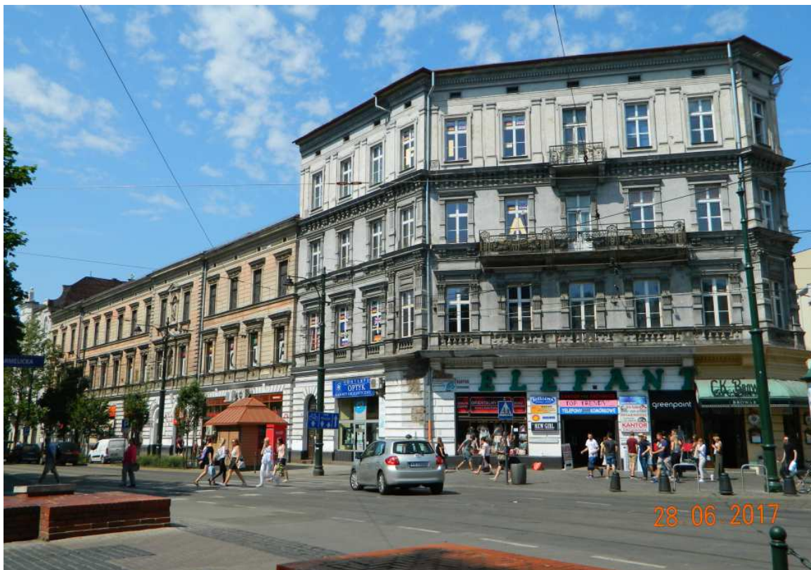
Fot. nr 97. Widok z wylotu ulicy Szewskiej. Być może niedługo powstanie tu galeria, a fragment pod nr 6 i 7 zostanie dobudowany o jedno piętro.
