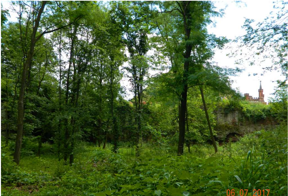
Fot. nr 172. Ruina bastionu nr II. Jest szansa na jego przynajmniej częściową rekonstrukcję, czemu należy kibicować.
