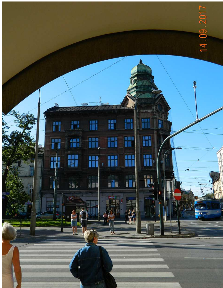
Fot. nr 186 (186-187). Oczekująca na kompleksowy remont kamienica Orensteina z ulicy Dietla 42, która powstała w latach 1911-1913 wg projektu Jana Zawiejskiego.
