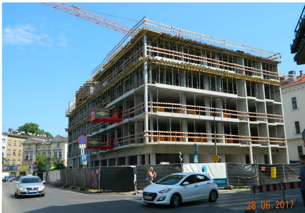
Fot. nr 133 (133-138). Przewymiarowane betonowe blokowisko z ulicy Dolnych Młynów 11 (róg z Rajską), które powstało w miejscu dawnego, dwupiętrowego lazaretu przy C.K. koszarach. Tak zdaniem WKZ wygląda „powrót do zabudowy tej ulicy z lat 50-tych”.
