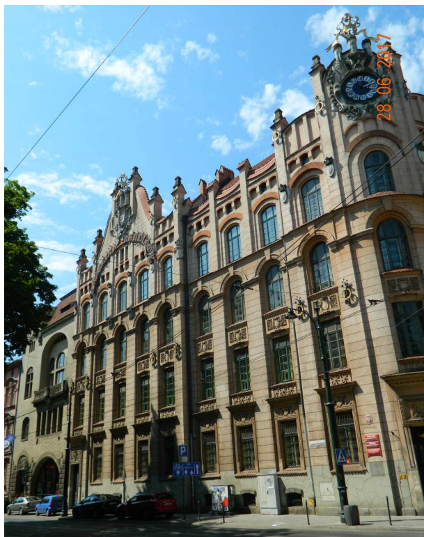
Fot. nr 86. Zabudowa ulicy Straszewskiego o numerach 28 i 29. Pod nr 28 dawny budynek NOT, który powstał w roku 1906 wg projektu Sławomira Odrzywolskiego, a na pierwszym planie budynek dawnej Szkoły Handlowej z lat 1904-1906.
