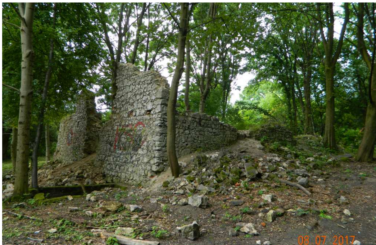
Fot. nr 265. Ruina budynku gospodarczego od strony ulicy Alabańskiej.
