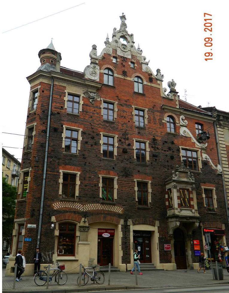
Fot. nr 130. Niezwykła fasada kamienicy Pod Pajakiem, autorstwa Teodora Talowskiego.
