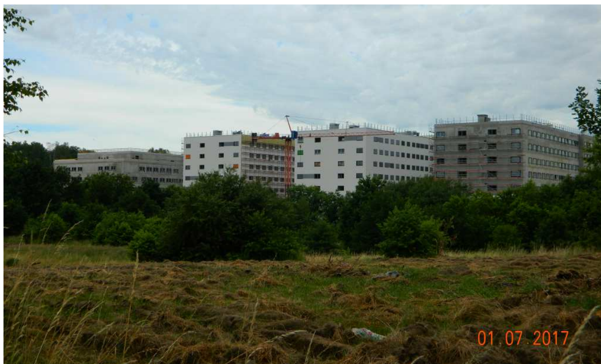
Fot. nr 328 (328-332). Kończy się budowa kompleksu szpitalnego w miejscu dawnego lasu brzozowego wzdłuż ulicy Jakubowskiego – widoki od strony ulicy Słona Woda.
