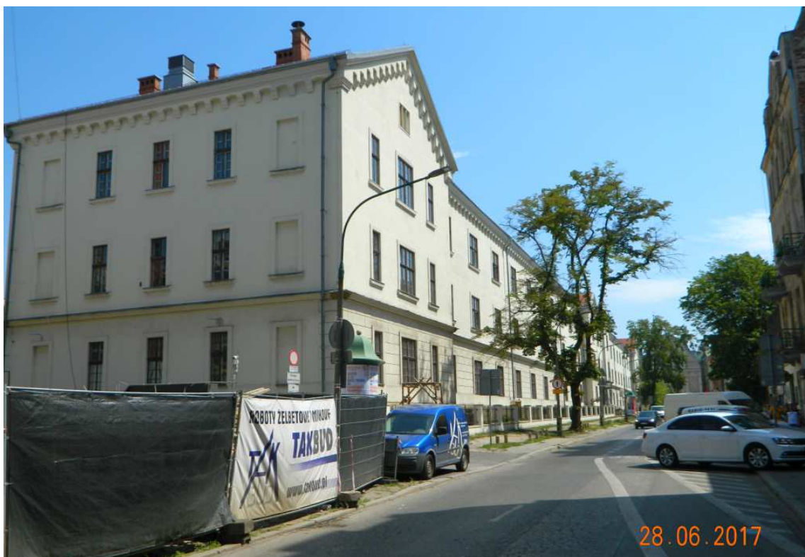
Fot. nr 139. Ulica Rajska w ujęciu od strony ulicy Dolnych Młynów.
