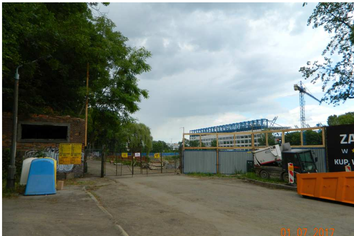
Fot. nr 155 (155-156). Plac budowy „aparthotelu” w miejscu stadionu lekkoatletycznego Cracovii, który „przekształcił się” już w mieszkalny, sześciopiętrowy „Błonia Park”.
