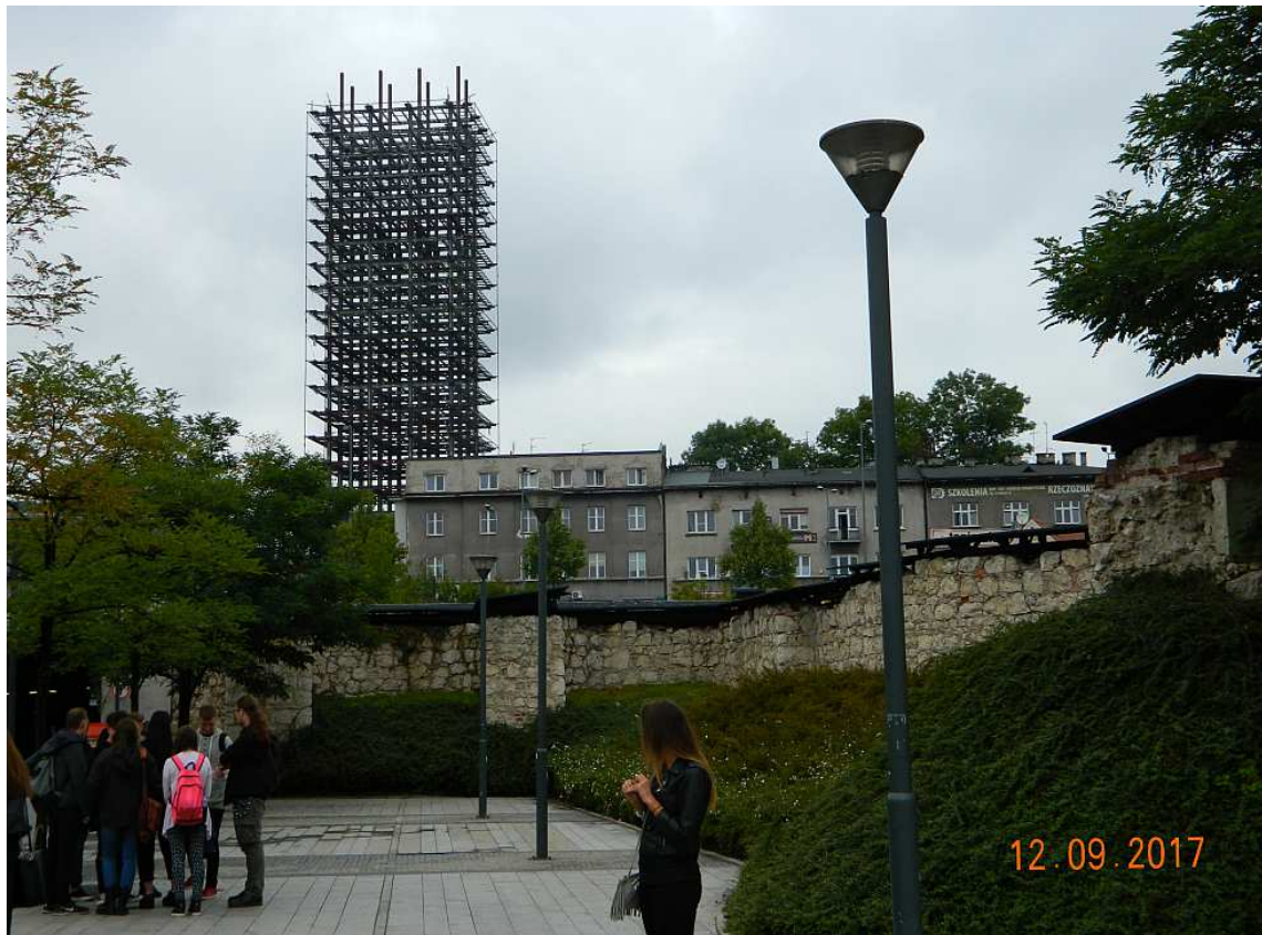
Fot. nr 355 (355-356). Konstrukcja stalowa „szkieletora” w stanie po usunięciu ścian zewnętrznych i działowych, ponad ulicą Lubomirskiego, w ujęciu spod fortu mogińskiego.
