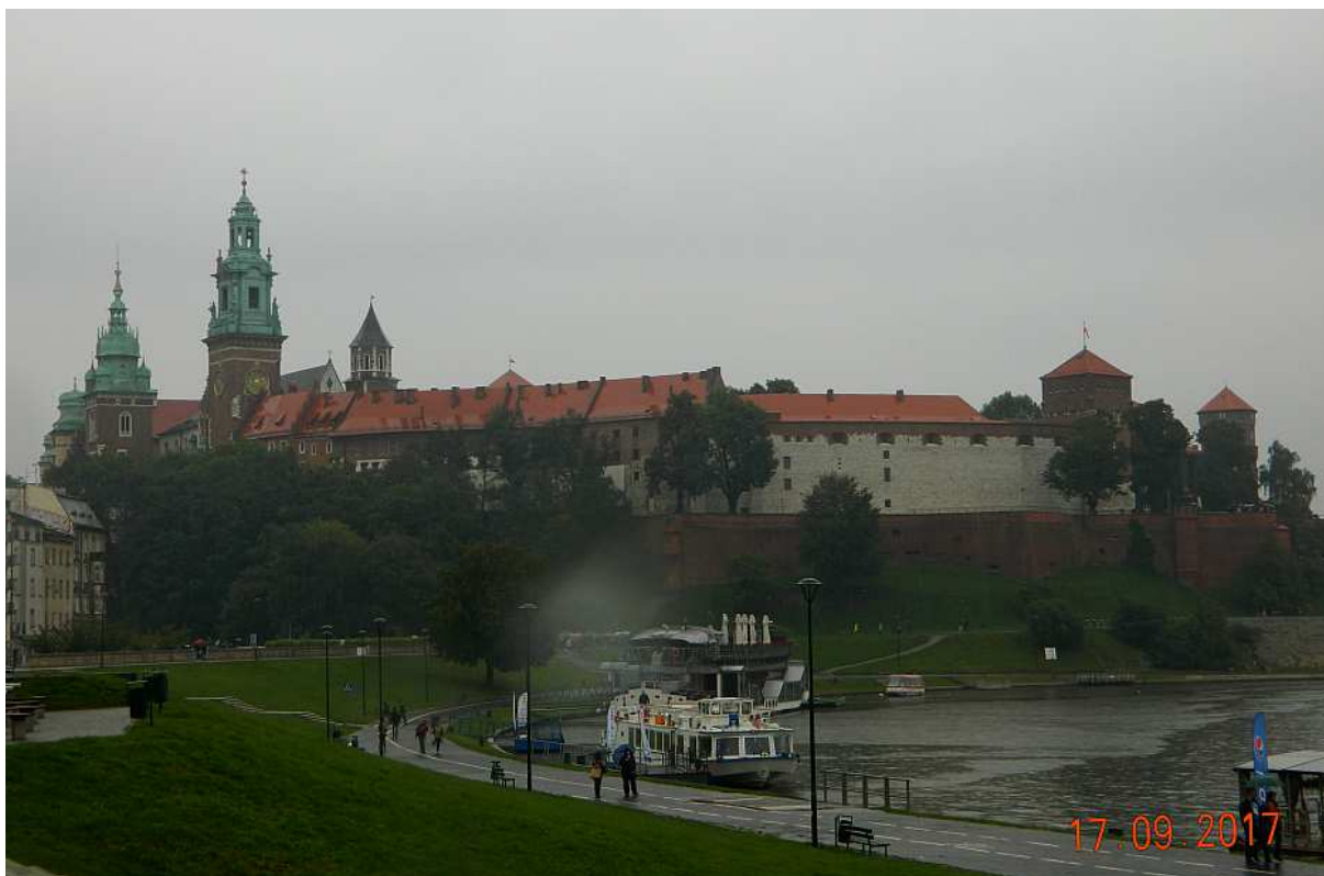
Fot. nr 11 (11-12). Ujęcia Wawelu z Mostu Dębnickiego.
