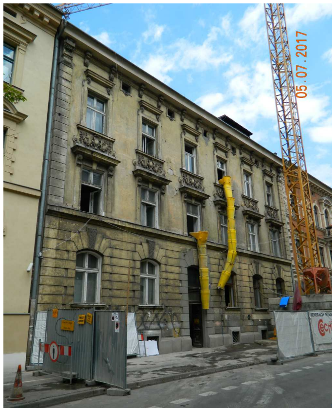
Fot. nr 94. Dawna kamienica Zollów spod nr 25 z lat 1891-93 (proj. W. Kaczmarzski).
