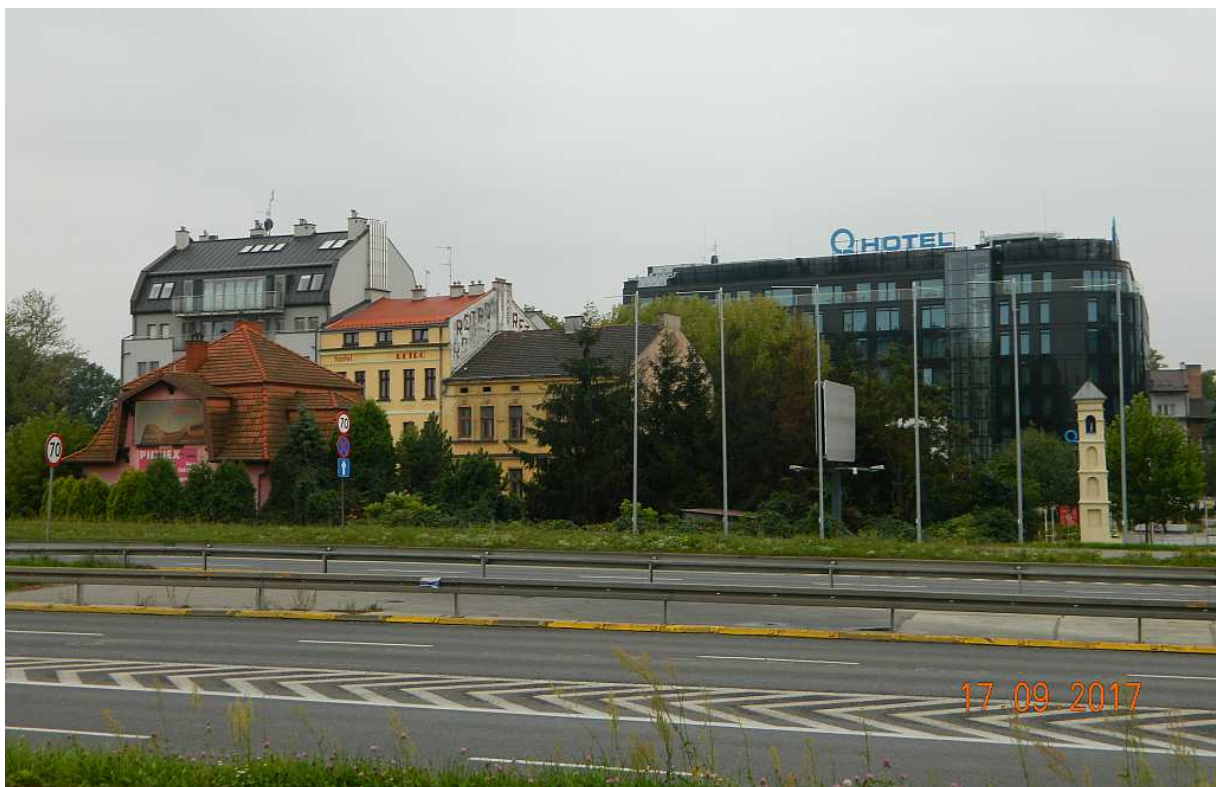
Fot. nr 225. Podobne ujęcie z niedawno wybudowanym hotelem Plus przy ulicy Wygranej 6 (z prawej).
