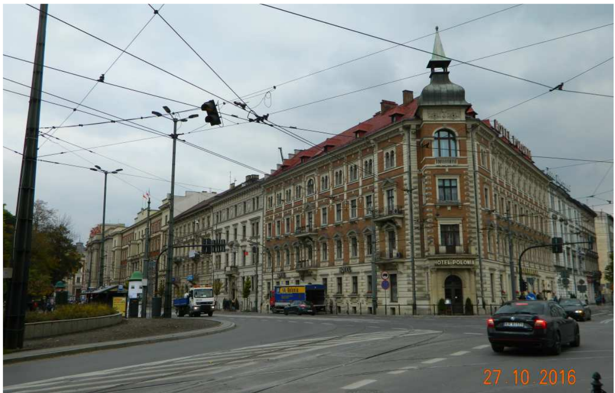
Fot. nr 138. Eklektyczny budynek hotelu Polonia w narożu z ulicą Pawią 2, który powstał w latach 1886-87 wg projektu Sławomira Odrzywolskiego i Władysława Kaczmareckiego.
