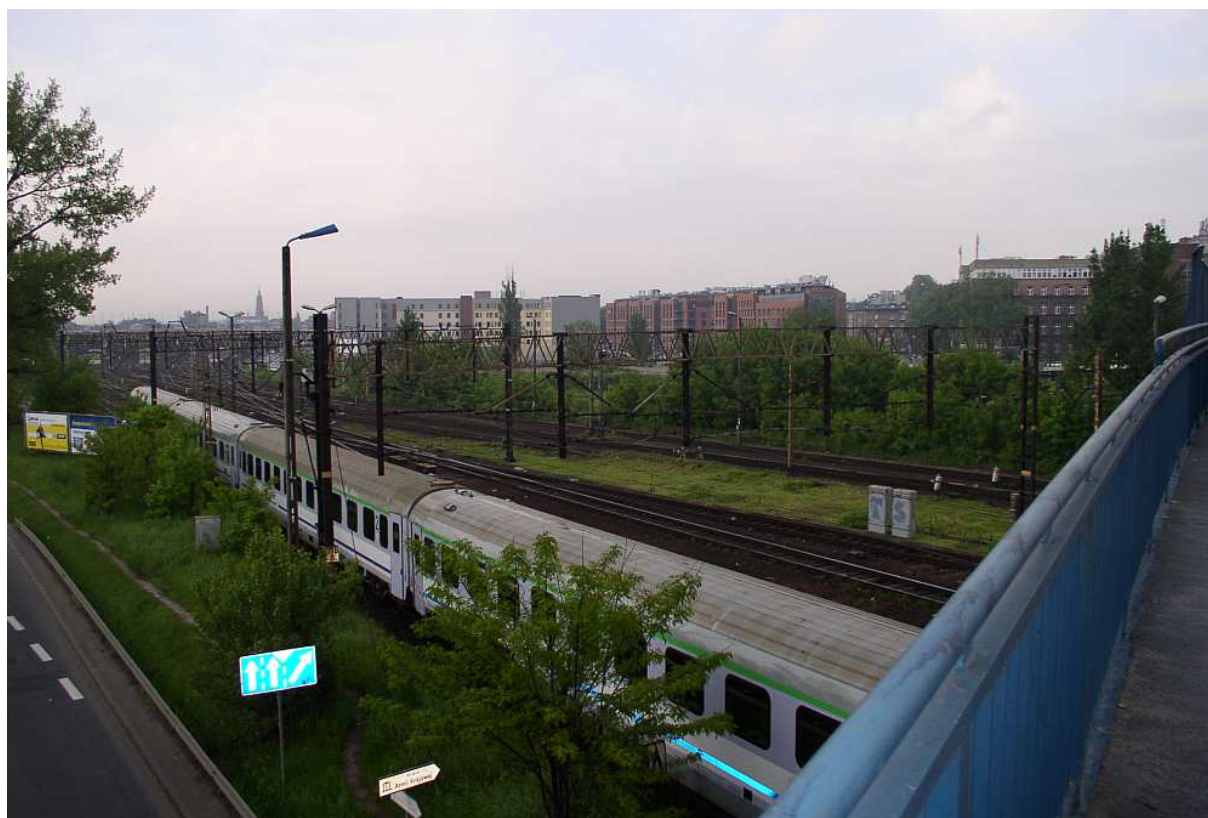
Fot. nr 207 (207-208). Panoramy z wiaduktu nad ulicą Warszawską w stronę styku ulic: Pawiej i Warszawskiej. (21.05.2010)
