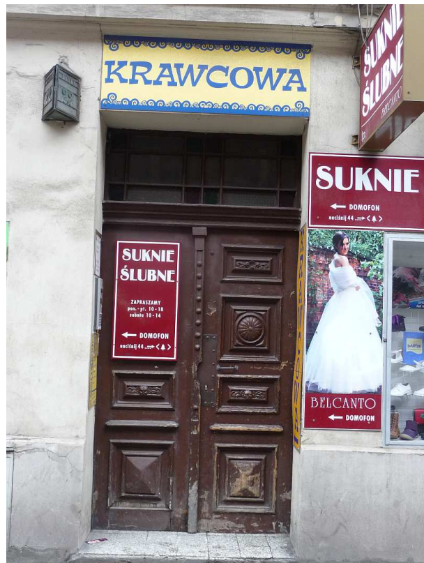
Fot. nr 44. Drzwi o cechach eklektycznych kamienicy spod nr 22, która została wybudowana w latach 1892-98 wg projektu Jana Drzewieckiego. (02.03.2012)
