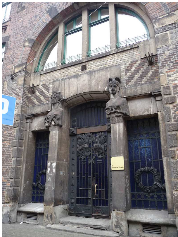
Fot. nr 29. Secesyjny portal i wykonane z metalu drzwi. (02.03.2012)
