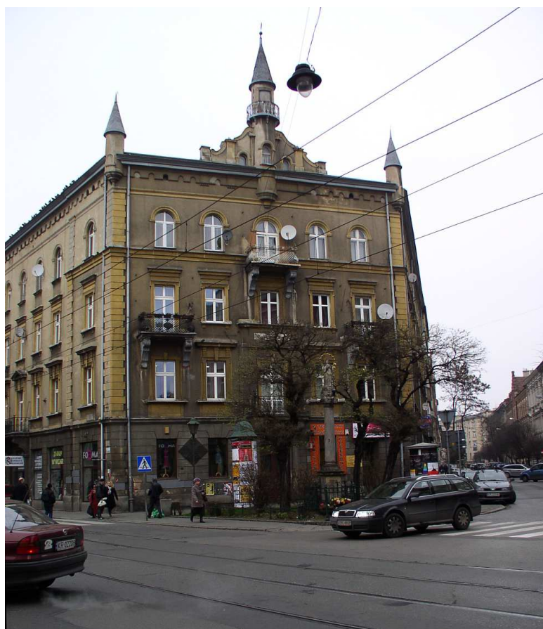
Fot. nr 50 (50-55). Kilka ujęć kamienicy Artura Teodora Rayskiego, uczestnika Powstania Styczniowego, a potem oficera armii osmańskiej w Turcji, z naroża ulic: Długiej 31 i Pędzichów 2. Kamienica „Pod Minaretem” („Dom Turecki”) powstała w latach 1883-85, ale została przebudowana w roku 1910 przez Henryka Lamensdorfa, kiedy podwyższono ją o III. piętro. Do roku 1818 w tym miejscu stał kościół p.w. św. Walentego, pospołu ze skromnym szpitalem, którego początki sięgały połowy XV. Wieku. (04.12.2009)
