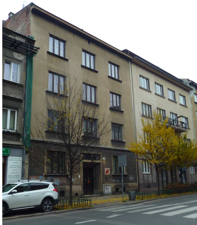
Fot. nr 10. Międzywojenne kamienice o numerach 63-65, w których miejscu istniały zabudowania fabryczne zakładu maszyn rolniczych Ludwika Zieleniewskiego, powstałego na początku lat 70. XIX wieku. Nowy zakład Zieleniewskich, wybudowany przez synów Ludwika: Leona i Edmunda, powstał I dekadzie XX wieku na Grzegórkach. (09.11.2017)
