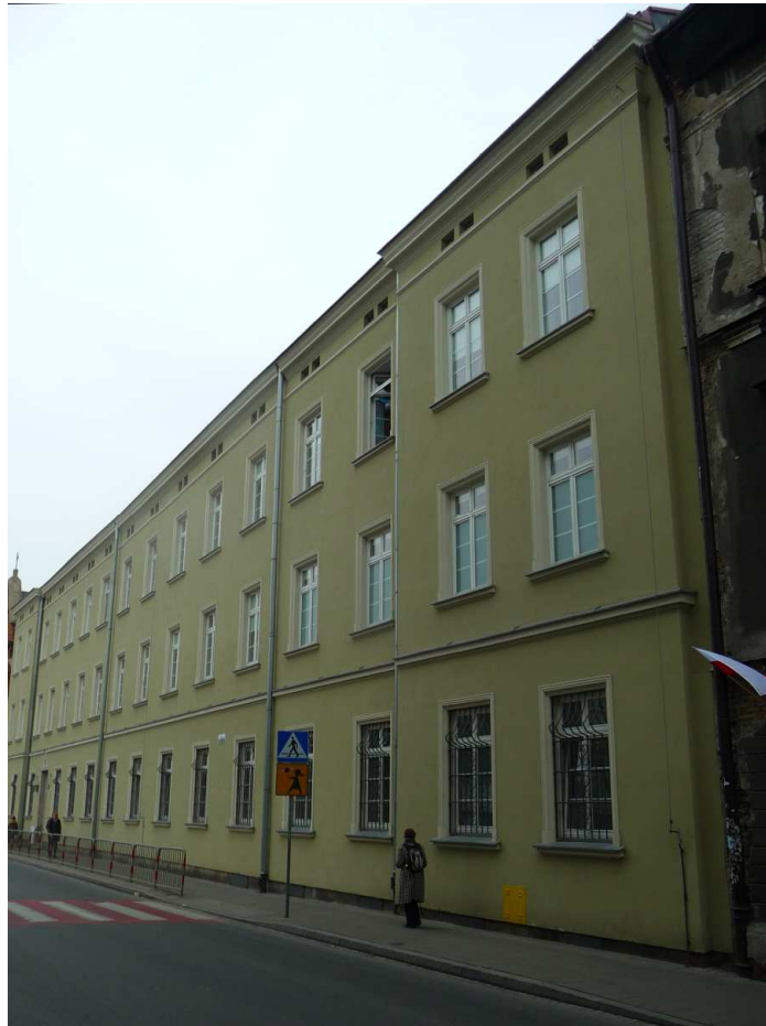
Fot. nr 91. Kamienica pod nr 21. Jej projektantem był Maksymilina Nitsch. (09.11.2017)
