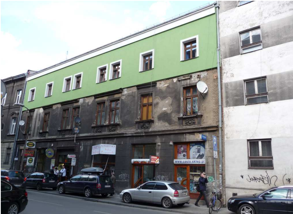
Fot. nr 3. Współcześnie zeszpecona, przez karykaturalną nadbudowę II piętra, kamieniczka spod nr 9. (23.04.2012)
