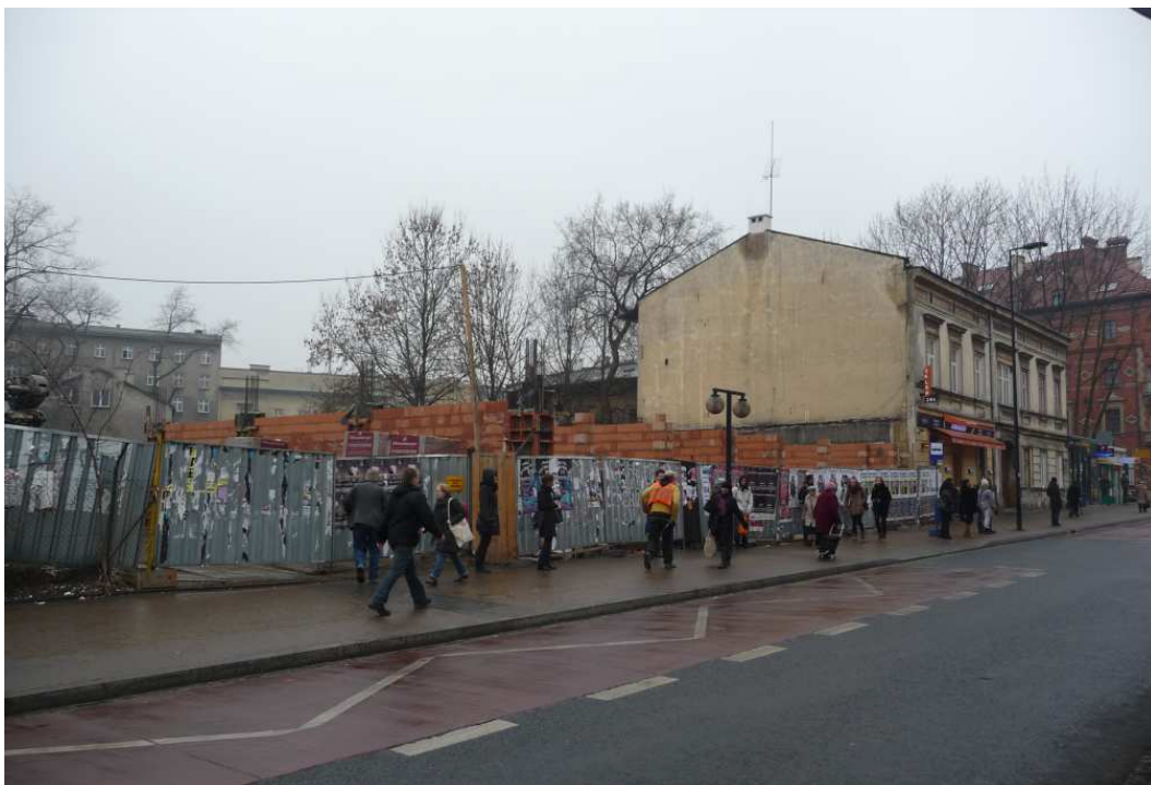
Fot. nr 147 (197-198). Wzdłuż ulicy Kurniki – tu widok od strony ulicy Pawiej. Z lewej plac budowy w narożu z ulicą Pawią, a w tle zabudowa ulicy Worcella. (09.03.2012)
