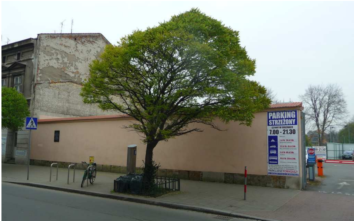
Fot. nr 87. Po domu spod nr 15 pozostał tylko murek. (09.11.2017)
