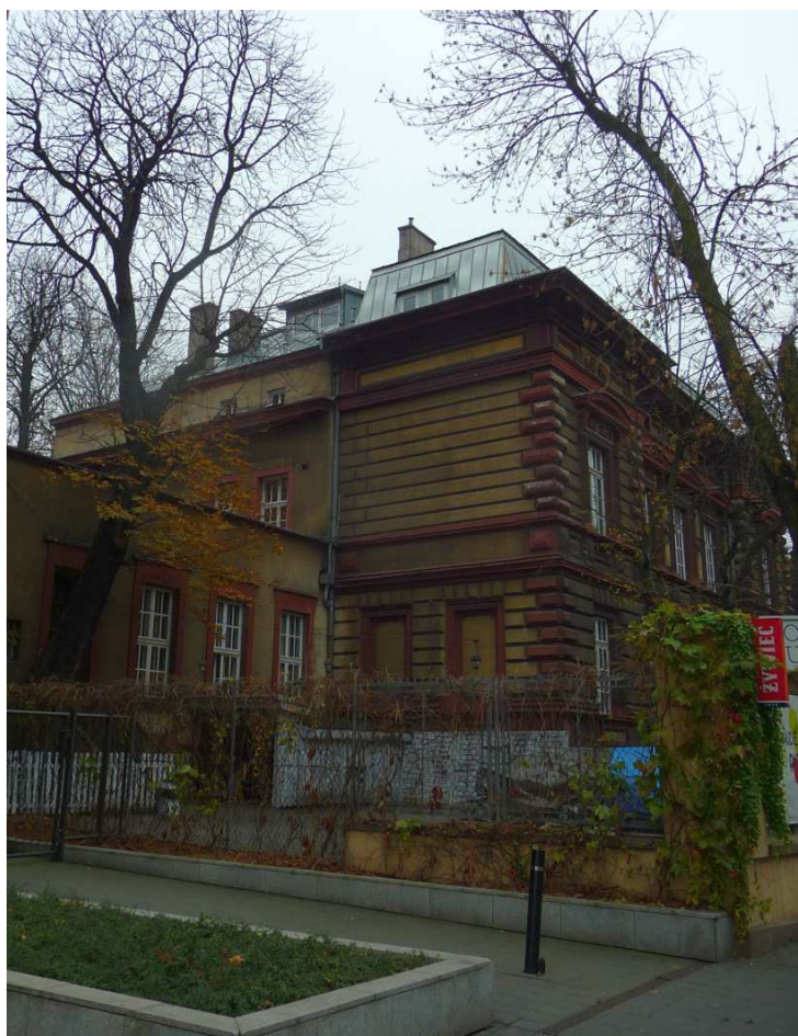
Fot. nr 186. Narożnik od strony ulicy Szlak. (09.11.2017)
