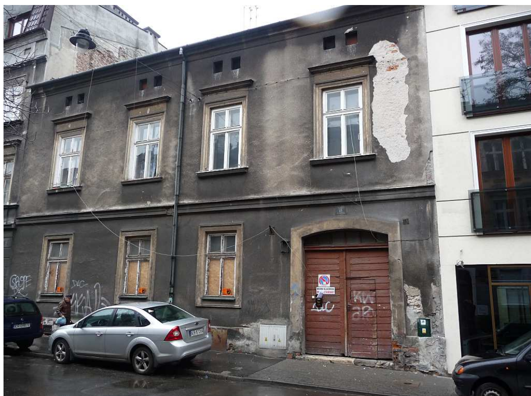
Fot. nr 72. Piętrowy dom pod nr 3. (16.04.2012)
