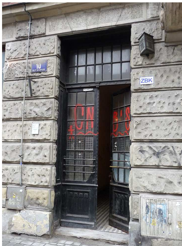
Fot. nr 36. Metalowe drzwi. (02.03.2012)
