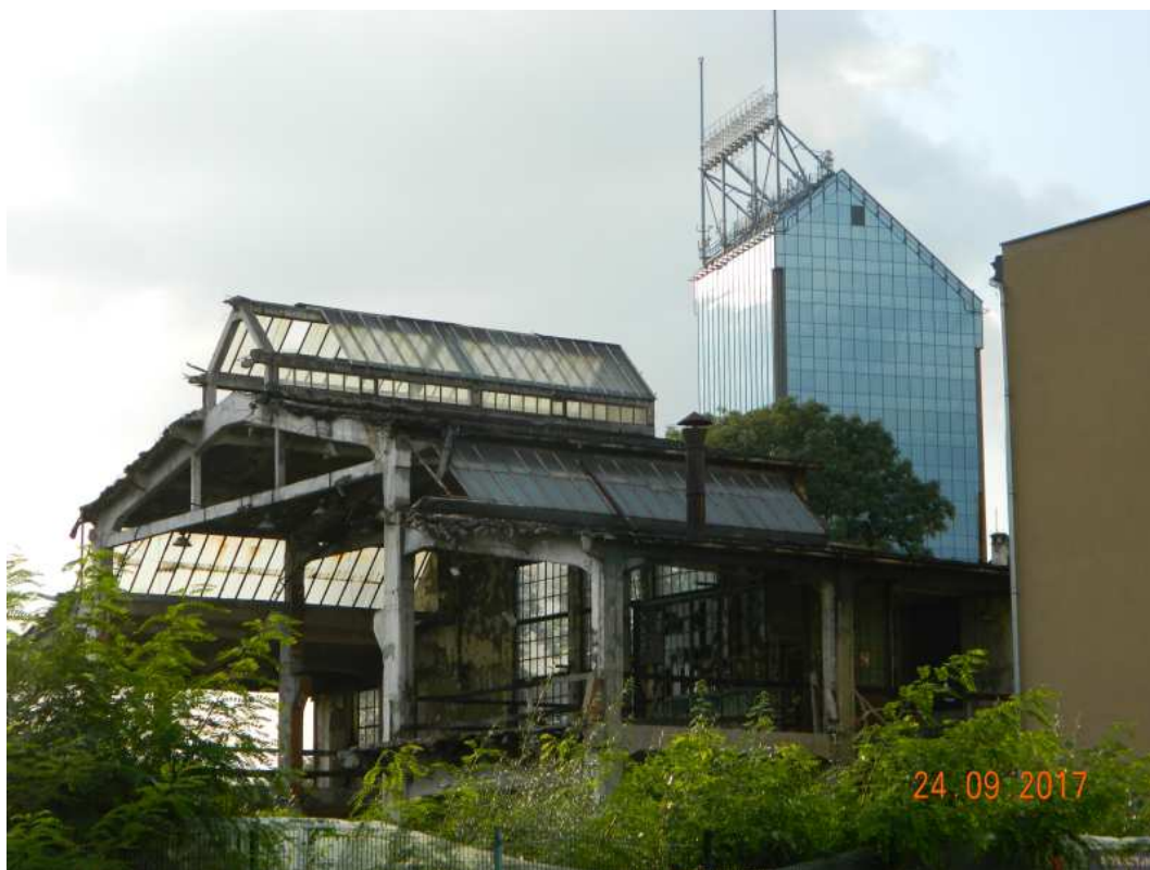
Fot. nr 1a. Tyle dziś pozostało po zabudowaniach międzywojennej firmy: „Polskie Fabryki Maszyn i Wagonów L. Zieleniewski S.A” na gruntach przy ulicy Grzegórzeckiej 69. Z dawnych obiektów przetrwał jedynie budynek fabryczny.
