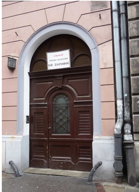
Fot. nr 109a. Neorenesansowe drzwi kamienicy. Tabliczka nad drzwiami informuje o dacie jej powstania.(16.04.2012)
