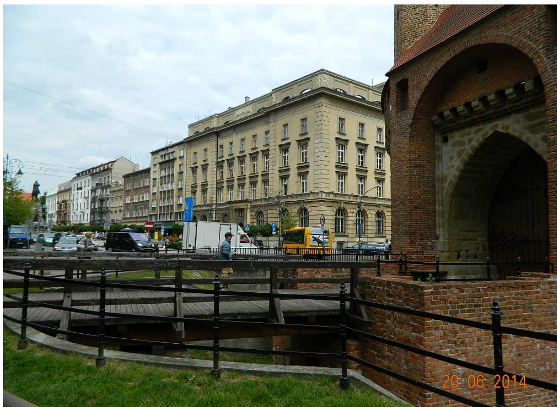
Fot. nr 145. Fragment zabudowy placu Matejki o nr: 1-8. Z prawej gmach Narodowego Banku Polskiego spod nr 1/Basztowej 20, który powstał w latach 1921-25 wg projektu Kazimierza Wyczyńskiego i Teodora Hoffmana w miejscu hotelu Centralnego.
