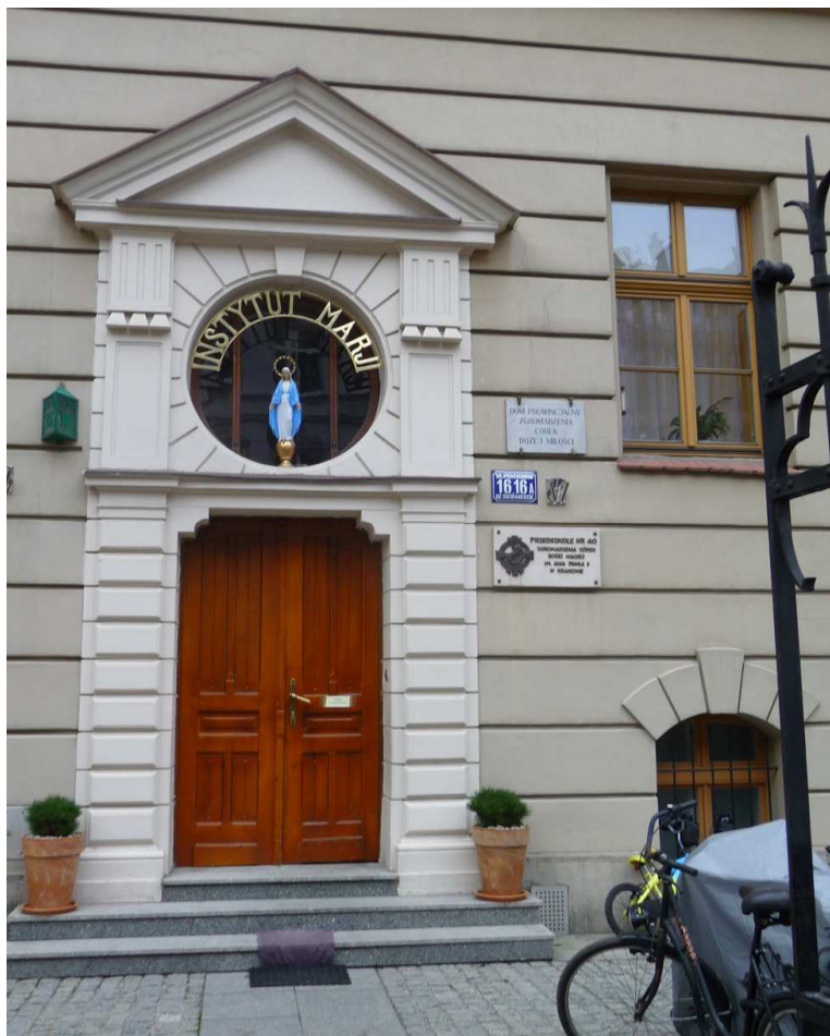
Fot. nr 107. Wejście do klasztoru. (09.11.2017)
