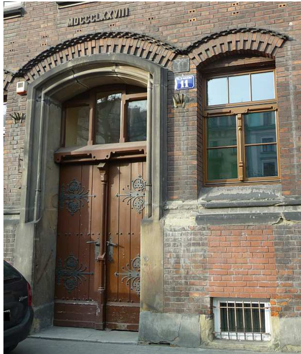
Fot. nr 157. Detale fasady: drzwi i okno, zachowane w oryginalnych kształtach. Przetrwiała również klamka w drzwiach, co w dzisiejszym Krakowie jest wielką rzadkością. (17.01.2014)
