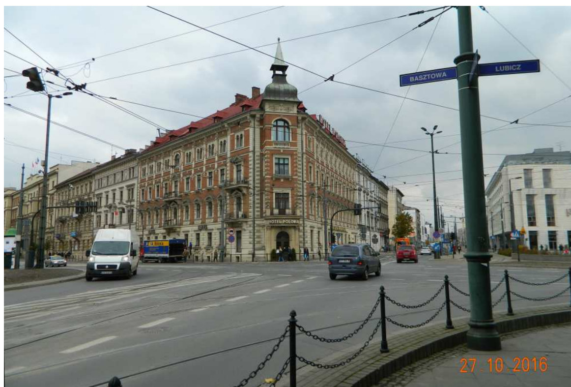
Fot. nr 195. Na styku ulic: Basztowej i Pawiej.
