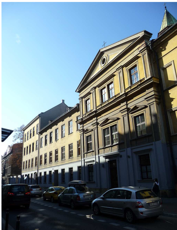
Fot. nr 168. Budynki klasztorne spod nr 6 i fasada kościoła spod nr 8. (23.10.2013)
