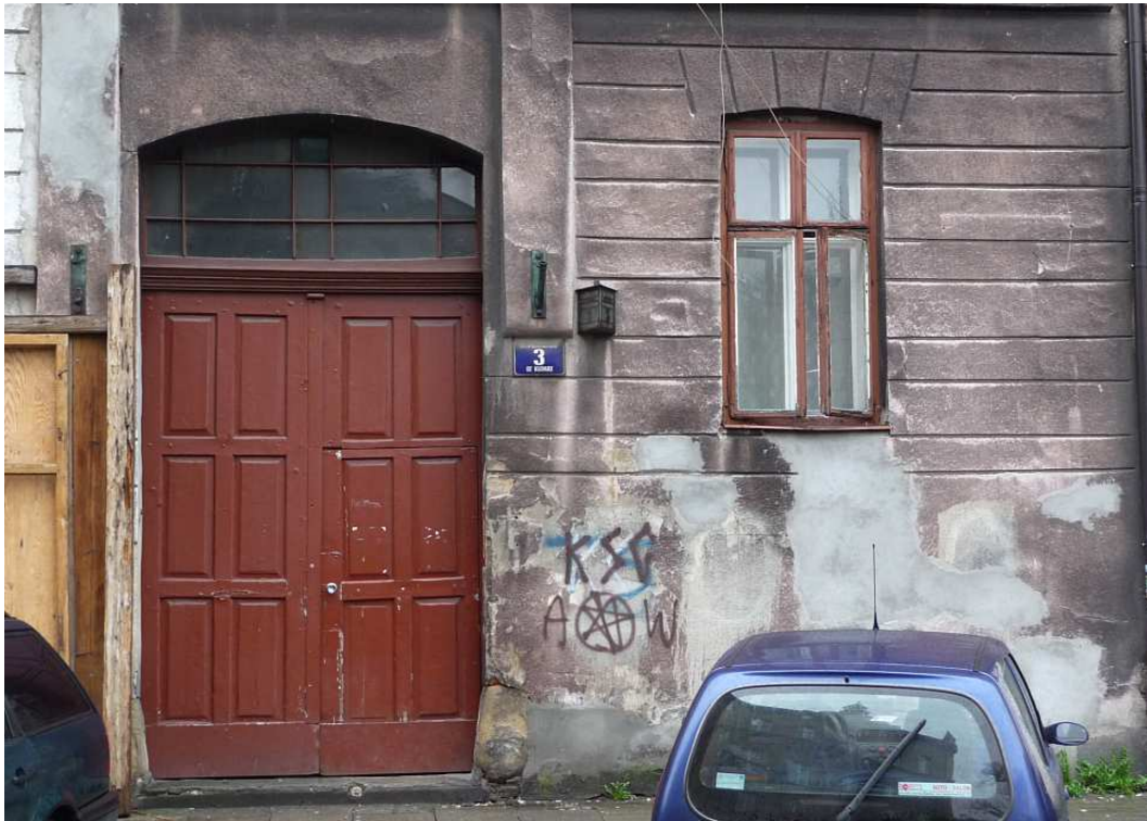
Fot. nr 101. Oryginalne okno parteru, o cienkich szprosach, na dodatek oteierane na zewnątrz, jakich już mało na terenie Krakowa. (16.04.2012)
