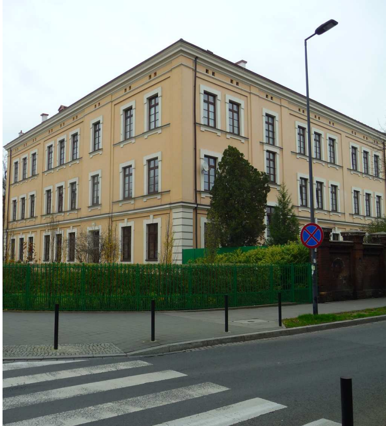
Fot. nr 179 (179-180). Kamienica o cechach klasycystycznych spod nr 11, która została wybudowana w ostatniej kwarcie XIX wieku. (09.11.2017)
