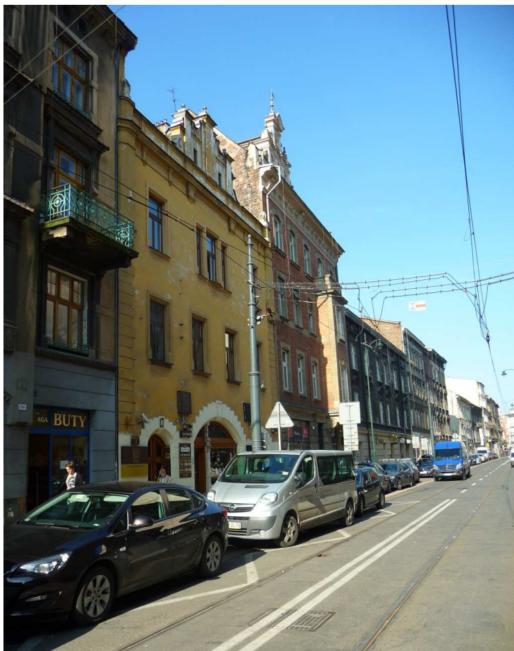
Fot. nr 33. Fragment zabudowy ulicy od nr 8. (17.10.2017)
