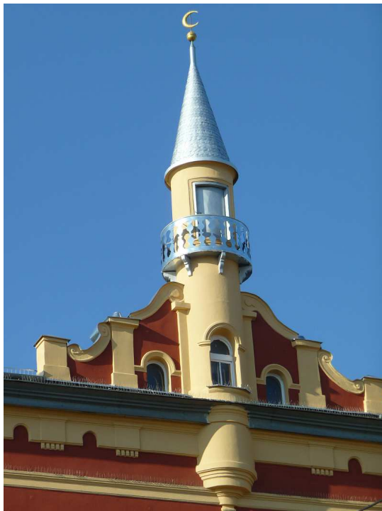
Fot. nr 55. Wieżyczka minaretu. (17.09.2014)
