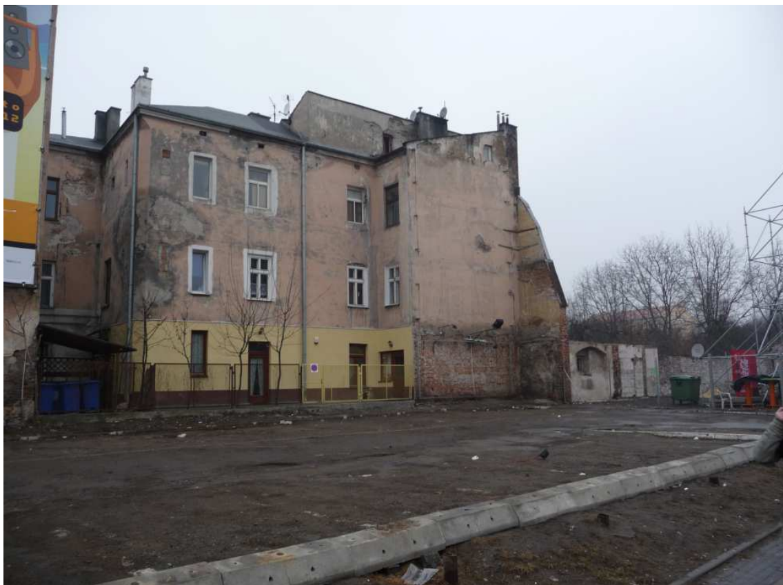
Fot. nr 201 (201-202). Pusty plac w narożu ulic: Pawiej i Kurniki w roku 2012. Po prawej pusta przestrzeń po niedawno wyburzonych budynkach pod nr: 22 i 24. (09.03.2012)
