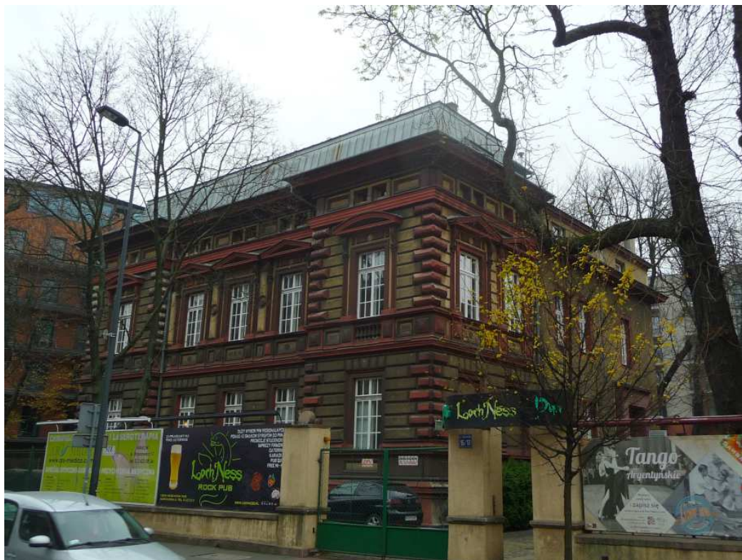
Fot. nr 185. Narożnik od strony ulicy Ogrodowej. (09.11.2017)
