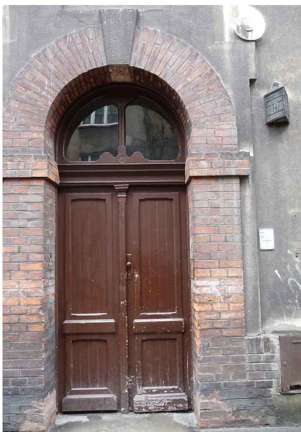
Fot. nr 18. Drzwi kamienicy spod nr 19 (proj. Józef Pakies - 1893). (16.04.2012)
