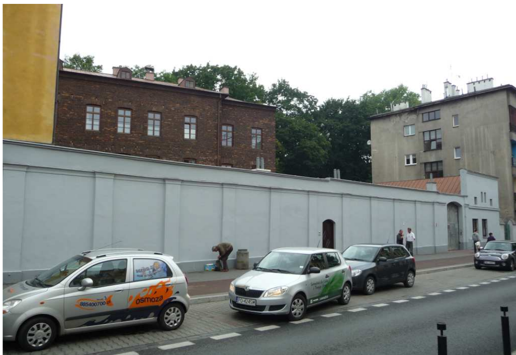
Fot. nr 174 (174-175). Kamienica przyklasztorna spod nr 10, jeśli wierzyć cyfrze wypisanej na drzwiach bramy wjazdowej na dziedziniec. (21.07.2012)
