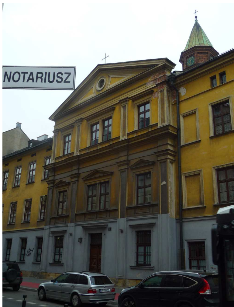
Fot. nr 170. XIX-wieczne wejście do kościoła p.w. Najświętszego Serca Pana Jezusa. (09.11.2017)
