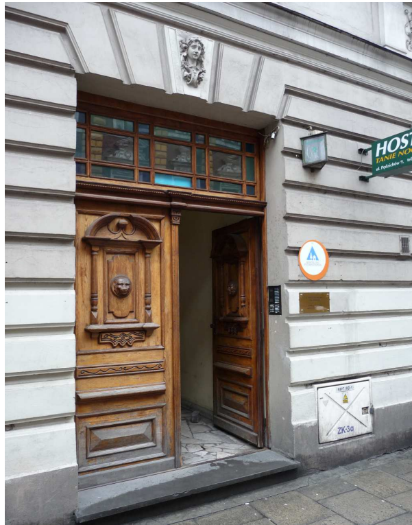
Fot. nr 103. Eklektyczne drzwi kamienicy spod nr 9, wybudowanej w roku 1892 wg projektu Stefana Ertela. (16.04.2012)
