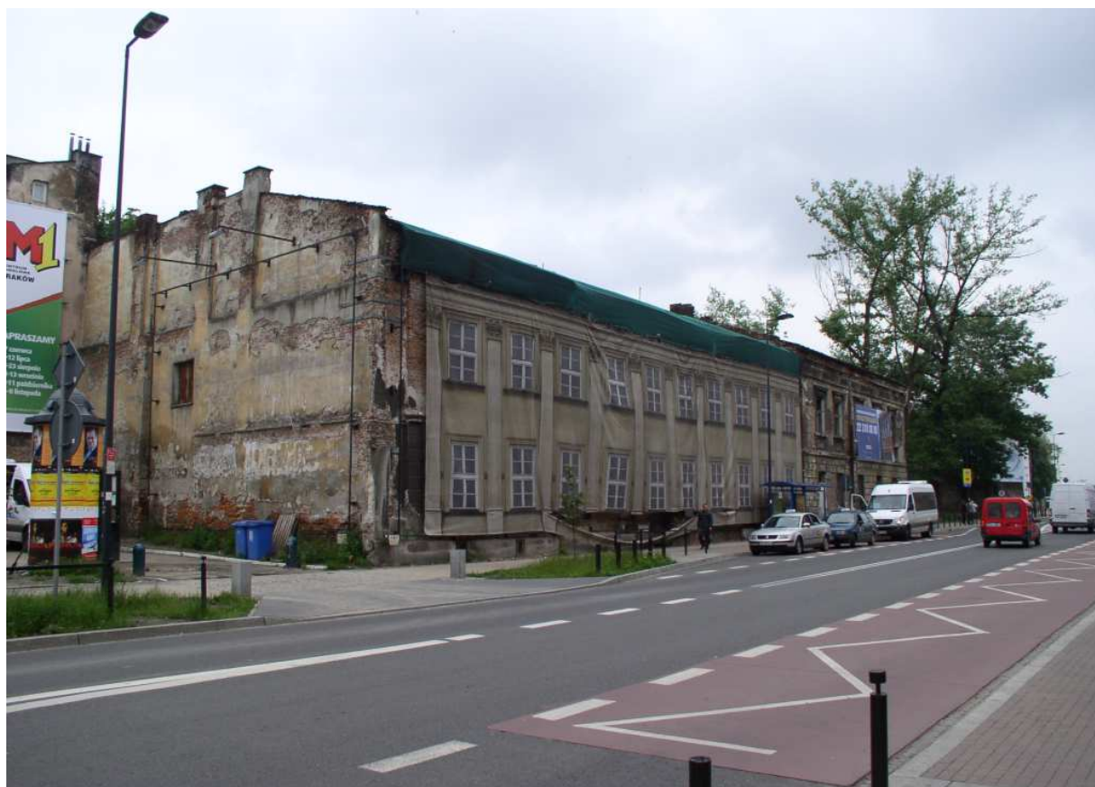
Fot. nr 203. Nieistniejące już budynki przy ulicy Pawiej o numerach: 22 i 24, które przez dekady PRL znajdowały się w opłakanym stanie. (25.06.2009)
