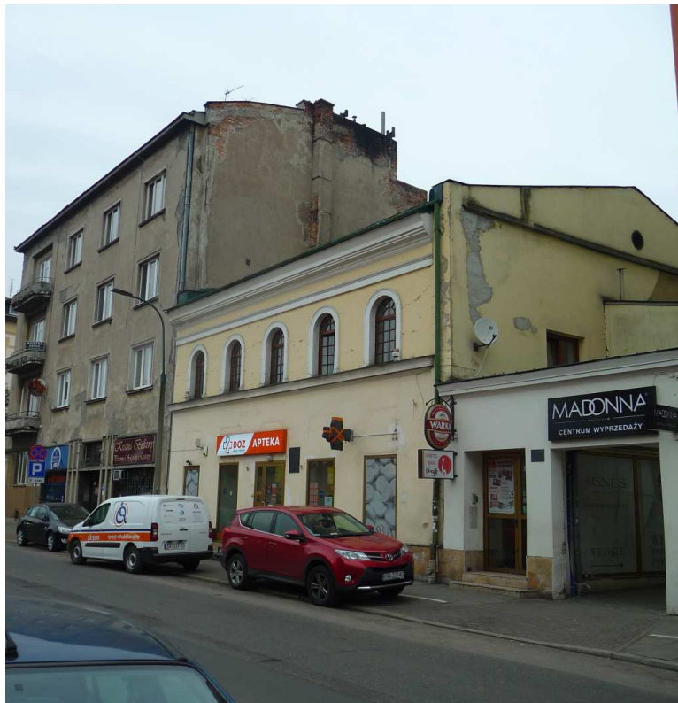
Fot. nr 8 (8-9). Budynek dawnego zakładu przemysłowego Marcina Petreseima pod nr 31, gdzie od I kwarty XX wieku okresie mieścił się Teatr Ludowy. Pod koniec XIX wieku zakład został przeniesiony na Grzegórzki w rejon ulicy Żółkiewskiego. (09.11.2017)
