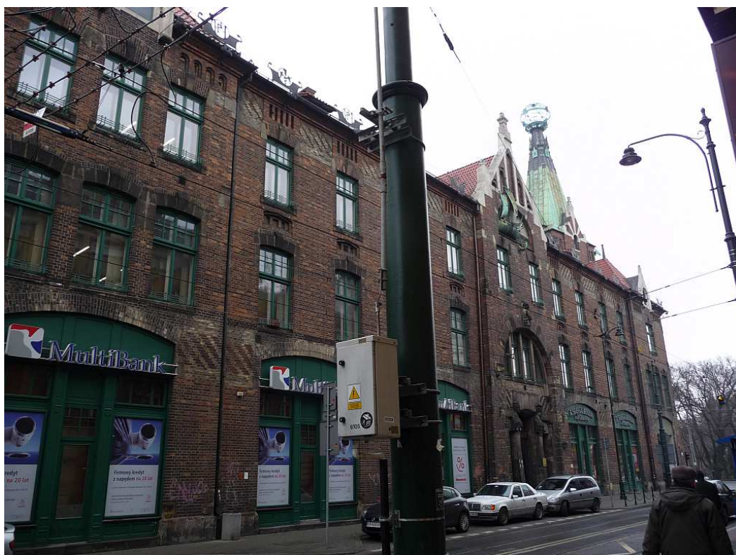
Fot. nr 28. Fasada tego secesyjnego gmachu od strony ulicy Długiej. (02.03.2012)
