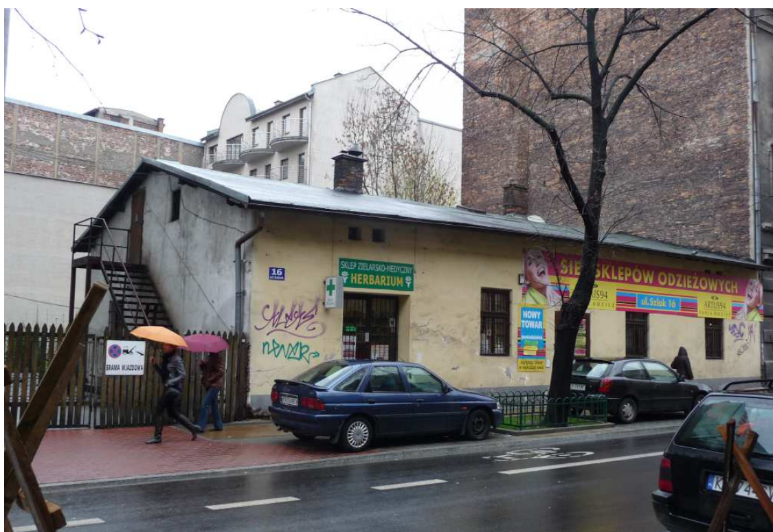
Fot. nr 17. Parterowy dom spod nr 16. (16.04.2012)
