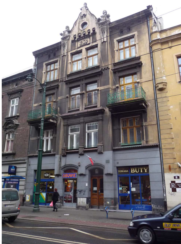
Fot. nr 31 (31-32). Secesyjna kamienica pod nr 6, wybudowana w roku 1908. Elewacja frontowa jest autorstwa Romana Bandurskiego. (02.03.2012)
