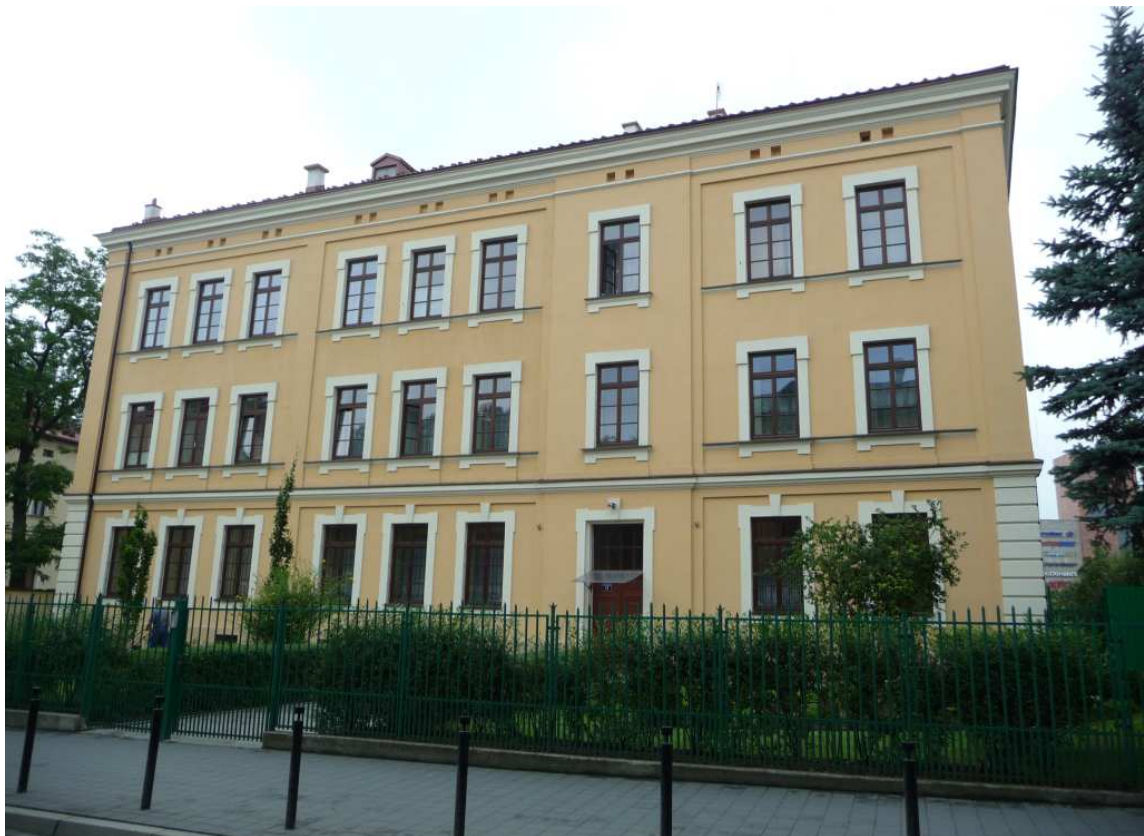
Fot. nr 180. Fasada kamienicy z oknami o ośmiopółowych podziałach. (21.07.2012)
