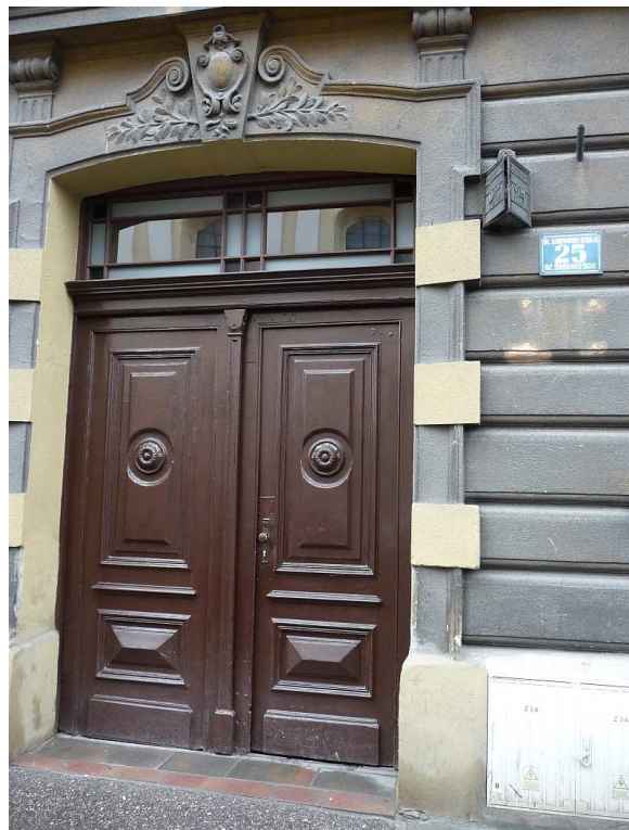
Fot. nr 4 (4-7). Przykłady kilku drzwi wejściowych i portali kamienic z przełomu XIX i XX wieku. Tu kamienica z końca XIX wieku spod nr 25. (16.04.2012)
