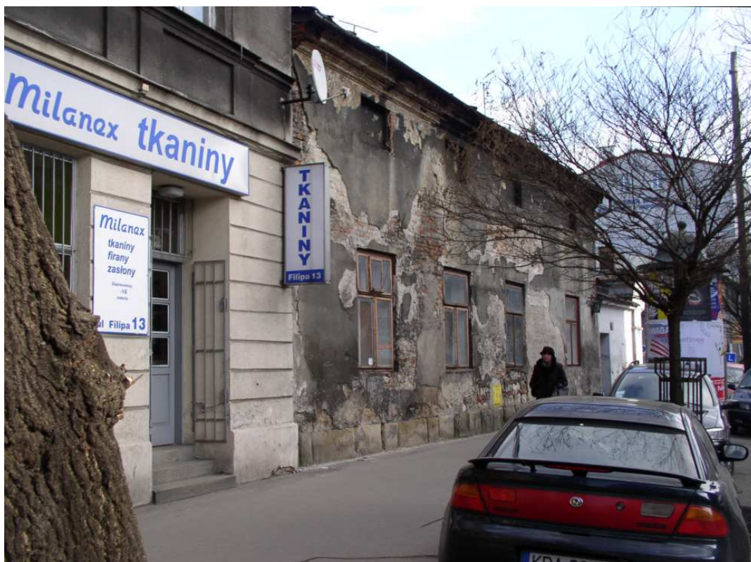
Fot. nr 81 (81-85). Zapewne XIX-wieczny dom spod nr 15 w oryginale sprzed wyburzenia. (09.02.2011)
