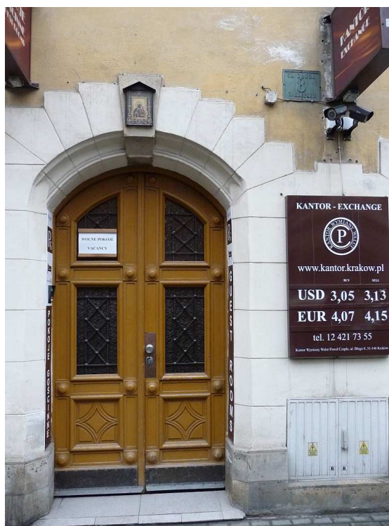
Fot. nr 34. Drzwi kamienicy spod nr 8, która powstała w roku 1907 wg projektu Józefa Pokutyńskiego. (02.03.2012)
