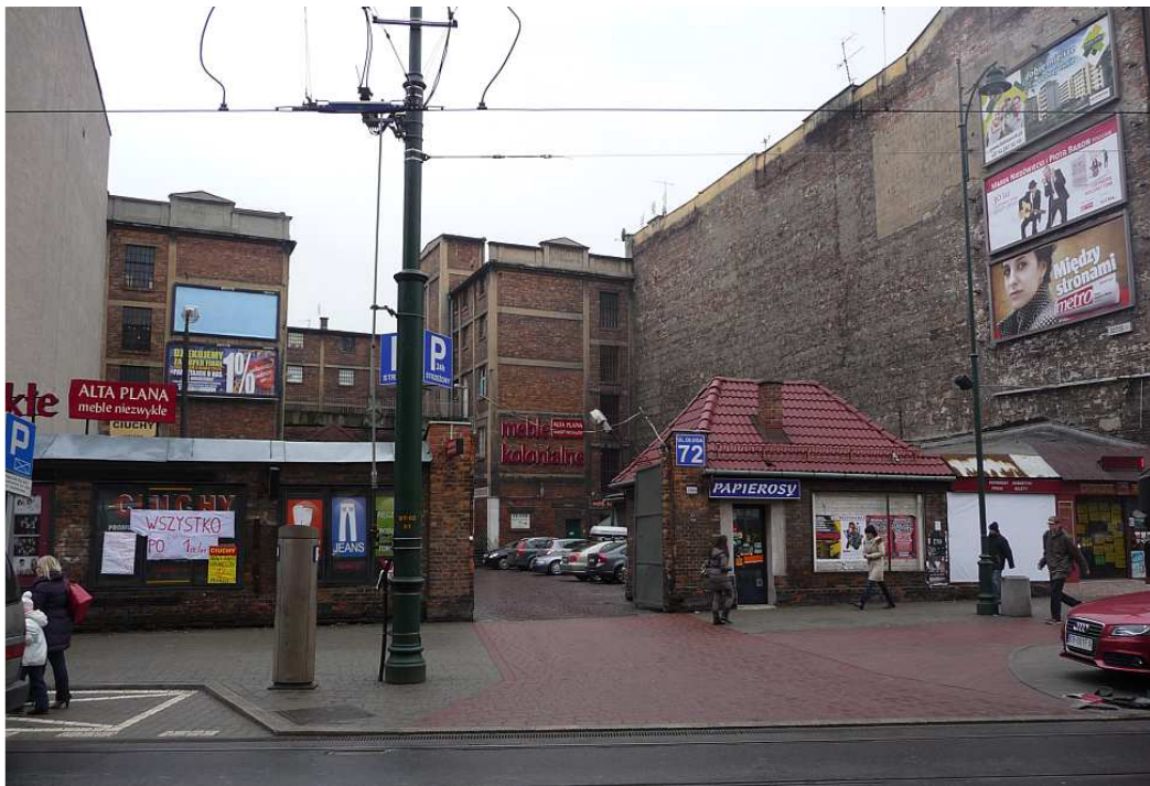
Fot. nr 64. Zespół dawnego magazynu Domu Spedycyjno-Handlowego firmy C. Hartwig z Poznania, który powstał w latach 1920-23 wg projektu Ludwika Wojtyczki. (02.03.2012)
