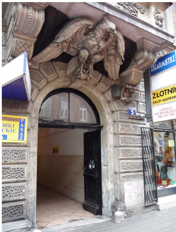
Fot. nr 41. Orzeł w zwieńczeniu portalu kamienicy. (02.03.2012)
