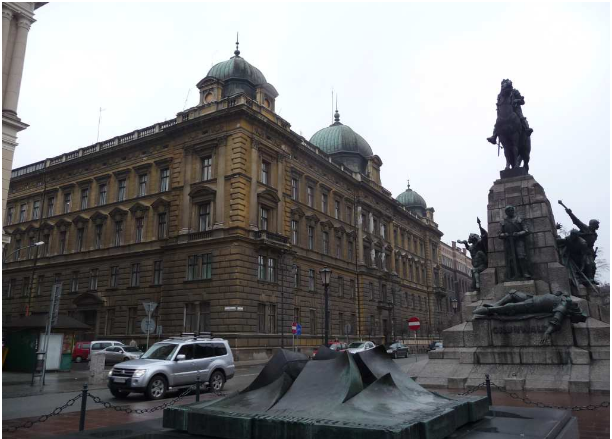
Fot. nr 158. Gmach Dyrekcji Kolei Państwowych spod nr 12. Ten eklektyczny obiekt powstał w latach 1889-89 wg projektu nieznanego wiedeńskiego architekta. (02.03.2012)
