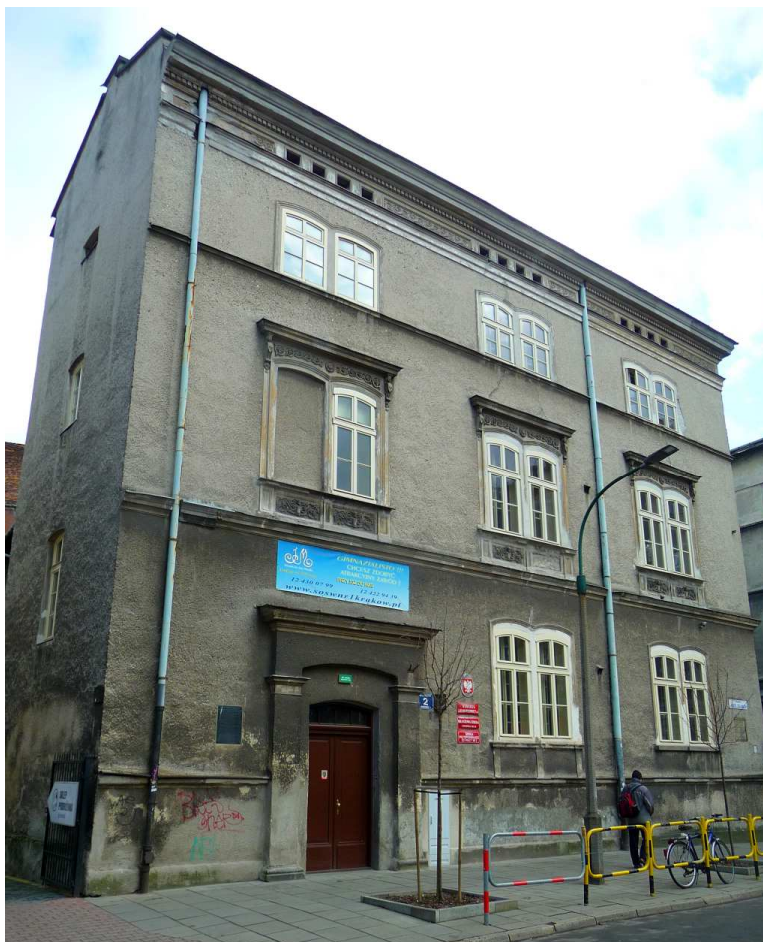
Fot. nr 28. Fasada budynku szkolnego. (05.02.1018)
