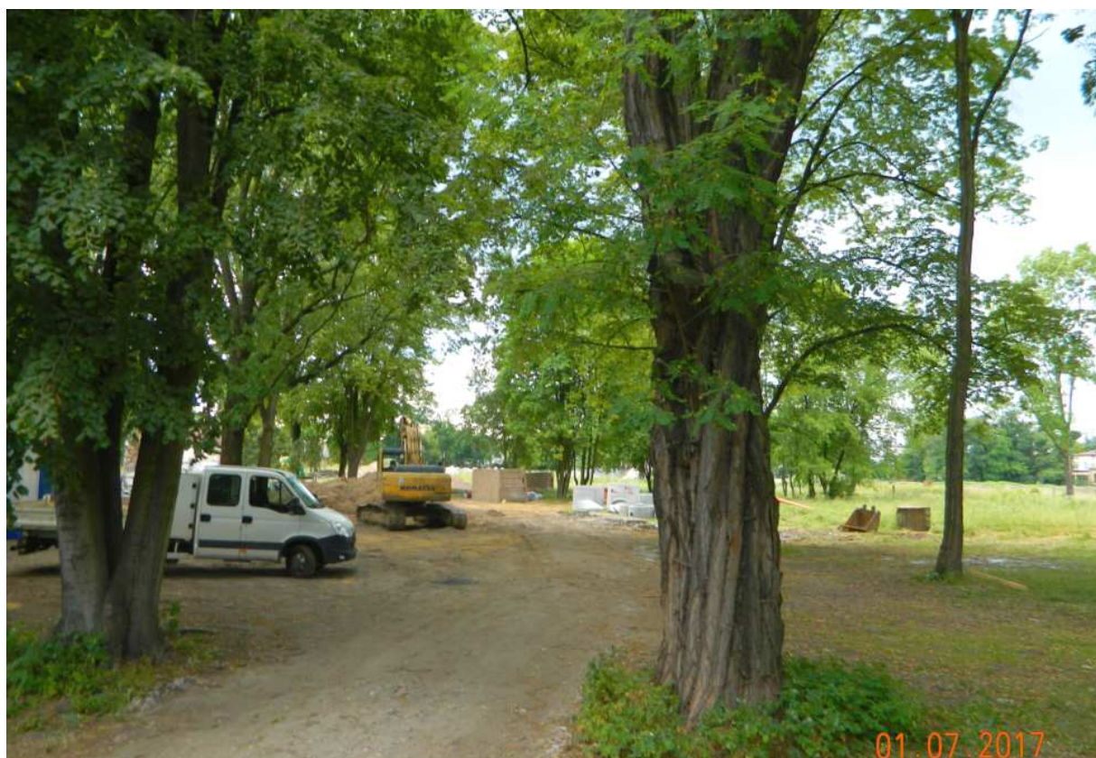
Fot. nr 89 (89-97). Plac budowy kompleksu rekreacyjnego Comarchu, który powstaje w miejscu zespołu trzech basenów Cracovii. Czy i tu (przy okazji) nie powstanie jakieś blokowisko mieszkalne? Fot. nr 89-90 – ujęcia od strony dawnego stadionu I.a.
