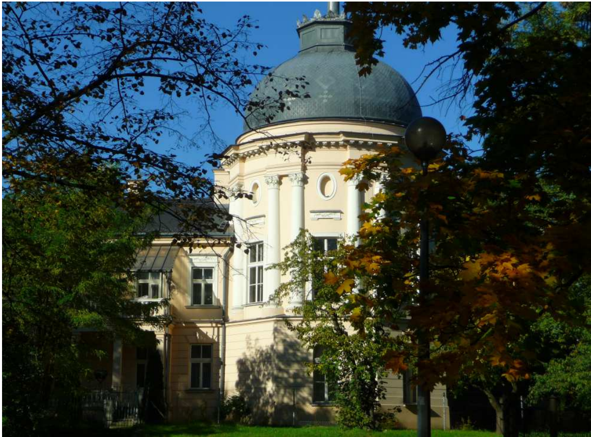
Fot. nr 228. Wieża mieszkalna pałacu. (16.10.2017)
