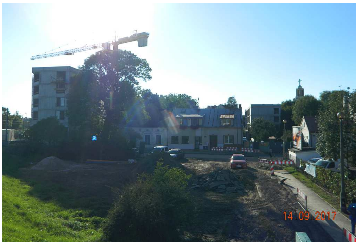
Fot. nr 130 (130-132). Zaciska się betonowy pieścień w końcowym odcinku ulicy Kilińskiego, która swą niską zabudową dobrze oddawała podmiejski klimat Dębna.
