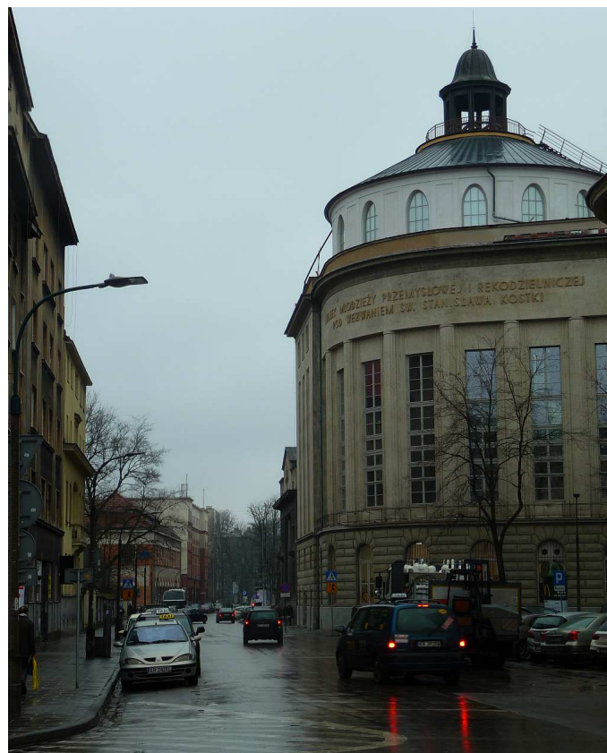
Fot. nr 43. Świeżo odnowiony budynek dawnej bursy księdza Kuznowicza. (12.01.2018)
