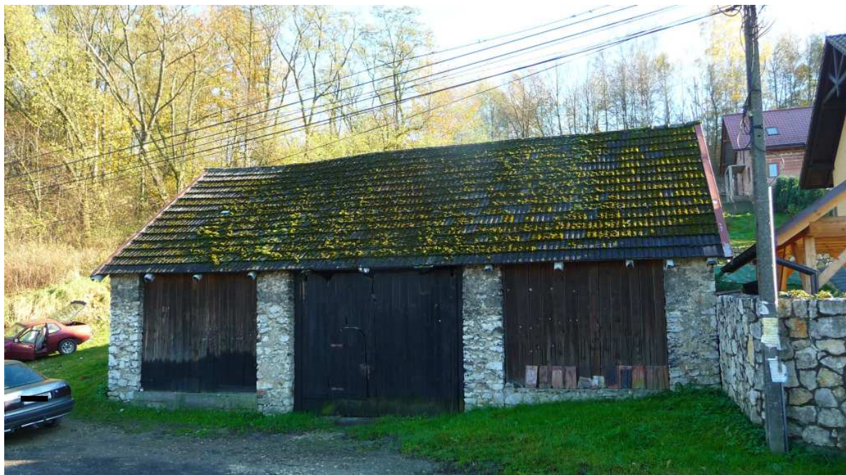
Fot. nr 160. Widok z ulicy. (04.11.2017)
