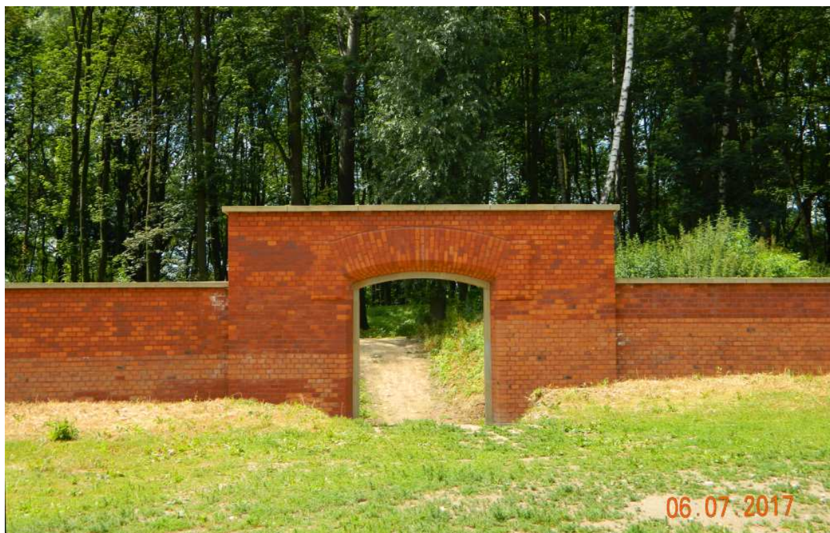
Fot. nr 105. Wspomnienie bramy wiodącej do bastionu nr I, który został całkowicie splantowany po II wojnie światowej.
