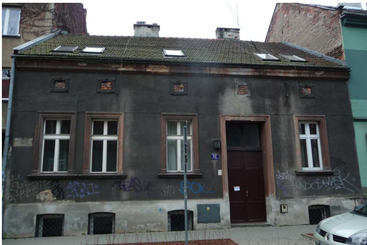
Fot. nr 138. Parterowy dom podmiejski, który zachował się przy ulicy Barskiej 37. (14.12.2017)
