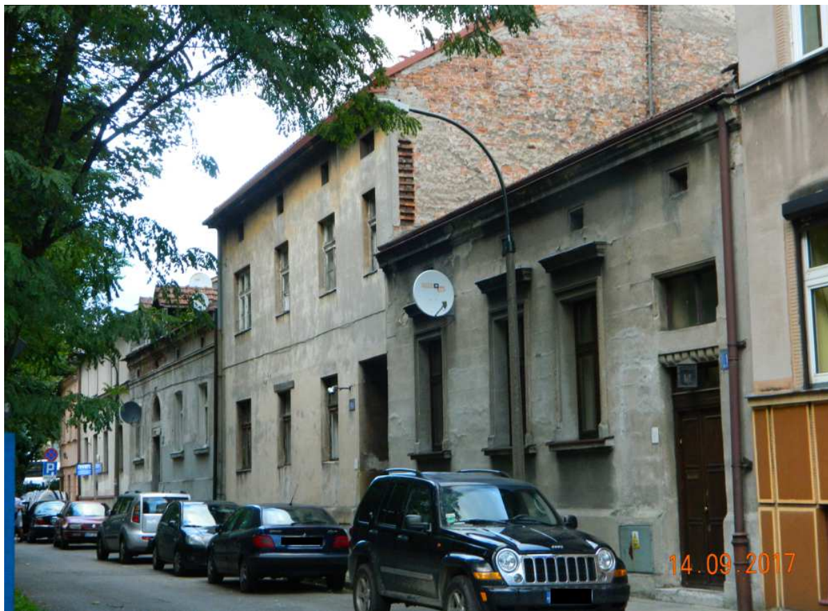
Fot. nr 140. Zabudowa ulicy Zduńskiej o nr: 6-14, która powstała na przełomie XIX i XX wieku. Jak długo przetrwa jej niska zabudowa?
