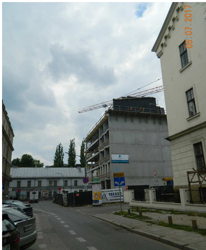
Fot. nr 56. Końcowy fragment ulicy Rajskiej z nowym, pięciopiętrowym „mrówkowcem” w narożu z ulicą Dolnych Młynów. Betonowania Krakowa ciąg dalszy.
