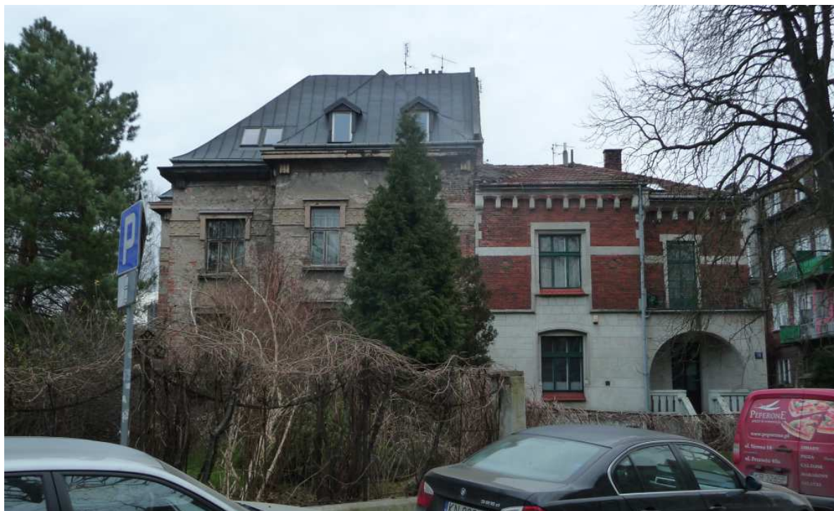
Fot. nr 139. Eklektyczna willa aptekarza Mieczysława Masłowskiego z ulicy Barskiej 26, wybudowana wg projektu Romana Bandurskiego, a z lewej secesyjna willa Władysława Zapałowicza, inspektora c.k. kolei z ulicy Barskiej 24, powstała w 1909 roku wg projektu Romana Bandurskiego. (14.12.2017)
