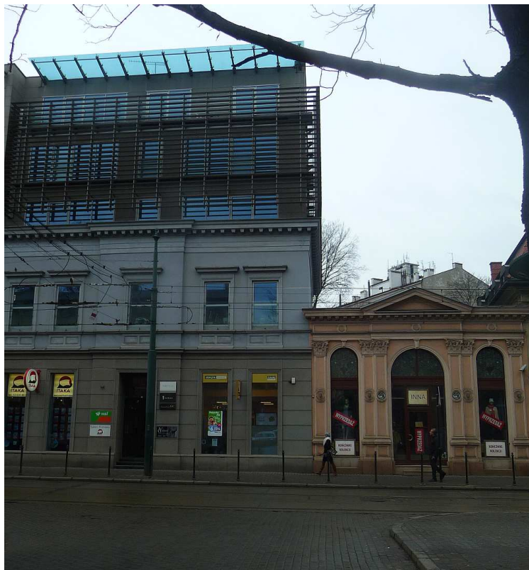
Fot. nr 60. Zespół dawnego zakładu opiekuńczego dla sierot fundacji Piotra Michałowskiego pod nr: 66 i 66a. Jednopiętrowa kiedyś bryła budynku spod nr 66, pochodzącego z roku 1821, została zniszczona nadbudową z lat 90-tych zeszłego wieku; zachowała się tylko parterowa oranżeria, która powstała w roku 1848. (29.01.2018)
