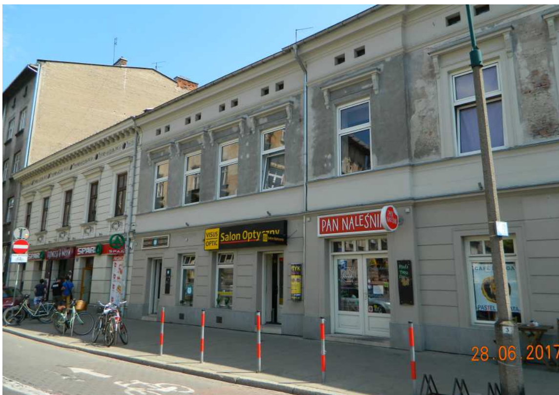
Fot. nr 50 (50-51). Niska zabudowa pod nr 3 i 5, pochodząca z I połowy XIX wieku.
