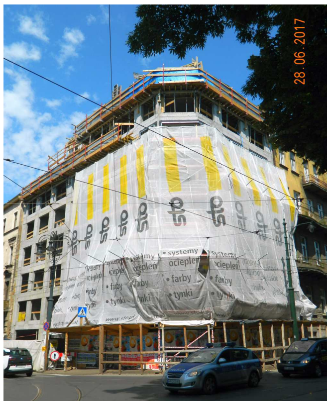
Fot. nr 13 (13-14). Betonowy szkielet przewymiarowanej kamienicy z naroża ulic: Piłsudskiego 1 i Straszewskiego 24, która powstała w miejscu piętrowego budynku dawnej „Barcelony”. W okresie międzywojennym funkcjonował tam szynk Goldmana.
