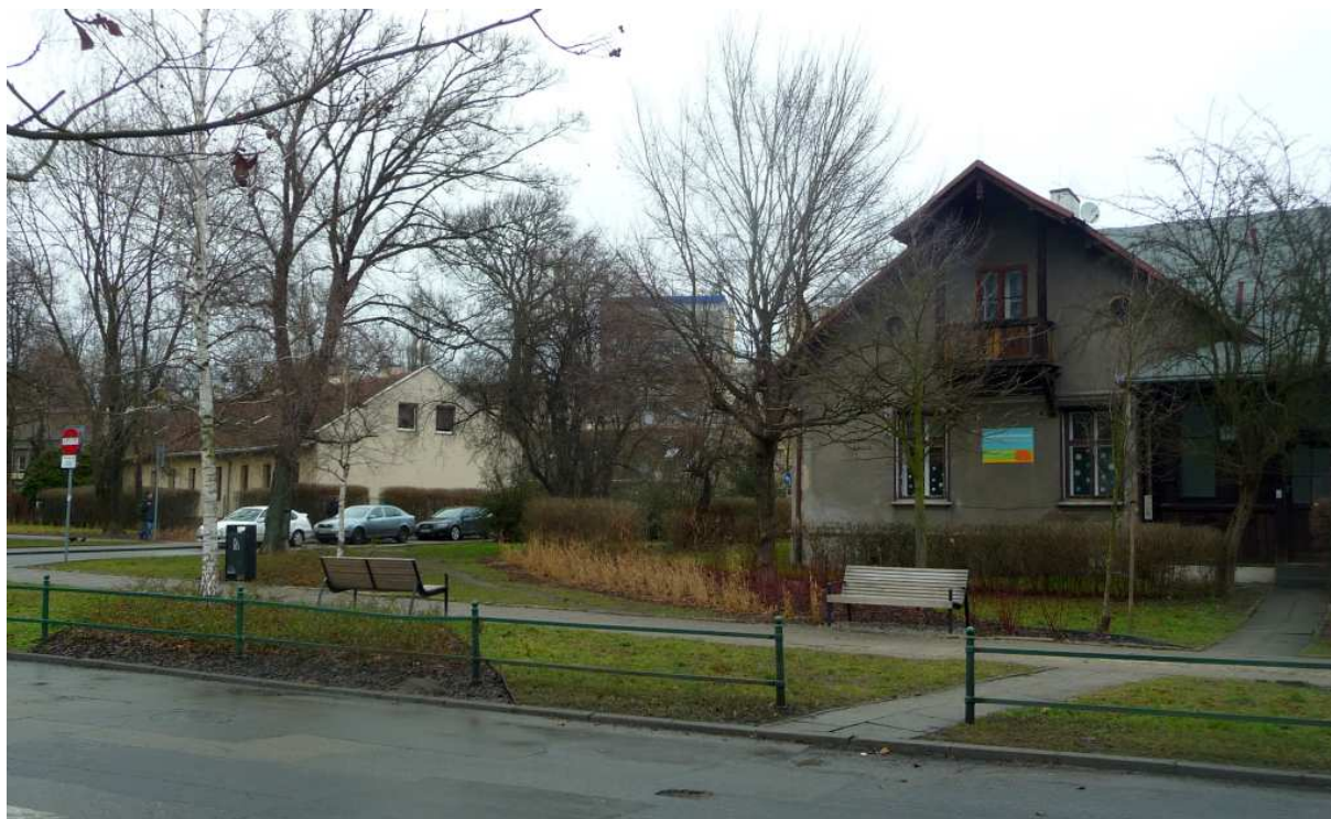
Fot. nr 81. Parterowy dom z drugiej części osiedla robotniczego „Modrzejówka”, usytuowany we fragmencie ulicy Sienkiewicza pod nr 30 (z lewej). A z prawej mocno zniszczona stolarka ganku i więźby dachowej willi. (29.01.2018)
