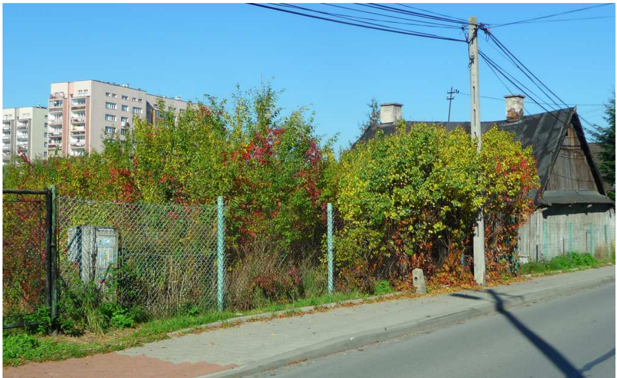
Fot. nr 231. Ruina chałupy przy ulicy Ściegiennego 12. Świat przedwojennego Prokocimia, który został włączony w obręb Krakowa w roku 1941, szybko odchodzi. (16.10.2017)
