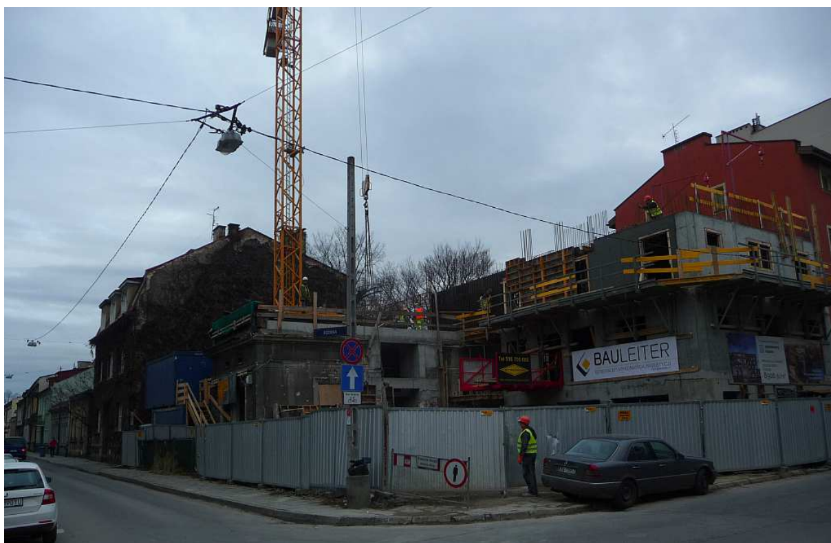
Fot. nr 143. Co powstanie w miejscu 1-piętrowego domu z ul. Różanej 20? (14.12.2017)
