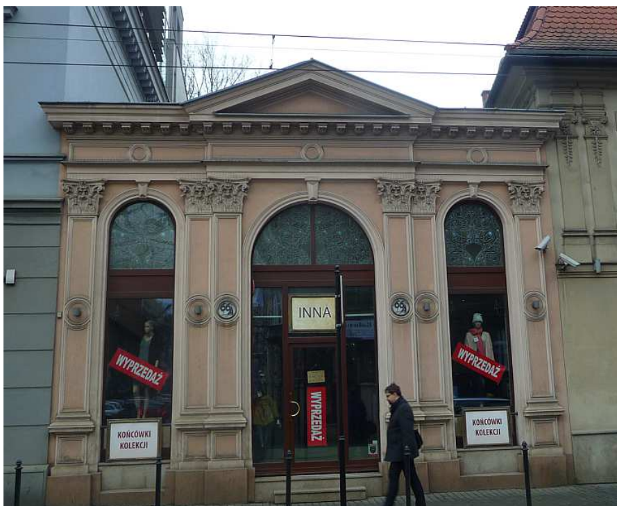
Fot. nr 61. Ciekawa fasada budynku dawnej oranżerii, który jest wpisana do rejestru zabytków. Można zadać pytanie po co na tej liście figuruje sąsiedni budynek spod nr 66, skoro jego fasada uległa ewidentnemu zniszczeniu i szpetnej nadbudowie. (29.01.2018)
