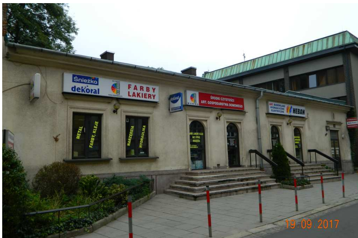
Fot. nr 73. Mocno zniekształcona fasada domu z ulicy Garbarskiej 11, który powstał w okolicy połowy XIX wieku. To cud, że w tym miejscu przetrwał parterowy budynek, bo nie jest on wpisany do rejestru zabytków.
