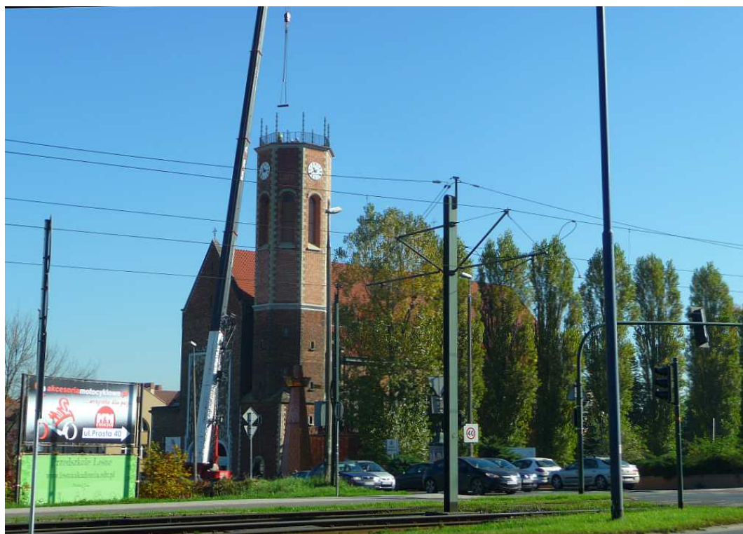
Fot. nr 211 (211-213). Zakładanie metalowego hełmu na dobudowanej niedawno wieży kościoła p.w. Matki Boskiej Dobrej Rady przy ulicy Prostej 35. (16.10.2017)
