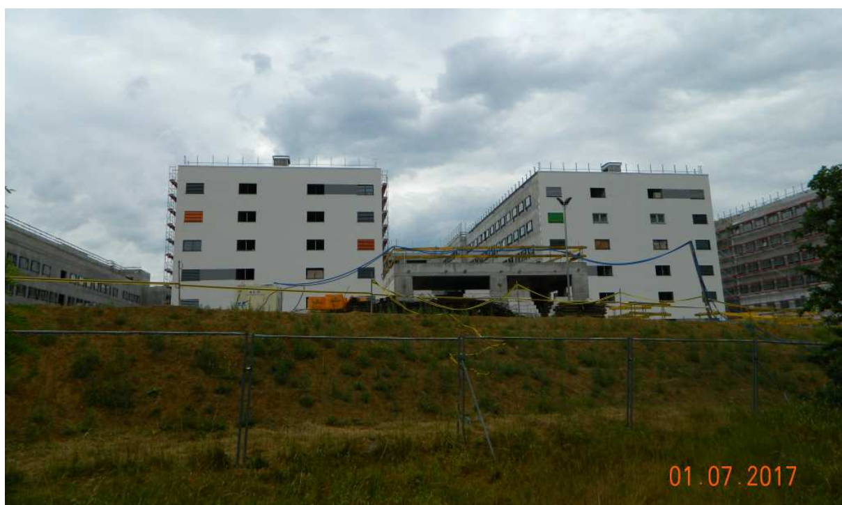
Fot. nr 273 (273-276). Budynki szpitalne w ujęciach od strony ulicy Słona Woda.
