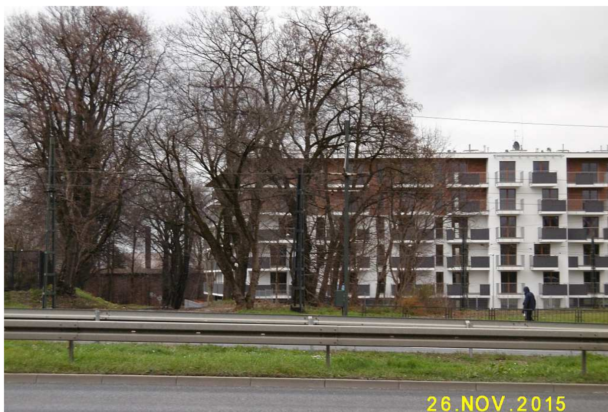
Fot. nr 221. Fragment ulicy Żniwnej, dawnej alei dojazdowej do majątku Jerzmanowskich, na którą wręcz wylewa się kolejne nowe blokowisko, tym razem z ulicy Górników 68-70. „Przy okazji” budowy oczywiście doszło do ubytków w szpalerze alei.
