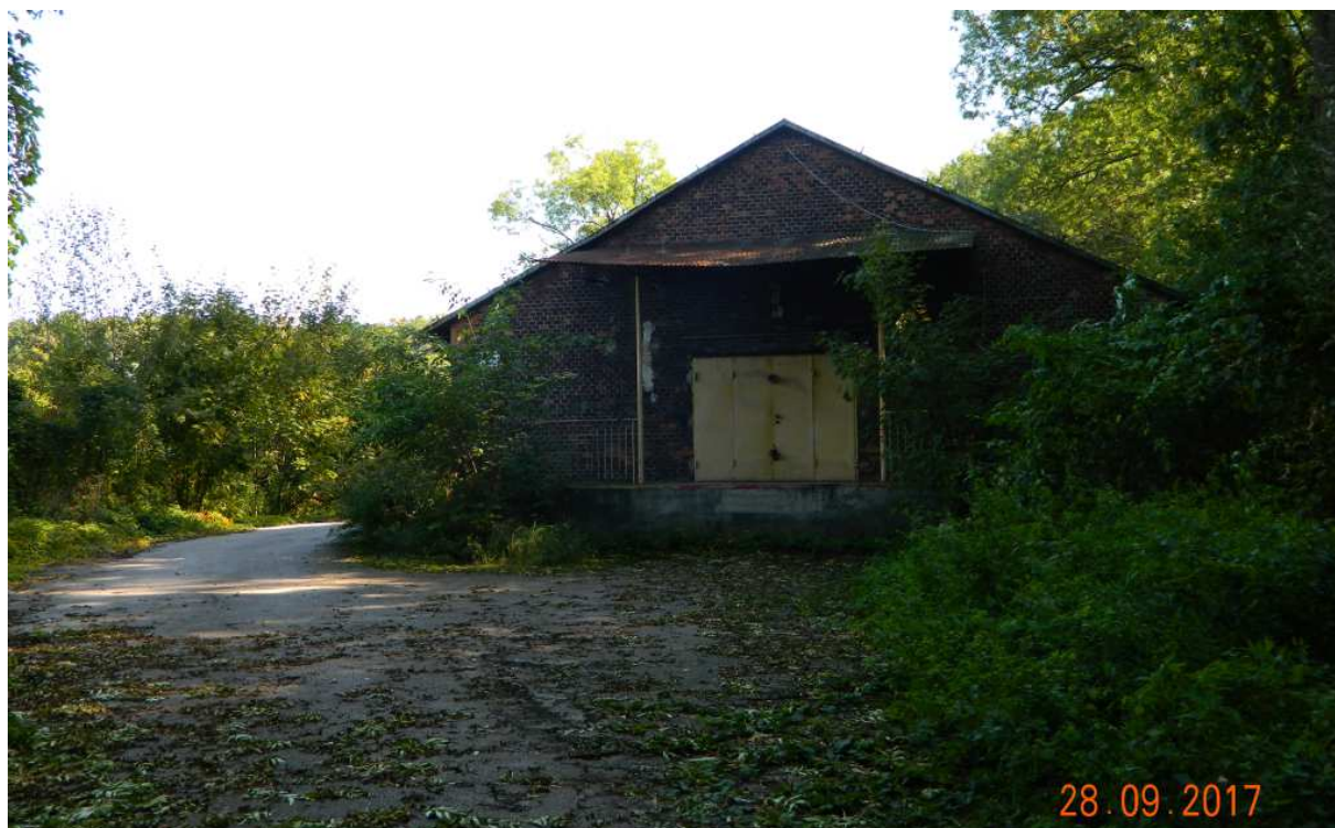
Fot. nr 190 (190-191). Budynek prochowni „Wola Duchacka” z czasów Twierdzy Kraków w bocznym odgałęzieniu od ulicy Kamieńskiego, biegnącym przy torze kolejowym. (22.10.2017)
