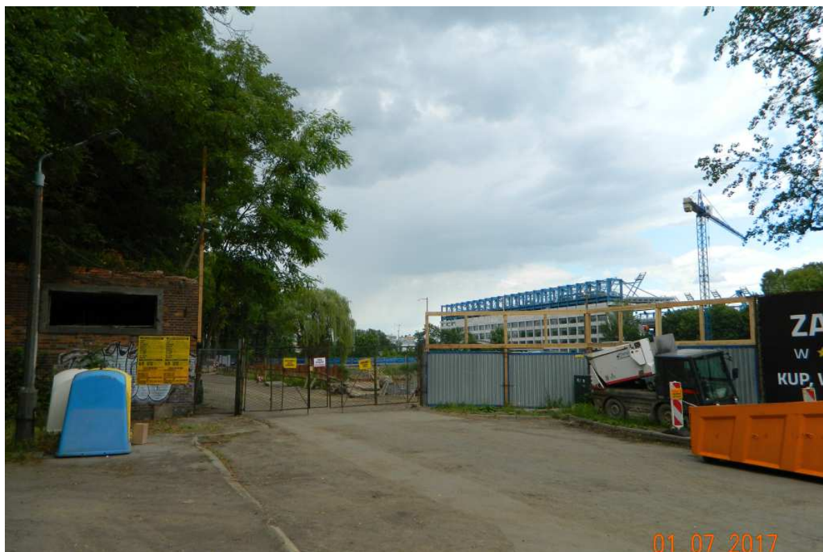
Fot. nr 84 (84-88). Plac budowy „aparthotelu” w miejscu stadionu lekkoatletycznego Cracovii, który „przekształcił się” już w mieszkalny, sześciopiętrowy „Błonia Park”. Kto zezwolił na budowę w tym sportowo-rekreacyjnym kompleksie, na zielonym przedpolu miasta, który przed wojną stworzyli nam przodkowie, takiego mieszkalnego giganta?
