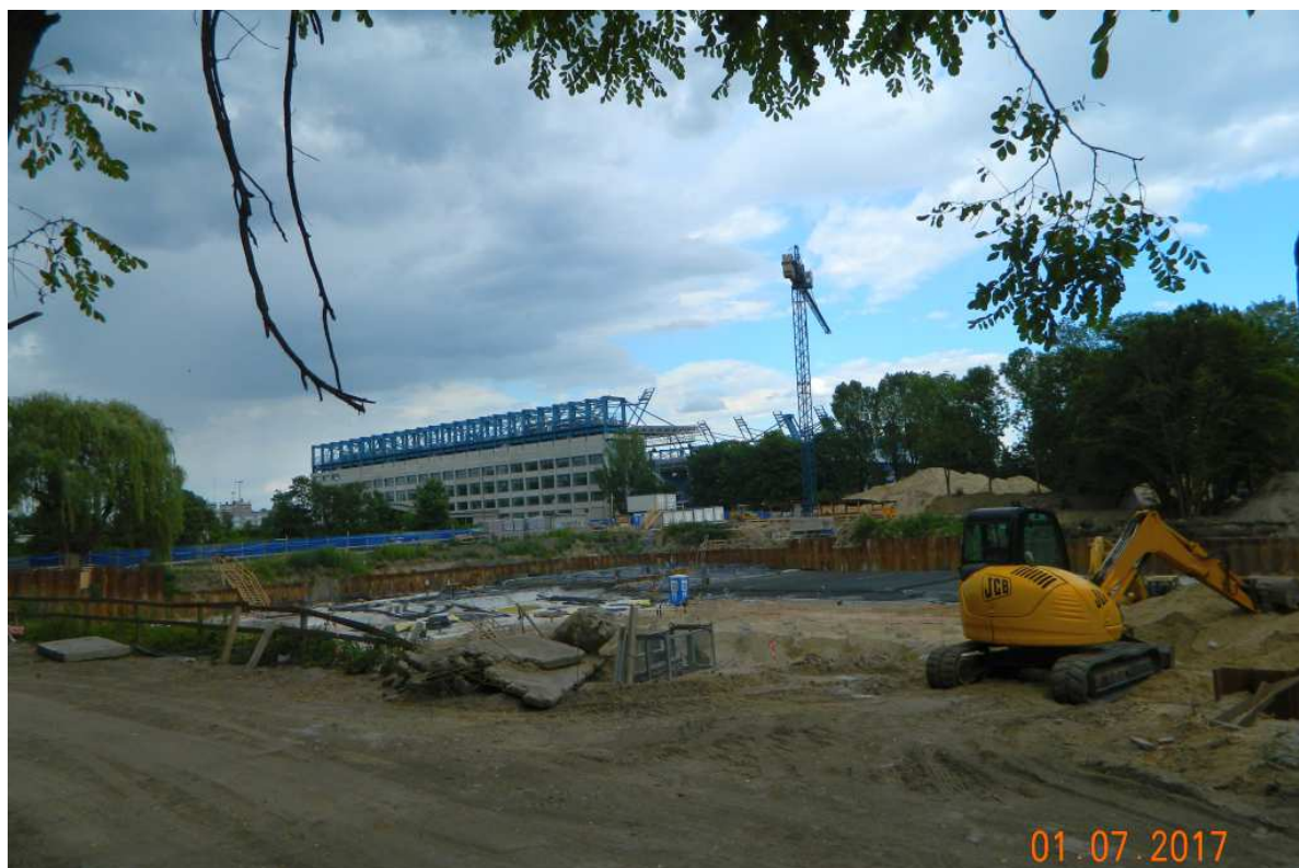
Fot. nr 85 (85-86). Plac budowy w miejscu dawnego stadionu I.a. Ujęcia spod dawnej bramy wejściowej z alei 3-Maja. Co to ma wspólnego z rekreacją?
