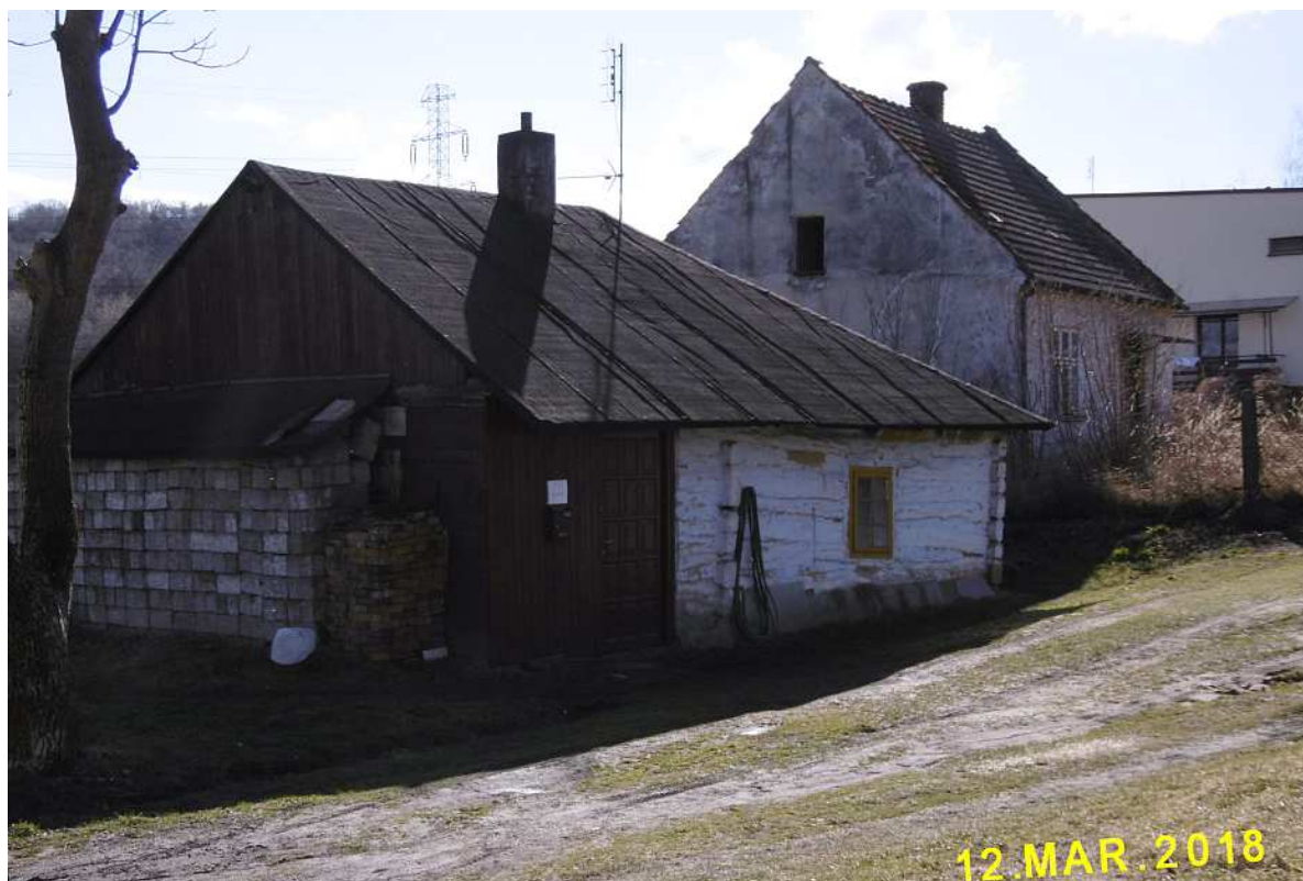
Fot. nr 291 (291-292). Fragment chałupy od strony podwórka. Z prawej strony oryginalny fragment drewnianej faktury ściany domu.
