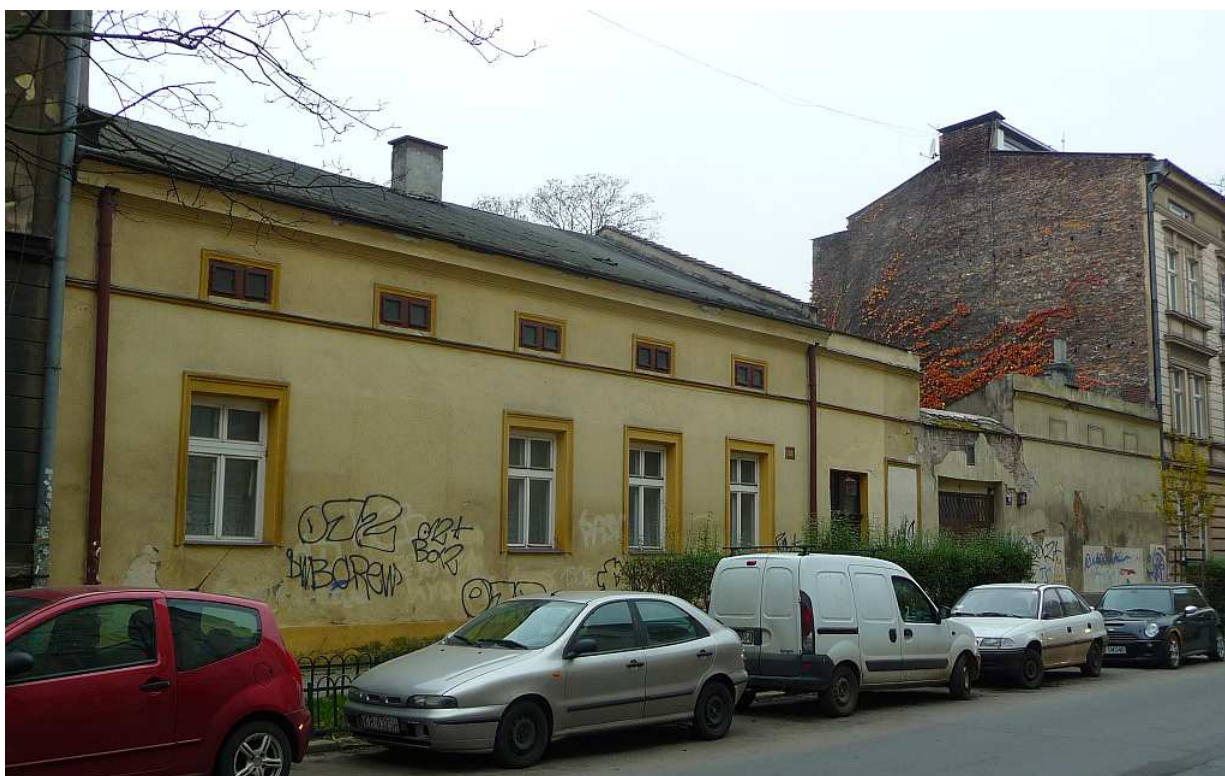
Fot. nr 77. Parterowy budynek dawnego przedszkola zakonnego z ulicy Krowoderskiej 38-40, który powstał w IV ćwierci XIX wieku. Jakimś cudem trwa do dzisiaj, choć też nie jest wpisany do rejestru zabytków. (09.11.2017)
