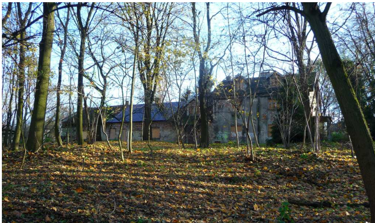
Fot. nr 208. Widok na dwór i wozownię od strony parku i ulicy Malborskiej. (19.11.2017)
