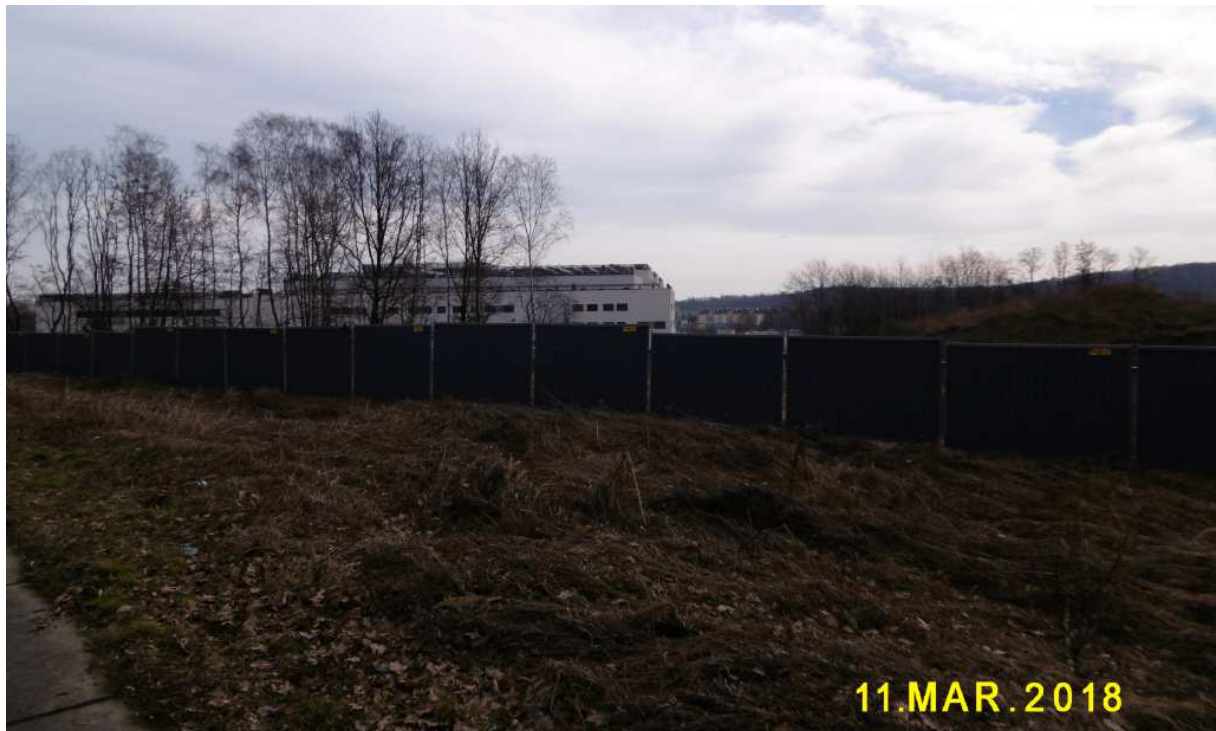
Fot. nr 266 (266-267). Widoki na plac budowy kompleksu szpitalnego UJ w ujęciach z łuku ulicy Kostaneckiego
