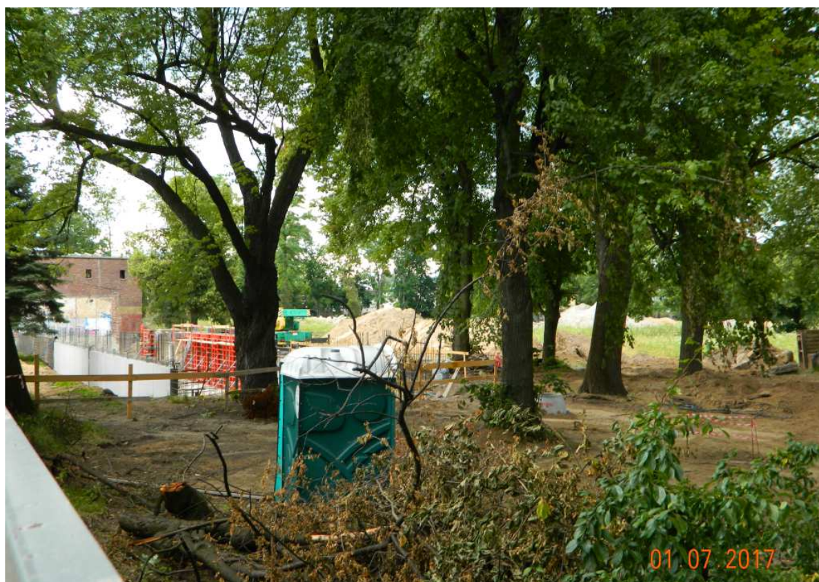
Fot. nr 91 (91-93). Wyburzony, a następnie odtwarzany budynek dawnych szatni.
