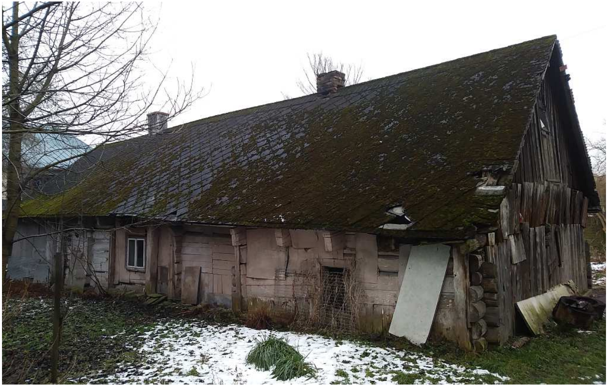
Fot. nr 2 (2-3). Bronowicka chałupa z ulicy Na Błonie 27. Być może jest to najstarszy tego typu obiekt w Krakowie, bo powstał w I poł. XIX wieku. (fot. Małgorzata Mrowiec)
