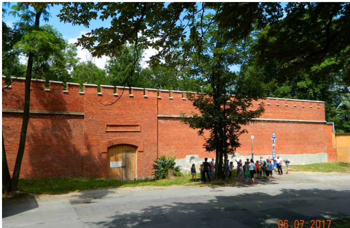
Fot. nr 106 (106-109). Zrekonstruowana ściana wewnętrzna bastionu nr II.
