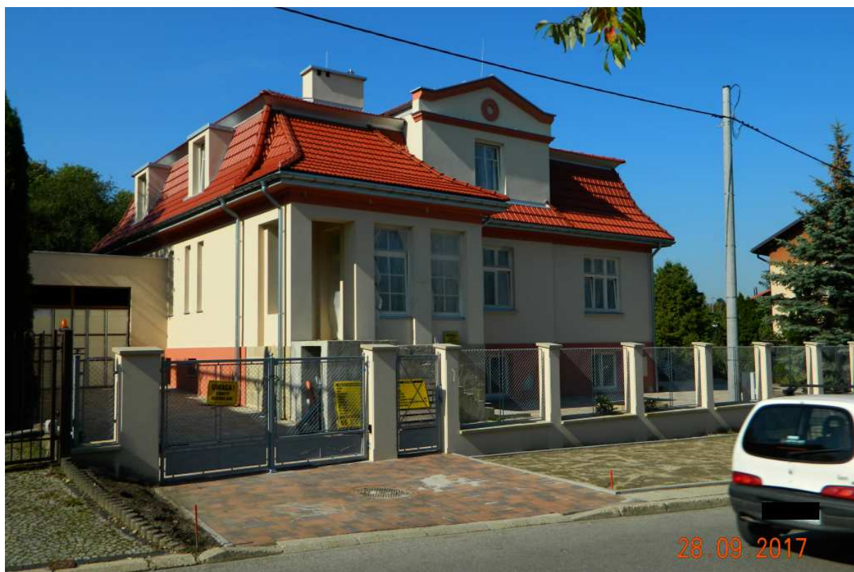
Fot. nr 192 (192-196). Przebudowana na apartamentowce dawna willa Amona Goetha, zbrodniczego komendanta KL Płaszów, z ulicy Heltmana 22.
