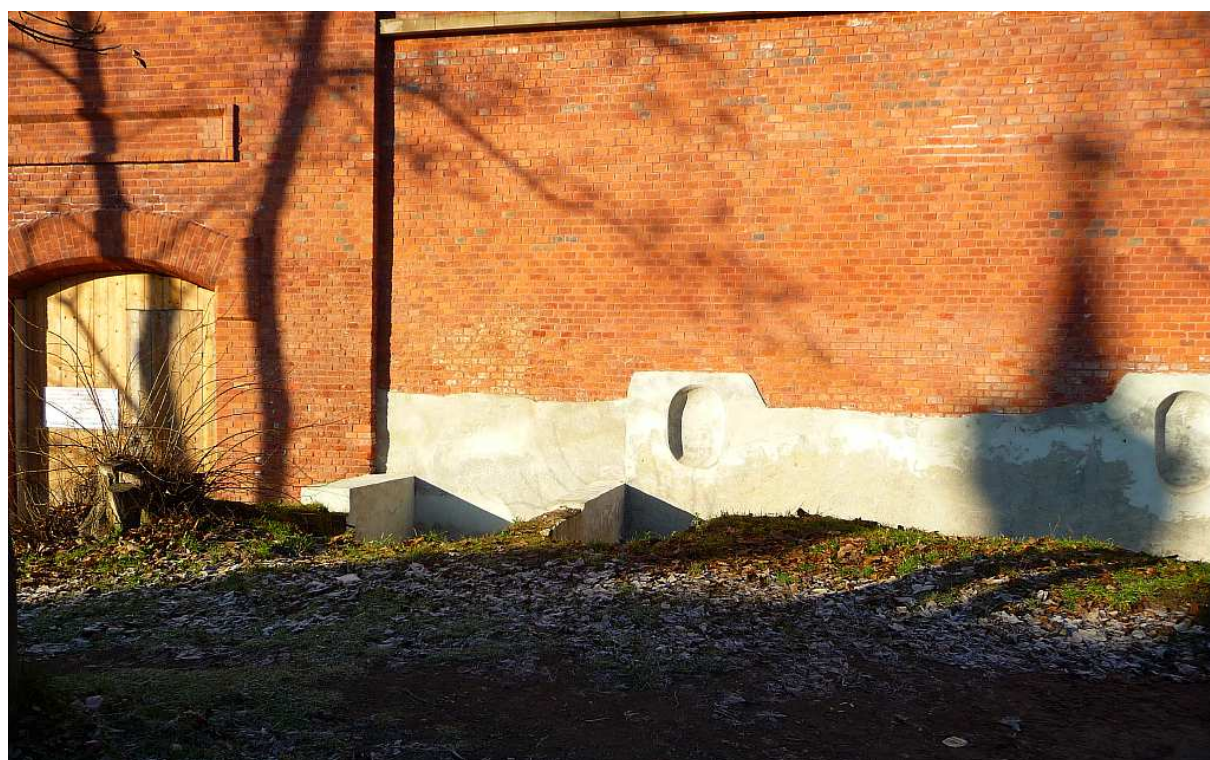
Fot. nr 109. Brama wjazdowa do bastionu nr II i (jak się wydaje) częściowo odtworzone wnęki na poidła dla koni w jego murze. (26.12.2017)
