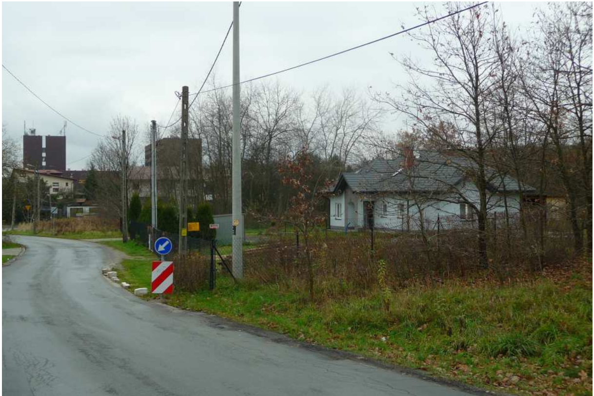
Fot. nr 238. Nowa zabudowa na styku ulic: Obronnej i Kostaneckiego. (18.11.2017)
