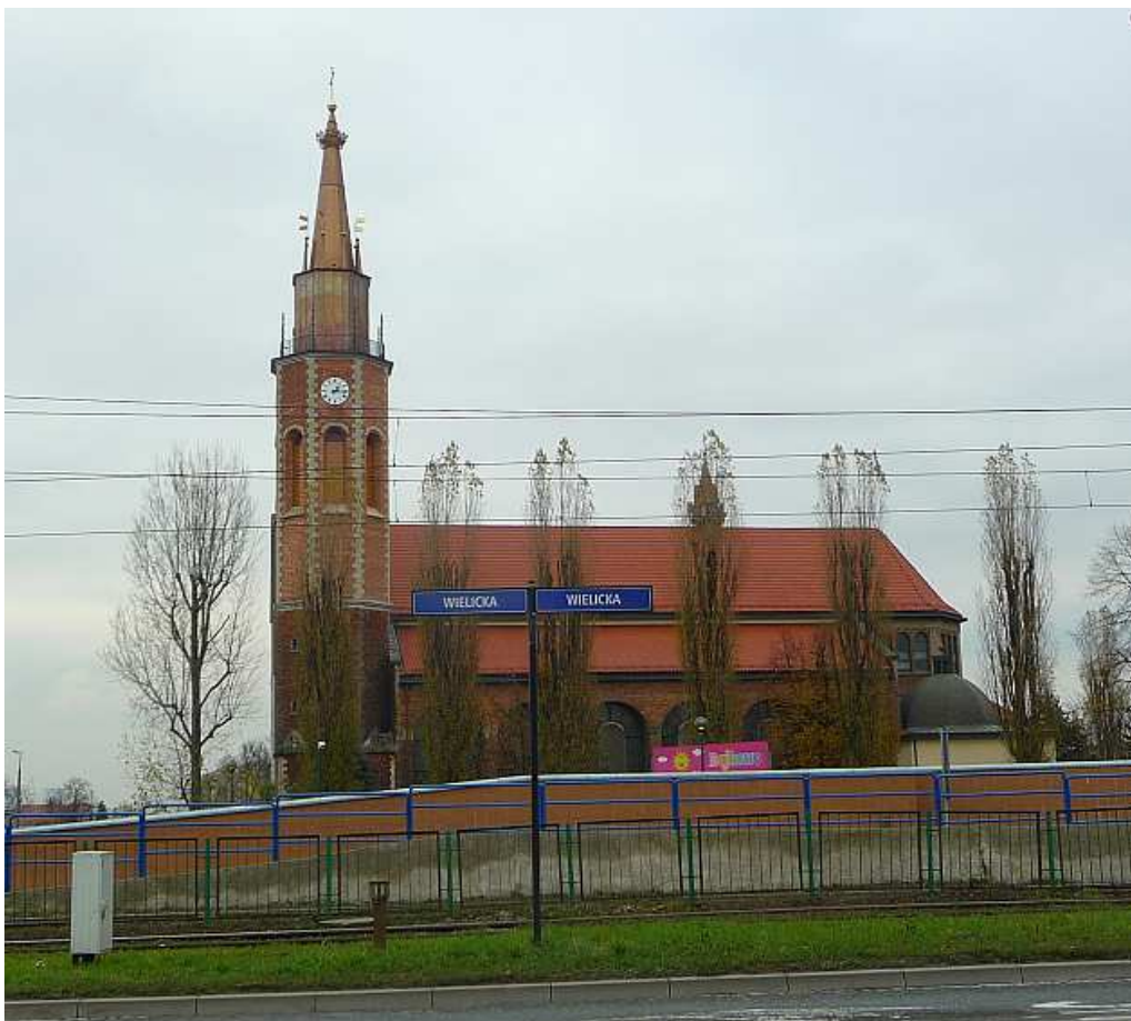
Fot. nr 214 (214-215). Widoki na nową szatę architektoniczną kościoła w ujęciach od strony ulicy Wielickiej. (18.11.2017)
