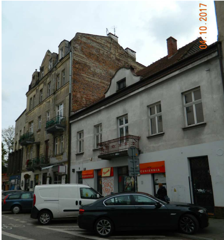
Fot. nr 58. Fragment ulicy o numerach: 20-22. Dom pod nr 22 to jeden z nielicznych już przykładów niskiej zabudowy Piaseku. Powstał w roku 1918.
