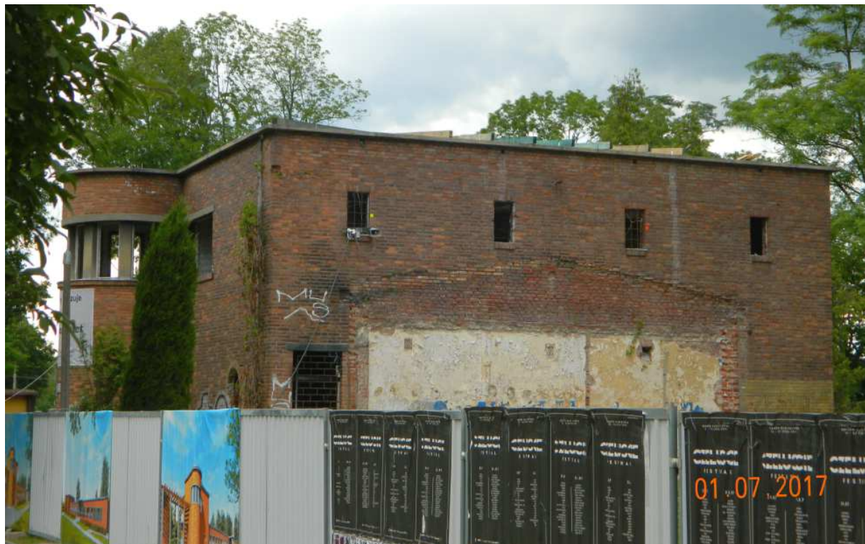
Fot. nr 94 (94-96). Remontowany, dawny budynek mieszkalny przy kompleksie splantowanych dziś basenów.
