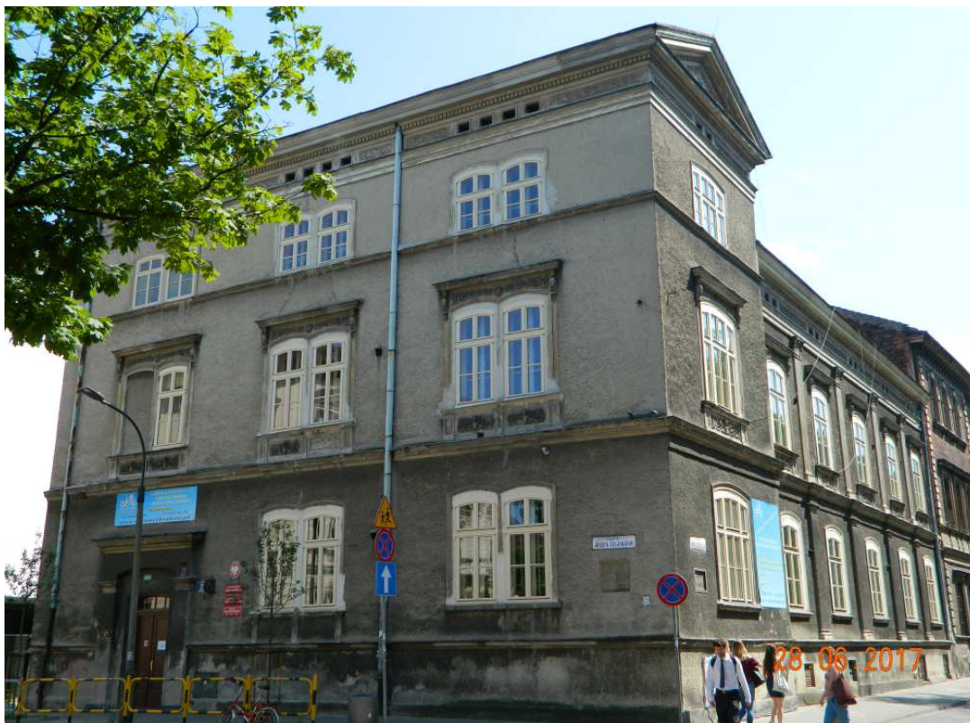
Fot. nr 26 (26-34). Budynek dawnej powszechnej i jego detale. W pierwotnej, niższej wersji front był jednopiętrowy, a fragment od ulicy Krupniczej parterowy. Powstał w tym miejscu w latach 1864-68 wg projektu Józefa Ochmańskiego. Podwyższenie budynku do celów szkolnych nastąpiło ok. roku 1885. Po II wojnie światowej do roku 1968 działała tu SP nr 6. Historia szkoły na tablicy – patrz fot. nr 32.
