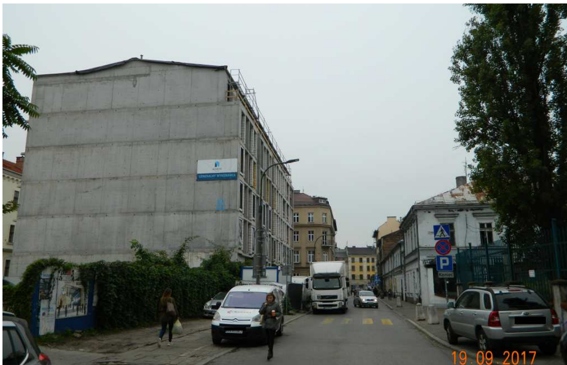
Fot. nr 54. Wzdłuż ulicy Dolnych Młynów – widok w stronę ulicy Krupniczej. Ten nowy, pięciopiętrowy blok betonowy miał stanowić „odtworzenie fragmentu ulicy z początku lat 50.”, kiedy obok stał II-piętrowy budynek mieszkalny, przerobiony z dawnego wojskowego lazaretu. Czy on ma dwa piętra?
