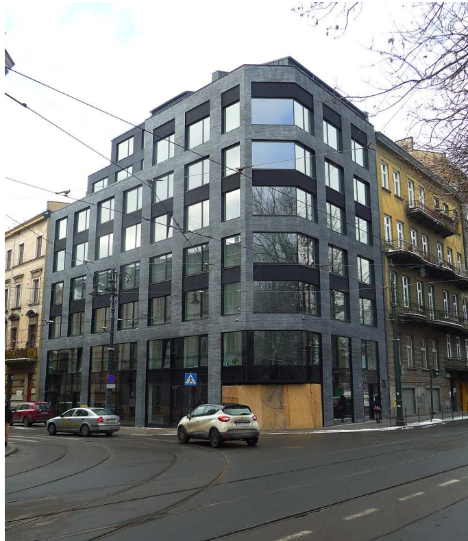
Fot. nr 14. Szklany „kloc” już gotowy. (22.01.2018)
