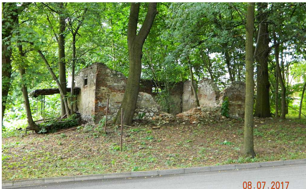
Fot. nr 200. Ruina budynku gospodarczego dawnego dworu Bemów przy ulicy Estońskiej.
