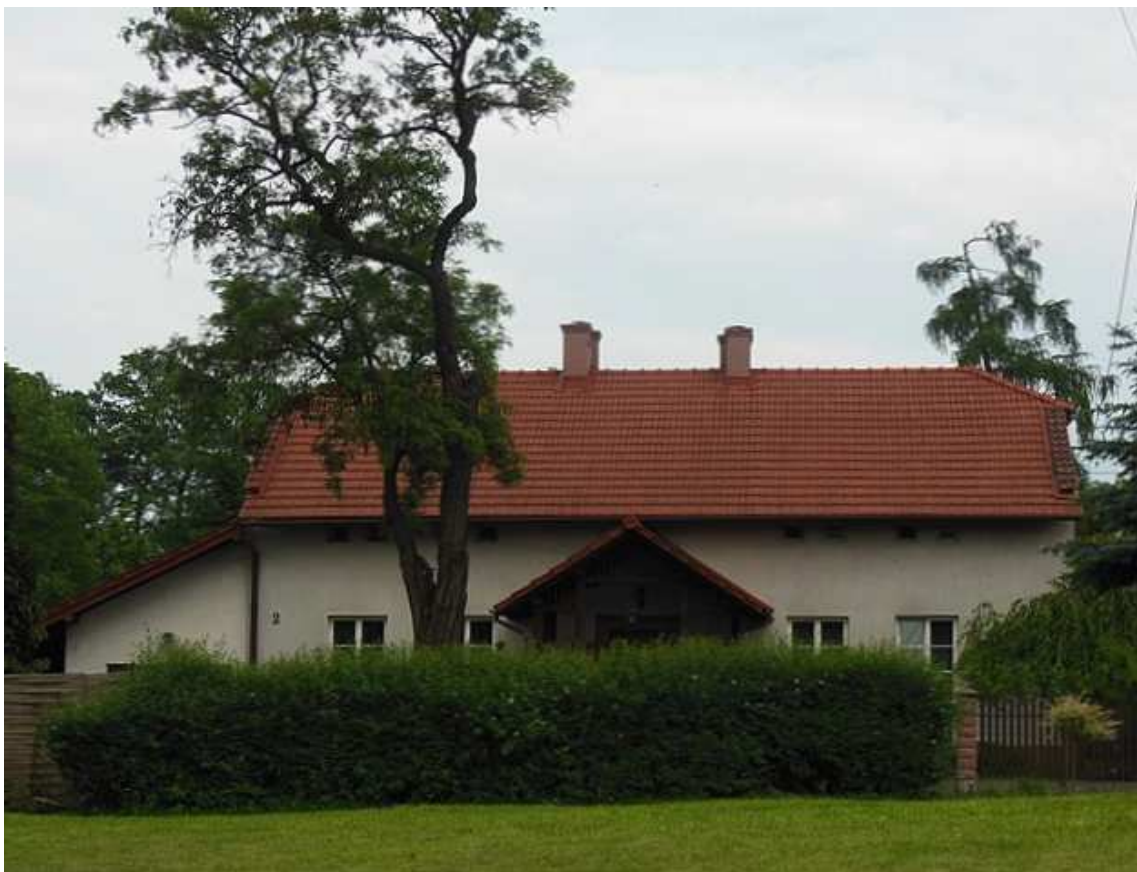
Fot. nr 78. Współczesny widok na dworek przy ulicy Kaczeńcowej 2, który wchodził w skład zespołu dworsko-parkowego, powstałego w drugiej połowie XIX wieku. W obecnej postaci budynek powstał na początku XX wieku. (fot. z Wikipedii).
