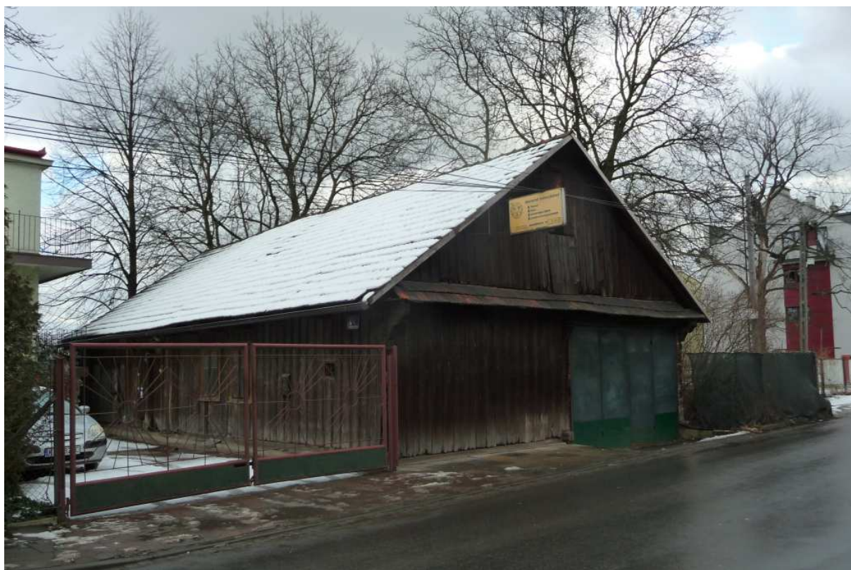
Fot. nr 139 (139-141). Widoki od strony podwórka. (17.01.2018)
