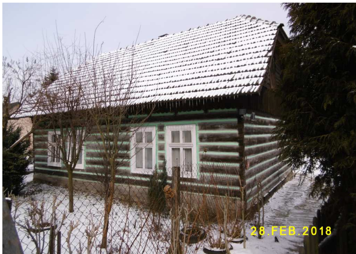
Fot. nr 18 (18-19). Bliska oryginałowi chałupa z ulicy Podrzecze 16, gdzie zachowała się dawna faktura w postaci naprzemiennie malowanego poprzecznego belkowania.
