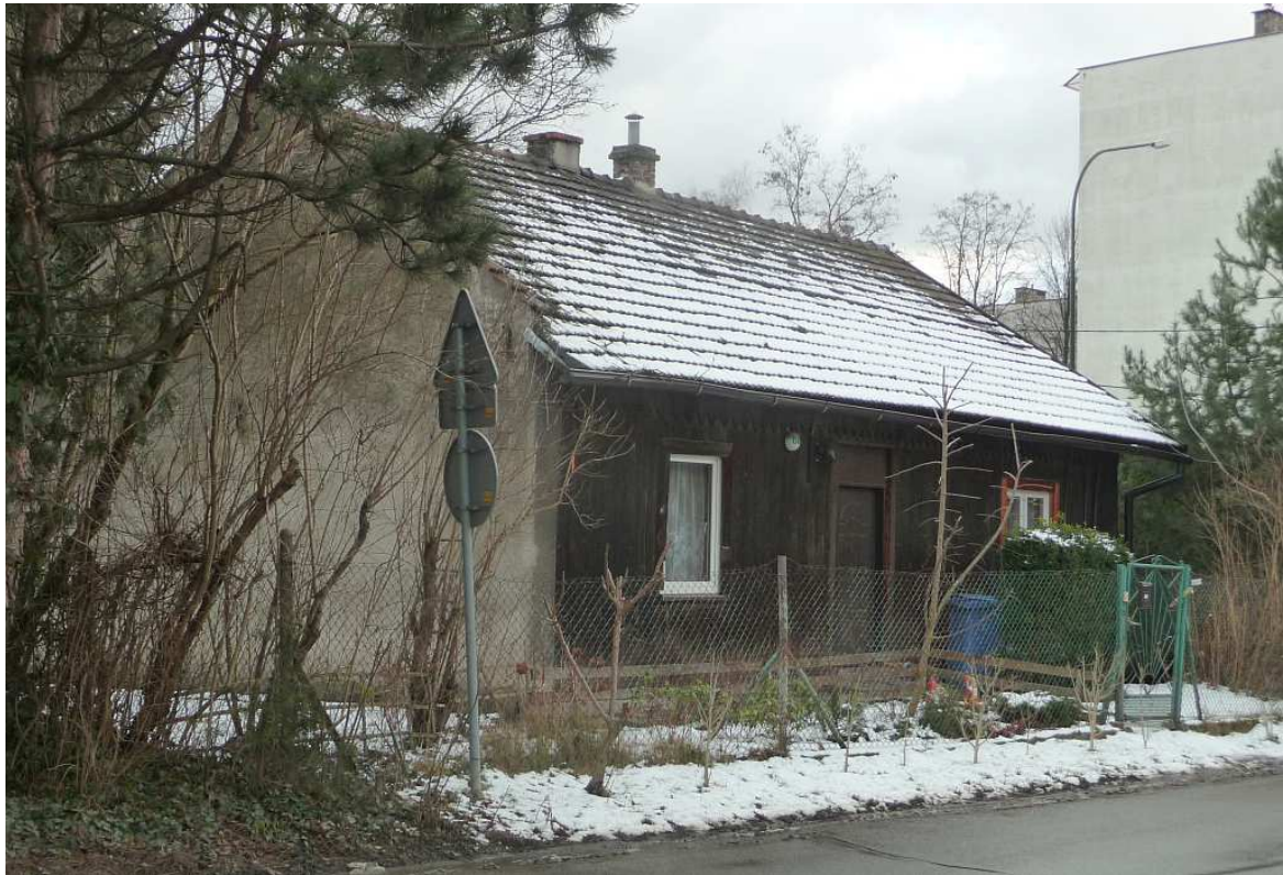
Fot. nr 122. Zniekształcona przez współcześnie wymienione okna fasada domu spod nr 68, który mógł zostać wybudowany na przełomie I i II ćwierci XX wieku. (17.01.2018)
