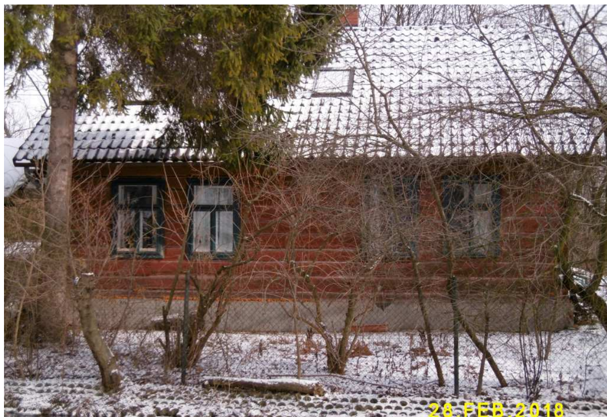
Fot. nr 108 (108-109). Detale fasady.
