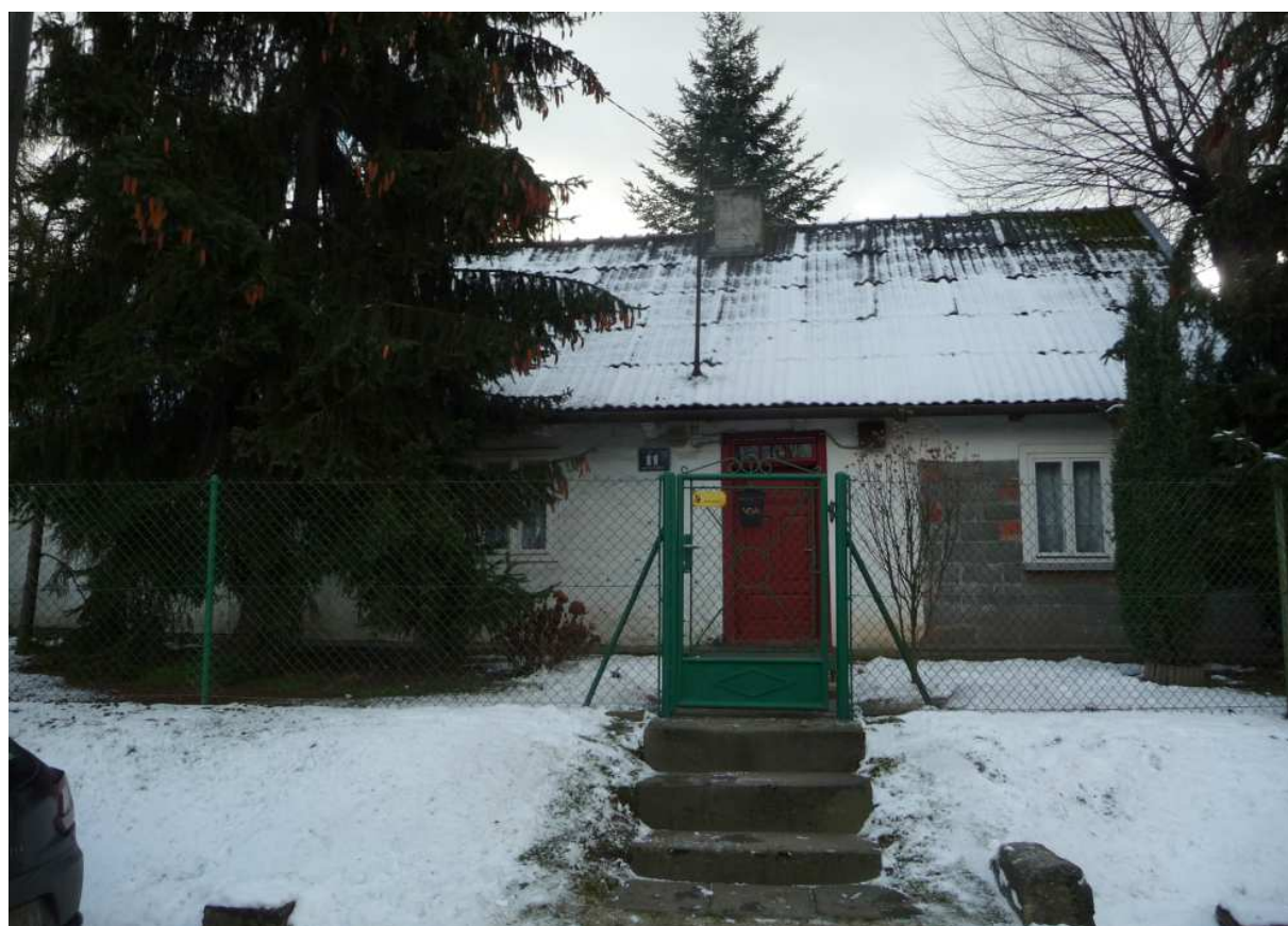
Fot. nr 43 (43-46). Bliska oryginałowi fasada chałupy z ulicy Fatimskiej 11, która powstała w I ćwierci XX wieku. Ujęcia z ulicy Fatimskiej. (17.01.2018)
