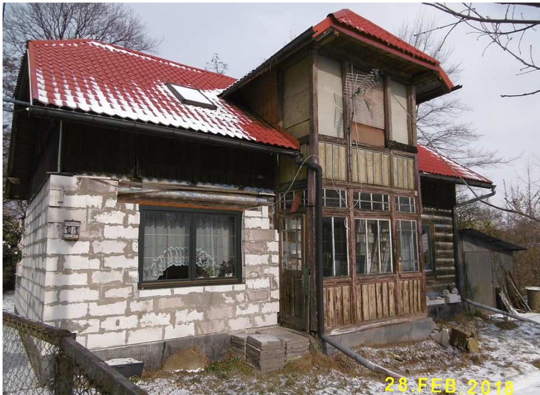
Fot. nr 112 (112-115). Częściowo przebudowana willa z ulicy Kaczeńcowej 10. Prawe skrzydło może pochodzić z wcześniejszej fazy z początku XX wieku. Ganek mógł zostać dobudowany na przełomie I i II ćwierci XX wieku.
