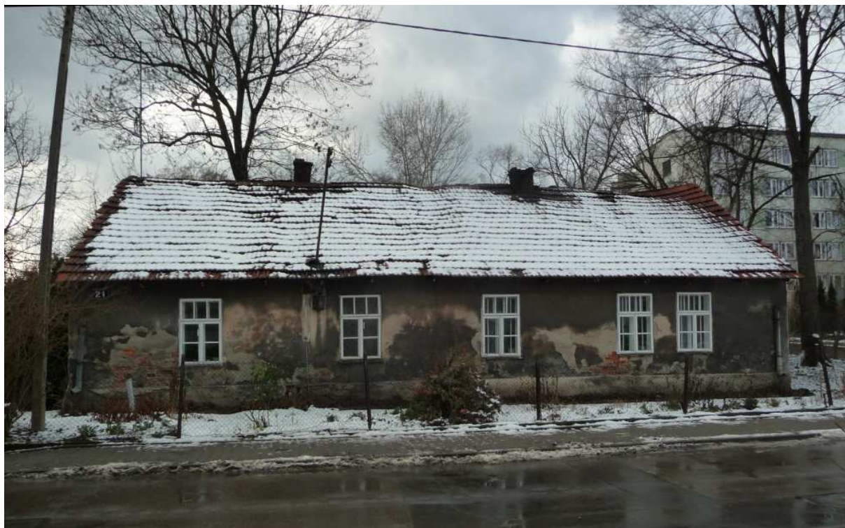
Fot. nr 118 (118-120). Fasada domu i jej oryginalne okna z okresu budowy. (17.01.2018)
