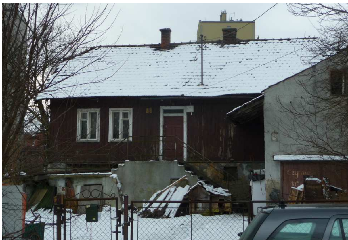
Fot. nr 29. Widok z ulicy Fatimskiej. (17.01.2018)
