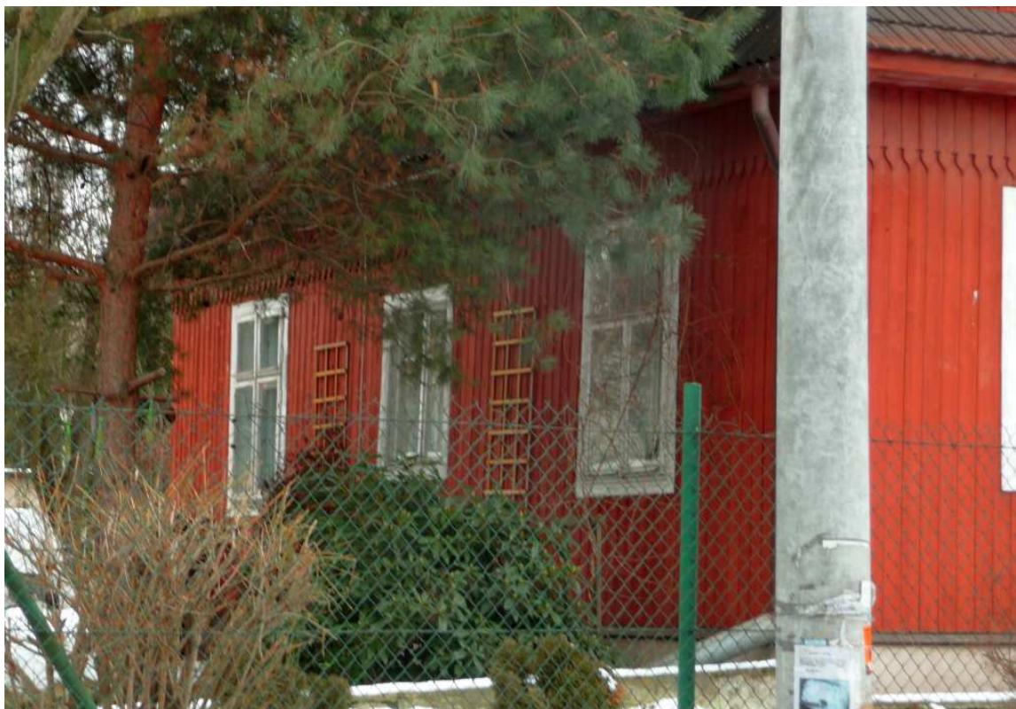
Fot. nr 132. Z prawej części fasady oryginalne, trójkwaterowe okno. W pierwotnej wersji pośrodku mógł znajdować się ganek bądź tylko drzwi wiodące do ogrodu. (17.01.2018)
