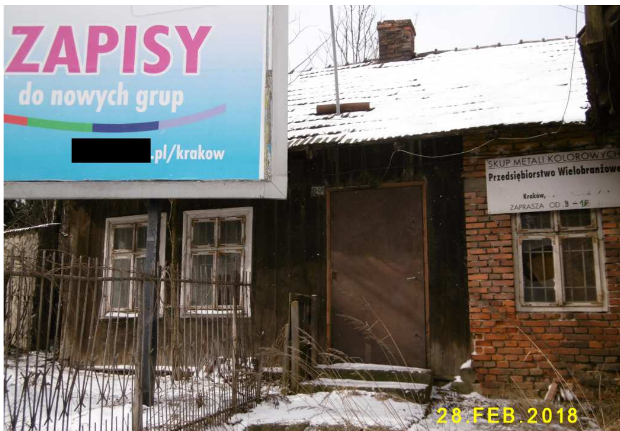
Fot. nr 23 (23-27). Opuszczony już, przedwojenny dom, gdzie zachowały się: oryginalne okna i drewniana boazeria fasady
