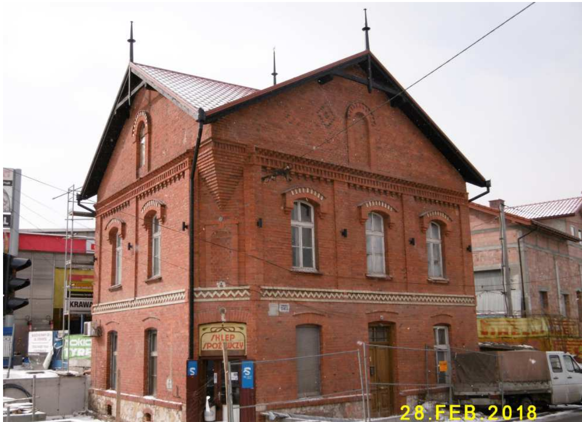
Fot. nr 20. Budynek PTG Sokół z ulicy Cienistej 1, który powstał na początku XX wieku.
