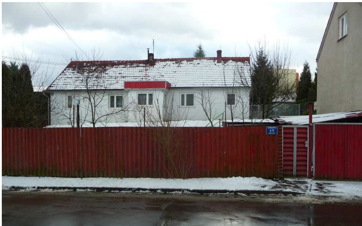
Fot. nr 74 (74-75). Przebudowany dom z ulicy Cienistej 49 (17.01.2018)
