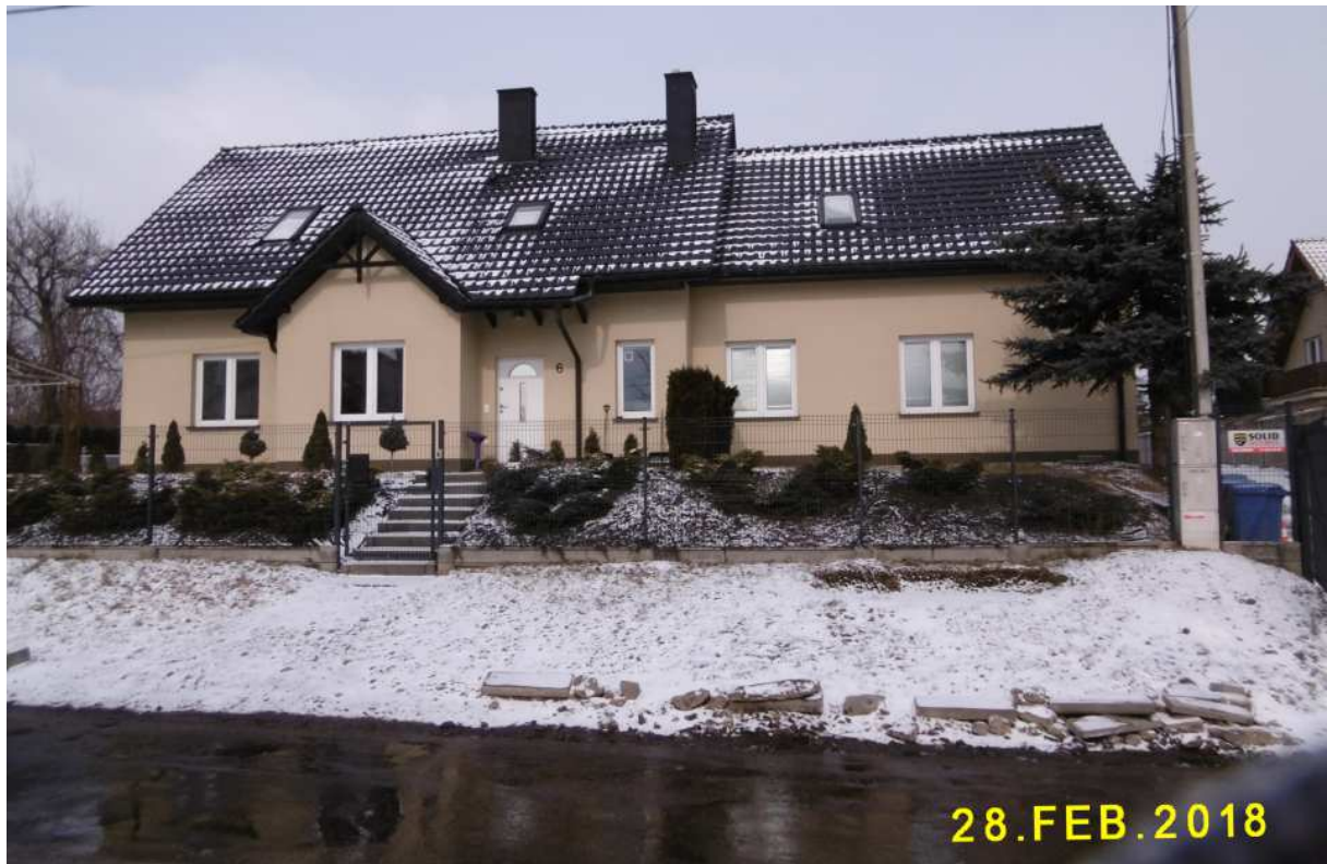
Fot. nr 2. Stan obecny na posesji pod nr 4 po wyburzeniu chałupy.
