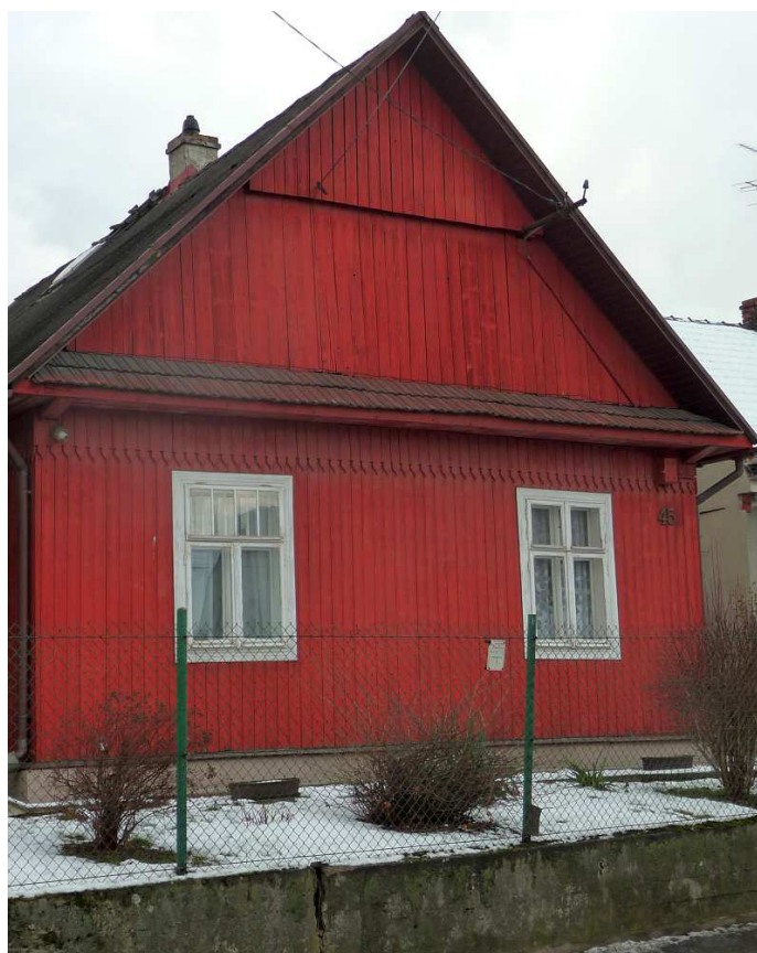
Fot. nr 133. Z lewej strony bocznej ściany oryginalne okno. Pozostałe okna domu są nieco późniejsze. (17.01.2018)
