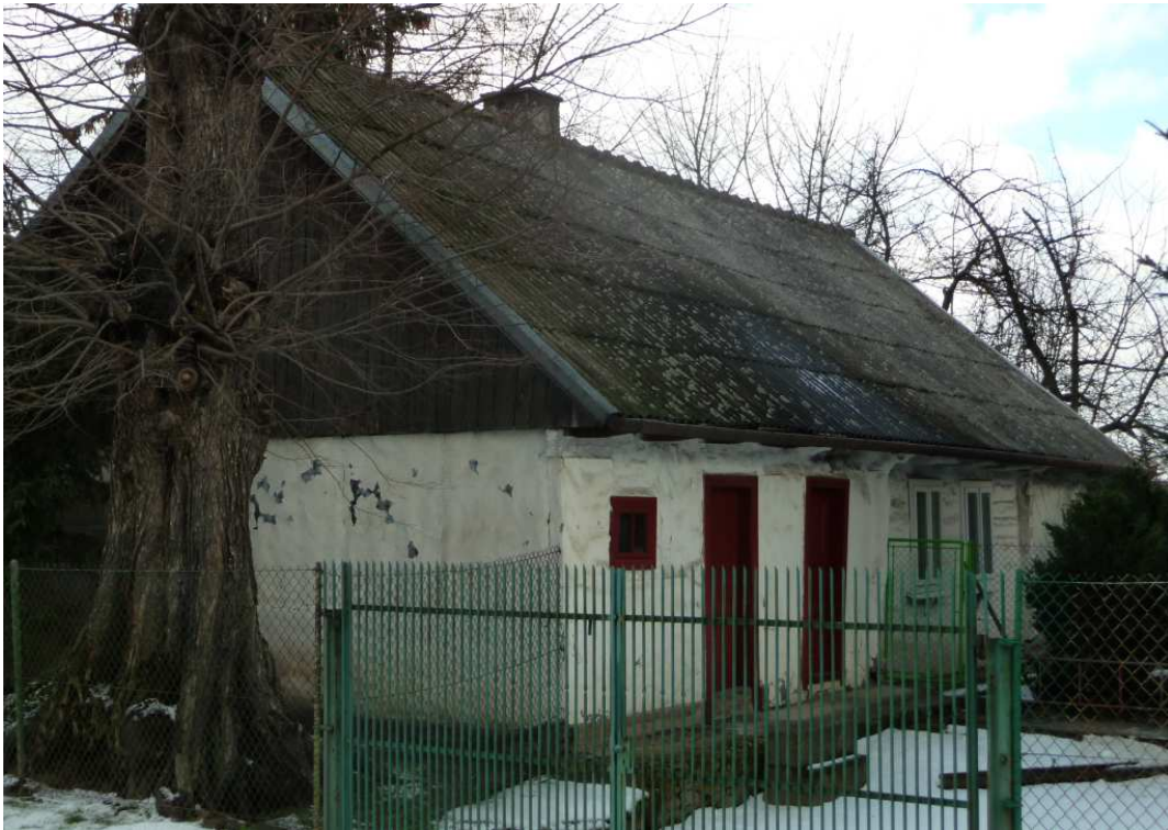
Fot. nr 48. W prawej części widoczne jest oryginalne, poprzeczne belkowanie ściany, natomiast okna nie pochodzą z czasów budowy. (17.01.2018)
