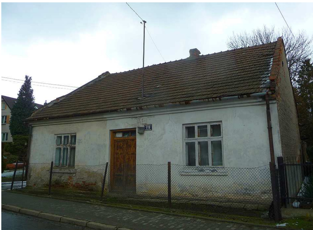
Fot. nr 77. Oryginalne okna domu. (17.01.2018)
