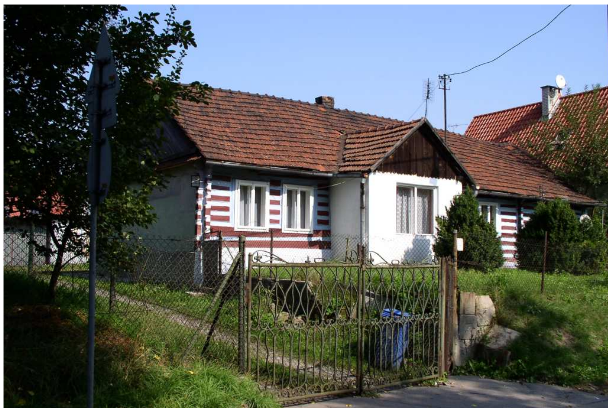
Fot. nr 1 (1-2). Poprzecznie belkowana i malowana chałupa ulicy Fatimskiej 4. Stan z roku 2009.
