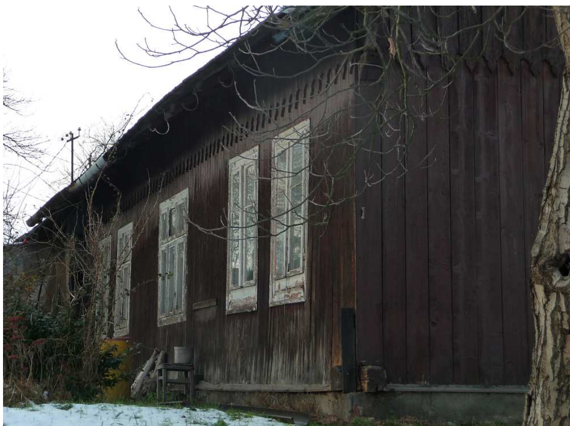
Fot. nr 33. Detale okienne. Te dwa okna z prawej są oryginalne; pozostałe trzy nieco późniejsze, z okolic połowy XX wieku. (17.01.2018)
