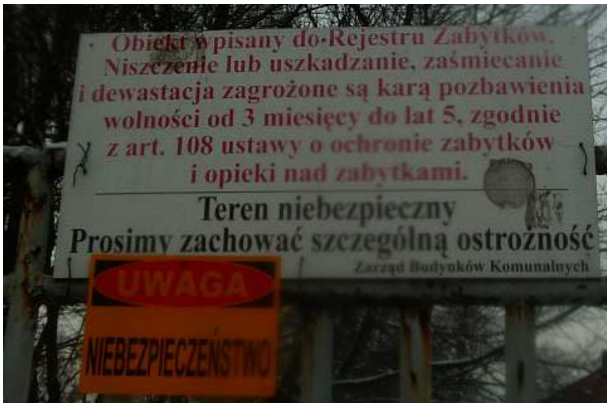
Fot. nr 7. Czy wpisanie obiektów młyna do rejestru zabytków uchroni go przed architektoniczną dewastacją? (24.01.2018)
