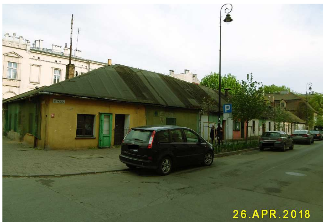
Fot. nr 72. Jak długo jeszcze przetrwa parterowa zabudowa wzdłuż ulicy Węgierskiej 13-15? Widok z ulicy Józefińskiej.
