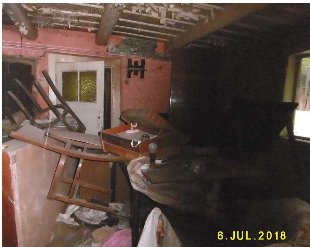
Fot. nr 231. Zdemolowane sprzęty tej prawdopodobnej kuchni.
