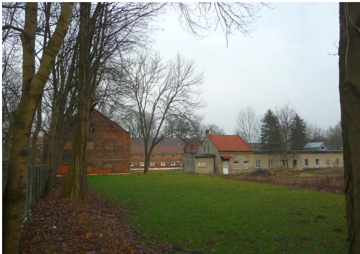
Fot. nr 136 (136-144). Dawny folwark „Na Wrzosach”, wybudowany przez Erazma Jerzmanowskiego pod koniec XIX wieku. Fot. nr: 136-139 – widoki z ulicy Żniwnej. (10.01.2018)
