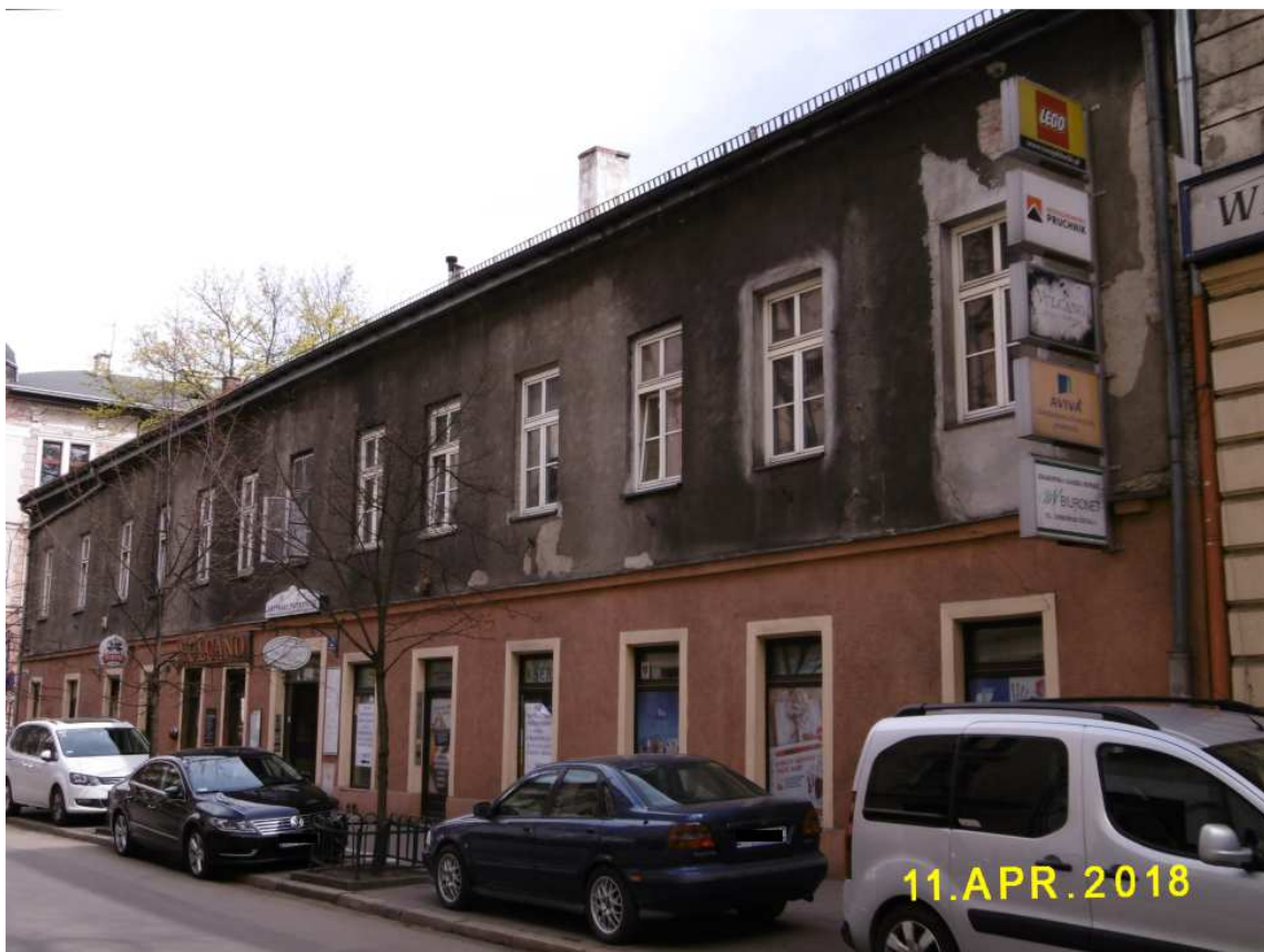
Fot. nr 11. Ostatnie chwile domu z ulicy Librowszczyna 3, który WKZ uznał za zbyt mało ciekawy, by go objąć prawną ochroną, choć to relikw niskej zabudowy z pocz. XIX wieku.
