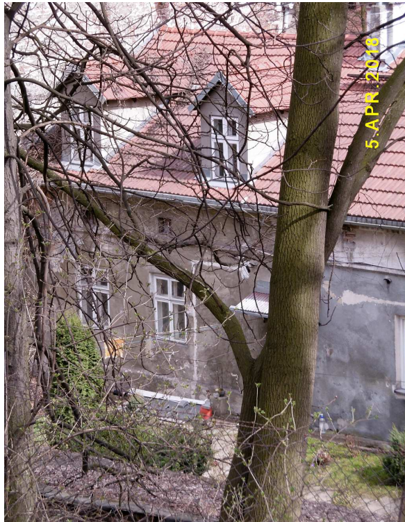
Fot. nr 102. Zachowane do dziś oryginalne okna.
