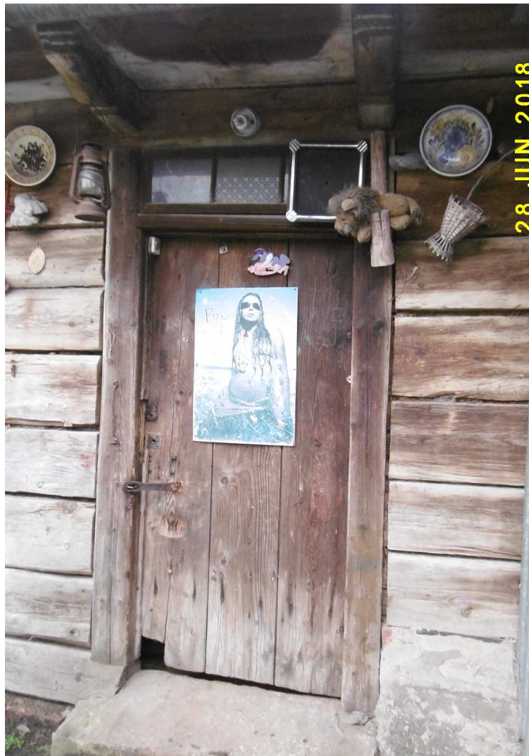
Fot. nr 198 (198-203). Detale w części od strony podwórka.
