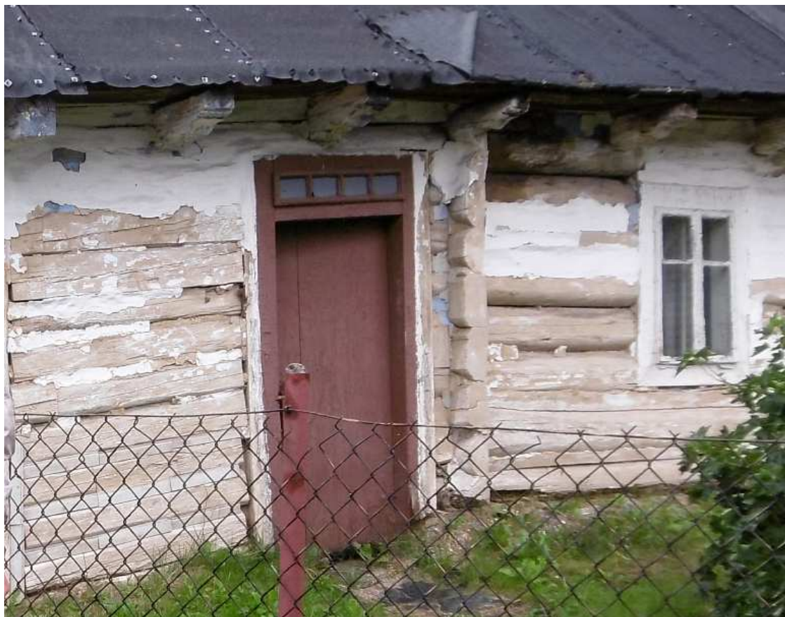
Fot. nr 217. Gnijące dźwigary nie wróżą tej chałupie długiego żywota.
