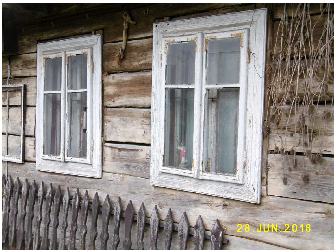
Fot. nr 201. Oryginalne okna.
