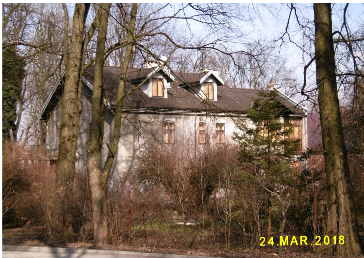
Fot. nr 120 (120-125). Stary dwór Bemów z ulicy Estońskiej (formalnie Mochnackiego 71) jeszcze nie do końca zdewastowany, bo okna i drzwi chronią jeszcze „dechy”.
