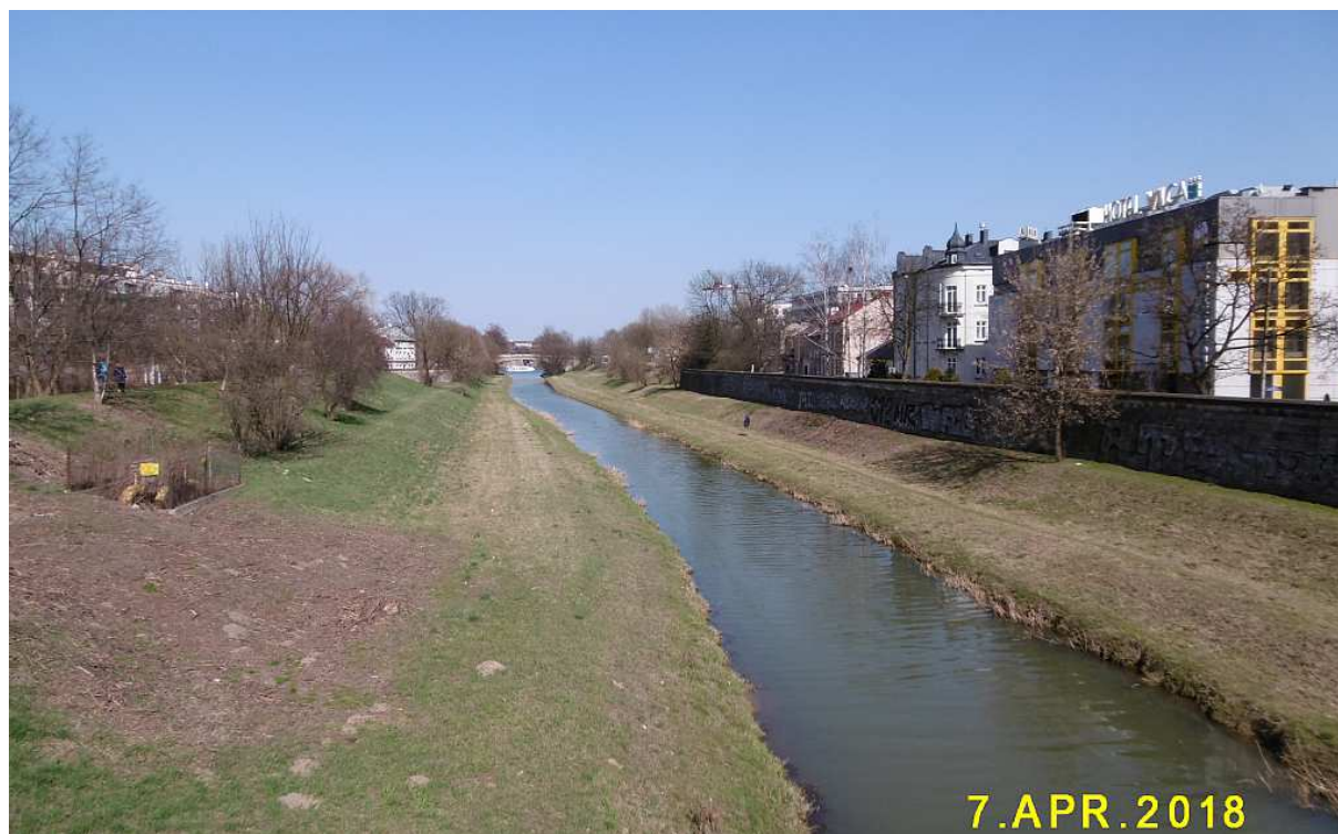
Fot. nr 36 (36-39). Zabudowa prawobrzeżnej części Ludwinowa wzdłuż ulicy Przedwiośnie: ta stara pod nr: 2-16 i ta nowopowstająca przy ujściu Wilgi do Wisły pod nr 2A i 2B.
