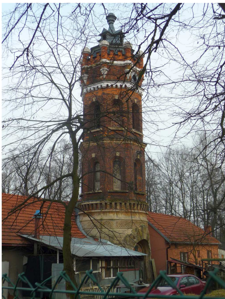
Fot. nr 147 (147-149). Eklektyczna wieża ciśnień na skraju Parku Jerzmanowskich przy ulicy Górników 25, która powstała na początku XX wieku. (10.01.2018)
