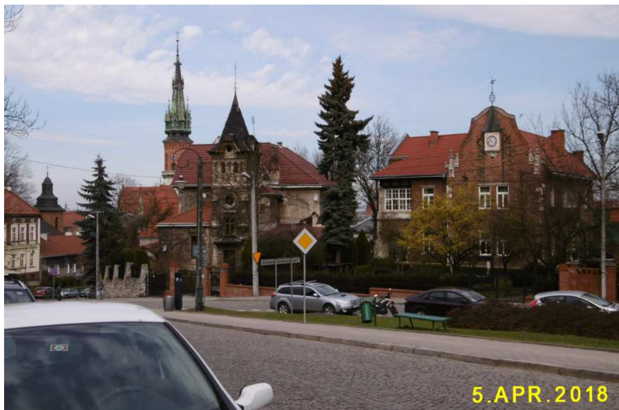
Fot. nr 92 (92-98). Eklektyczna zabudowa Podgórza z przełomu XIX i XX wieku we fragmencie na styku Placu Lasoty i ulicy Parkowej.
