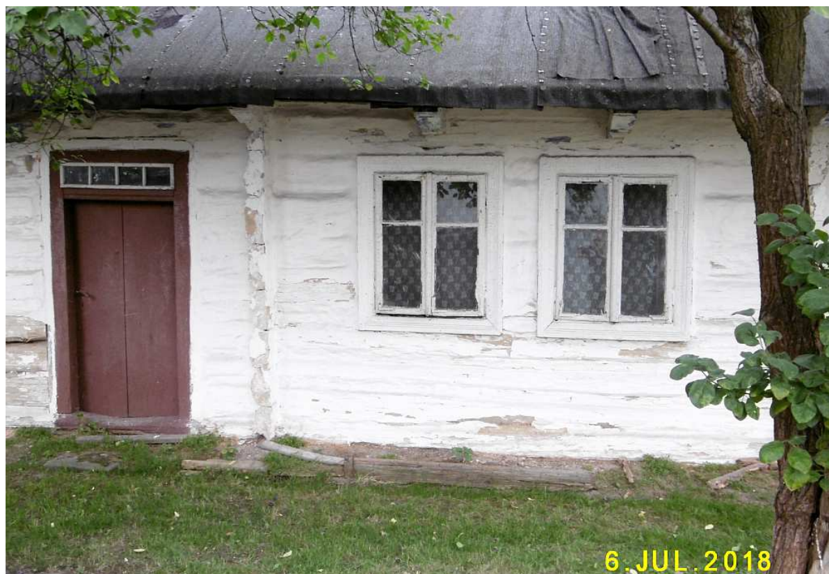
Fot. nr 209 (209-210). Oryginalne okna prawej części chałupy oraz drzwi z tradycyjnym świetlikiem w górnej części futryny.
