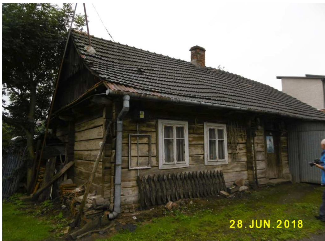
Fot. nr 197. Fragment od strony podwórka.
