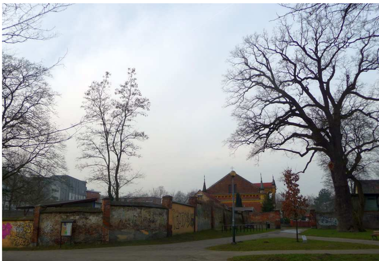
Fot. nr 155 (155-157). Kaplica Augustianów, wybudowana w miejscu wozowni w roku 1911. (10.01.2018)
