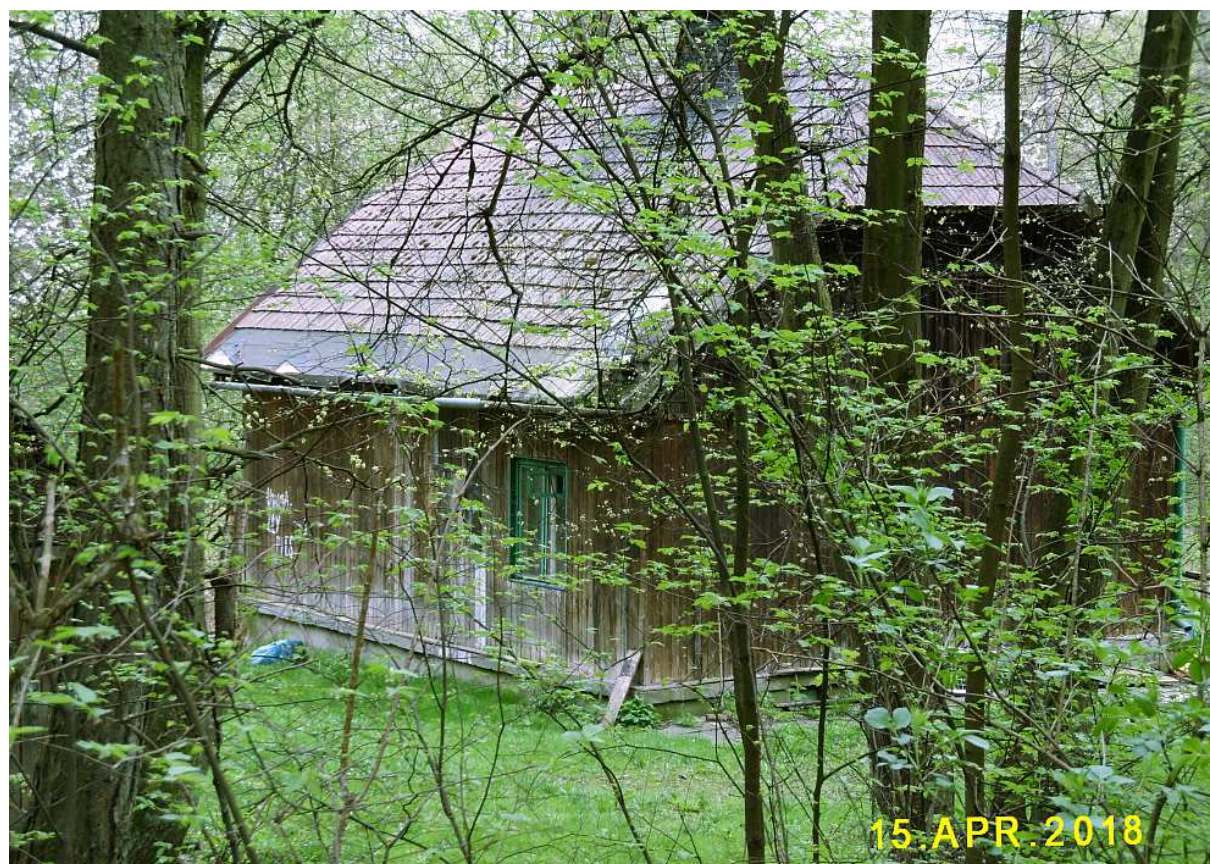
Fot. nr 21 (21-22). Tylna część domu
