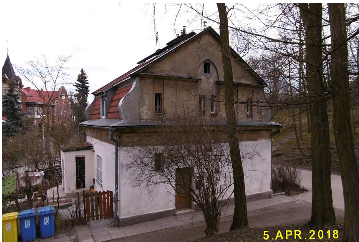
Fot. nr 99. Dom przy wejściu do Parku Bednarskiego przy ulicy Parkowej 10 (ok. 1910).
