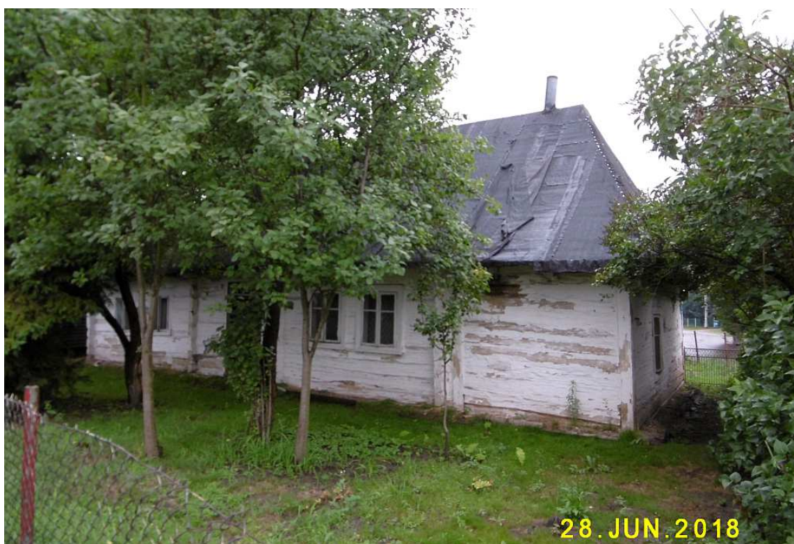
Fot. nr 206 (206-217). Chałupa z ulicy Wańkowicza 51 (dawniej 81), która powstała pod koniec XIX wieku.
