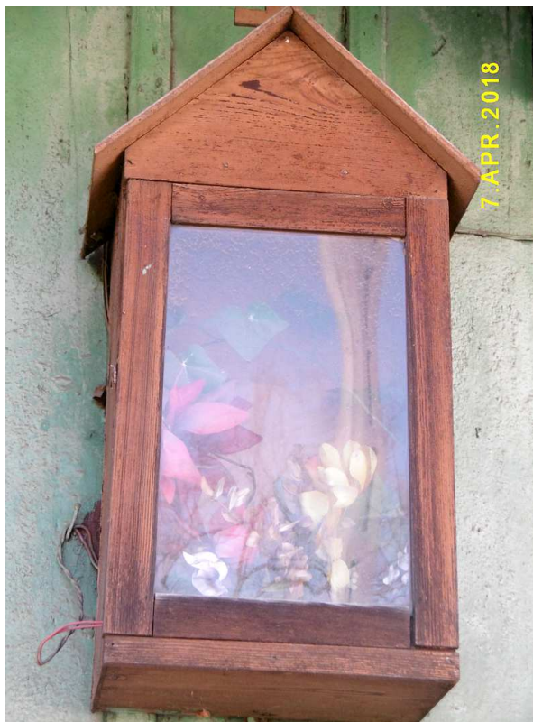
Fot. nr 44. Pusta kapliczka na fasadzie opuszczonego już domu spod nr 21.
