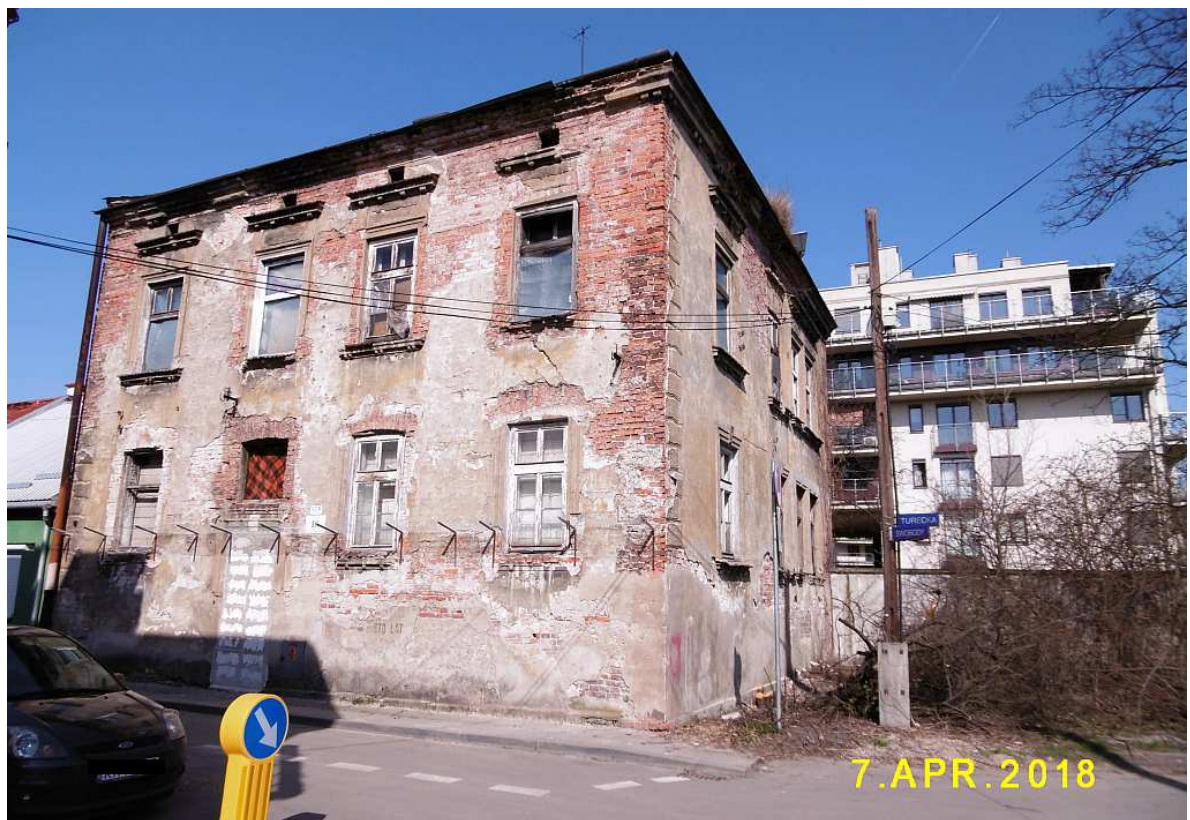
Fot. nr 49 (49-53). Kamieniczka z ulicy Tureckiej pod nr 16, która powstała w latach 30. zeszłego wieku dla pracowników pobliskiej garbarni.
