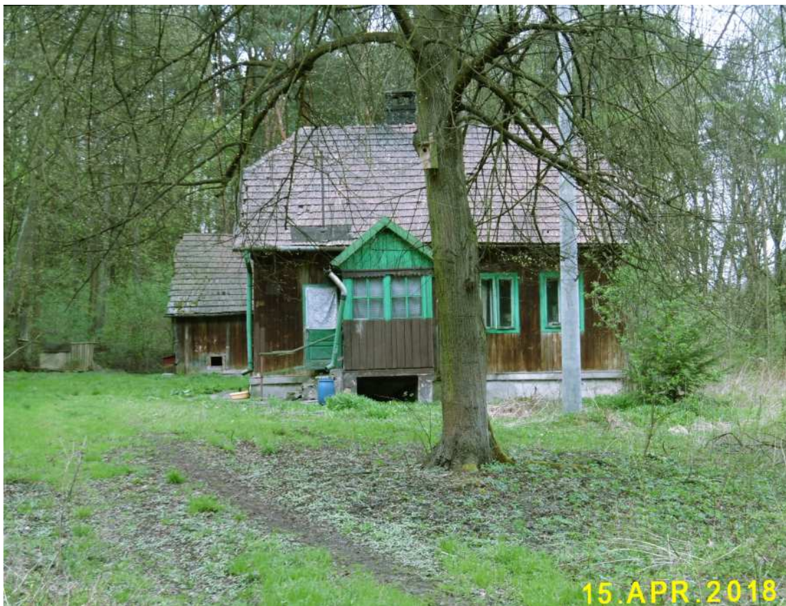
Fot. nr 14 (14-23). Przedwojenna leśniczówka z ulicy Do Groty 105 i jej detale oraz zaplecze gospodarcze. Można się obawiać o jej przyszłość, bo wydaje się być opuszczona.
