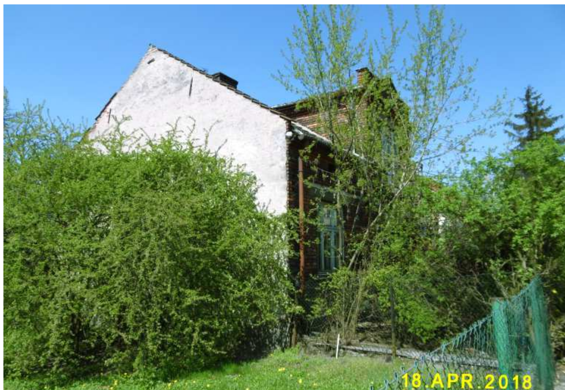
Fot. nr 165 (165-166). Dom z ulicy Morawiańskiego 15, który od kilku lat zarasta.
