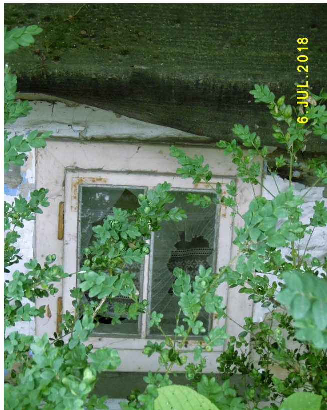
Fot. nr 227. Okienko w ścianie bocznej.
