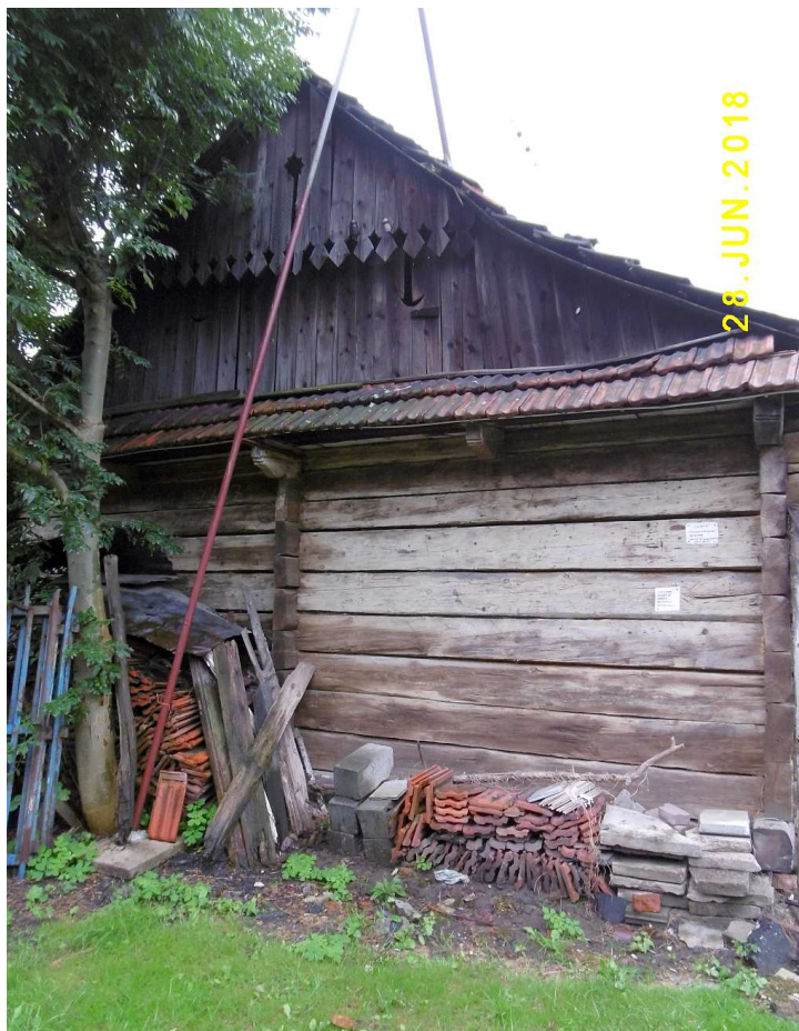
Fot. nr 196. Boczna ściana.
