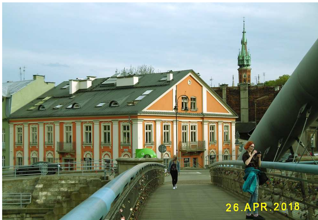
Fot. nr 69. Dom spod nr 2, który powstał w IV ćwierci XVIII wieku.
