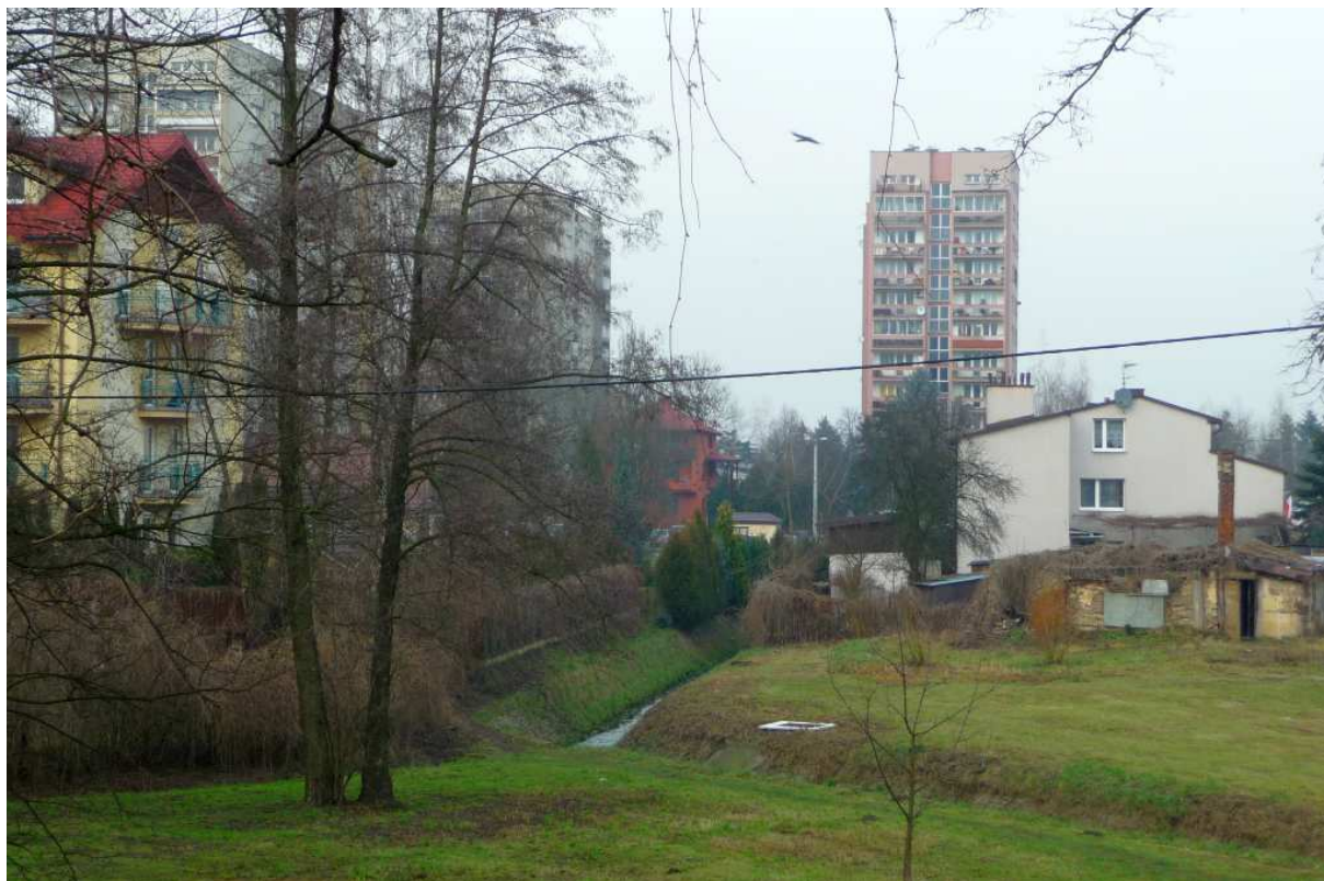
Fot. nr 163. Ruina domku z ulicy Jesiennej 5 na tle zabudowy osiedla przy ulicy Nad Potokiem. (10.01.2018)
