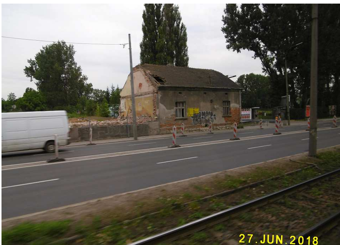
Fot. nr 117b. Trwa wyburzanie. W dniu 27.06.18 pozostał już tylko dom spod nr 105.
