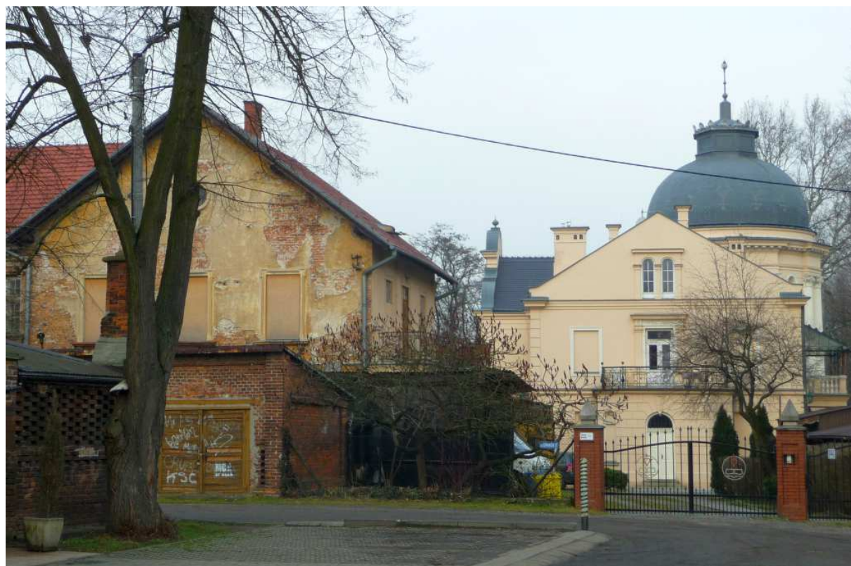
Fot. nr 159. Boczny fragment pałacu od strony kaplicy. (10.01.2018)
