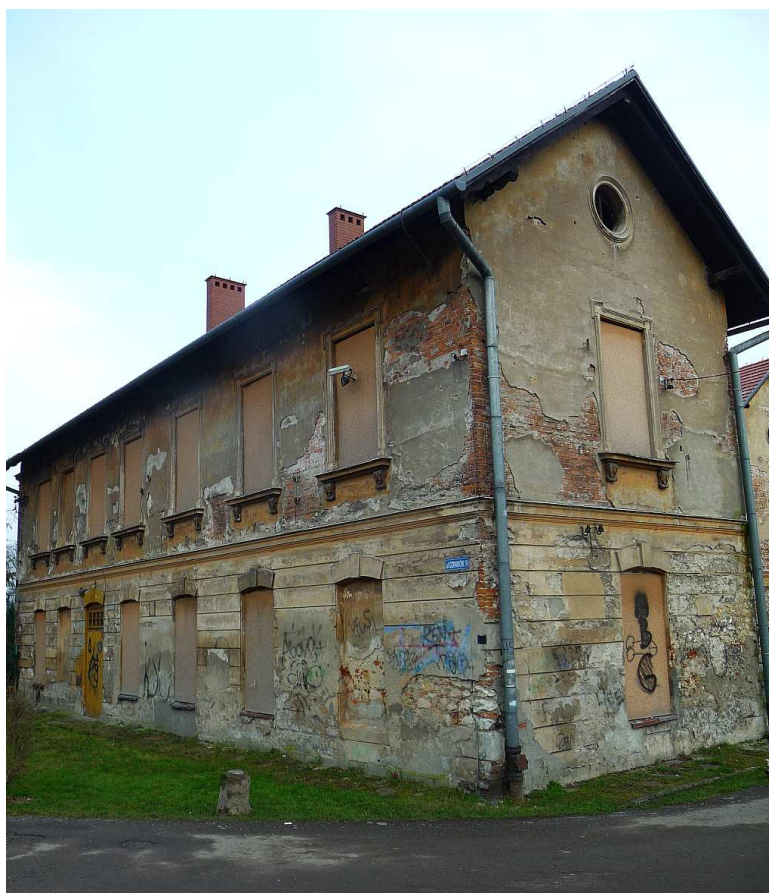
Fot. nr 161. Lewo skrzydło budynku już bez oryginalnych okien. (10.01.2018)
