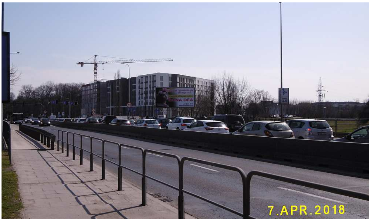
Fot. nr 35. Nowe blokowisko przy ulicy Konopnickiej, zlokalizowane na przedłużeniu ulicy Orawskiej, na końcowym etapie budowy. Powstaje dodatkowe skrzyżowanie, które dodatkowo zaburzy ruch na ulicy Konopnickiej i zwiększy samochodowe korki.
