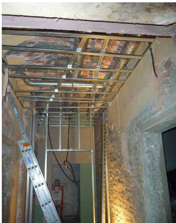
Fot. nr 73 (73-74). Remont sufitu parteru, gdzie zostanie przywrócony jego pierwotny wygląd znany z archiwalnych fotografii (patrz poniżej). (22.01.2018)
