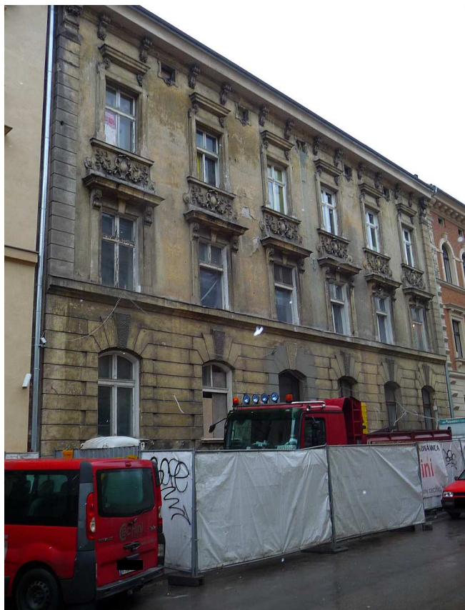
Fot. nr 66 (66-85). Kamienica Zollów z ulicy Studenckiej 25 i jej detale. Fotografie na etapie remontu. (12.01.2018)
