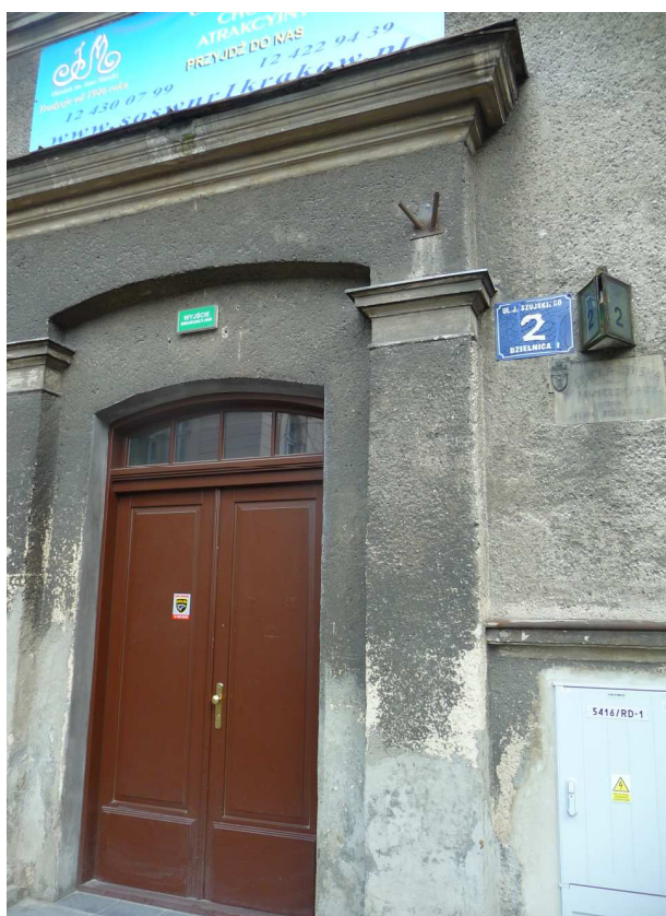
Fot. nr 95. Drzwi wejściowe do budynku szkolnego. Jeszcze do niedawna była w nich oryginalna klamka. (05.02.2018)
