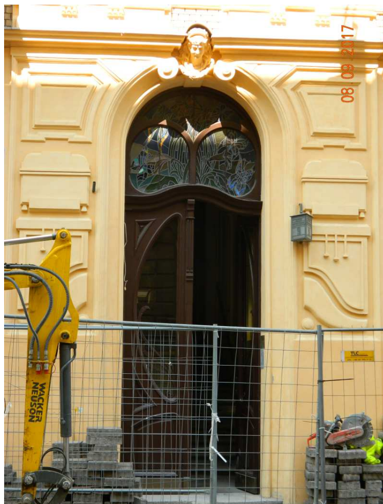
Fot. nr 54 (54-55). Drzwi i ich detale.
