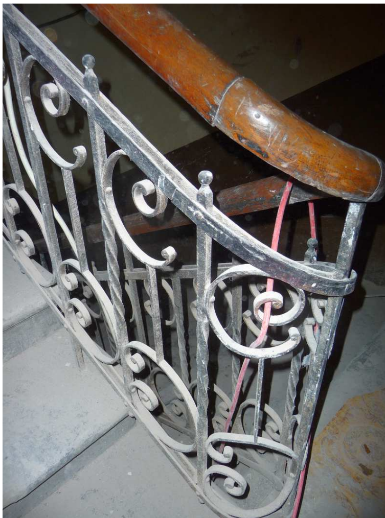
Fot. nr 76. Metalowa balustrada. (22.01.2018)
