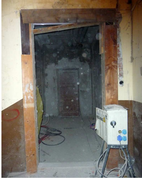
Fot. nr 82. Zabezpieczone odrzwia drzwi wejściowych do dawnego mieszkania prof. Andrzeja Zolla na pierwszym piętrze kamienicy. (22.01.2018)
