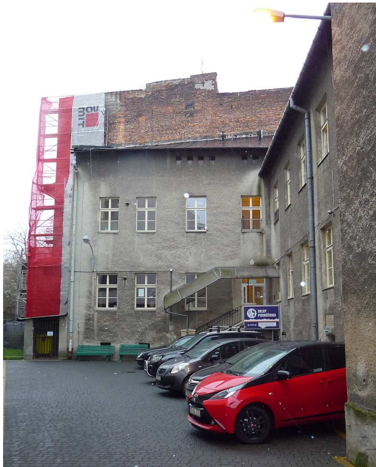
Fot. nr 122. Podwórkę szkolną, dziś już wybrukowaną, kiedyś szutrową. (12.01.2018)
