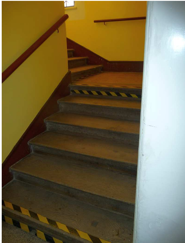
Fot. nr 118. Skrzypiące jak dawnie schody klatki schodowej. (05.02.2018)
