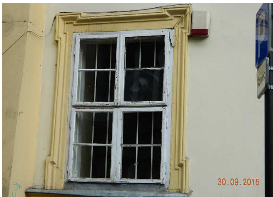
Fot. nr 16. Oryginalne, ośmiopolowe okno, które zachowało się na parterze kamienicy z naroża ulic: św. Tomasza 35 i św. Krzyża 15, charakterystyczne dla klasycystycznej zabudowy z połowy XIX wieku. Takich oryginałów pozostało w Krakowie ledwie kilka.
