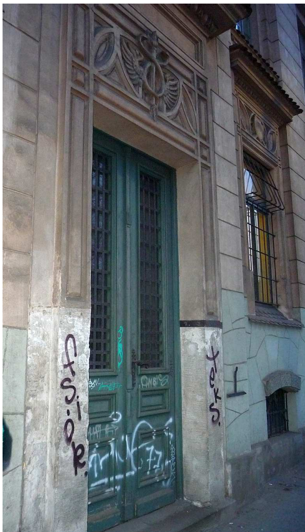
Fot. nr 56 (56-61). Detale parteru dawnej Szkoły Handlowej z naroża ulic: Straszewskiego 29 i Kapucyńskiej 2/4. (07.02.2018)
