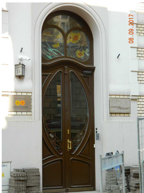
Fot. nr 51 (51-52). Próba odtworzenia dawnych drzwi i ich zwieńczenia w postaci witrażu.
