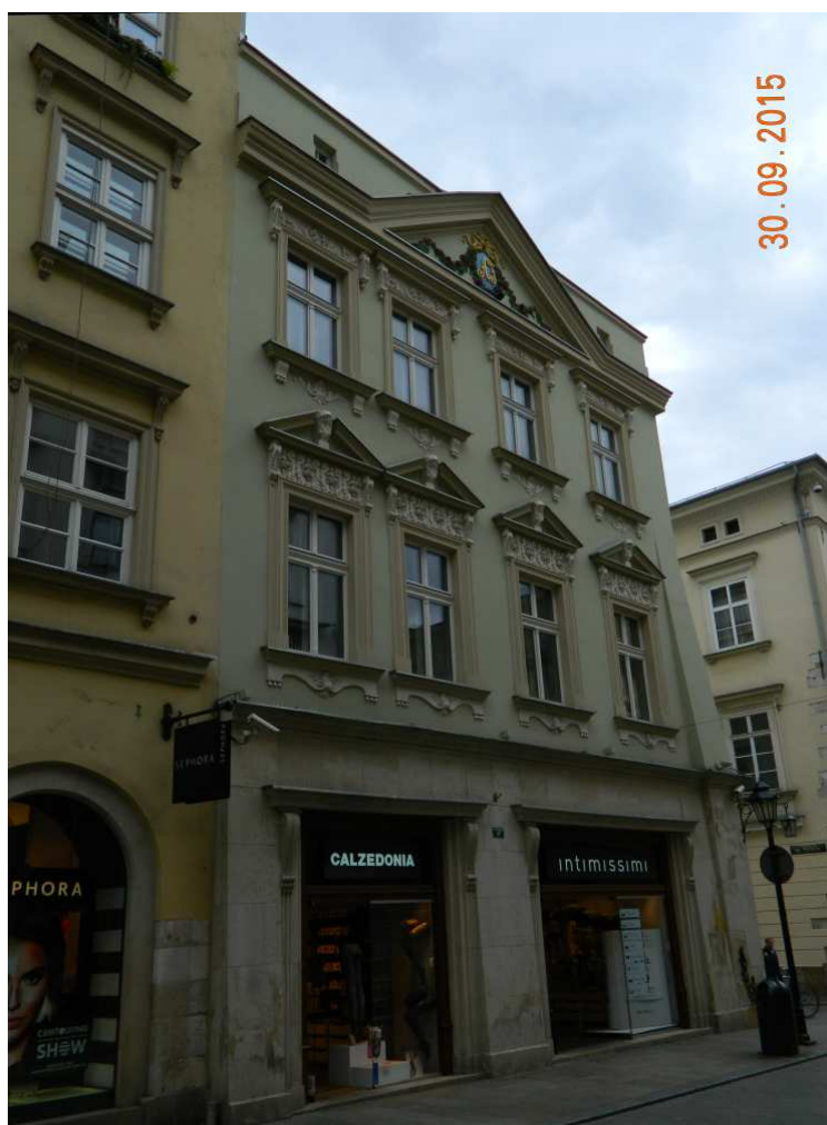
Fot. nr 17 (17-18). Świeżo odnowiona kamienica z ulicy Floriańskiej 17.
