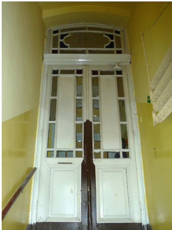
Fot. nr 98 (98-100). Mozaikowe drzwi wewnętrzne wiodące od wejścia do parterowego korytarza oraz ich mozaikowe detale. (05.02.2018)
