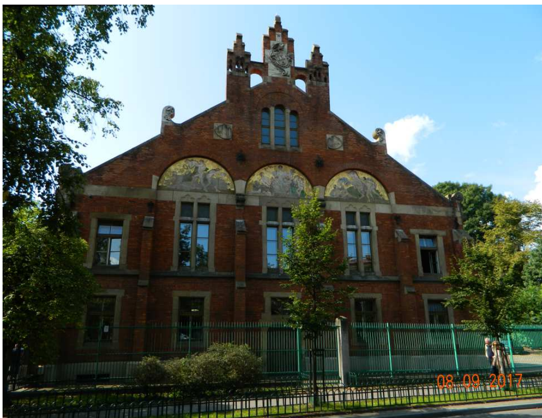
Fot. nr 48 (48-49). Szczytowa ściana TG Sokół w kształcie po przebudowie dokonanej przez Teodora Talowskiego w roku 1894. W zwieńczeniu dekoracja sgraffitowa autorstwa Fryderyka Lachnera.
