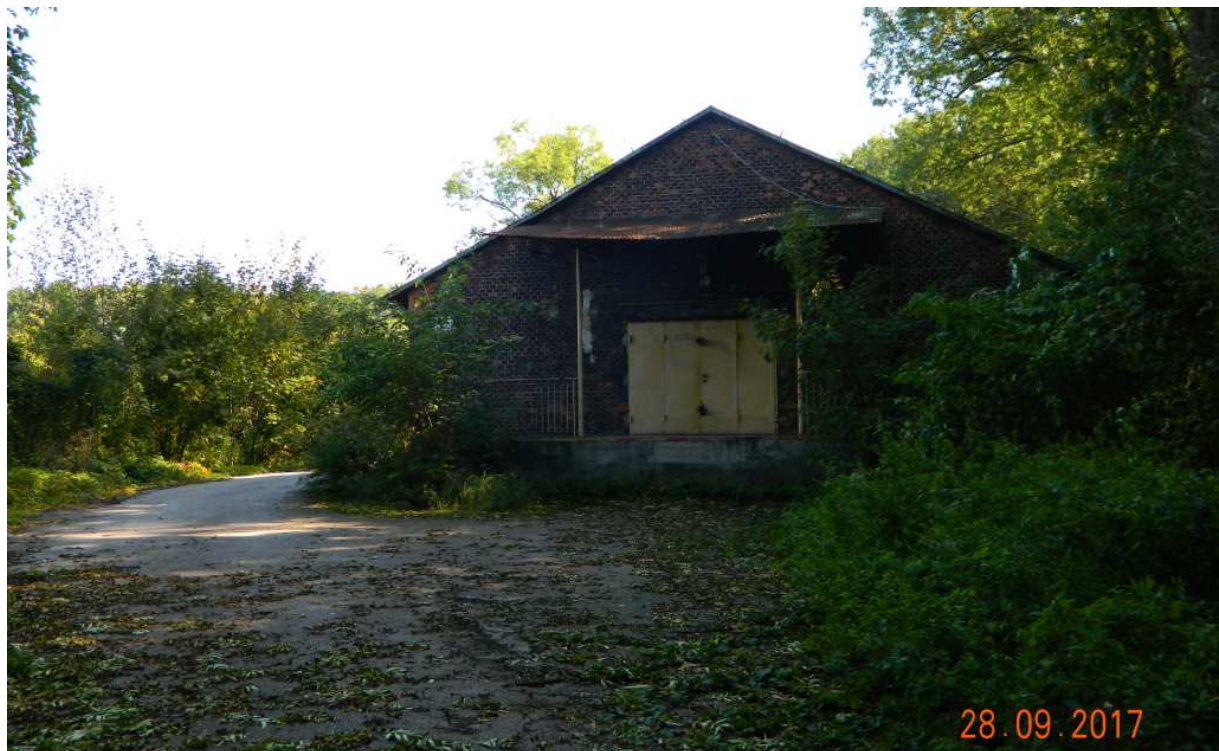
Fot. nr 188 (188-189). Budynek prochowni „Wola Duchacka” z czasów Twierdzy Kraków w bocznym odgałęzieniu od ulicy Kamieńskiego, który biegnie przy torach kolejowych. (22.10.2017)
