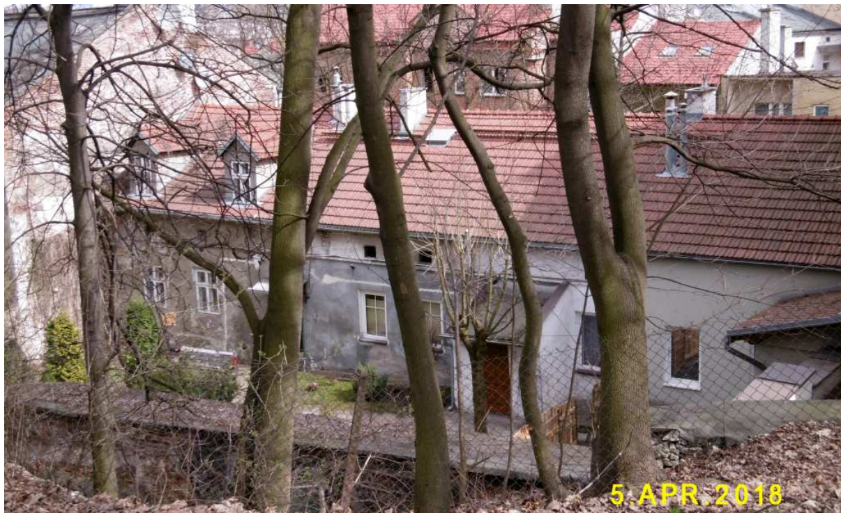
Fot. nr 182 (182-183). Tylna część domu z ulicy Parkowej 2.
