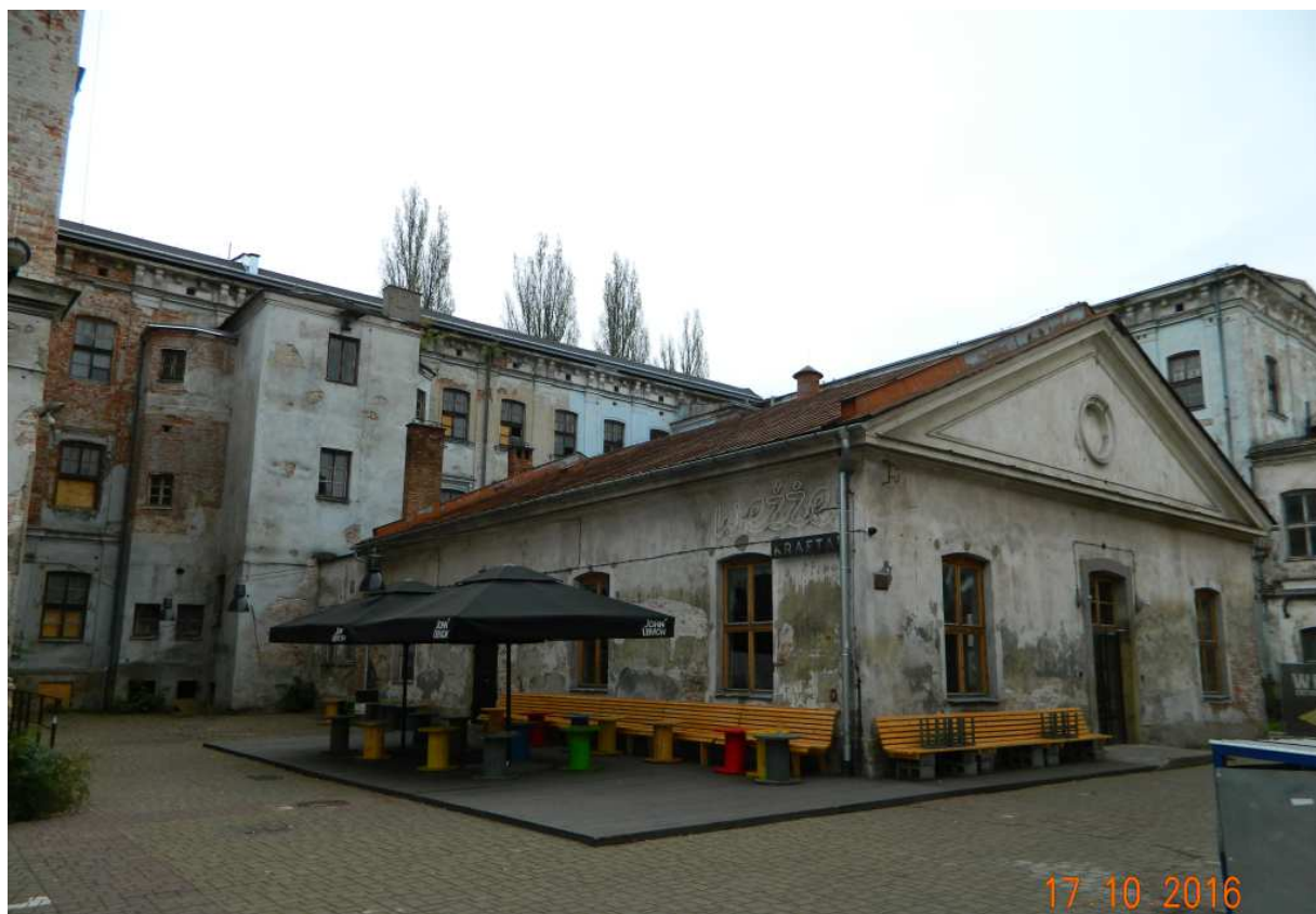
Fot. nr 137. Widoki na budynki fabryczne usytuowane wewnątrz zakładu. Wszędzie zachowały się ośmiopółowe, czterokwaterowe okna.
