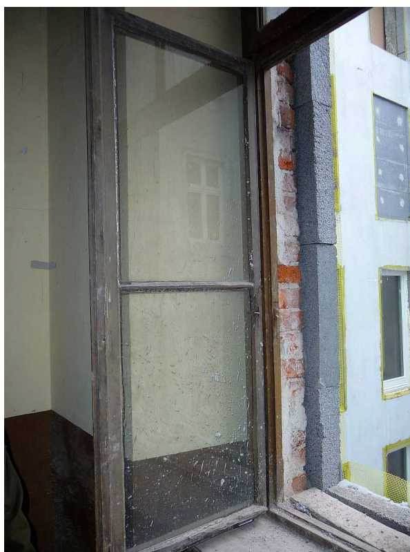
Fot. nr 79 (79-81). Oryginalne okno klatki schodowej i jego niecodzienne dziś detale. (22.01.2018)
