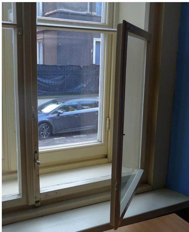
Fot. nr 112. Uchylny lufcik dolnego fragmentu prawego skrzydła. (05.02.2018)
