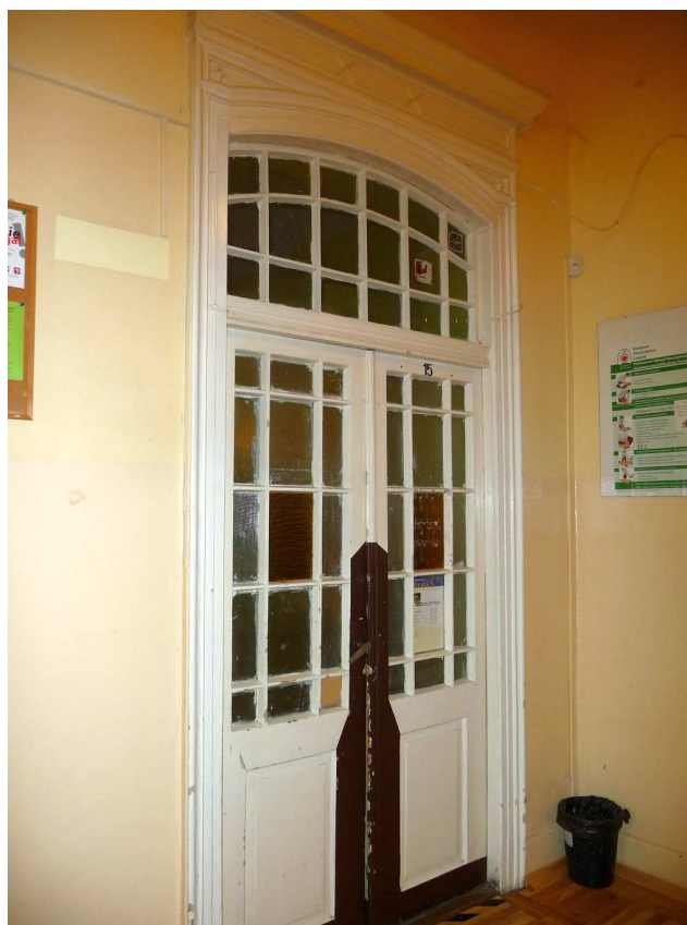
Fot. nr 113. Mozaikowe drzwi wejściowe do dawnego gabinetu dyrektora SP nr 6 w skrajnej części korytarza I piętra. (05.02.2018)
