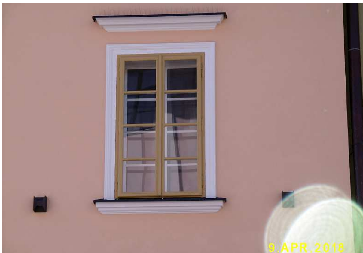
Fot. nr 14. Gdyby jeszcze został tu odtworzony lufcik, czyli uchylna pojedyncza kwatera, mielibyśmy detal oryginalny, bo okno to jest ośmiopolowe, o cienkich, drewnianych szprosach, na dodatek otwierane na zewnątrz. Czemu dokonano takiej redukcji?
