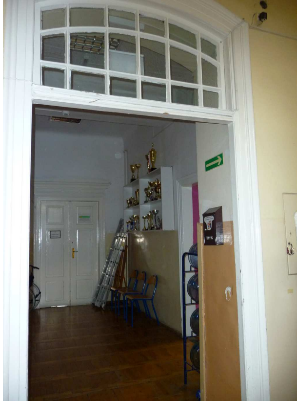
Fot. nr 108. Skrajny fragment parteru z wejściem do bocznej odnogi korytarza. (05.02.2018)
