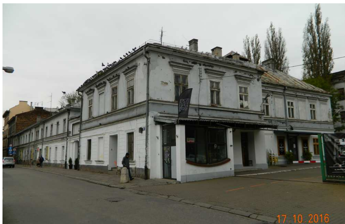
Fot. nr 135 (135-142). Fotografie kompleksu budynków dawnej rządowej „Cygar Fabryki” z ulicy Dolnych Młynów 8-10. Tu zabudowania socjalne, których fasadę niszczą chaotycznie powstające tu „knajpki” i brama wjazdowa na teren zakładu.
