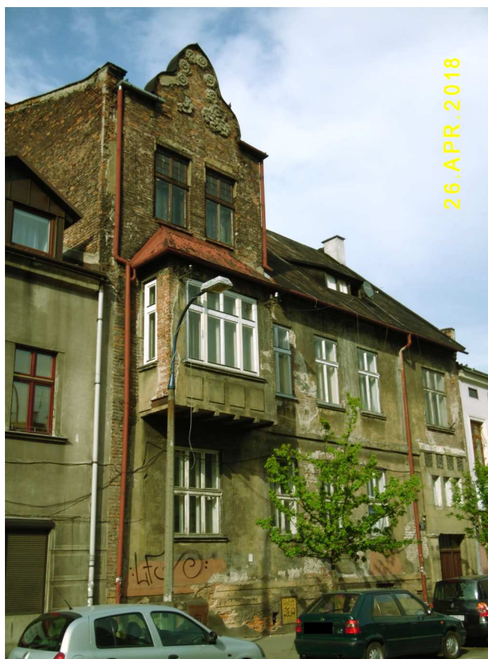
Fot. nr 175 (175-176). Modernistyczna kamienica z ulicy Józefińskiej 23.
