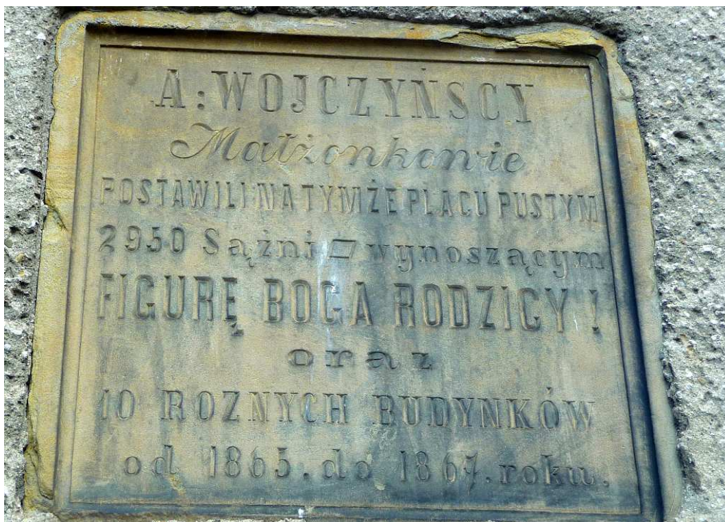
Fot. nr 94. Tablica z fasady budynku od strony ulicy Szujskiego. (05.02.2018)
