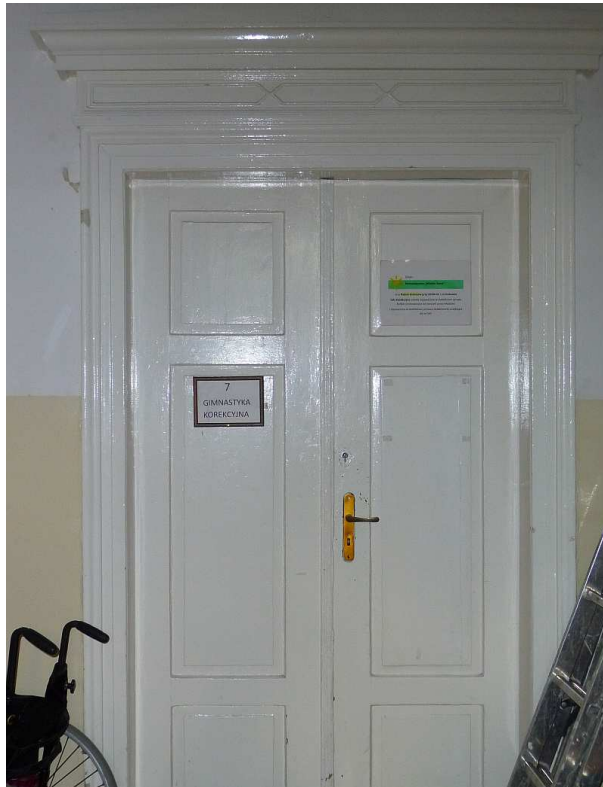
Fot. nr 110 (110-112). Wejście do sali na parterze budynku od strony ulicy Krupniczej i jej detale. Tu masywne drzwi wejściowe, które przetrwały burzę dziejowe. (05.02.2018)
