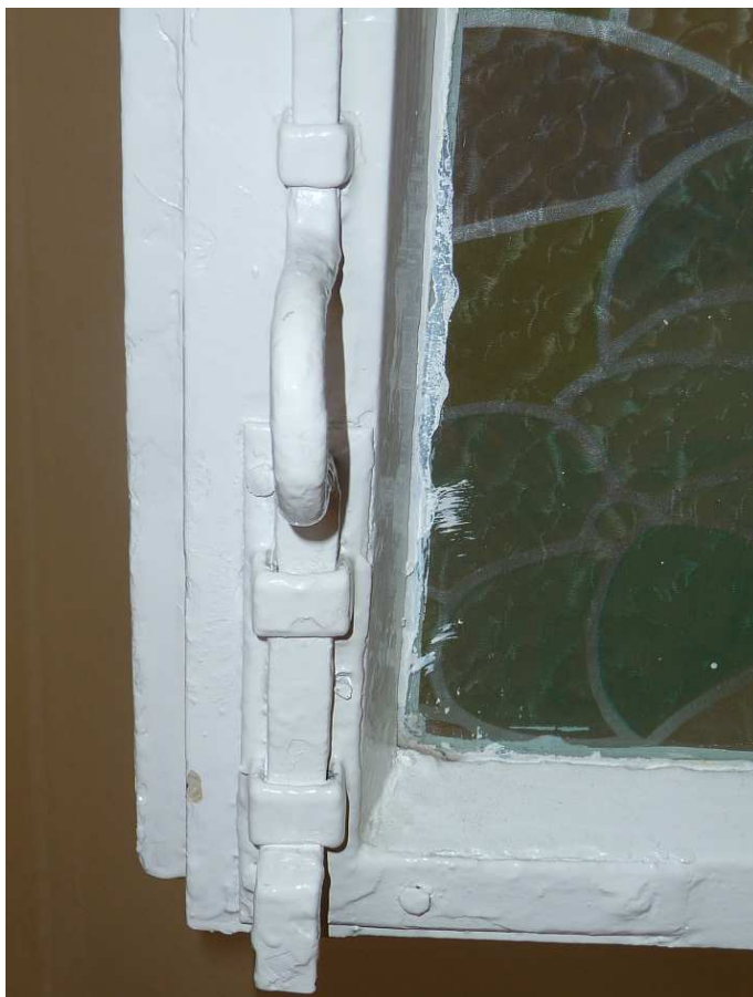
Fot. nr 104. Zasuwa ręczna w dolnym skrzydle lewej kwatery. (05.02.2018)
