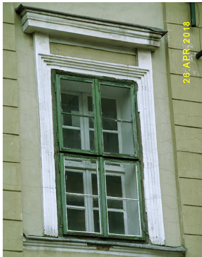
Fot. nr 161. Jedyne oryginalne okno ośmiopolowe, czterokwaterowe.
