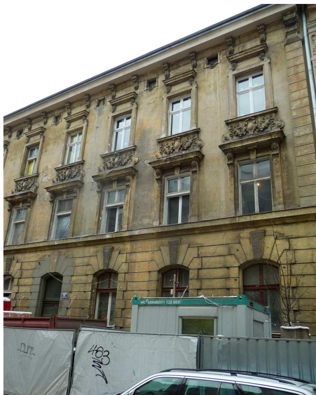
Fot. nr 67. Fasada kamienicy, gdzie w całości zostaną odtworzone dawne okna. Część z ich (na drugim piętrze) już zostało wymienionych. (22.01.2018)
