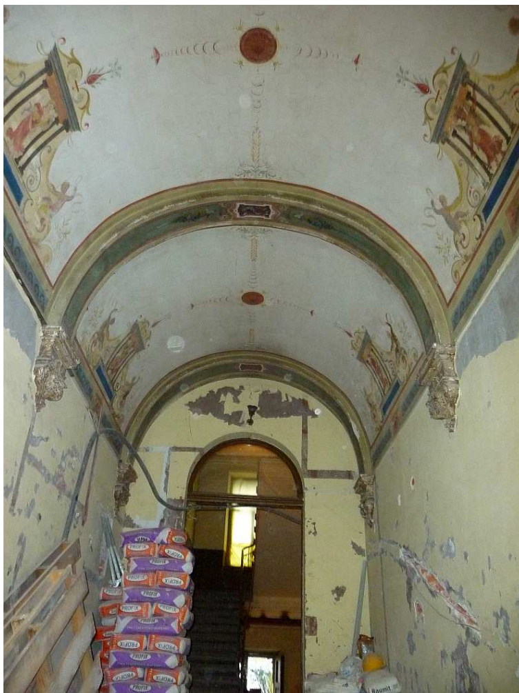
Fot. nr 70(70-72). Sień kamienicy i malowidła pompejańskie na jej suficie. (22.01.2018)
