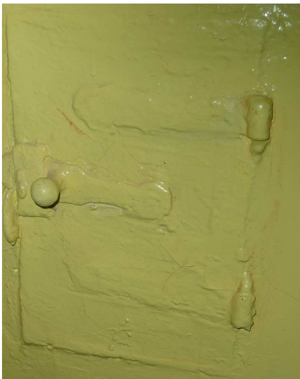
Fot. nr 126. Drzwiczki do dawnego pionu wentylacyjnego w przyziemiu budynku. (05.02.2018)
