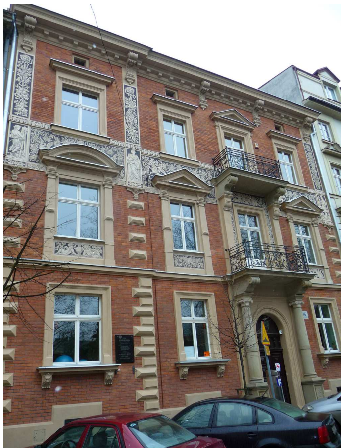
Fot. nr 62 (62-63). Odnowiona fasada kamienicy własnej Sławomira Odrzywolskiego z ulicy Studenckiej 19, gdzie uwagę przyciąga dekoracja sgraffitowa. (12.01.2018)
