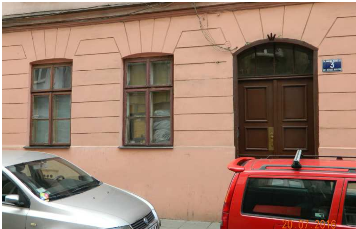
Fot. nr 164. Oryginalne okna kamienicy z ulicy Meiselsa 3, jeszcze z cienkimi szprosami.
