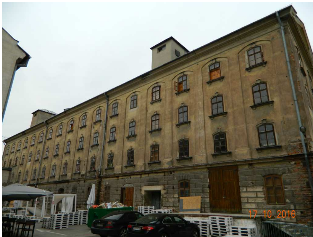
Fot. nr 138 (138-141). Najcenniejszy pod względem architektonicznym budynek fabryczny, który przylega do gmachu Akademii Rolniczej. Zachowało się tutaj m.in. boniowanie części parterowej i oryginalne okna drewniane otwierane na zewnątrz.
