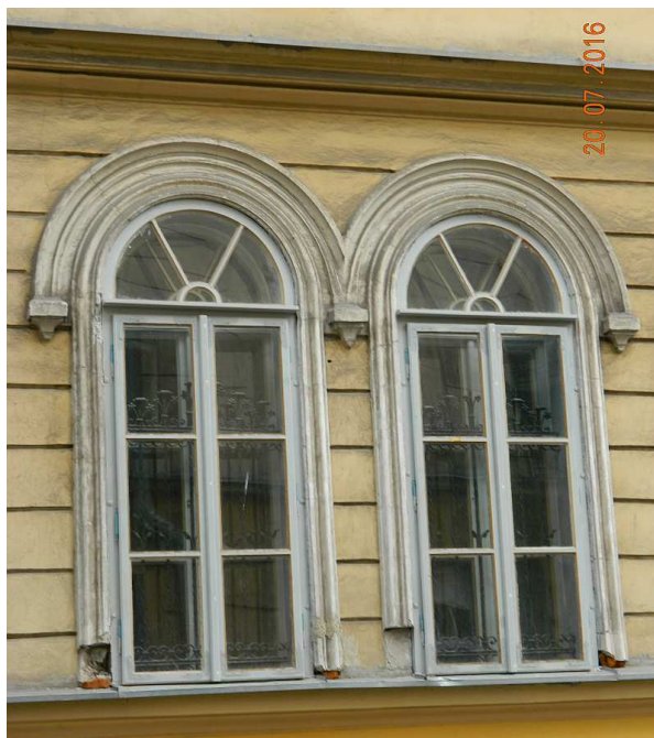
Fot. nr 165. Oryginalne okna o cechach neorenesansowych parteru budynku.
