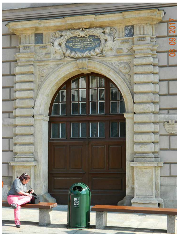
Fot. nr 3 (3-4). Oryginalny portal po dawnym arsenale, którego początki sięgają połowy XV wieku. W roku 1643 został on gruntownie przebudowany przez króla Władysława IV, po którym pozostała też nazwa – arsenał Władysława IV.
