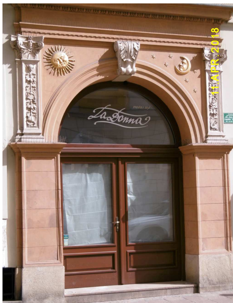
Fot. nr 27. Portal od strony ulicy Szczepańskiej.
