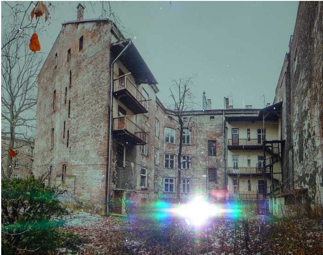
Fot. nr 84 (84-85). Stan tylnej części kamienicy sprzed remontu; z prawej zdemontowane schody „kuchenne” i ganki wewnętrzne – fot. udostępniona przez Pana Jana Krawczyka. (22.01.2018)
