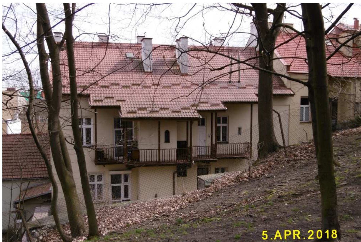
Fot. nr 181. Tylony balkon kamienicy z ulicy Parkowej 4.
