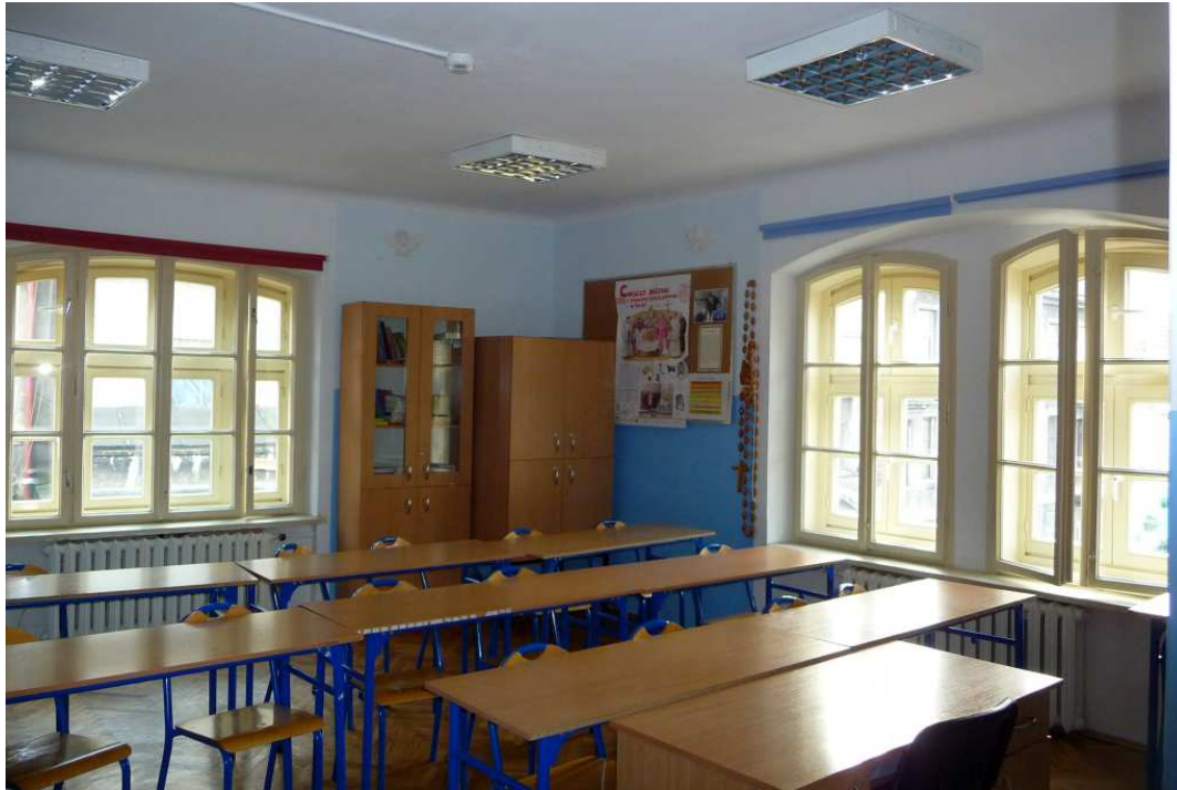
Fot. nr 120 (120-121). Oryginalne okna sali. (05.02.2018)
