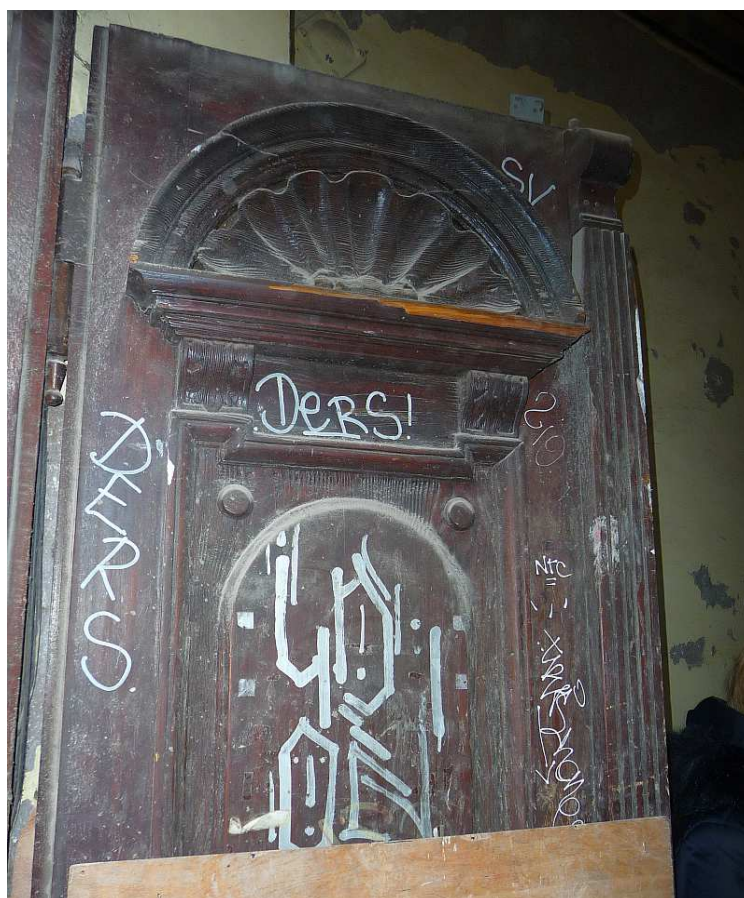
Fot. nr 69. Skrzydło drzwi wejściowych. (22.01.2018)
