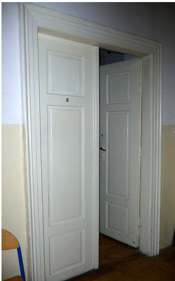
Fot. nr 106 (106-107). Solidne odrzwia i oryginalne drzwi wejściowe do sali na parterze północnego skrzydła budynku. (05.02.2018)
