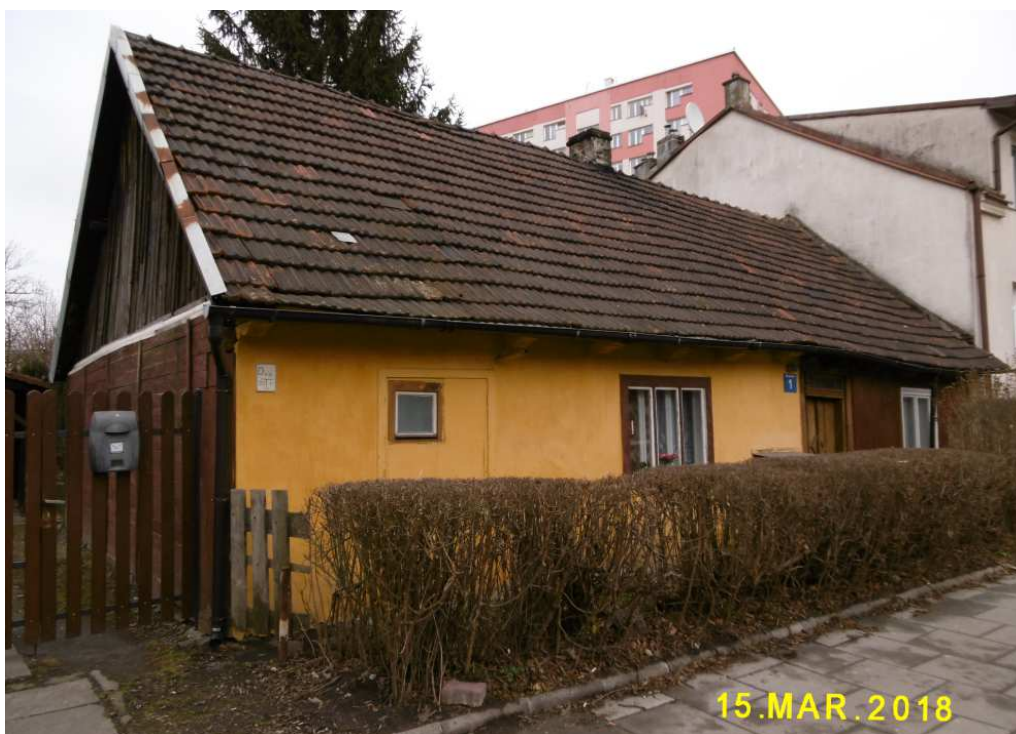
Fot. nr 248 (248-249). Relikt dawnej zabudowy Dąbia, zapewne pochodzący gdzieś z przełomu XIX i XX wieku, z ulicy Na Szaniec 1.
