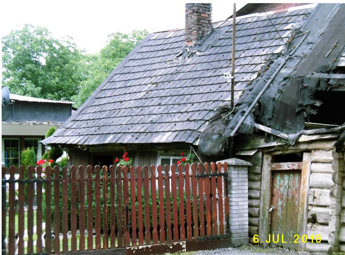
Fot. nr 277a. Ciągłe zamieszkały fragment. Z prawej oryginalne drzwi ruiny.
