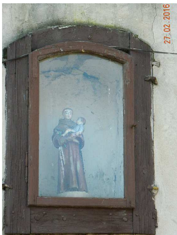
Fot. nr 131. Kapliczka pod dachem ściany bocznej.
