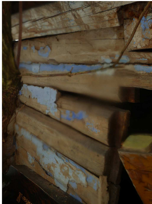
Fot. nr 260. Poprzecznie belkowana faktura ściany zewnętrznej, na której znać ślady bielonej gliny, która stanowiła jej wymurówkę. (24.01.2018)
