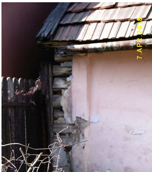
Fot. nr 303. Drewniana faktura w narożu chałupy, która jest ukryta pod bieloną kiedyś warstwą zewnętrznego gliny.
