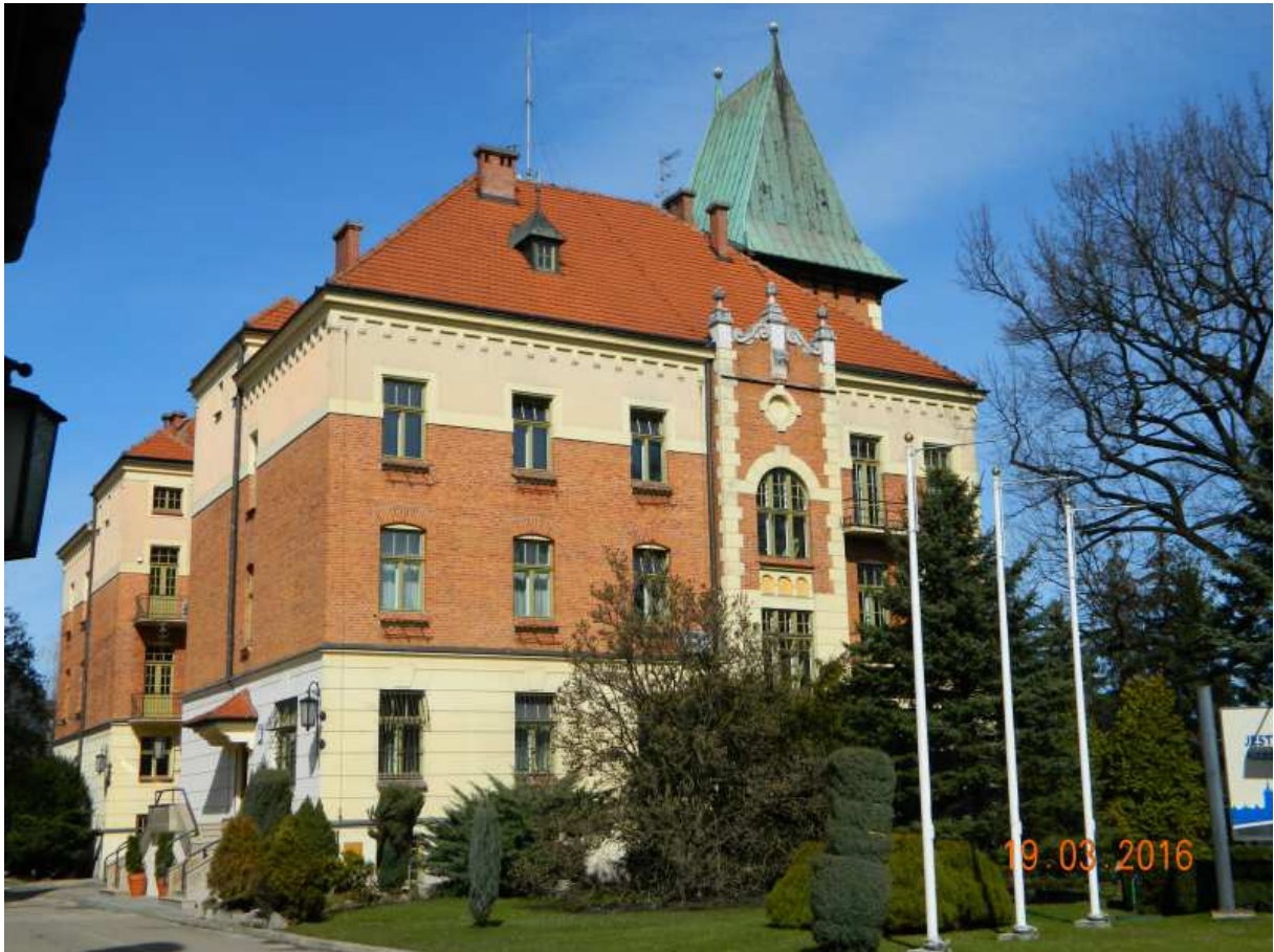
Fot nr 14 (14-16). „Dworzec Wodociągowy” czyli dawny budynek Miejskiego Wodociągu Pompowego im. Franciszka Józefa, dziś siedziba MPW, przy ulicy Senatorskiej 1 i jego detale. Ten okazały gmach i przylegające do niego budynki powstał w latach 1911-13 wg projektu Jana Rzymkowskiego.
