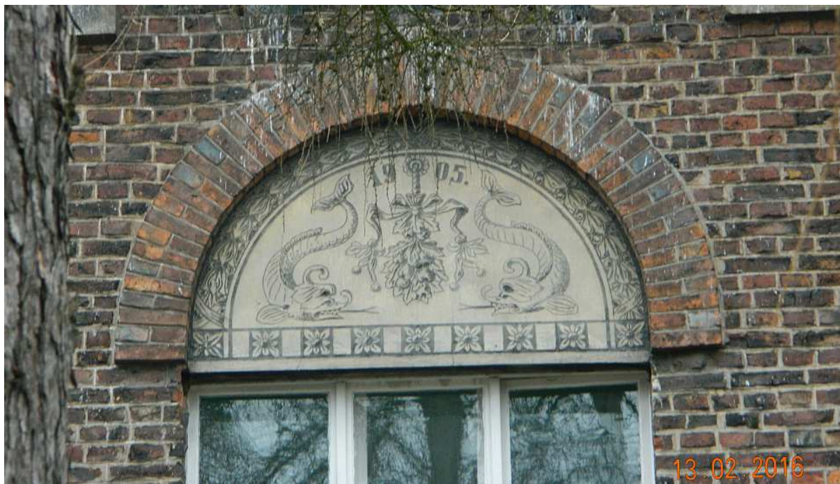
Fot. nr 222. Dekoracja sgraffitowa nad oknem I piętra ryzalitu. (1905)
