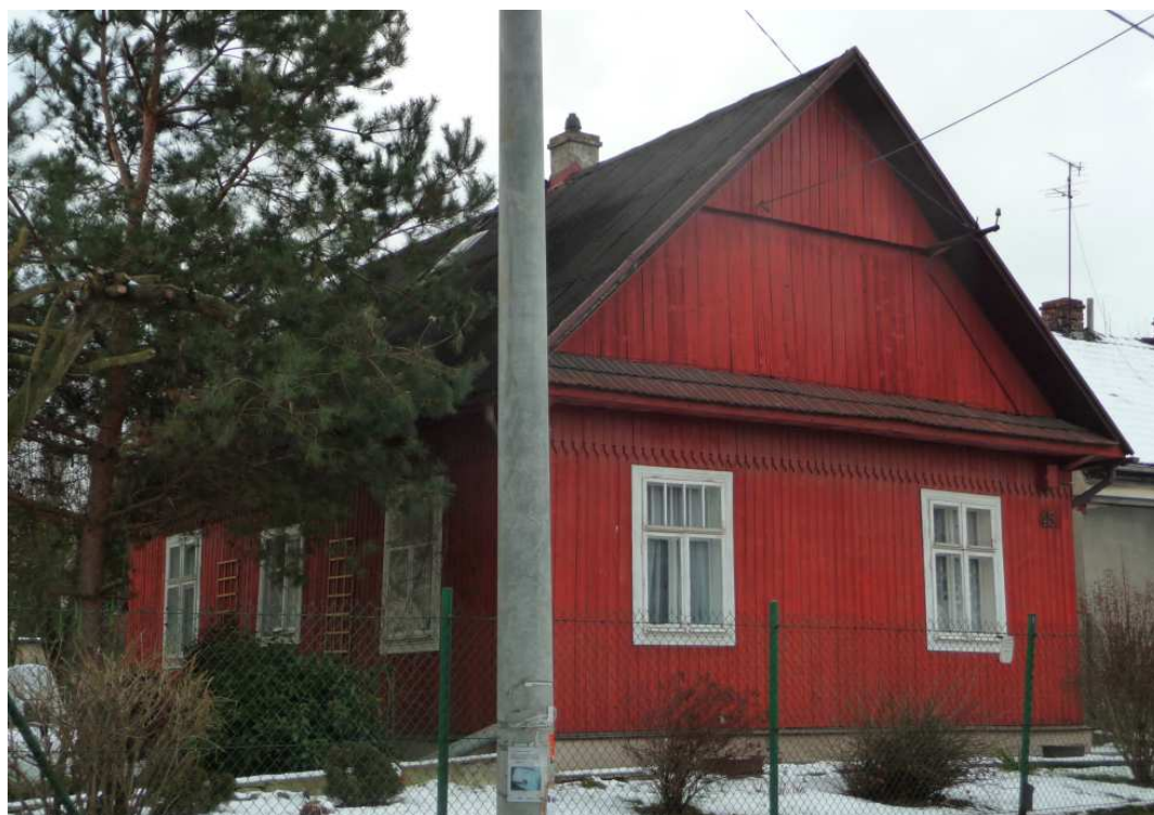
Fot. nr 267 (267-268). Ujęcia bliskiemu oryginałowi domu z przełomu I i II ćwierci XX wieku, zlokalizowanego przy ulicy Fatimskiej 46. W pierwotnej wersji pośrodku ściany ogrodowej znajdował się zapewne zdobiony, oszklony ganek. (17.01.2018)
