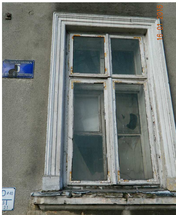
Fot. nr 20. Oryginalne okno z cienkimi szprosami i kwaterami otwieranymi na zewnątrz.
