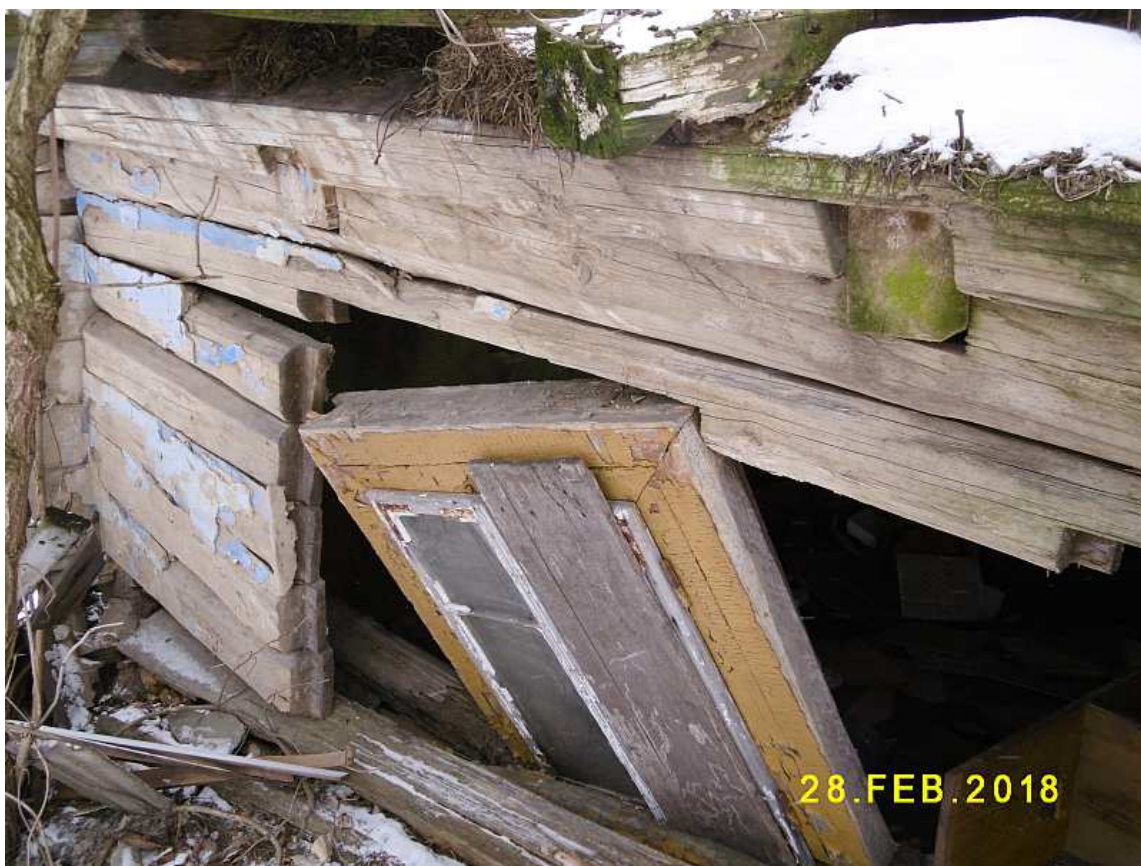
Fot. nr 259. Dawne okno dwukwaterowe, czteropolowe.
