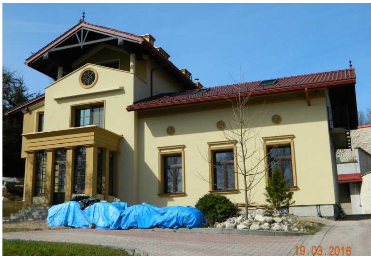
Fot. nr 138. Fasada mocno zmodernizowanej w stosunku do oryginału willi Pod Lipkami.
