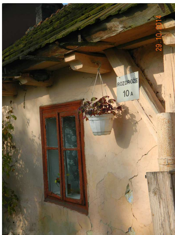
Fot. nr 301 (301-302). Oryginalne okno: dwukwaterowe, czteropolowe, typowe dla chałup z przełomu XIX i XX wieku.
