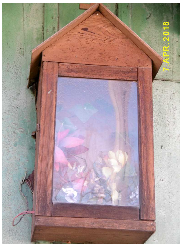
Fot. nr 297. Pusta już kapliczka na fasadzie domu spod nr 21, która oprócz drewnianej boazerii na fasadzie stanowi ostatnie pozostałości po dawnym oryginale.
