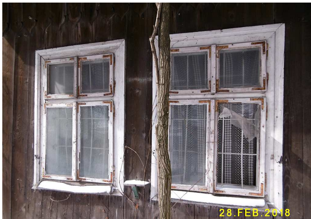
Fot. nr 256. Oryginalne okna fasady.
