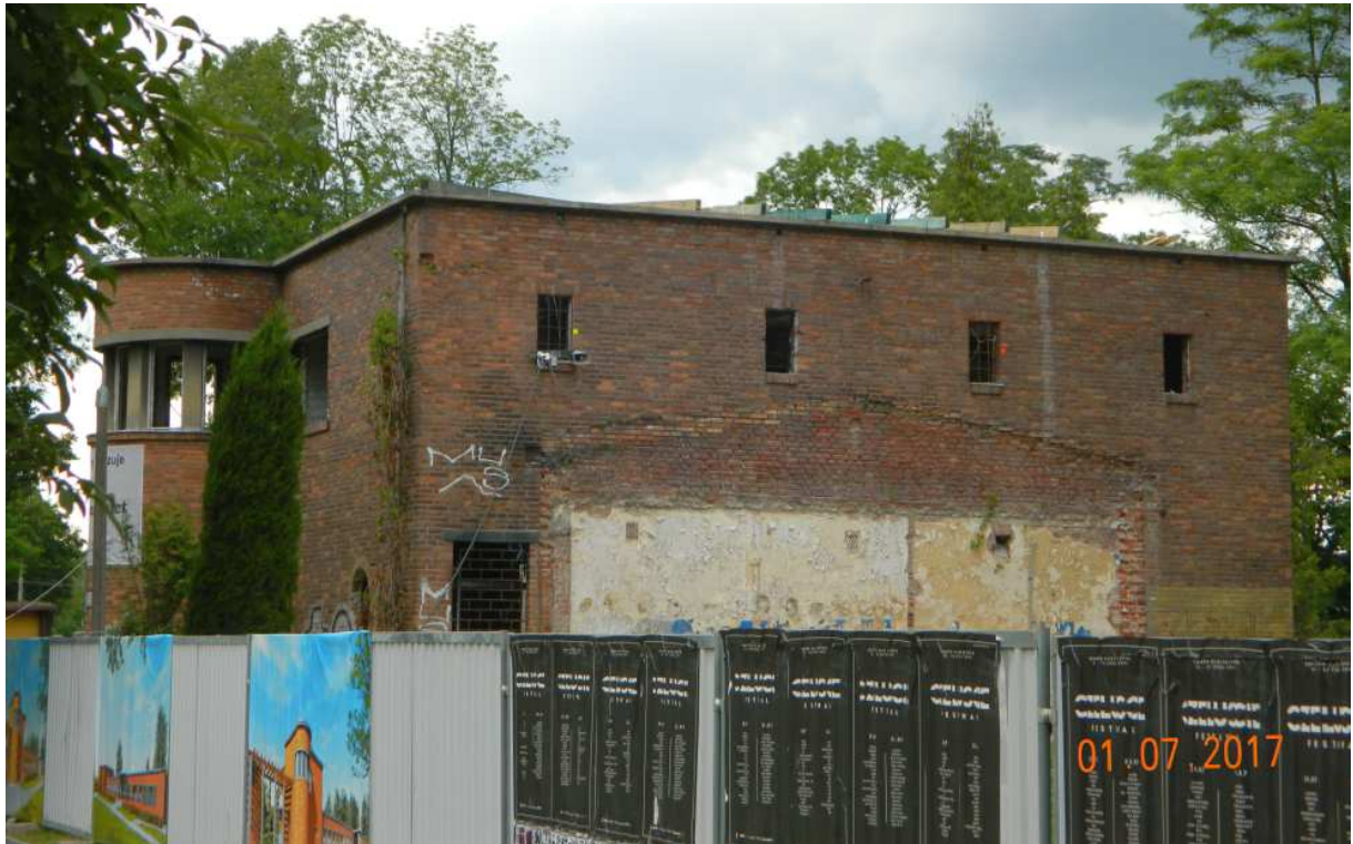
Fot. nr 4. Remontowany budynek mieszkalny przy zespole dawnych basenów i budowane od nowa pomieszczenia dawnych szatni.
