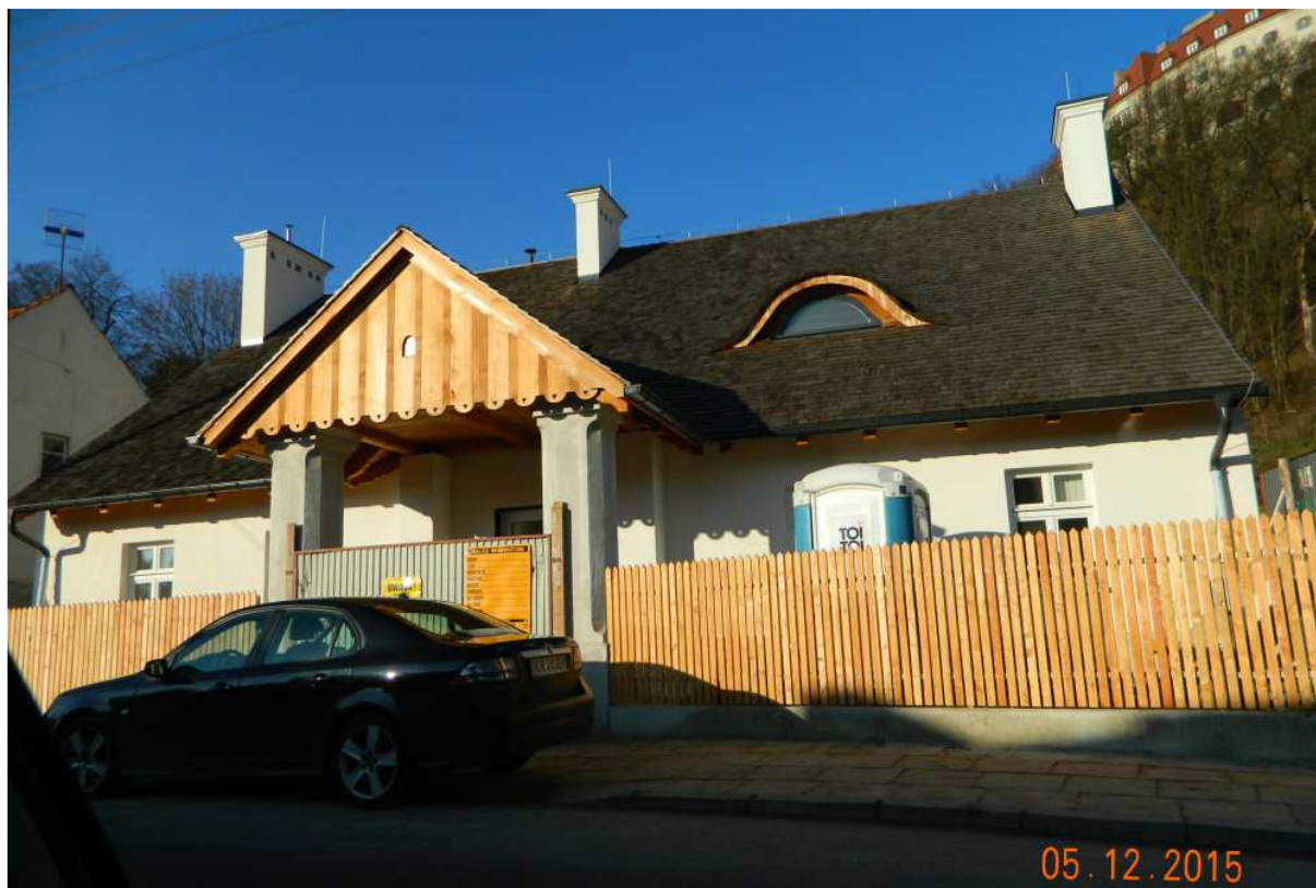
Fot. nr 239. Odtworzony portyk znów dodaje uroku fasadzie tego obiektu.
