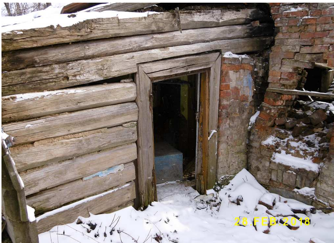
Fot. nr 258 (258-260). Detale tylnej części, widoczne z ulicy. Tu odrzwia we wnętrzu dawnej chałupy.
