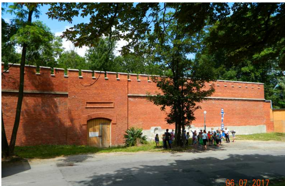
Fot. nr 215 (215-216). Zrekonstruowana ściana wewnętrzna bastionu nr II.
