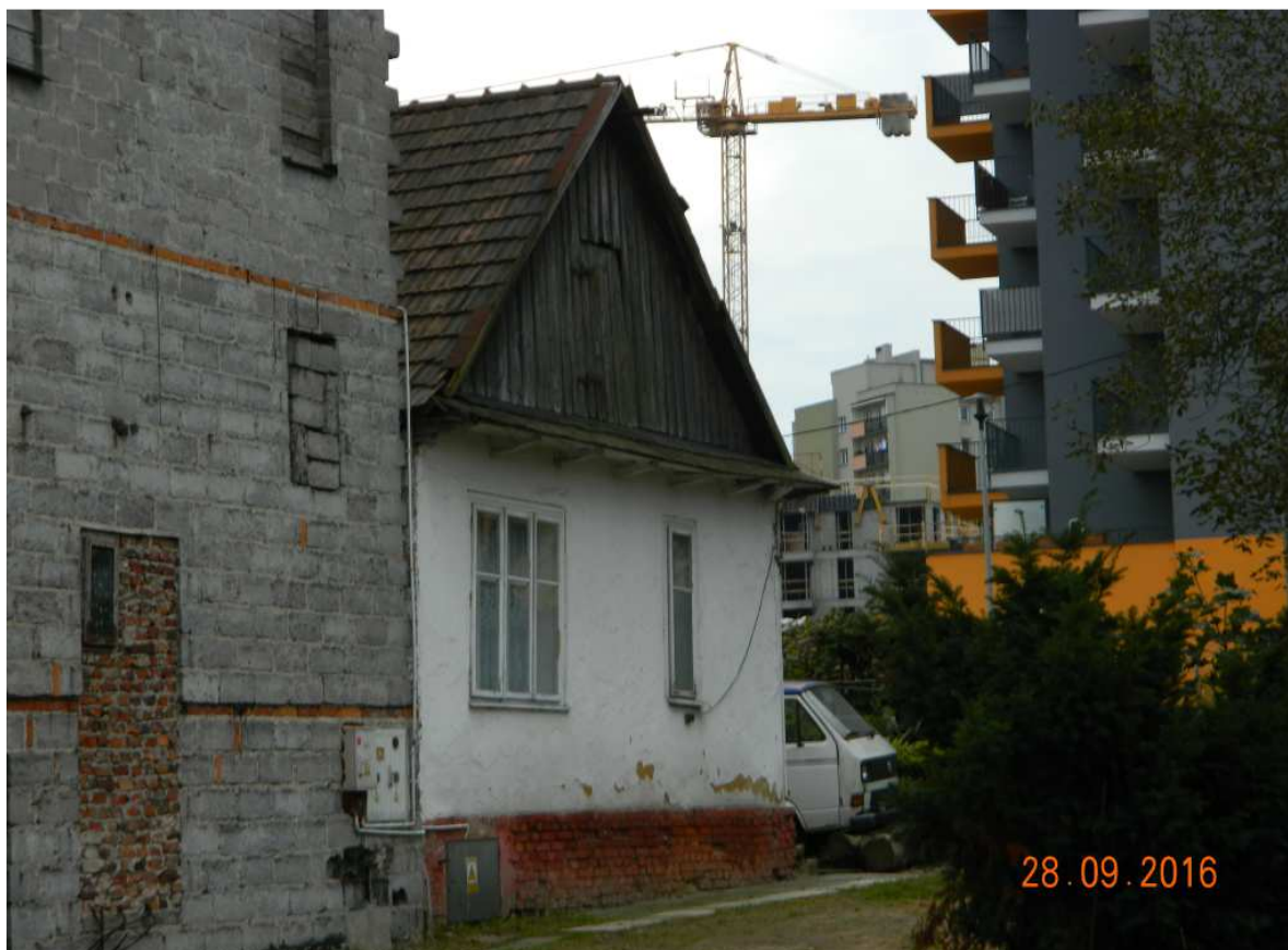
Fot. nr 309. Ściana boczna domu z ulicy Wielickiej 251, w niej oryginalne, sześciopoleowe okno, którego boczne kwatery są otwierane na zewnątrz i zabezpieczane przed zamknięciem przy użyciu wahlowych haczyków, co było standardem w takich chałupach.
