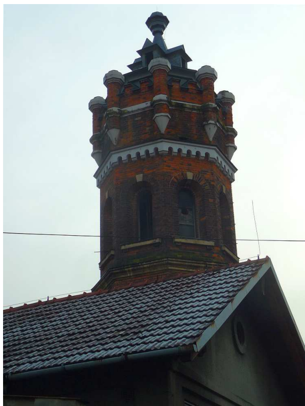
Fot. nr 313. Zwieńczenie wieży. (10.01.2018)
