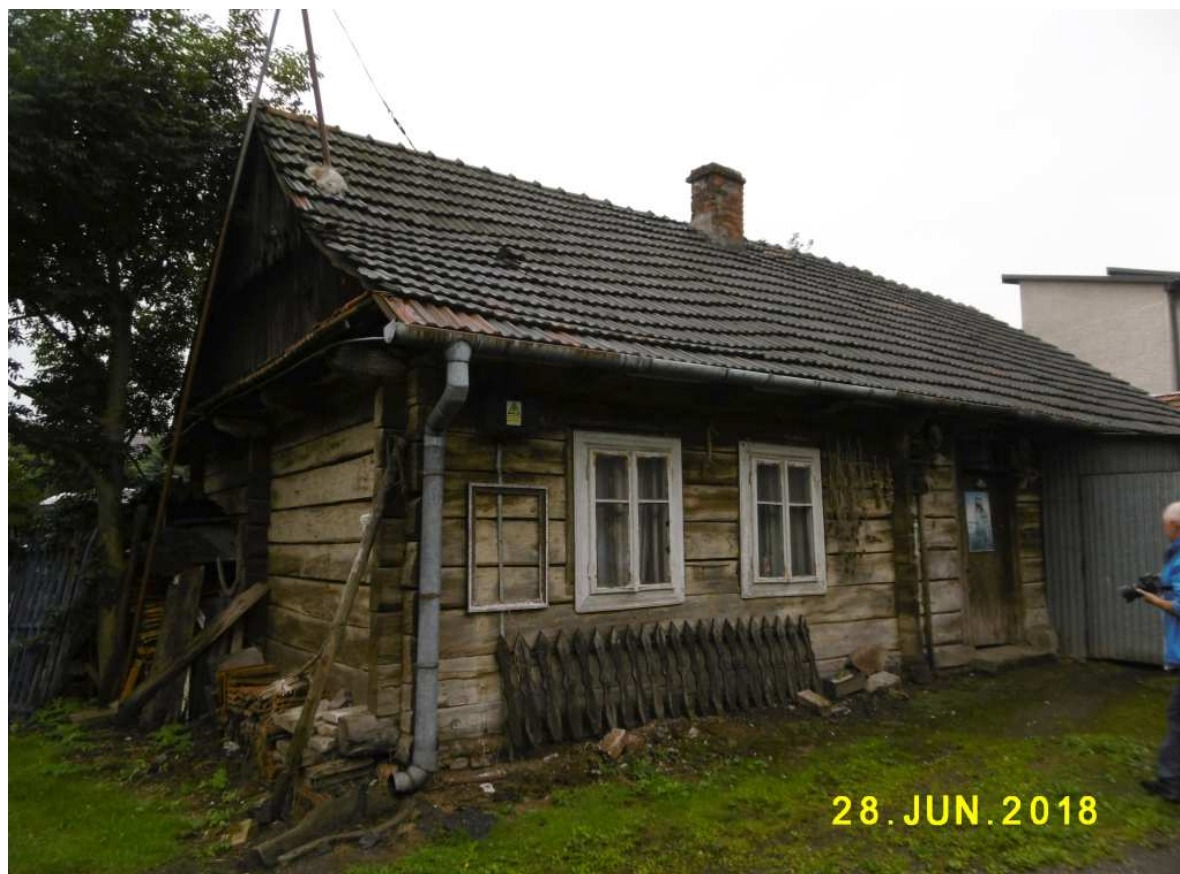
Fot. nr 270 (270-279). Pochodząca z pocz. XX wieku chałupa z ulicy Kaczeńcowej 3 (dawniej Nowa Huta 136) i jej detale oraz otoczenie we fragmencie od strony podwórka.
