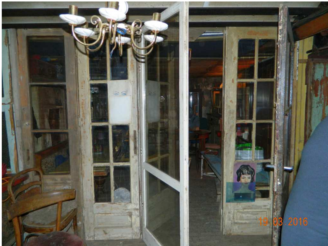
Fot. nr 186 (186-202). Część druga – kuchenna – pomieszczenia, usytuowana za przeszklonymi drzwiami mozikowymi.
