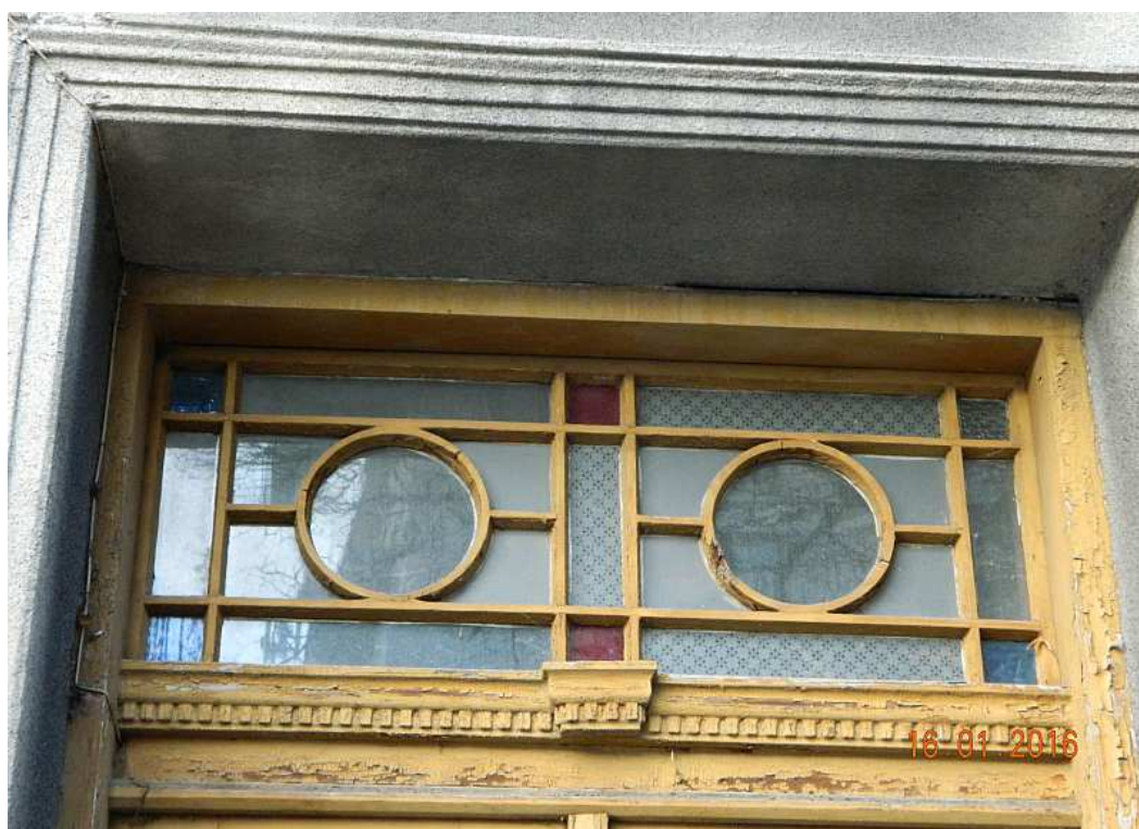
Fot. nr 21. Oryginalne okno mozaikowe nad drzwiami wejściowymi.
