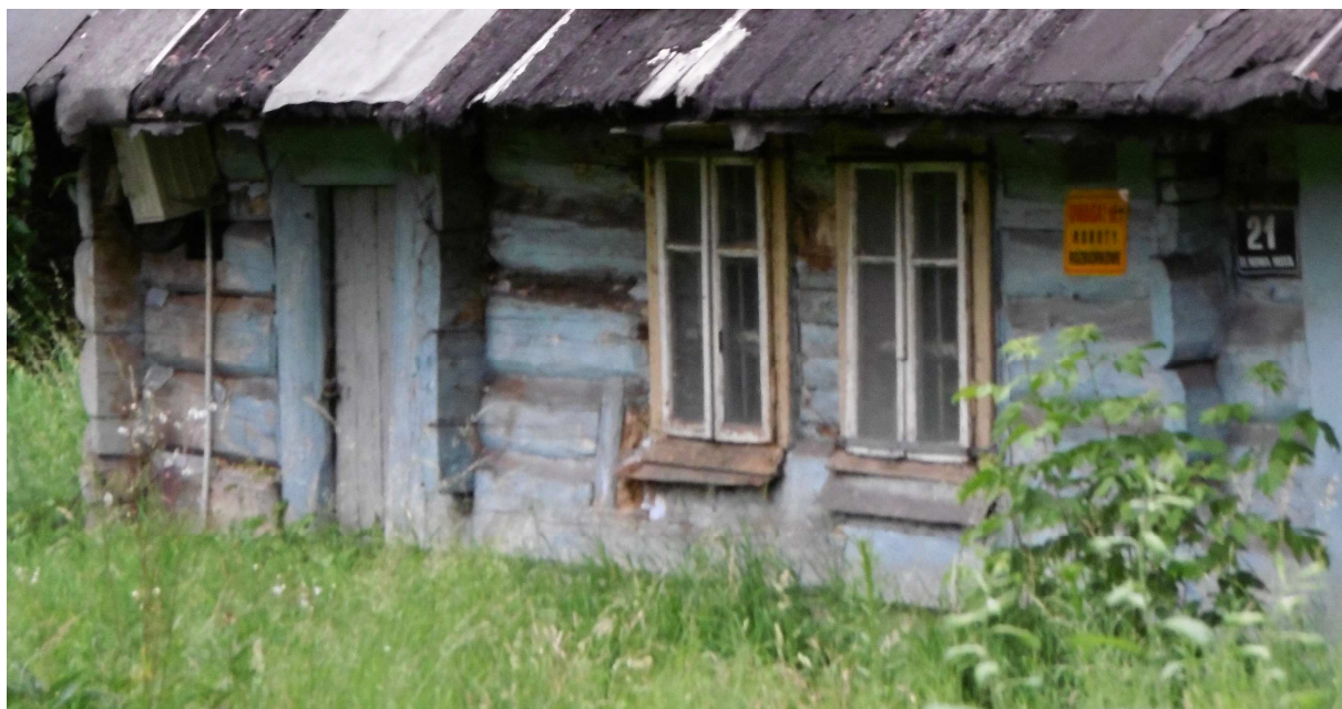
Fot. nr 279a. Oryginalne belkowanie, okna i drzwi fasady.
