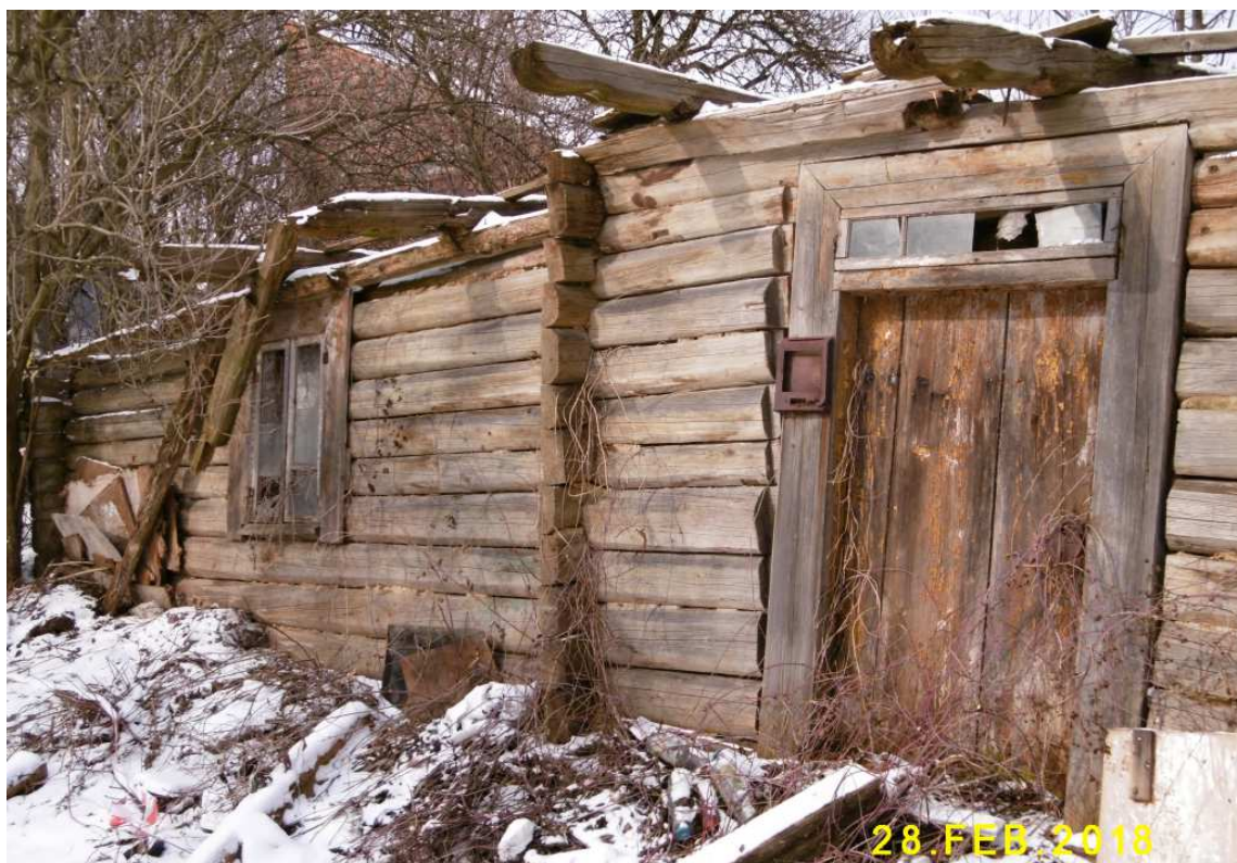
Fot. nr 265. Lewa część fasady.
