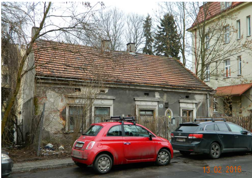
Fot. nr 114 (114-120). Ostatnie chwile dawnego domu pani Chwałowej spod nr 31, który powstał gdzieś na przełomie XIX i XX wieku. Dziś to już tylko wspomnienie. A przecież jego fasada posiadała wiele ciekawych detali.
