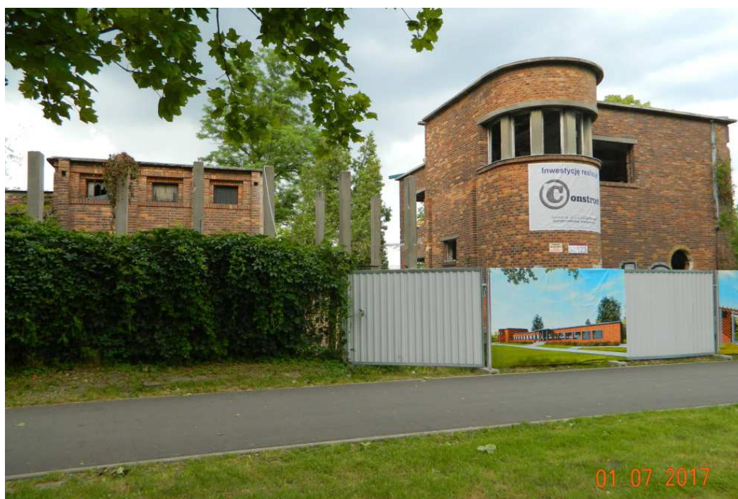
Fot. nr 7 (7-8). Budynek mieszkalny w różnych fazach remontu.
