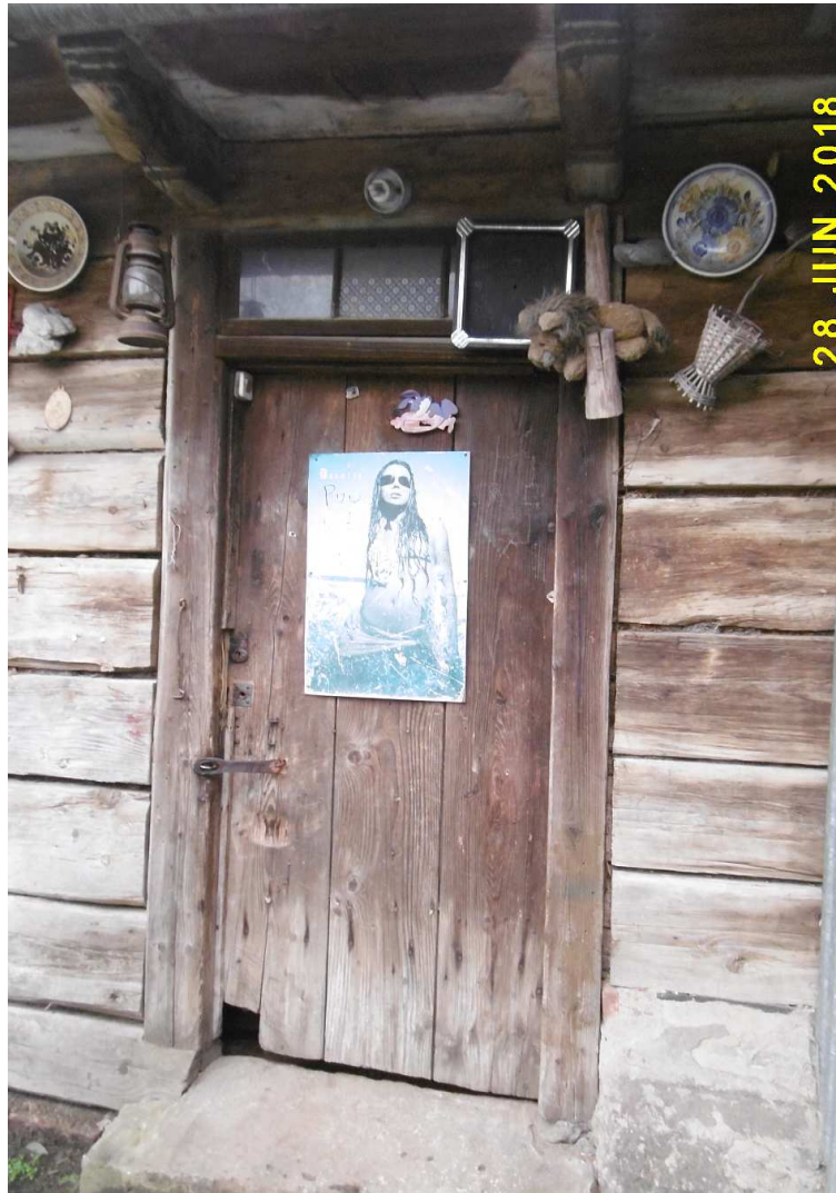
Fot. nr 272 (272-272e). Detale w części od strony podwórka.
