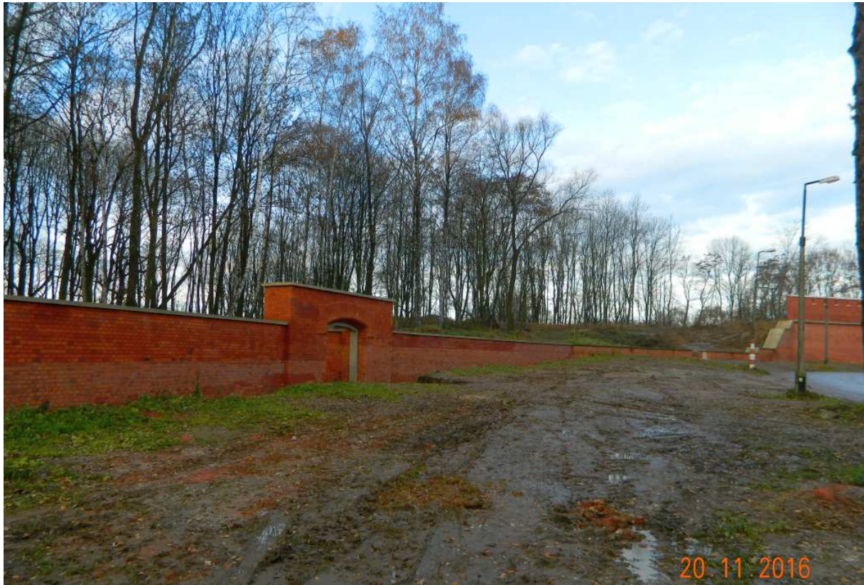
Fot. nr 212 (212-216). Niemal ukończona rekonstrukcja kurtyny I-II fortu Kościuszko. Pośrodku replika dawnej bramy wjazdowej do bastionu nr I.
