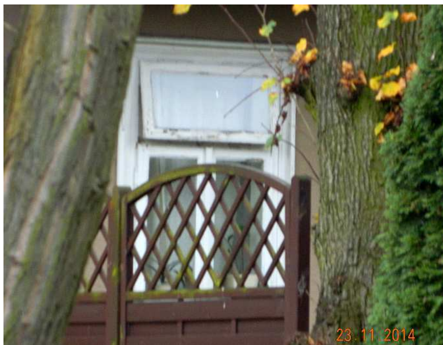
Fot. nr 284. Oryginalne, trókwaterowe okno w lewym fragmencie fasady.
