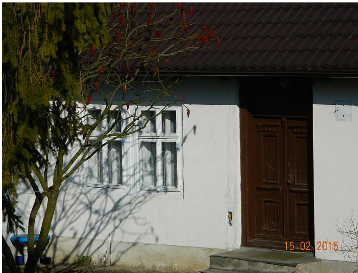
Fot. nr 13. Oryginalny fragment domu: drzwi z klamką i czterokwaterowe okna o cienkich szprosach.
