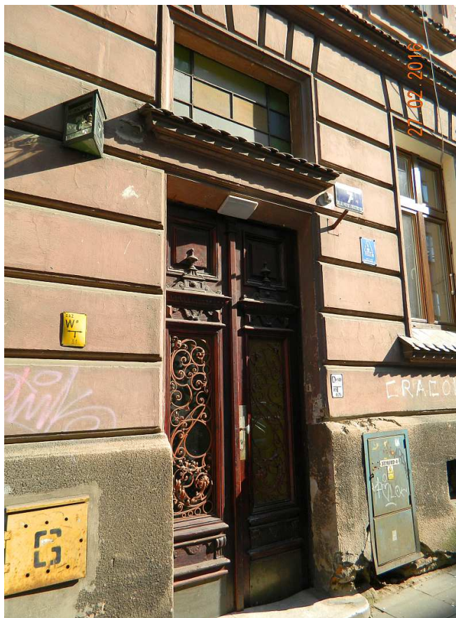
Fot. nr 28. Oryginalne drzwi wejściowe, a nad nimi mozaikowe okno.
