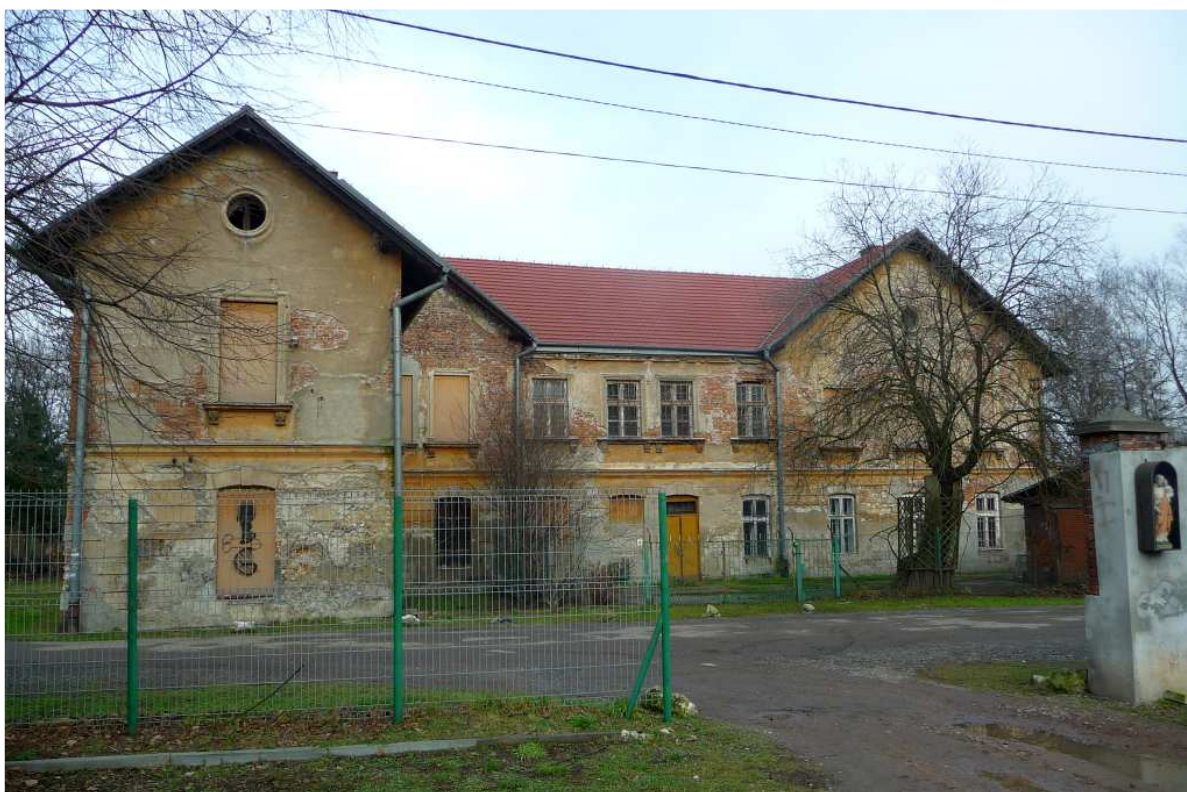
Fot. nr 315. Jak będzie w przyszłości wyglądał opuszczony dziś budynek „rządcówki” przy pałacu Wodzickich-Jerzmanowskich, który w tym kształcie powstał pod koniec XIX wieku. Widok na fasadę od strony ulicy Górników 29, w której pozostało już tylko jedno oryginalne okno o cienkich szprosach (trzecie od prawej na parterze). (10.01.2018)
