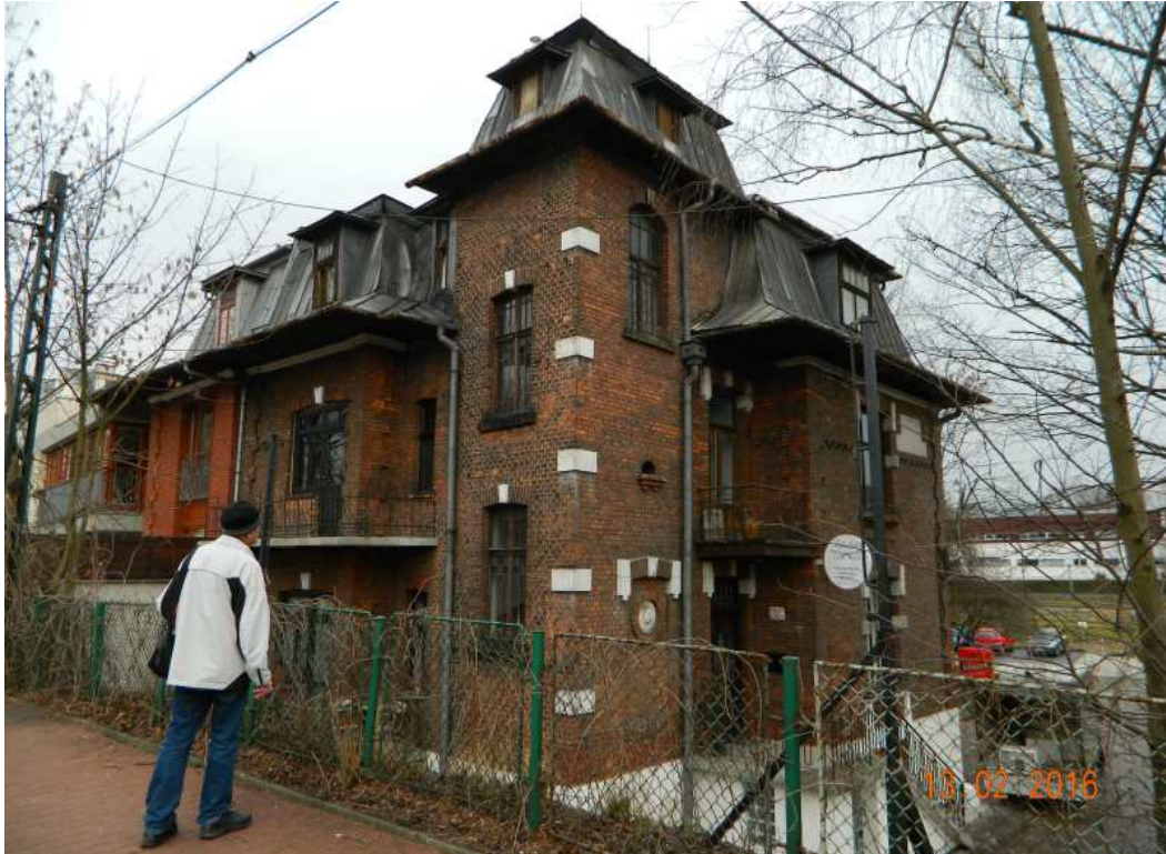
Fot. nr 107. Budynek wraz z ogrodem, który powstał w roku 1911 wg projektu Józefa Wilczyńskiego i Alfreda Kramarskiego
