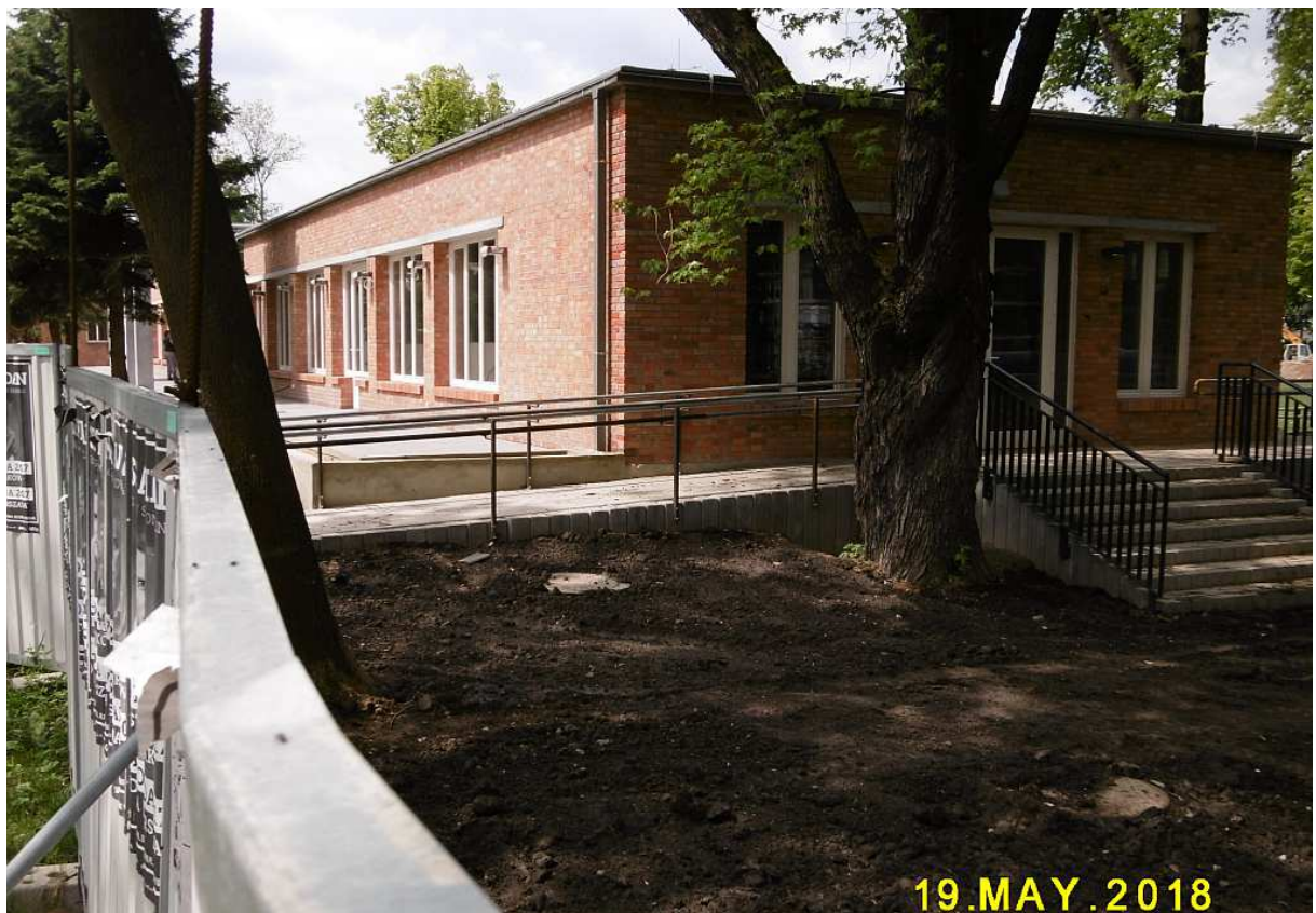
Fot. nr 5 (5-6). Gotowy budynek dawnych szatni.
