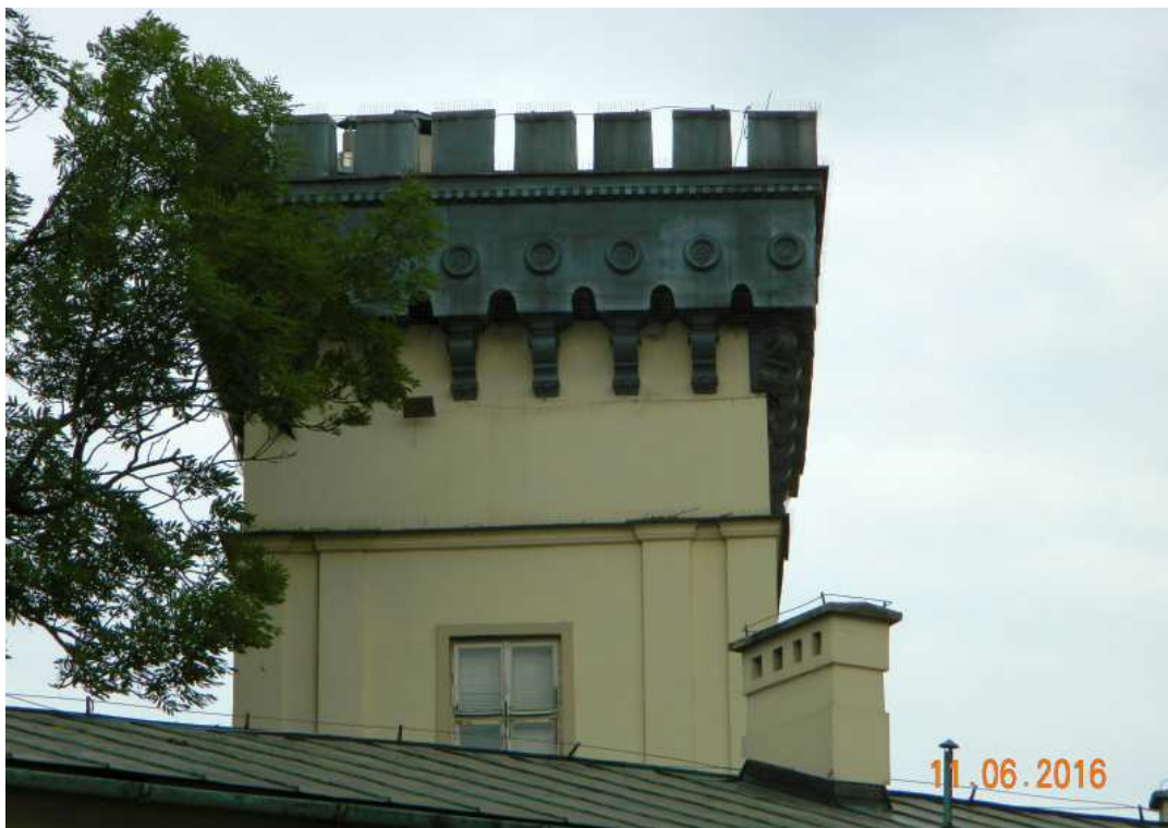
Fot. nr 282. Hełm romantycznej wieży.
