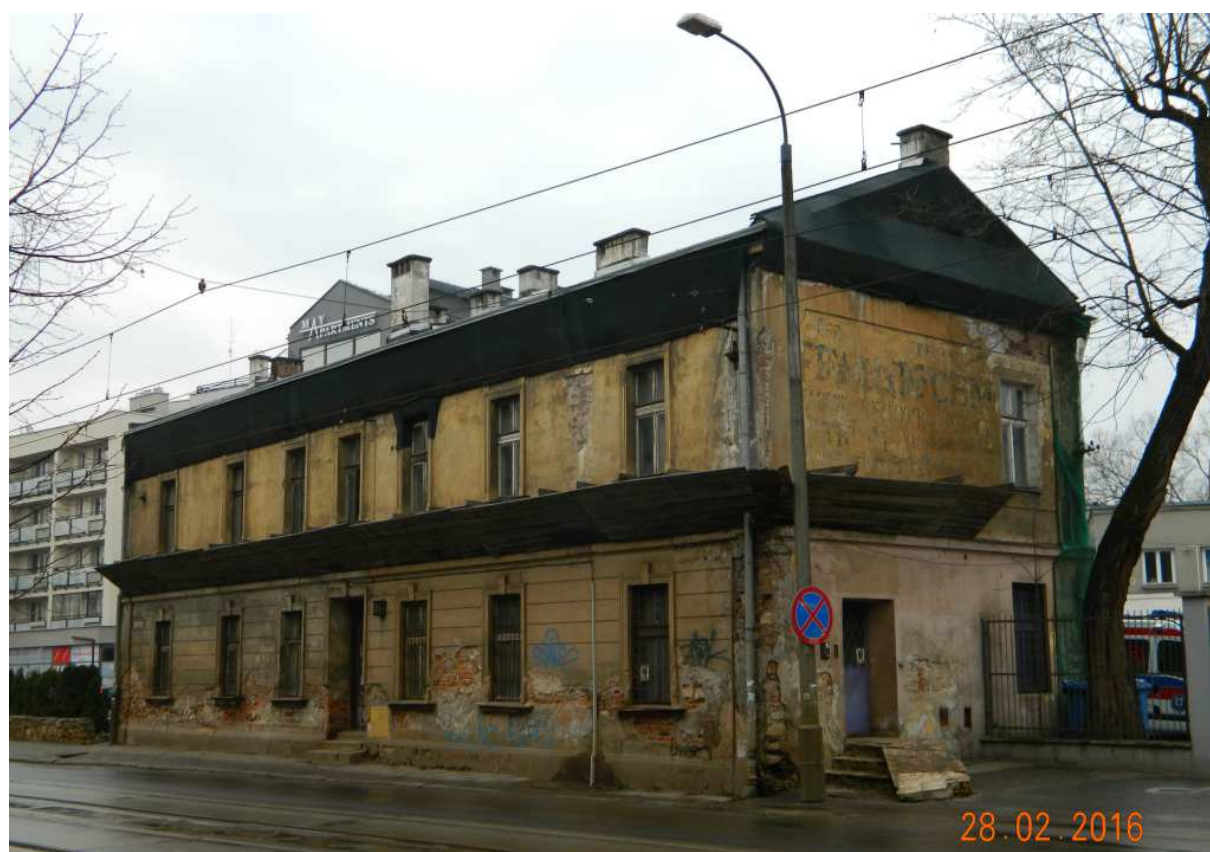
Fot. nr 103 (103-104). Dom spod nr 51, który od kilku lat jest pustostanem.
