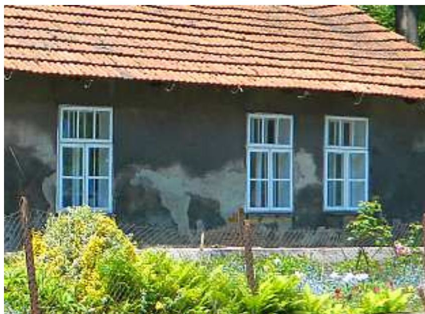
Fot. nr 253. Oryginalna stolarka okienna sprzed około 90 lat. Są to charakterystyczne, trójkwaterowe podziały dla tego okresu.
