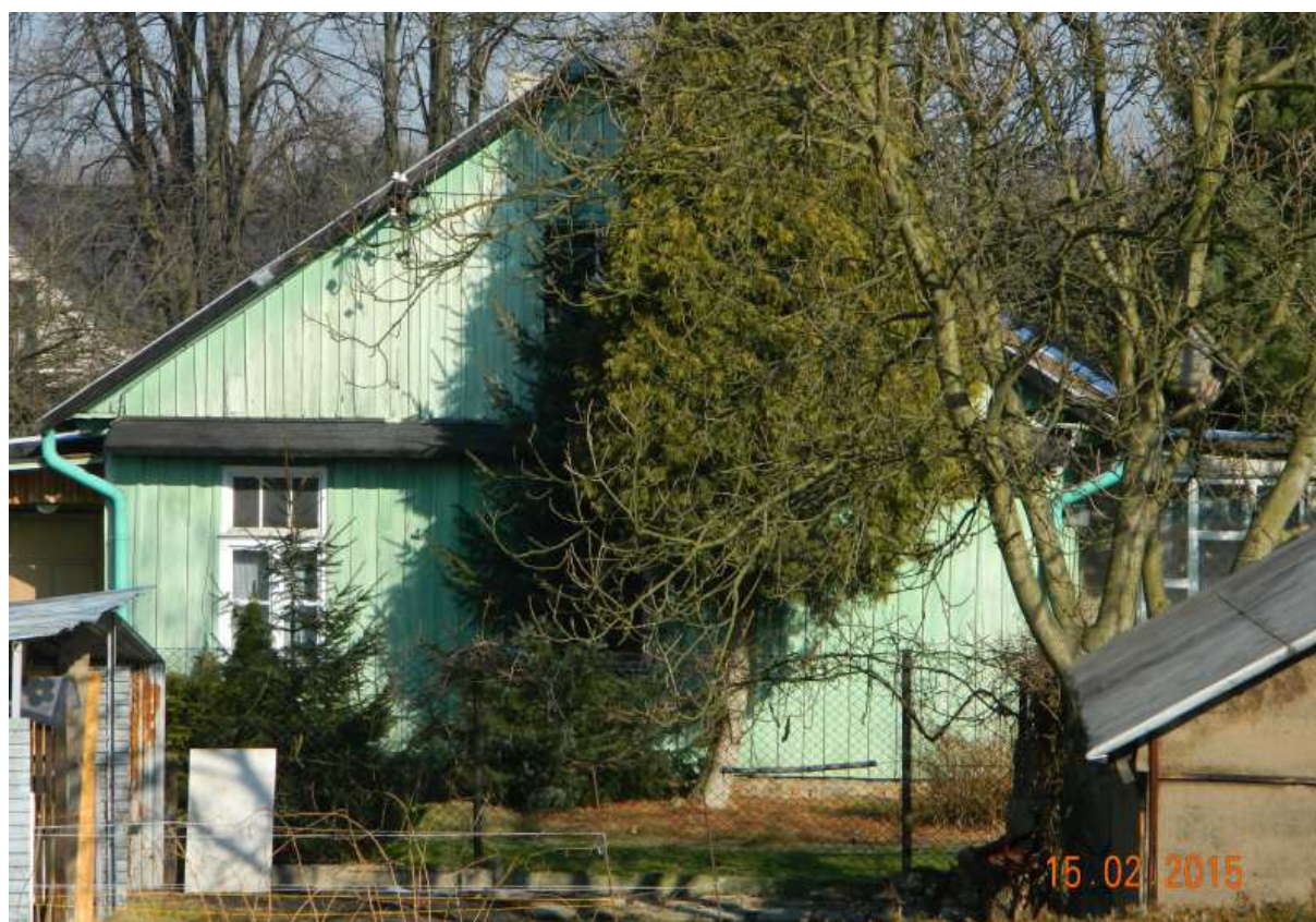
Fot. nr 11. Ostała jeszcze drewniana boazeria i oryginalne okno sprzed około 100 lat.
