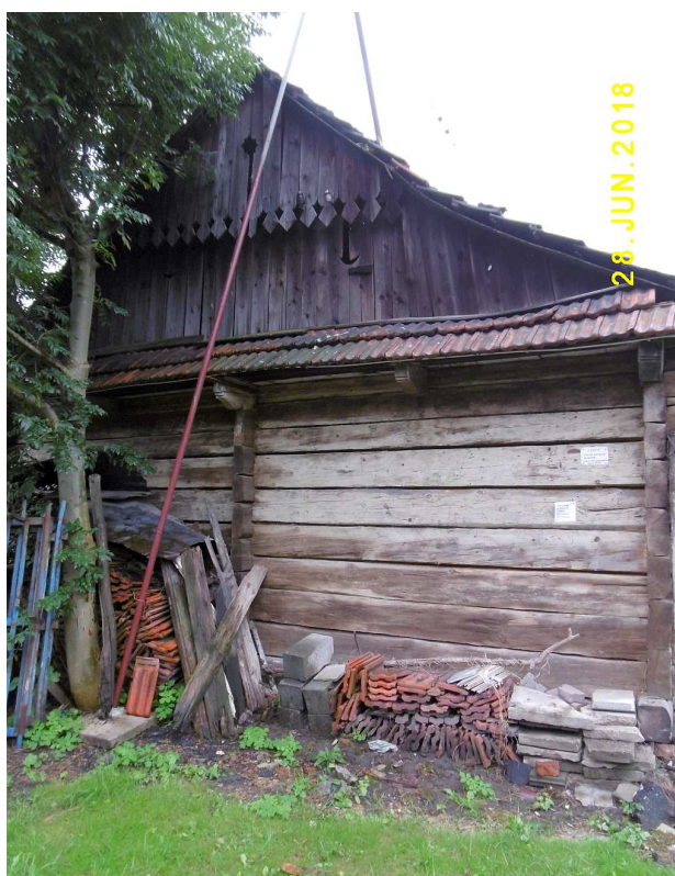
Fot. nr 271. Boczna ściana.
