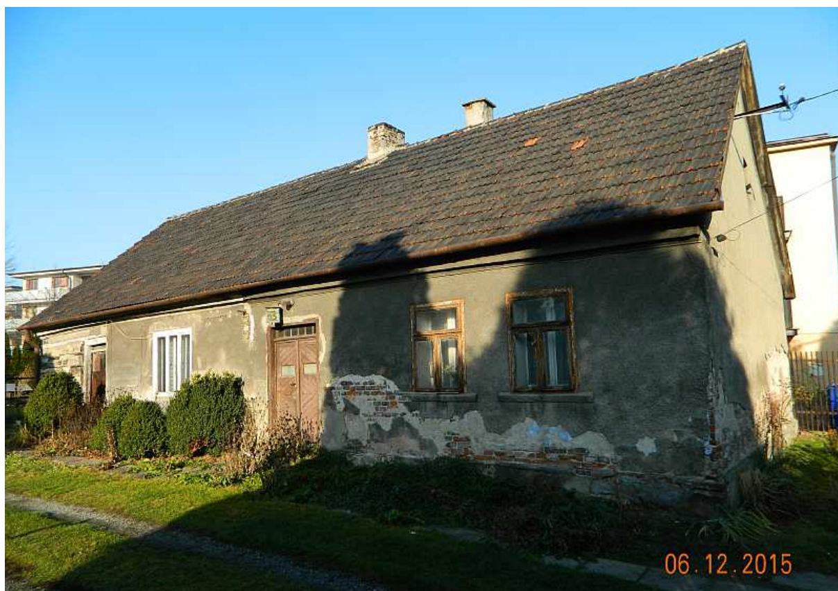
Fot. nr 306 (306-307). Stary płaszowski dom, kiedyś najpewniej drewniana chałupa, wybudowany zapewne gdzieś na przełomie XIX i XX wieku na co może wskazywać oryginalne belkowanie fasady, które ukazuje się po odpadnięciu tynku w lewym jego narożu. Okna z prawej, trójkwaterowe, pochodzą z przełomu I i II ćwierci XX wieku.
