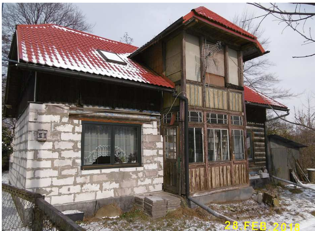
Fot. nr 266. Częściowo przebudowana willa z ulicy Kaczeńcowej 10. Prawe jej skrzydło może pochodzić z wcześniejszej fazy z początku XX wieku. Mozaikowy ganek mógł zostać dobudowany na przełomie I i II ćwierci XX wieku.
