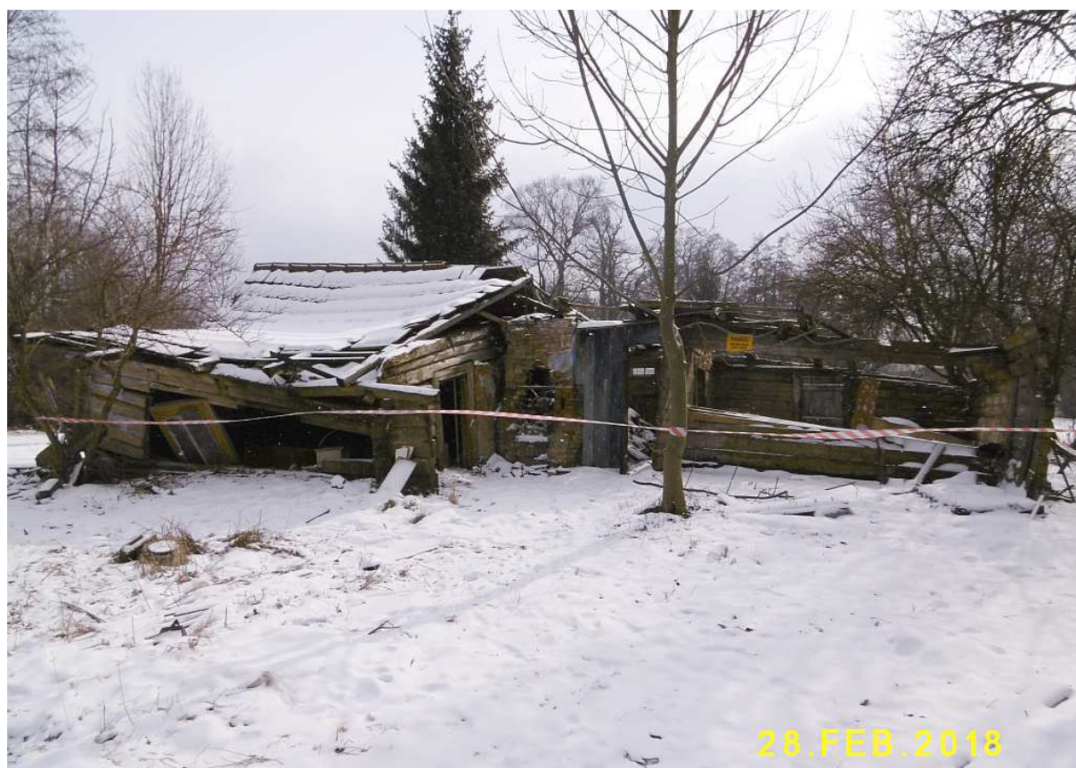
Fot. nr 257 (257-265). Ruina chałupy wybudowanej przy ulicy Kaczeńcowej 6 w roku 1898, co poświadcza napis na belce nośnej w jej środku. Zdjęcia pozostałości domu i zachowanych jeszcze jego detali.
