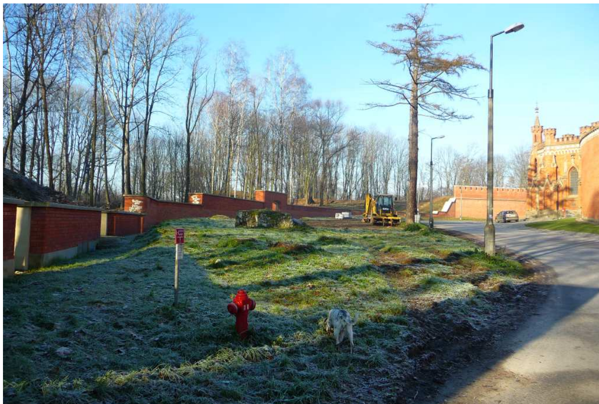
Fot. nr 214. Końcowy etap odtwarzania narysu kurtyny I-II. (26.12.2017)
