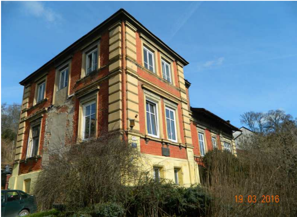
Fot. nr 134 (134-136). Daleka od przykładowego wyglądu willa z ulicy Ks. Józefa 29, w której w latach 1899-1910 (raczej nie do 1914) mieszkał Jacek Malczewski. Do obecnej postaci została przebudowana w 1914 roku.
