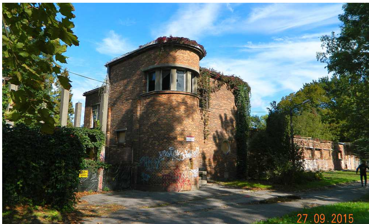
Fot. nr 2 (2-9). Szatnie i budynek mieszkalny w zespole dawnych basenów Cracovii w Cichym Kąciku na różnych etapach: przed w trakcie i po remoncie bądź odbudowie.
