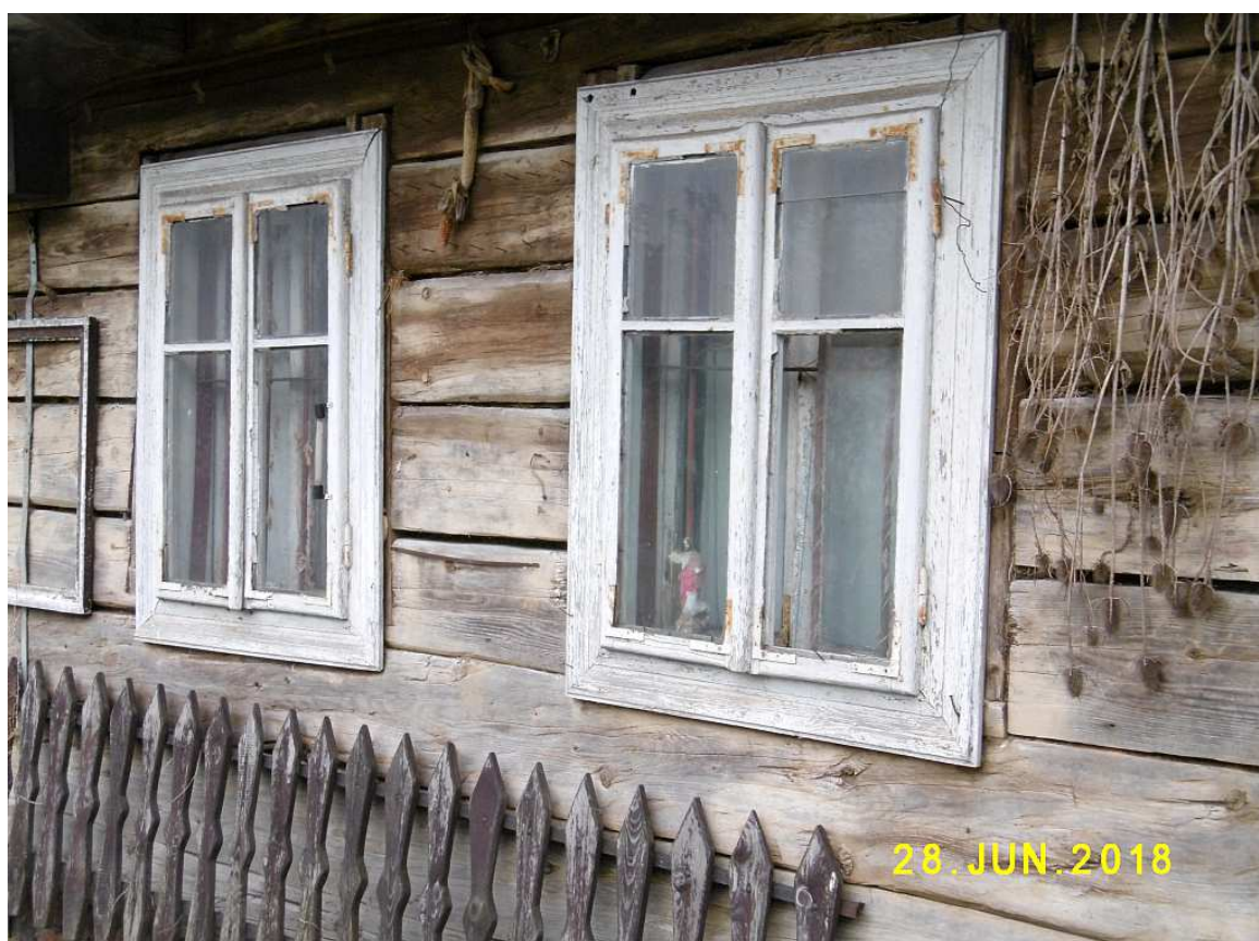
Fot. nr 272c. Oryginalne okna.
