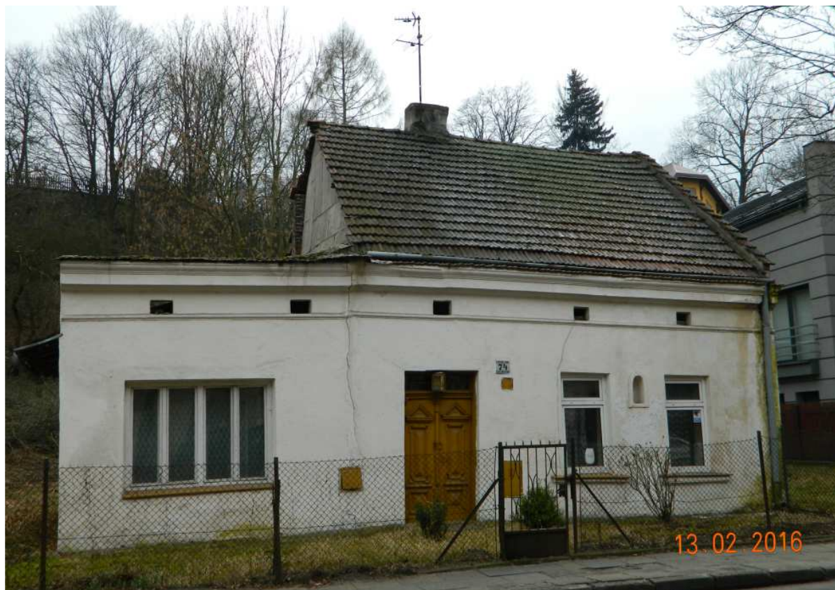
Fot. nr 125 (125-126). Ciągłe zamieszkały domek spod nr 74, w którym tylko drzwi są oryginalne. Wg Staszka Malika jego właściciele jeszcze w latach 90-tych wypasali krowy na Błoniach.
