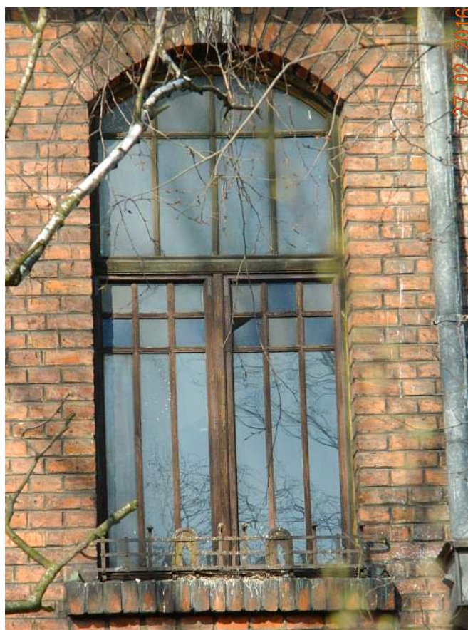
Fot. nr 109 (109-110). Oryginalne okna mozaikowe.
