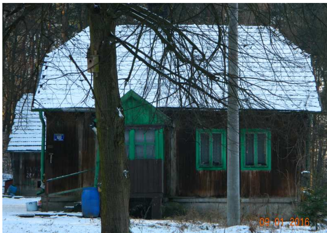
Fot. nr 285 (285-286). Przedwojenna leśniczówka z ulicy Do Groty 105, której przyszłość rysuje się w ciemnych barwach, bo ostatnio sprawiała wrażenie opuszczonej.
