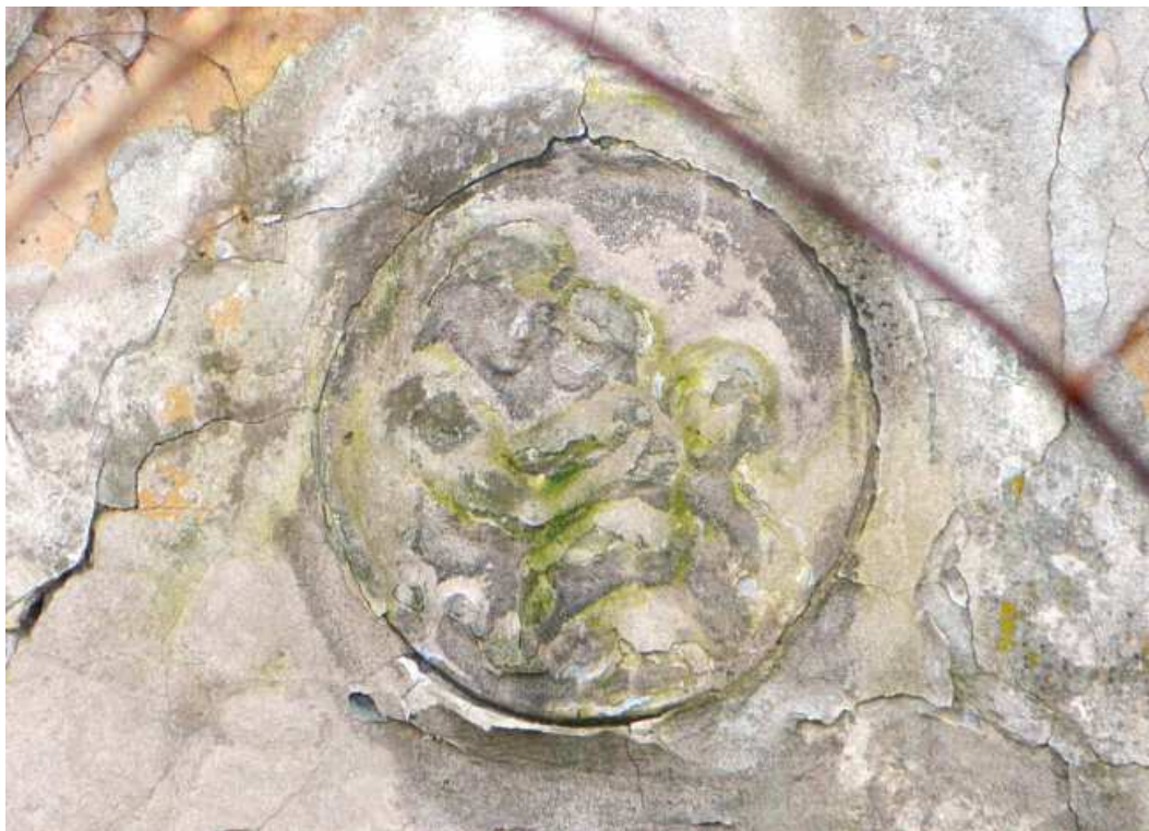
Fot. nr 218. Mocno już rozmyta płaskorzeźba Matki Boskiej z dzieciątkiem nad wejściem do domu, która miała go chronić przed przeciwnościami losu.
