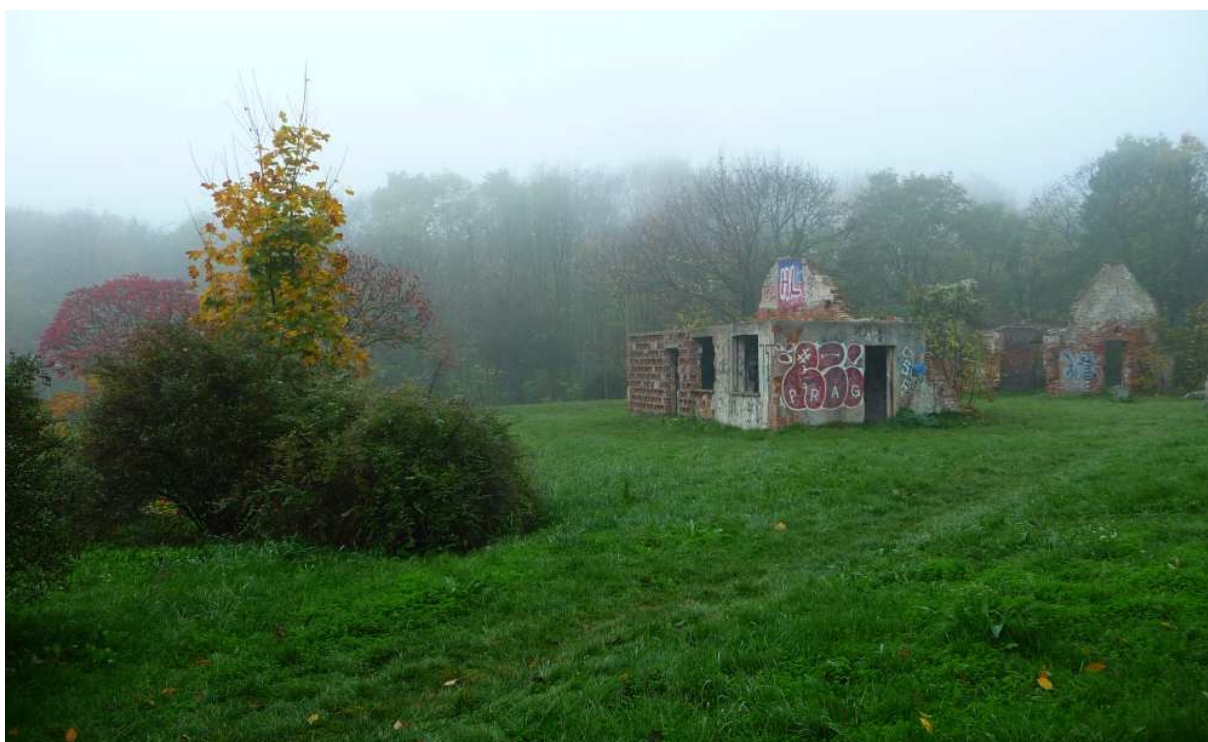
Fot. nr 29 (29-33). Ruina drugiej z prochowni, zlokalizowanej w sąsiedztwie ulicy Swoszowickiej. (22.10.2017)
