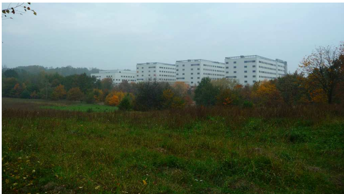
Fot. nr 281 (281-284). Kończy się budowa kompleksu szpitalnego UJ wzdłuż ulicy Jakubowskiego. (22.10.2017)
