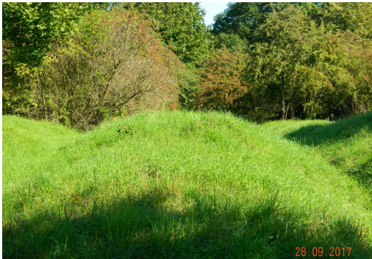
Fot. nr 84. Pozostałości wału ziemnego i fosy, który został zachowanego pomiędzy szańcami FS-21 i FS-22 z drugiego pierścienia Twierdzy Kraków.
