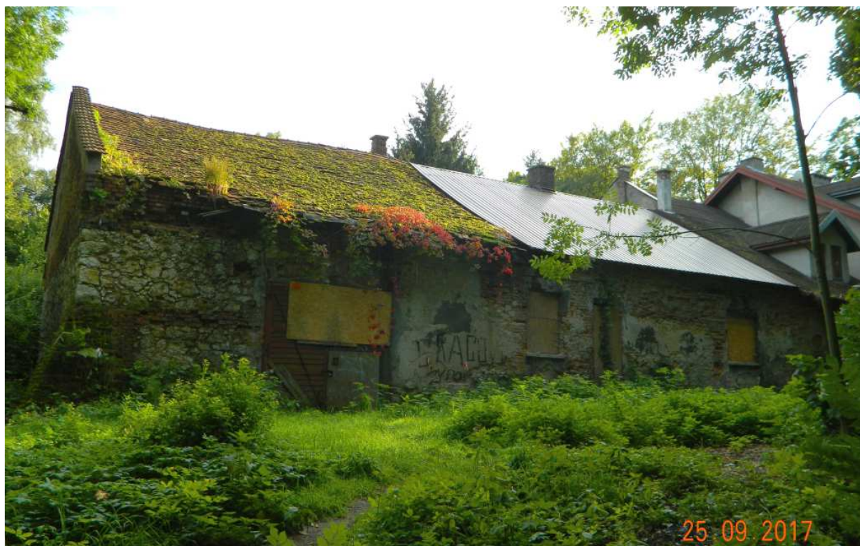
Fot. nr 106 (106-107). Ujęcia od strony stawu na dawną wozownię.
