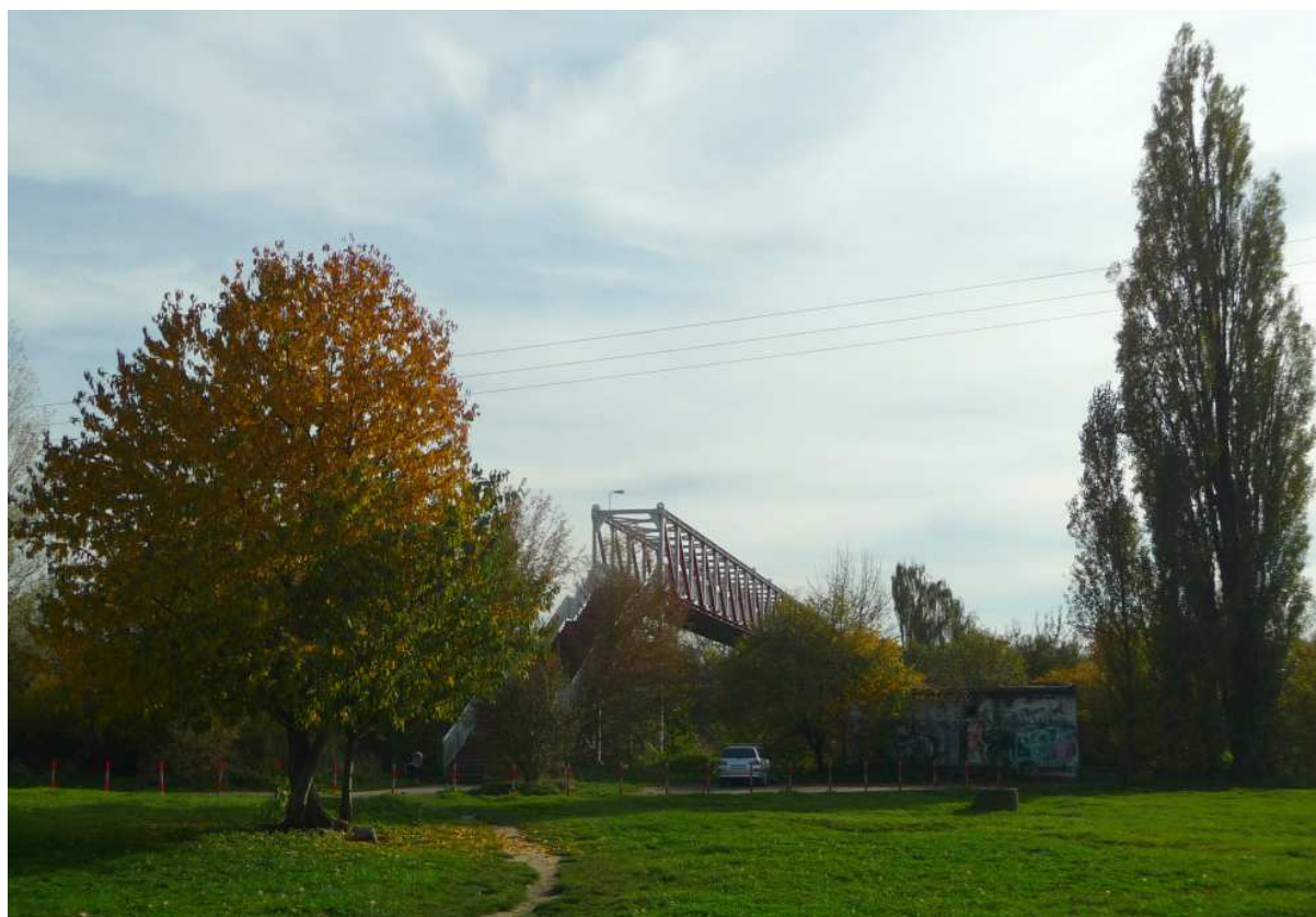
Fot. nr 143. Kładka kolejowa nad torami kolejowymi. (18.10.2017)
