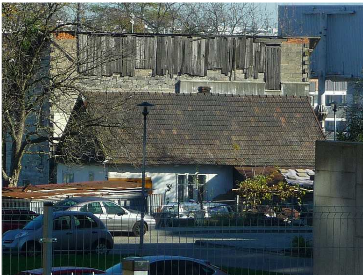
Fot. nr 163. Ujęcie od strony ulicy Polonijnej. (04.11.2017)
