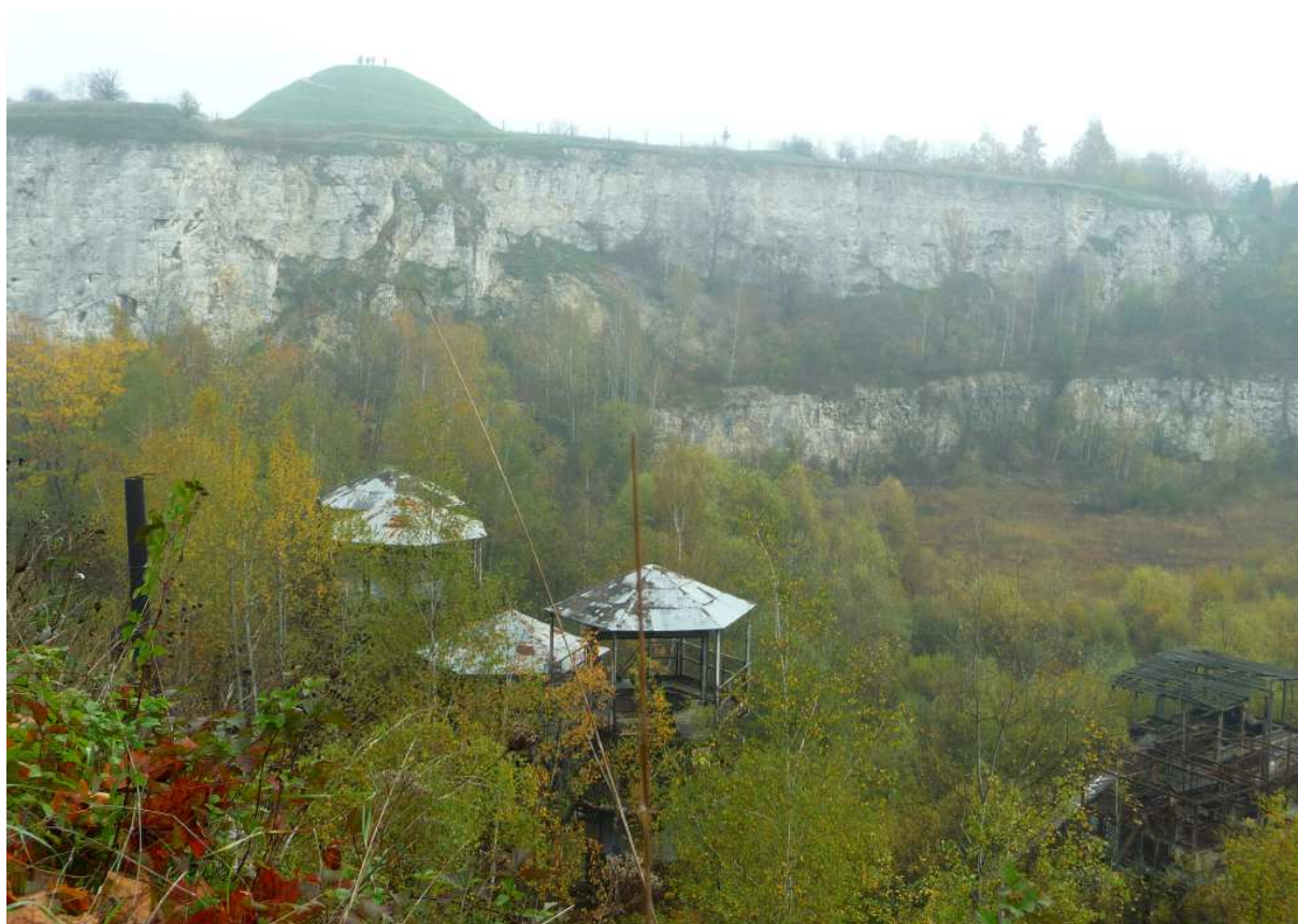
Fot. nr 39. Rdzewiejąca instalacja przeróbcza skały wapiennej. (22.10.2017)
