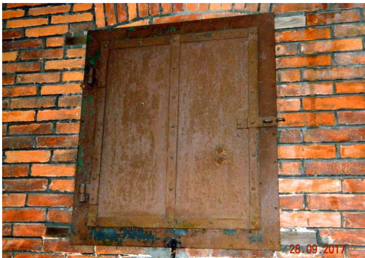
Fot. nr 43. Oryginalna osłona metalowa okna.
