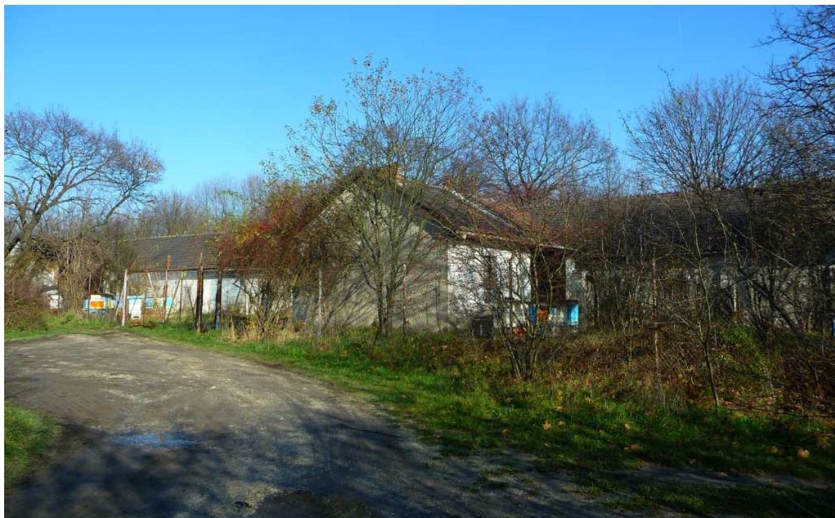
Fot. nr 28. Jeden z dwóch budynków starych prochowni na obrzeżu KL Płaszów. (16.11.2017)
