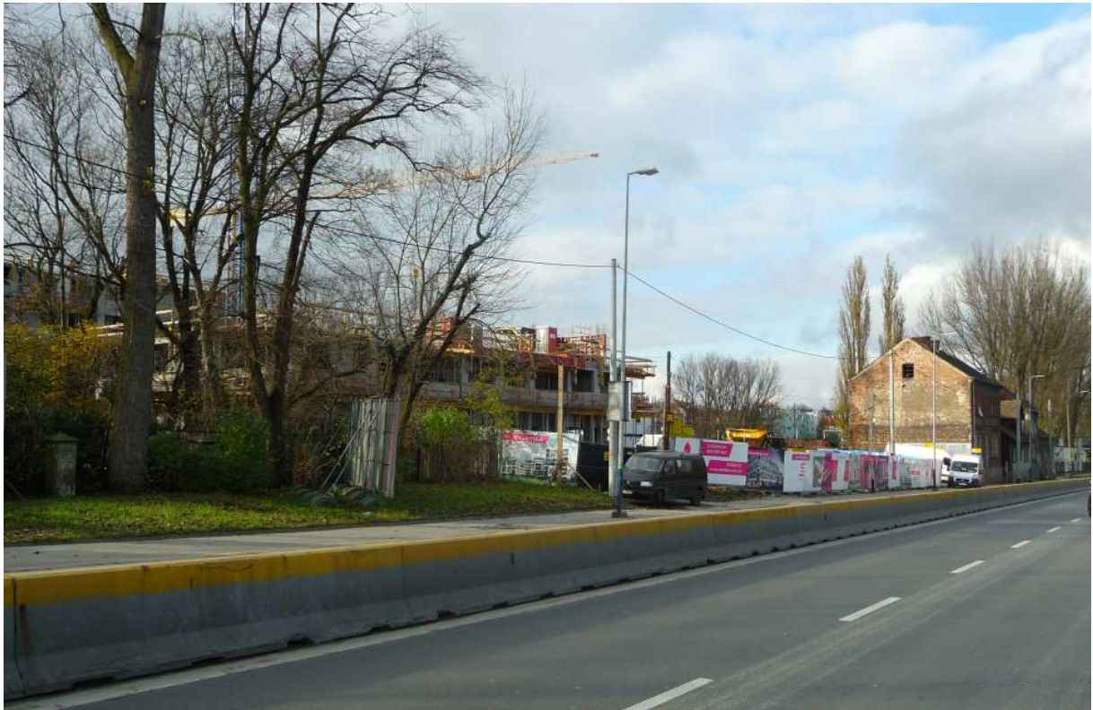
Fot. nr 96 (96-97). Fragment typowo podmiejskiej zabudowy ulicy Wielickiej o numerach: 105-111, który niebawem zniknie. (14.11.2017)
