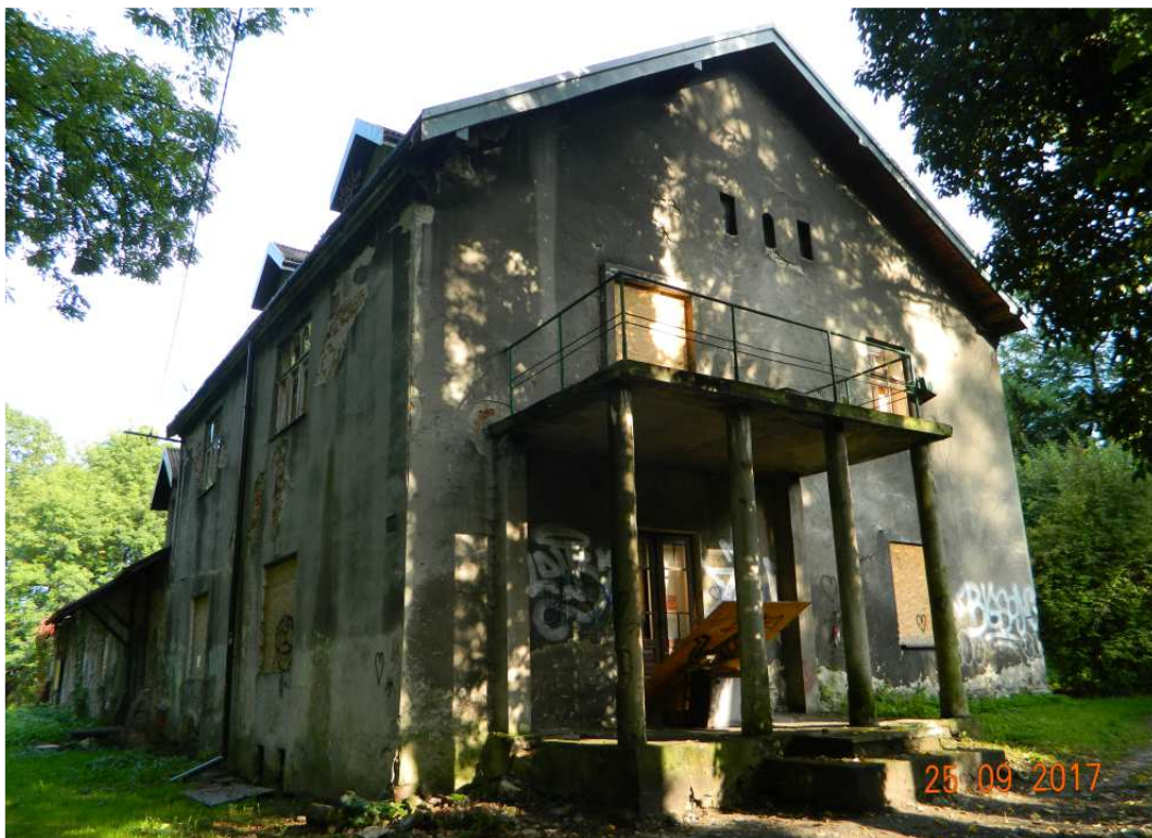
Fot. nr 105. Widok od strony ulicy Estońskiej.
