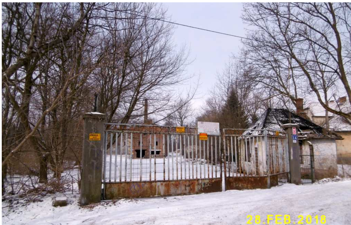
Fot. nr 138. Brama wjazdowa na teren młyna.
