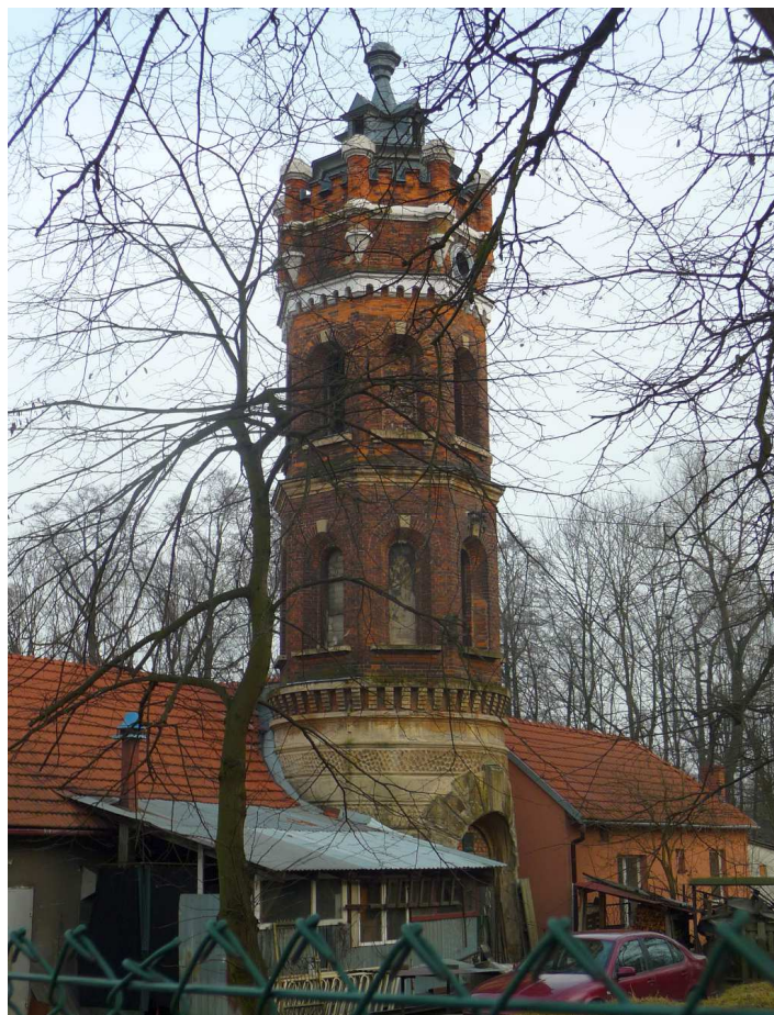
Fot. nr 281 (281-283). Eklektyczna wieża ciśnień przy ulicy Górników 25. (10.01.2018)
