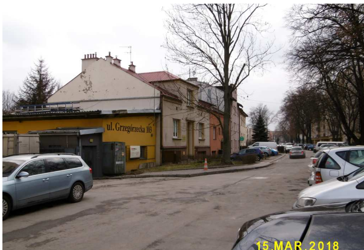
Fot. nr 104. Ciągłe niska zabudowa końcowego fragmentu ulicy Grzegórzeckiej.
