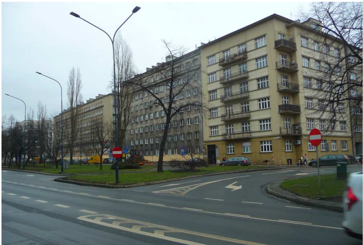
Fot. nr 50. Fragment zabudowy o nr: 11-13 pomiędzy ulicami: Lenartowicza i Łobzowską. (29.01.2018)
