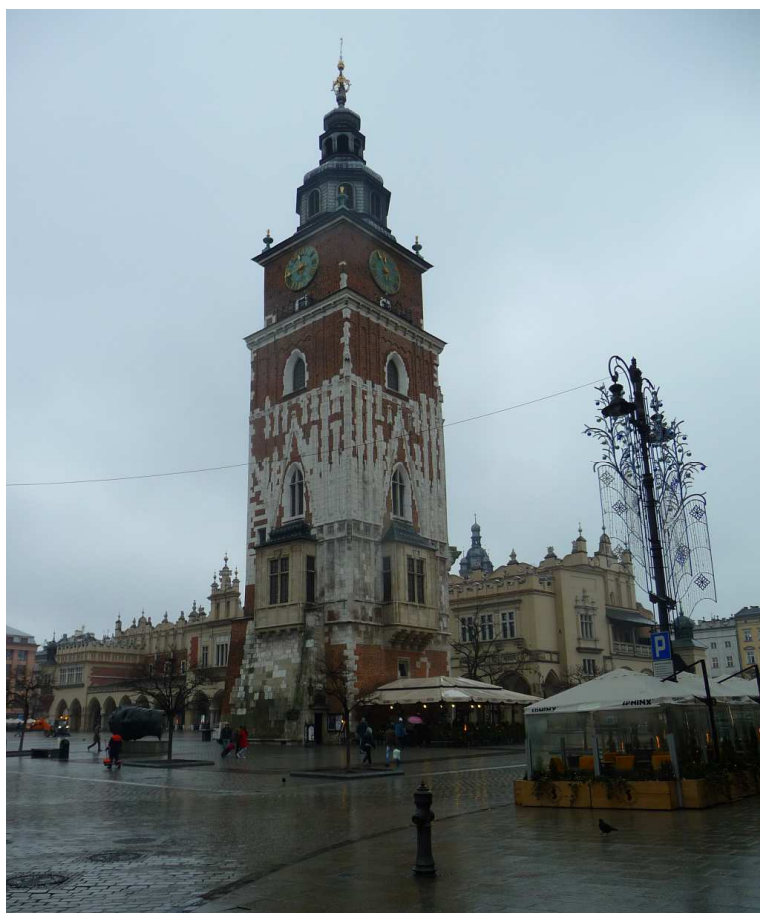
Fot. nr 20. Wieża ratuszowa w ujęciu z wylotu ulicy św. Anny. (12.01.2018)
