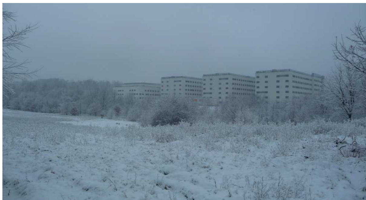
Fot. nr 352 (352-353). Budowa centrum szpitalnego UJ wzdłuż ulicy Jakubowskiego dobiega końca. (21.01.2018)
