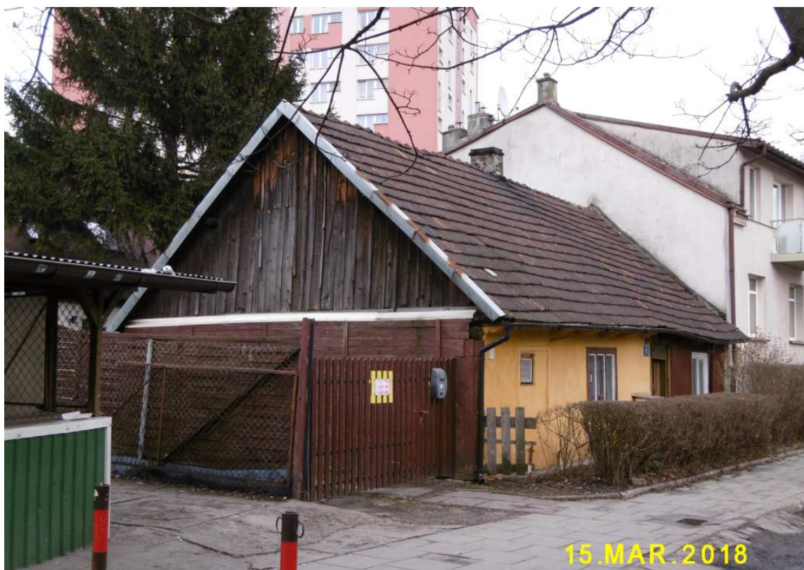
Fot. nr 105. Chałupa przy ulicy Na Szaniec 1.
