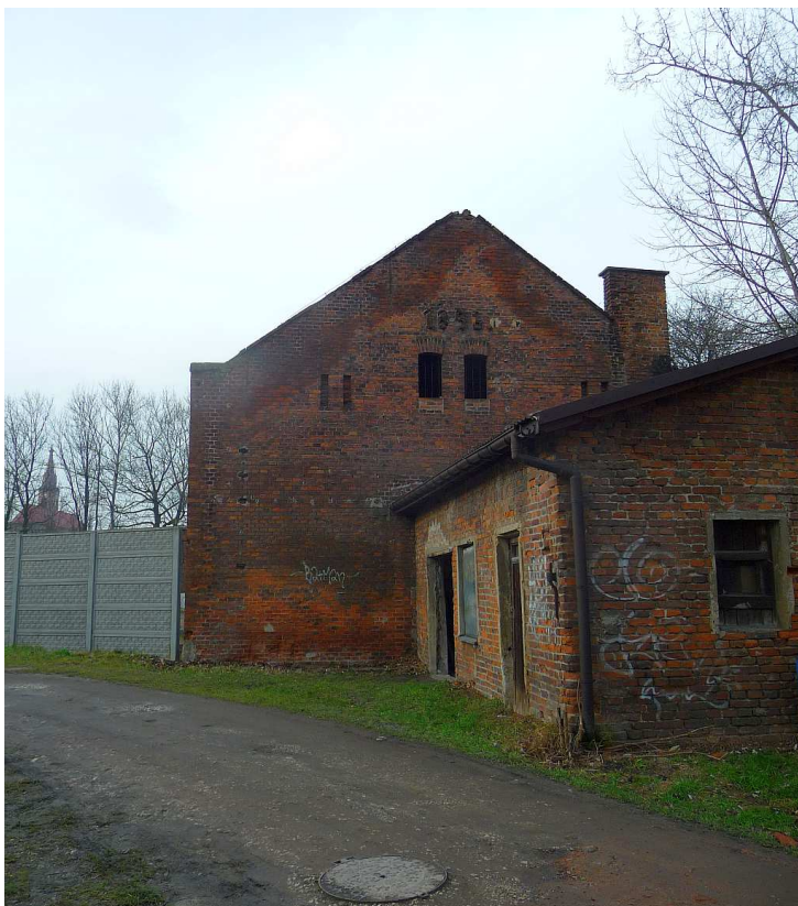
Fot. nr 277. Data budowy folwarku na ścianie szczytowej od strony ulicy Żniwnej. (10.01.2018)
