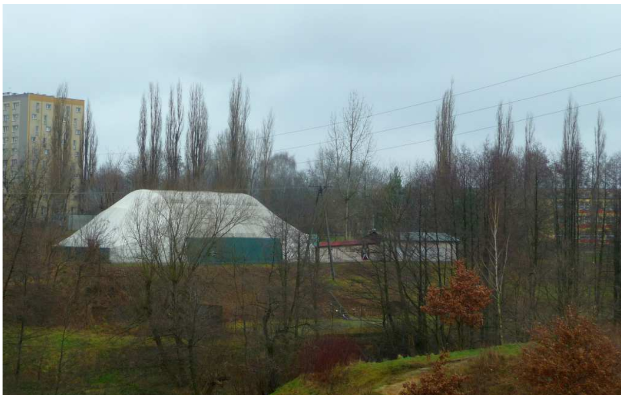
Fot. nr 238. Ponad halą balonową klubu tenisowego „Kozłówek” w stronę placu budowy basenu, gdzie właśnie wycinany był topolowy szpaler. (24.12.2017)
