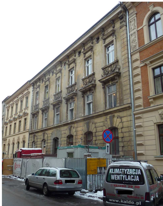
Fot. nr 41. Dawna kamienica Zollów spod nr 25 na etapie remontu. (22.01.2018)
