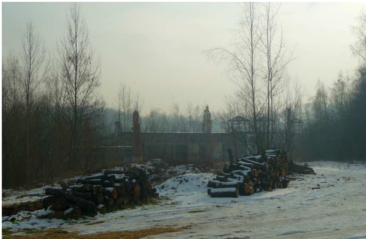
Fot. nr 171 (171-173). Budynki fabryczne dawnego kamieniołomu we fragmencie od strony ulicy Swoszowickiej. (26.01.2018)
