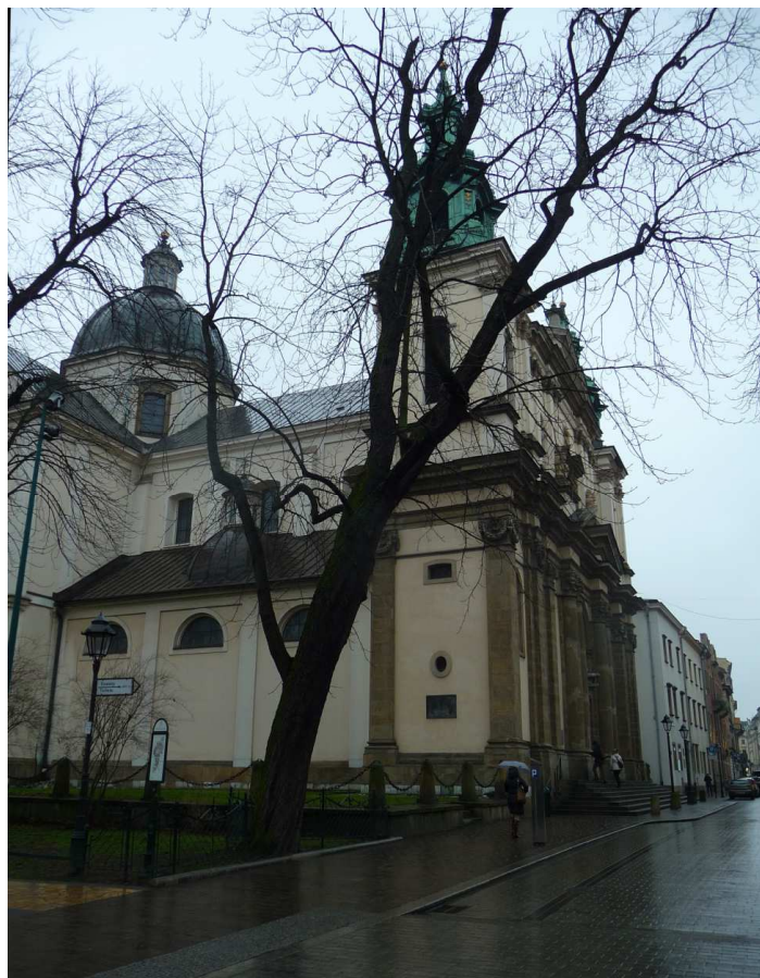
Fot. nr 33 (33-34). Wzdłuż ulicy świętej Anny – widoki od strony Plant. (12.01.2018)
