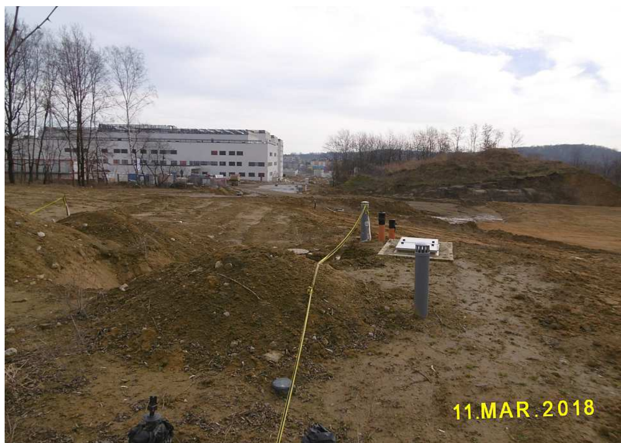
Fot. nr 309 (309-310). Na placu budowy centrum szpitalnego UJ – widoki z ulicy Kostaneckiego.
