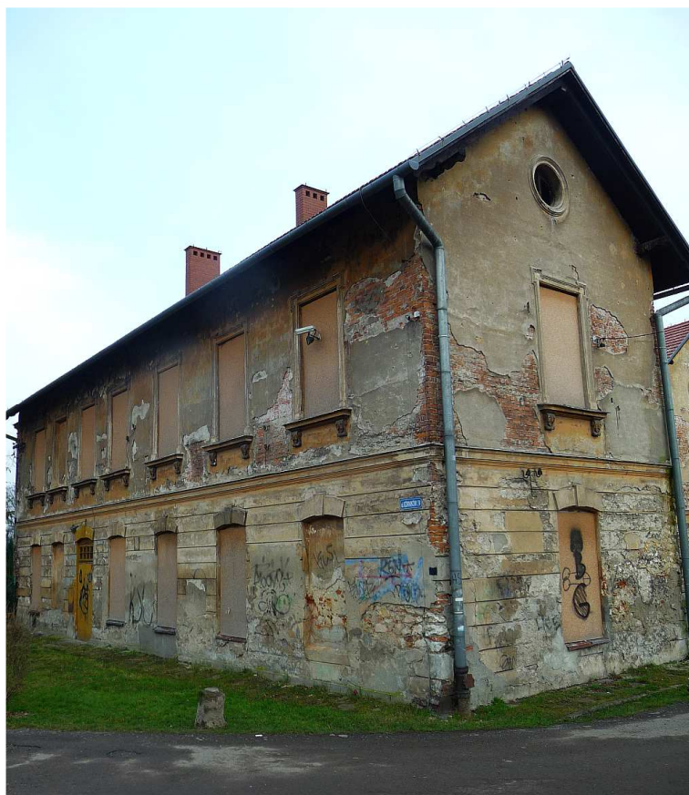
Fot. nr 292. Skrzydło rządcówki od strony ulicy Górników. (10.01.2018)
