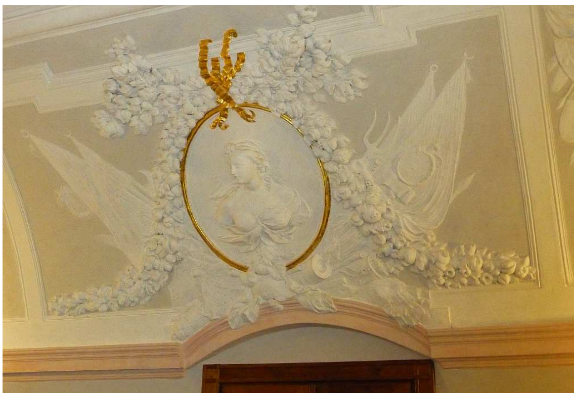
Fot. nr 18. Stiuki nad drzwiami wejściowymi. (21.12.2017)
