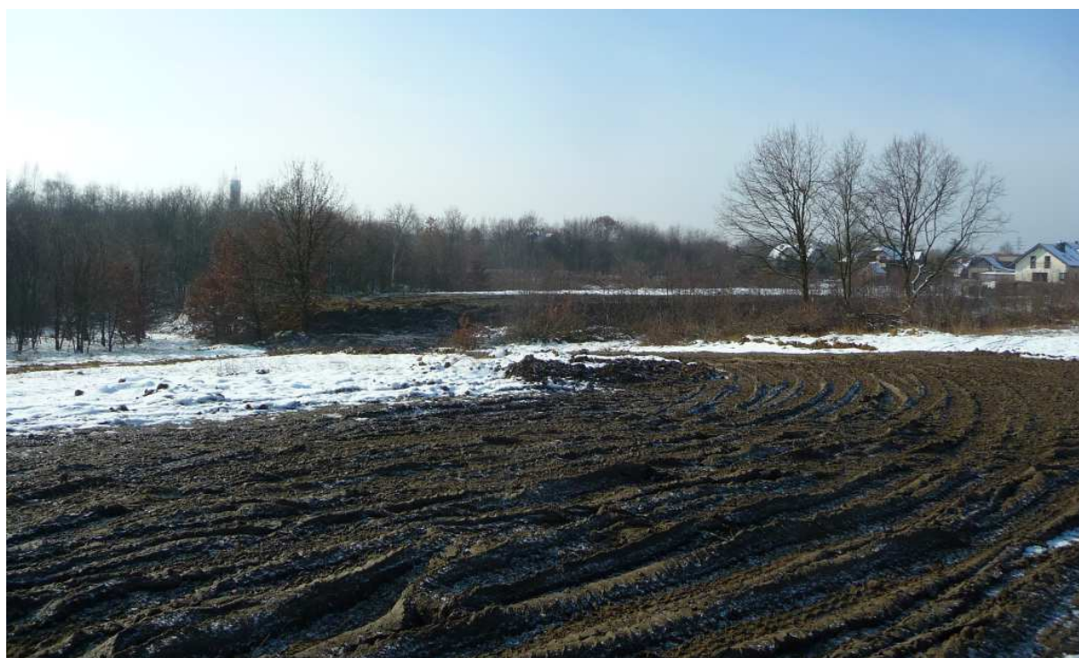
Fot. nr 320. Trwa plantowanie terenu pod zabudowę. (17.02.2018)
