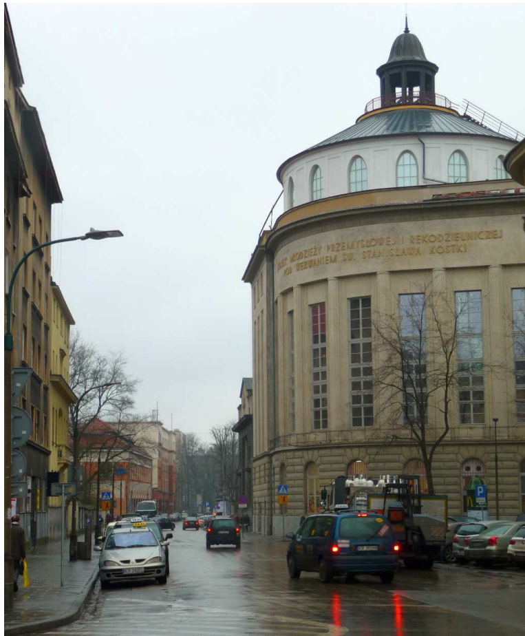
Fot. nr 45. Świeżo odnowiony budynek dawnej bursy księdza Kuznowicza. (12.01.2018)
