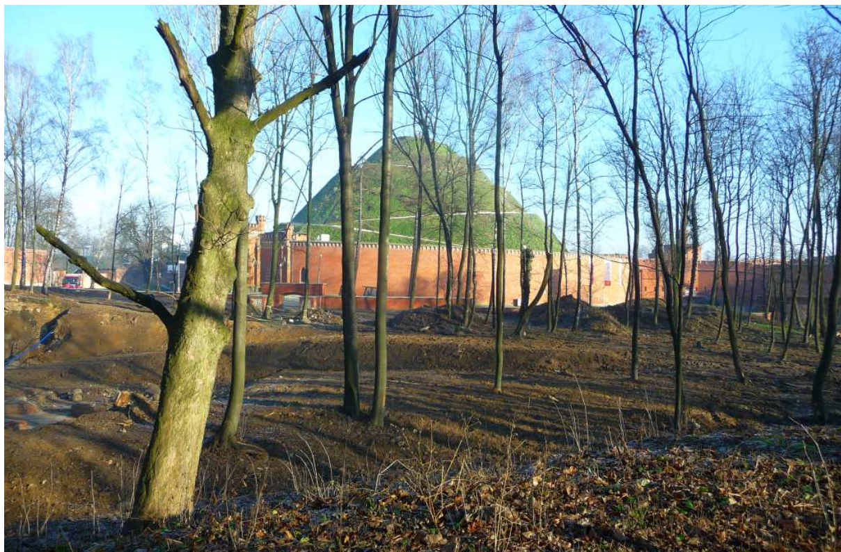
Fot. nr 57 (57-60). Roboty ziemne na przedpolu bastionów I i II. (26.12.2017)
