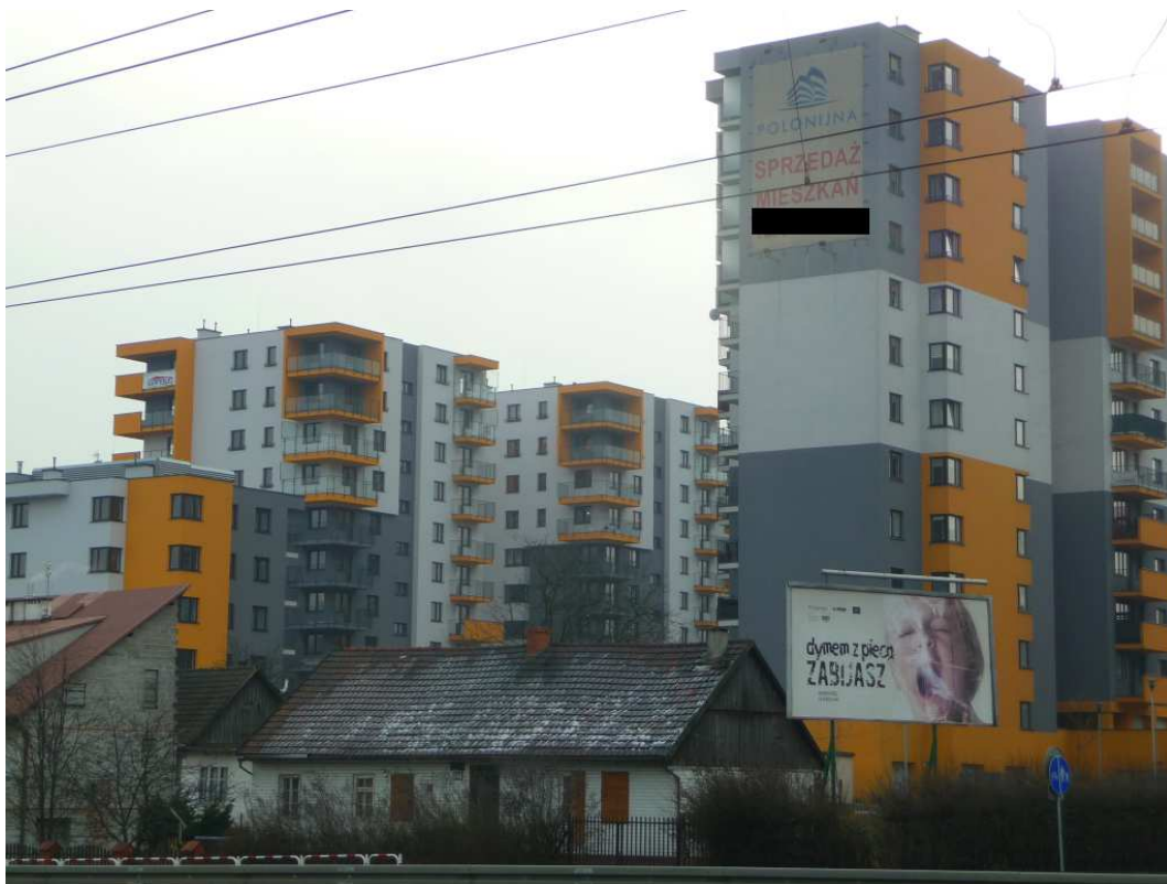
Fot. nr 259 (259-262) Przytłoczone ogromnym blokowiskiem relikty dawnej zabudowy Prokocimia przy ulicy Wielickiej 249 i 251. (10.01.2018)
