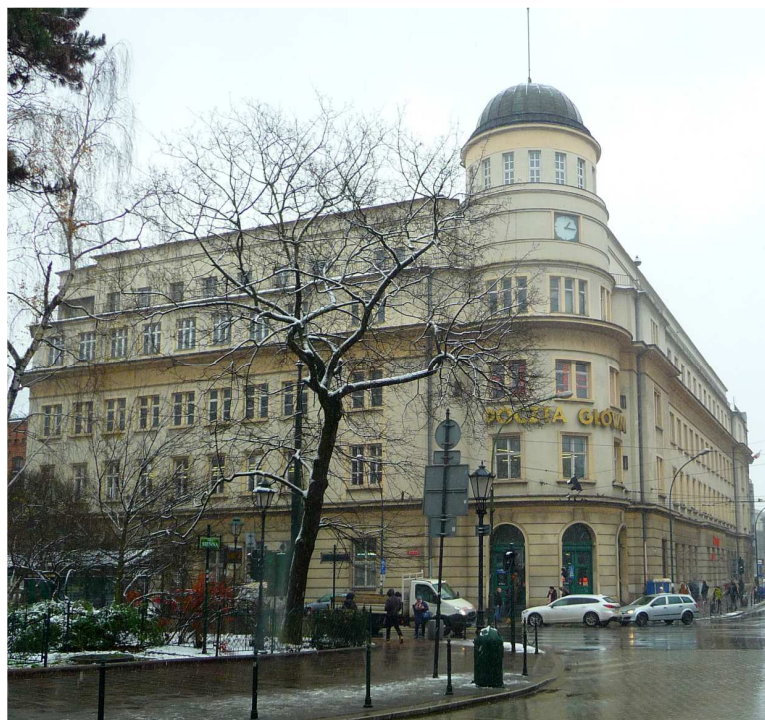
Fot. nr 100. Gmach Poczty Głównej przy ulicy Wielopole 2. (04.12.2017)
