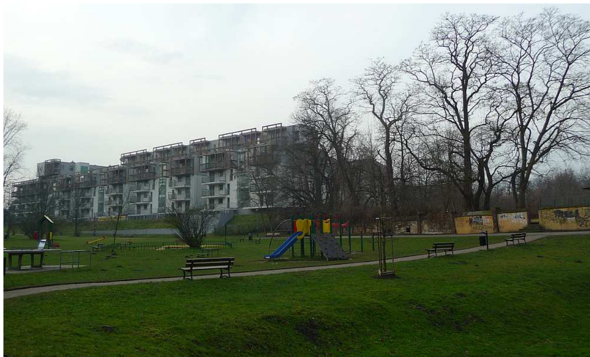
Fot. nr 293. Blokowisko z ulicy Górników 50-66, które wlewa się do parku. (10.01.2018)
