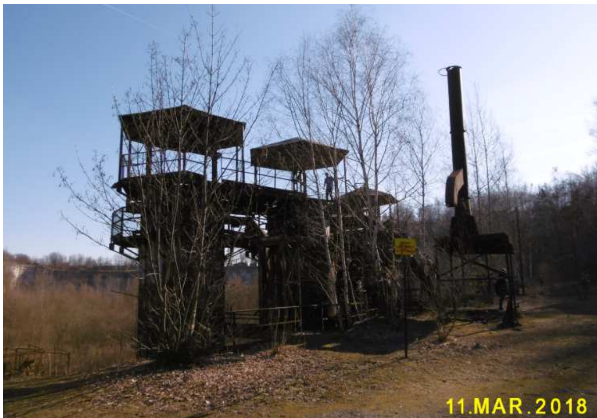
Fot. nr 174 (174-176). Rdzewiejąca instalacja przeróbca wapienia, która zaprzestała pracować pod koniec lat 80. (174-176).
