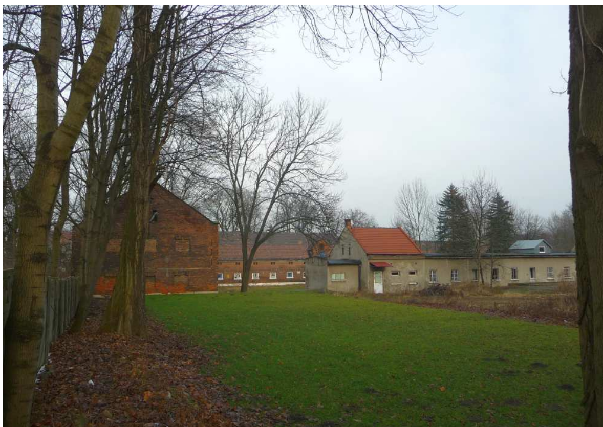
Fot. nr 270 (270-278). Dawny folwark Na Wrzosach wybudowany przez Erazma Jerzmanowskiego pod koniec XIX wieku. (10.01.2018) Fot. nr 270-274. Ujęcia z dawnej alei dojazdowej.
