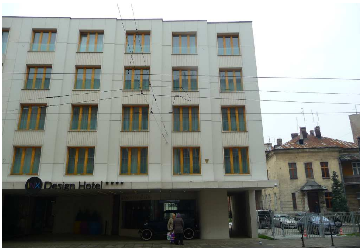
Fot. nr 97. Fasada hotelu Design. (16.02.2018)
