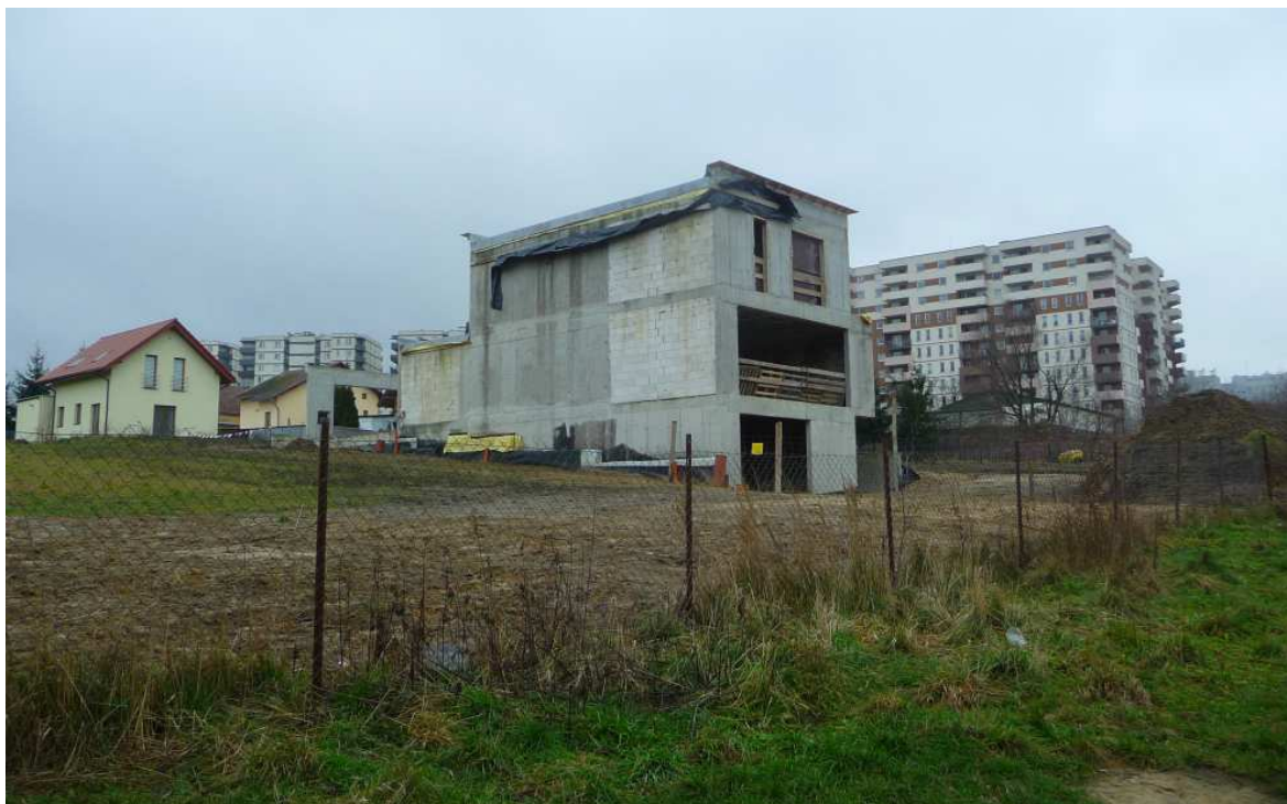
Fot. nr 299. Trwa zabudowa otuliny Parku Rzecznego Drwinka w sąsiedztwie ulicy Szpakowej. (24.12.2017)
