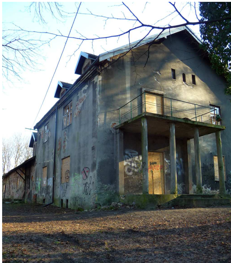
Fot. nr 202. Fragment od strony drogi wjazdowej z ulicy Estońskiej. (14.01.2018)
