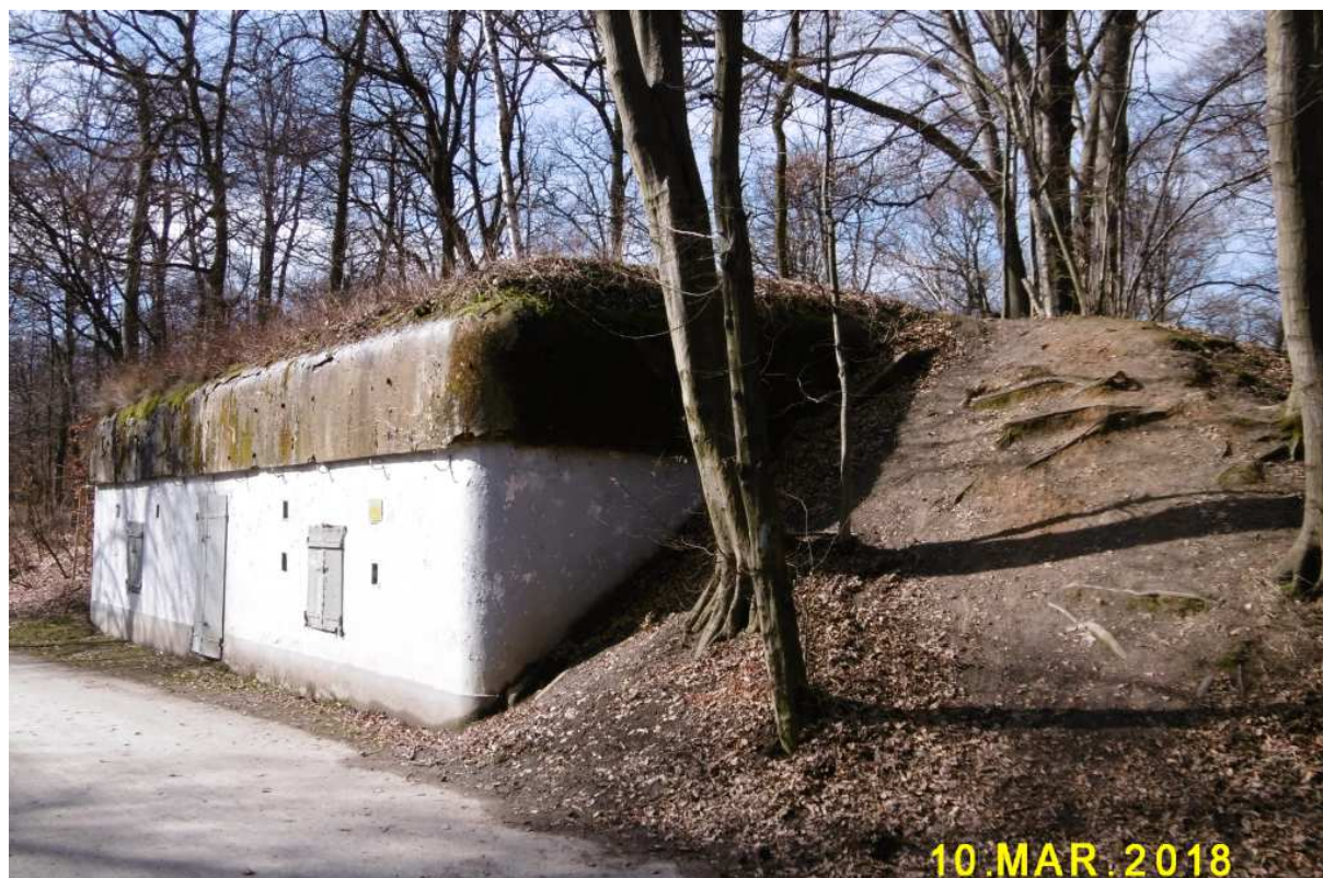
Fot. nr 87 (87-88). „Kazamata” na Ostrej Górze.
