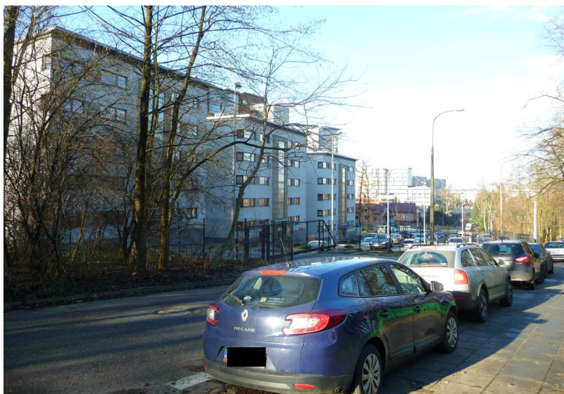
Fot. nr 196. Blokowisko „pod dębami”. (27.12.2017)
