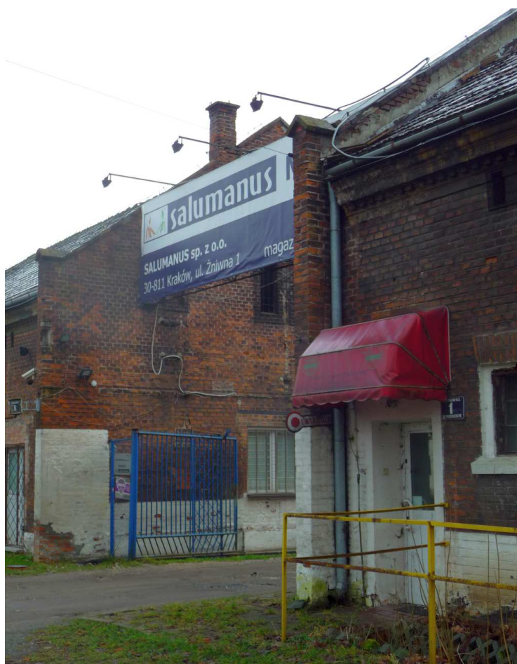
Fot. nr 275 (275-278). Ujęcia od strony alei Dygasińskiego. Nad bramą logo nowego użytkownika. (10.01.2018)
