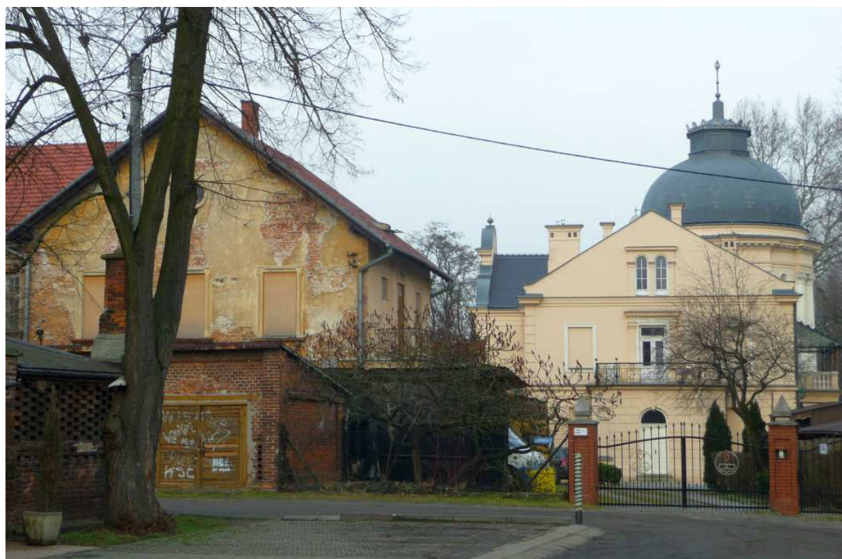
Fot. nr 290. Fragment pałacu w ujęciu od strony kaplicy. (10.01.2018)
