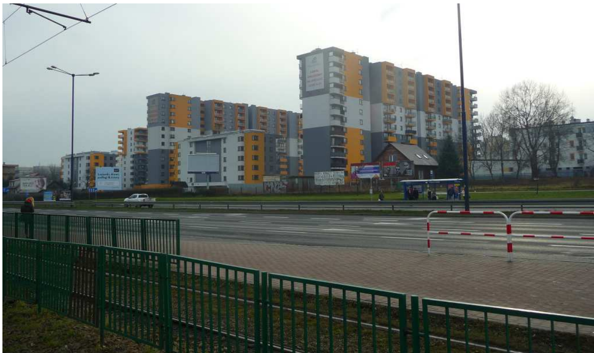
Fot. nr 258 (258-262). Trwa rozbudowa giganta mieszkaniowego pomiędzy ulicami: Wielicką i Polonijną na terenie dawnych zakładów produkcji zabawek. (10.01.2018)
