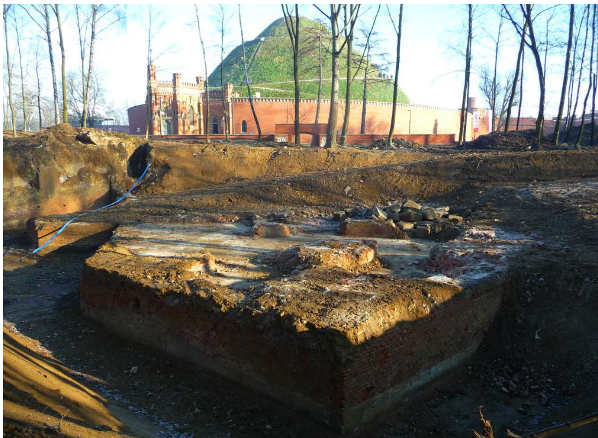
Fot. nr 58 (58-59). Odslonięta partia przyziemia bastei usytuowanej pomiędzy bastionami I i II. (26.12.2017)
