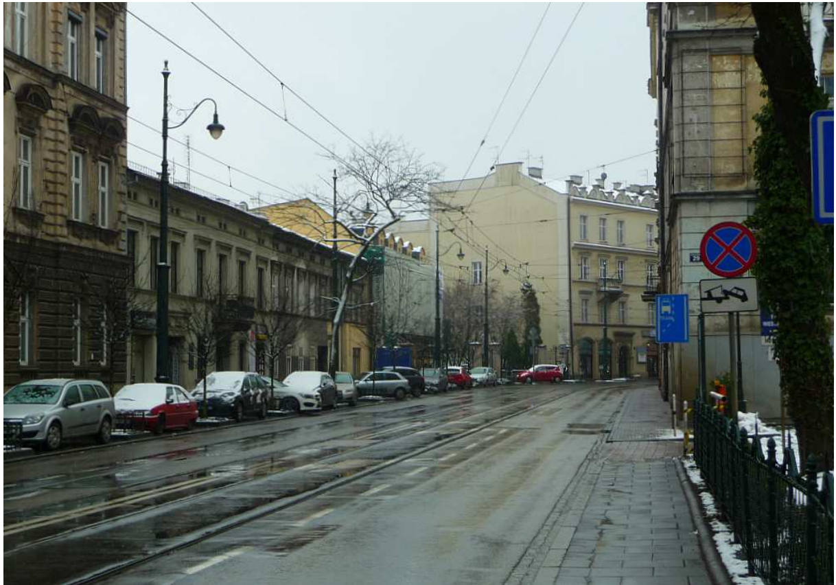
Fot. nr 93. Niska zabudowa w końcowym odcinku ulicy św. Gertrudy 17-23. (04.12.2017)
