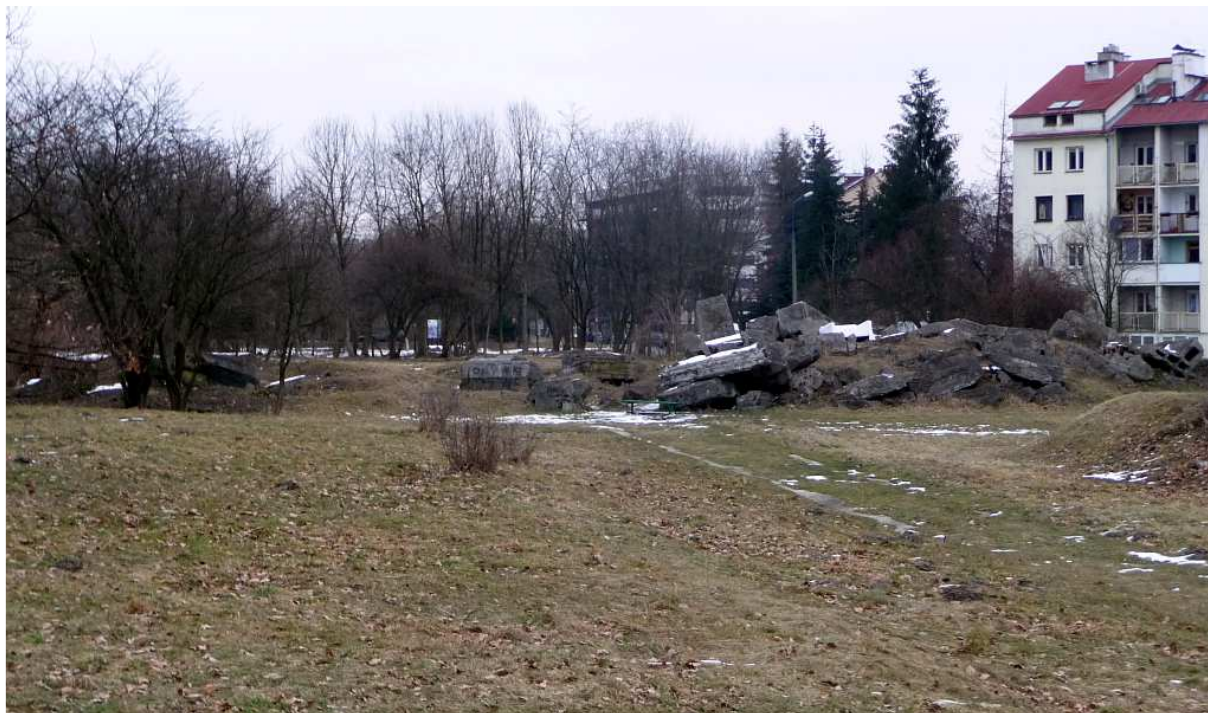
Fot. nr 181 (181-182). Widok na ruinę domu pogrzebowego przy przedwojennym kikucie, który został zburzony pod koniec okupacji hitlerowskiej i rozebrany po wojnie. (22.02.20)
