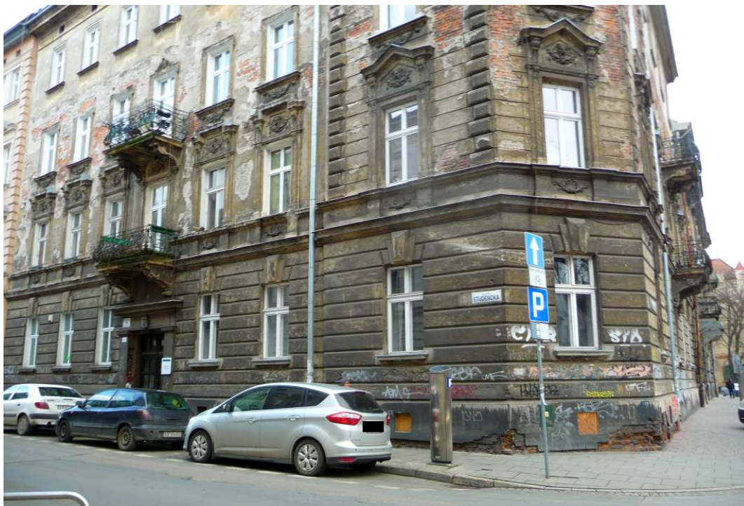
Fot. nr 39. Odrapana kamienica z naroża ulic: Studenckiej 8 i Loretańskiej. (05.02.2018)
