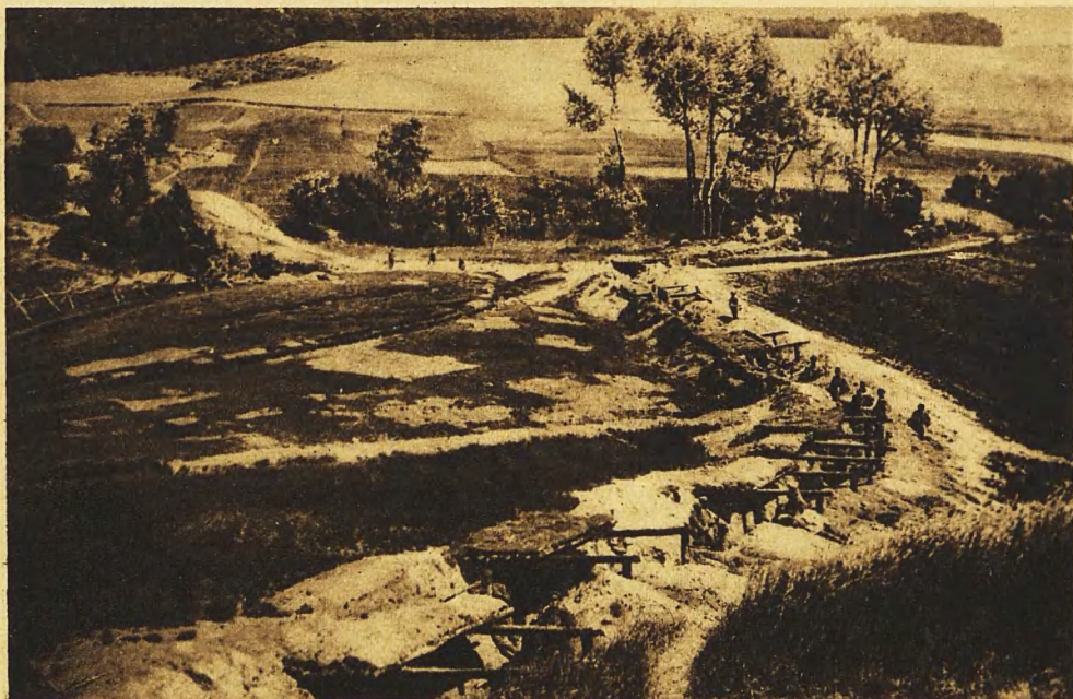
Nr. 40. Okopy legionowe. — Tranchées des Légions Polonaises. — A part of the Polish Legion trenches.
