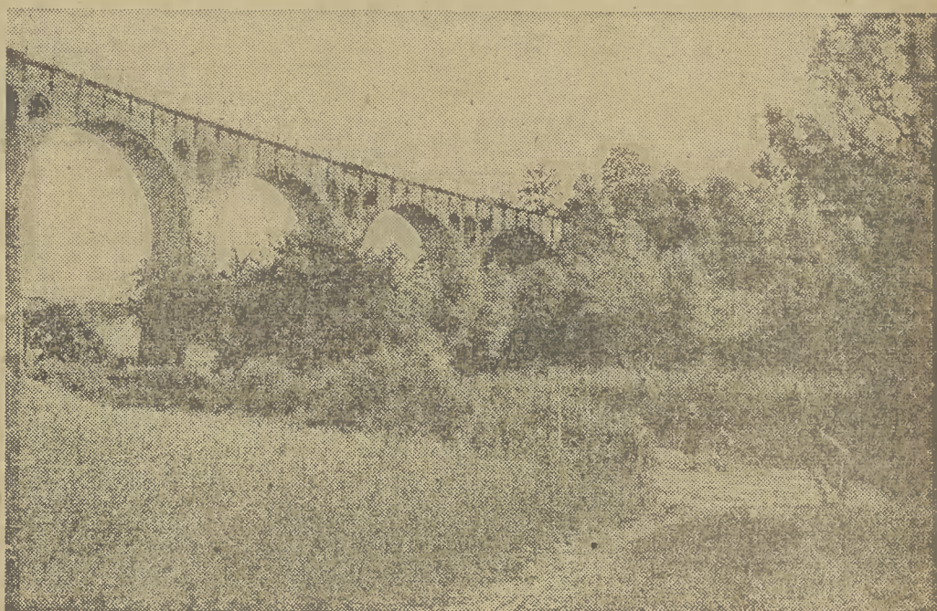
Wiadukt w okolicy Kuźdowy
