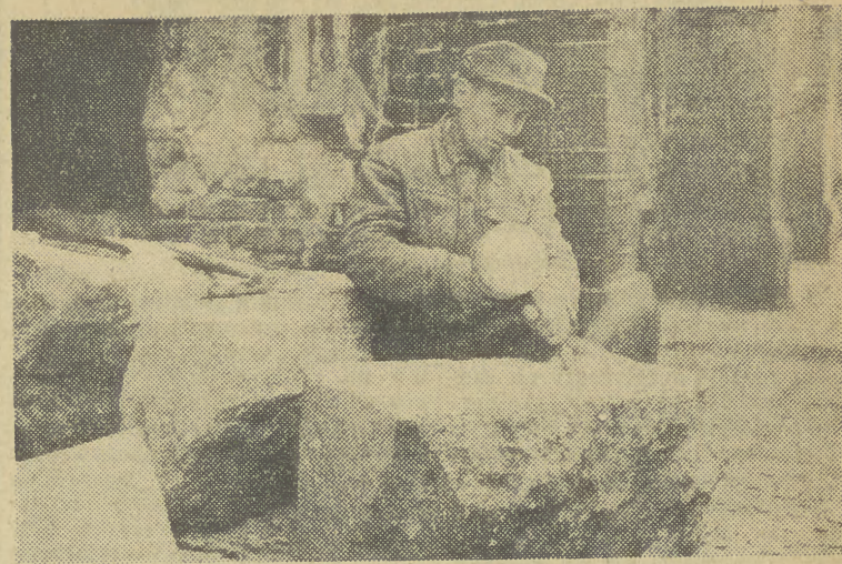
MISTRZ kamieniarski, Jan Zwieryzak, przy obróbce nowych kamieni do Bramy Floriańskiej, które zastąpią stare, już zmuszające.
