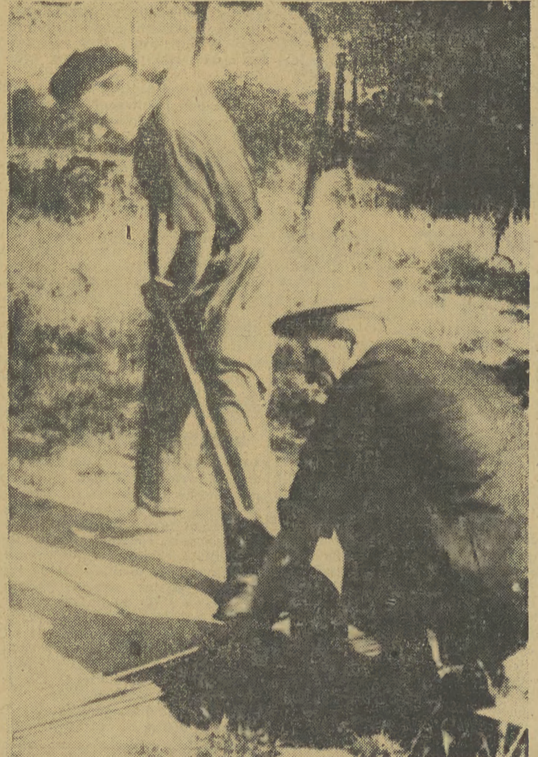
Wyprostowane już długie „sznurzy“ żelaza zbrojenowego — trzeba pociąć na kawałki o ustalonej długości. Przy pracy tej widzimy Mieczysława Fudalę (stojącego) i Stanisława Halatka.
